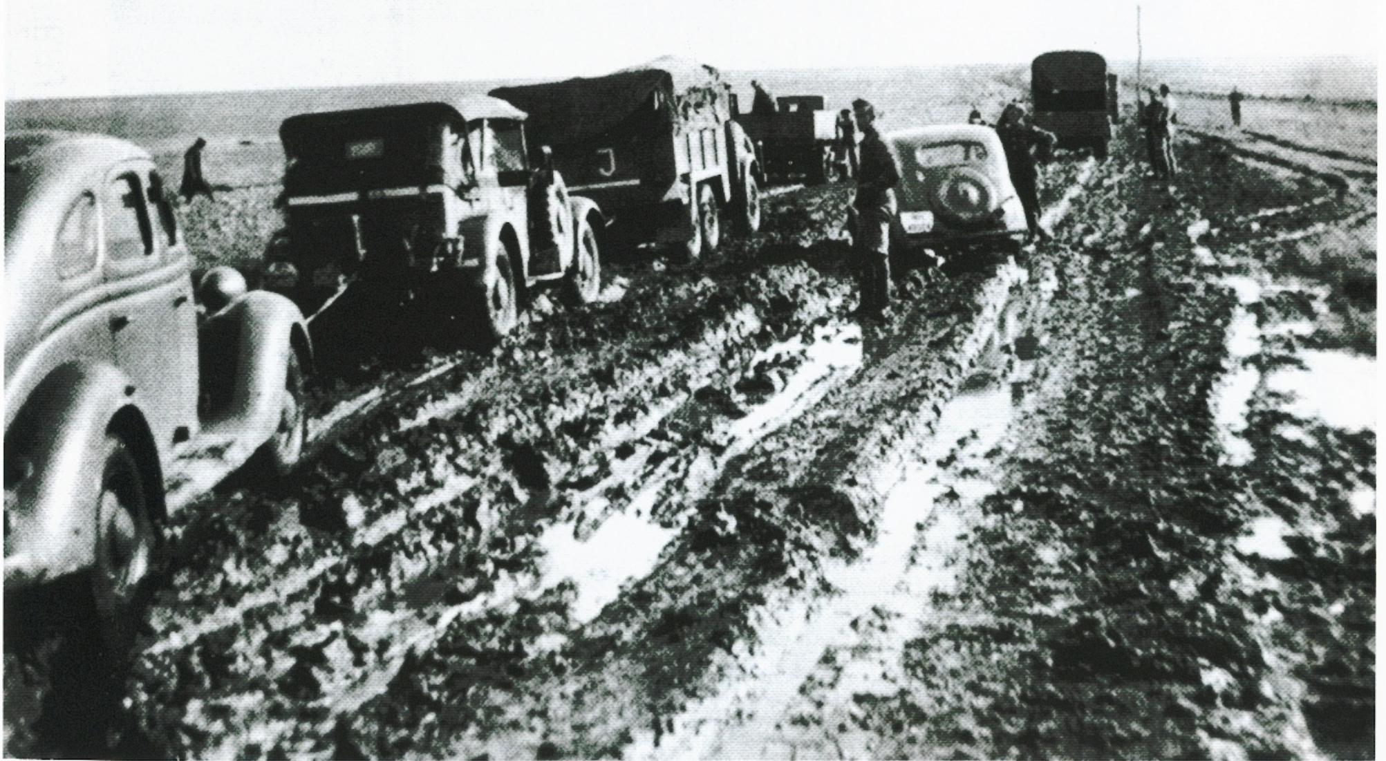
Diese Aufnahme entstand am 26. Oktober 1941 in der Nähe von Senkow bei der Karten- und Vermessungsabteilung 608. Ein leichter geländegängiger Einheits-LKW 2,5 t (6x6) bewährte sich hier als Vorspann für PKW dieser Abteilung, die sich im tiefen Boden aus eigener Kraft nicht mehr fortbewegen konnten.
