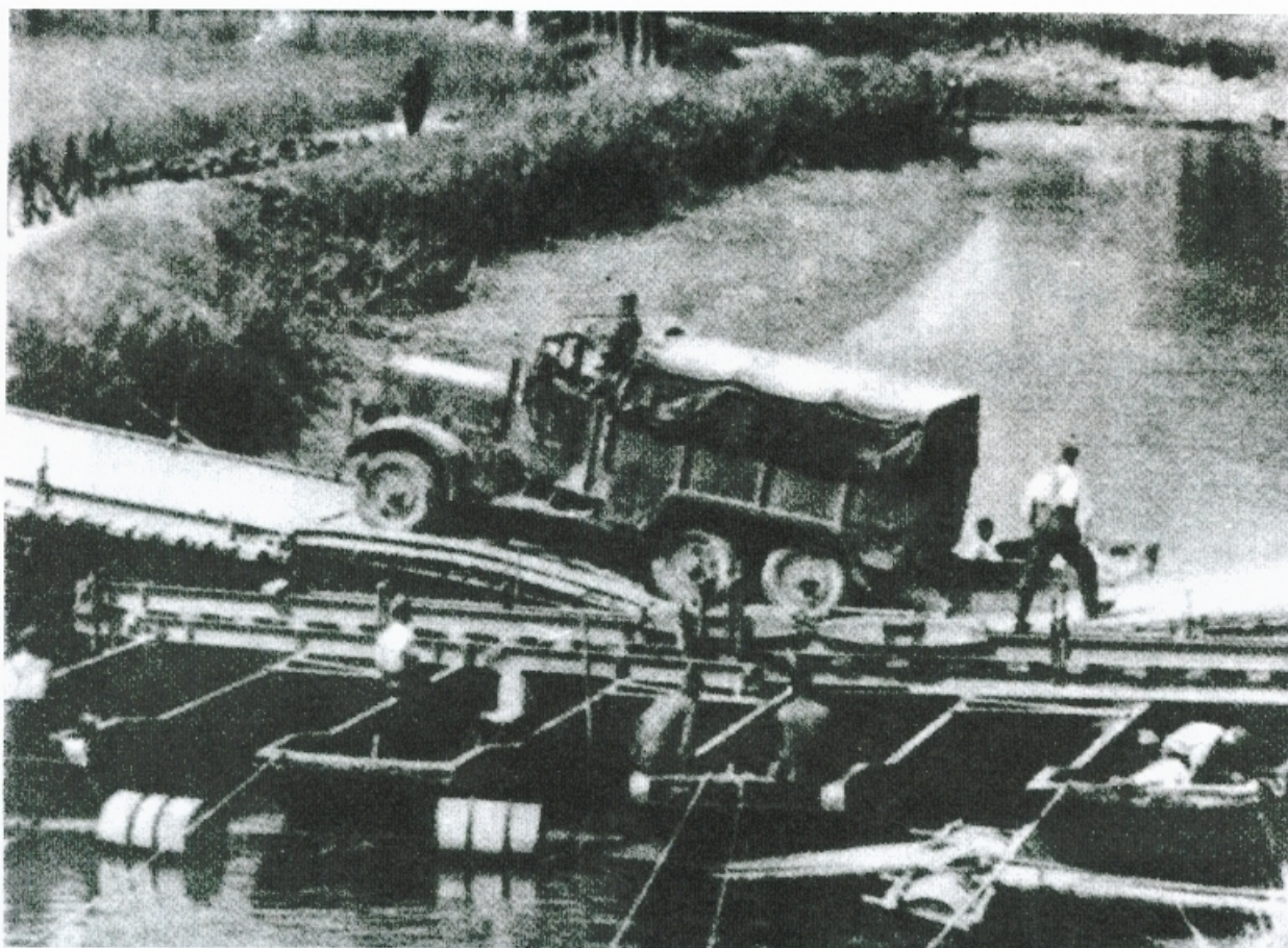
Der leichte geländegängige Einheits-LKW hat eine Pontonbrücke passiert und fährt gerade über die Rampe auf den Anfahrsteg. Die Aufnahme entstand 1940 in Frankreich.
