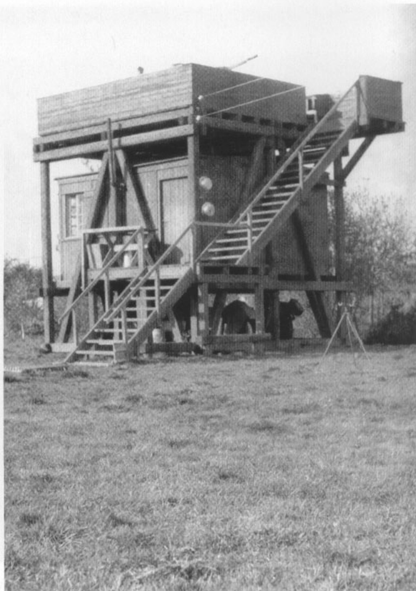
Hochstände für leichte Fliegerabwehrkanonen konnten nur unter fachmännischer Anleitung gebaut werden. Im Bild ein Flak-Hochstand aus Holz, bestückt mit einer 2-cm-Fliegerabwehrkanone 38.
