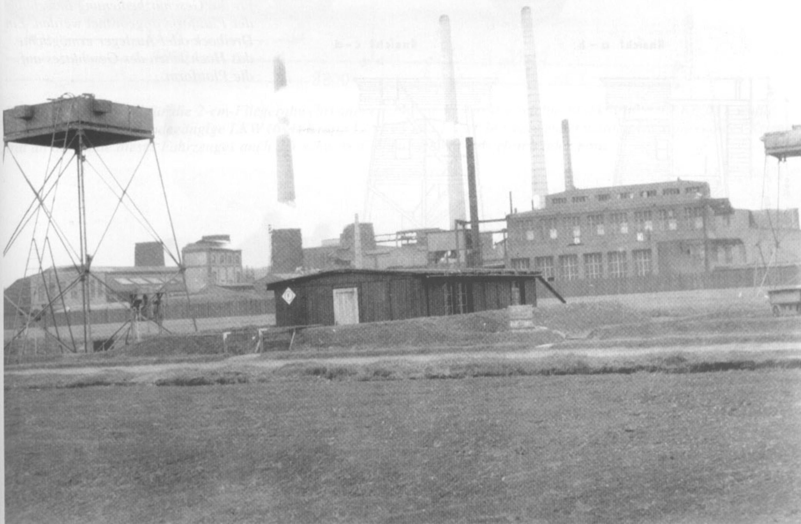
Hochstände aus einer Stahlrohrkonstruktion wurden mit 2-cm-Fliegerabwehrkanone 30 und 38 bestückt und dort aufgestellt, wo der Schutz von Industrieanlagen die ständige Anwesenheit der Flak-Artillerie notwendig machte.
