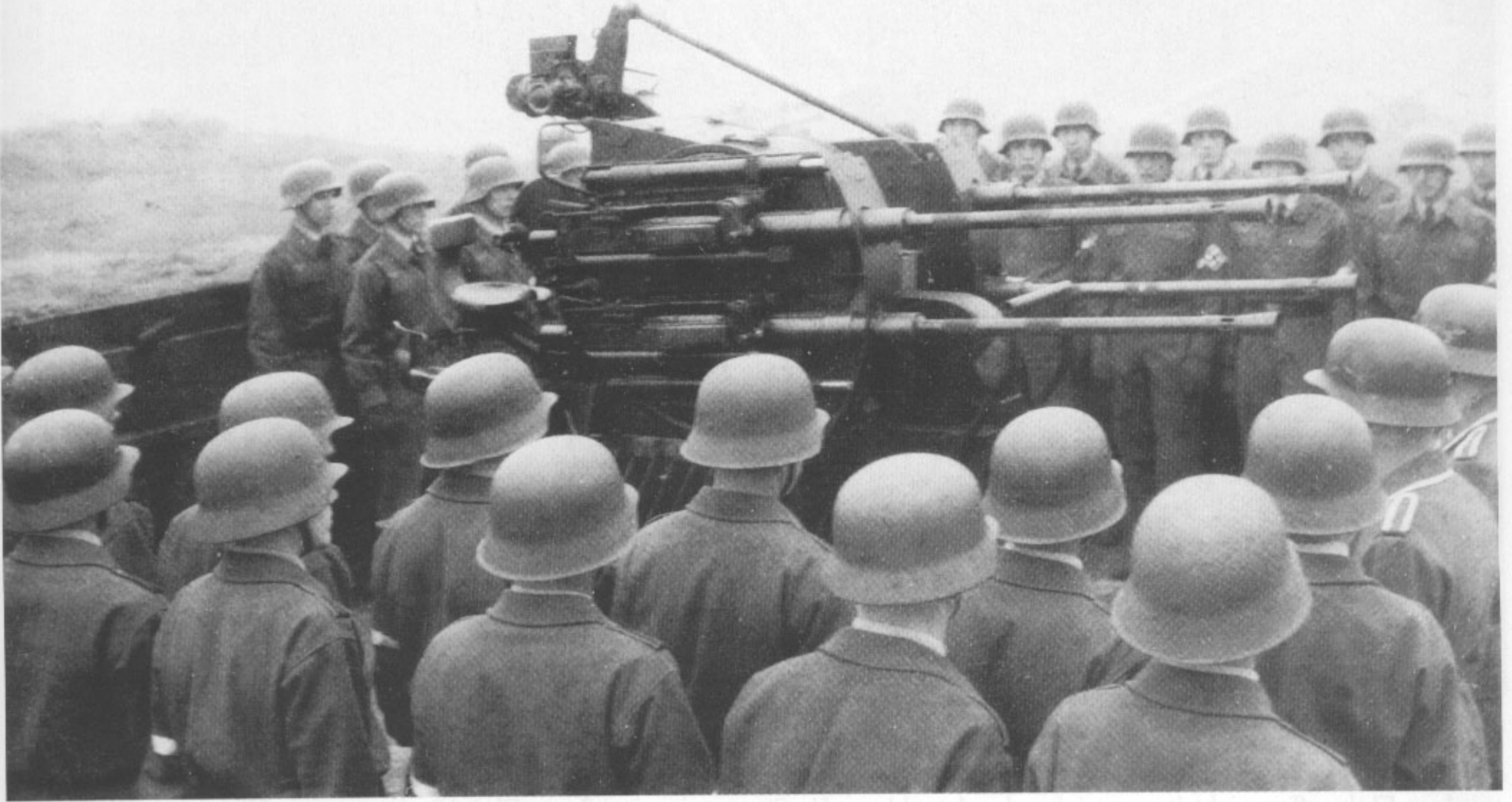
Der 2-cm-Flak-Vierling 38 war mit dem Flakvisier 40, dem Linealverkehr 21, dem Schwebekreisvisier 30/38 und dem Erdzielfernrohr 3x8 0 im Einsatz.
