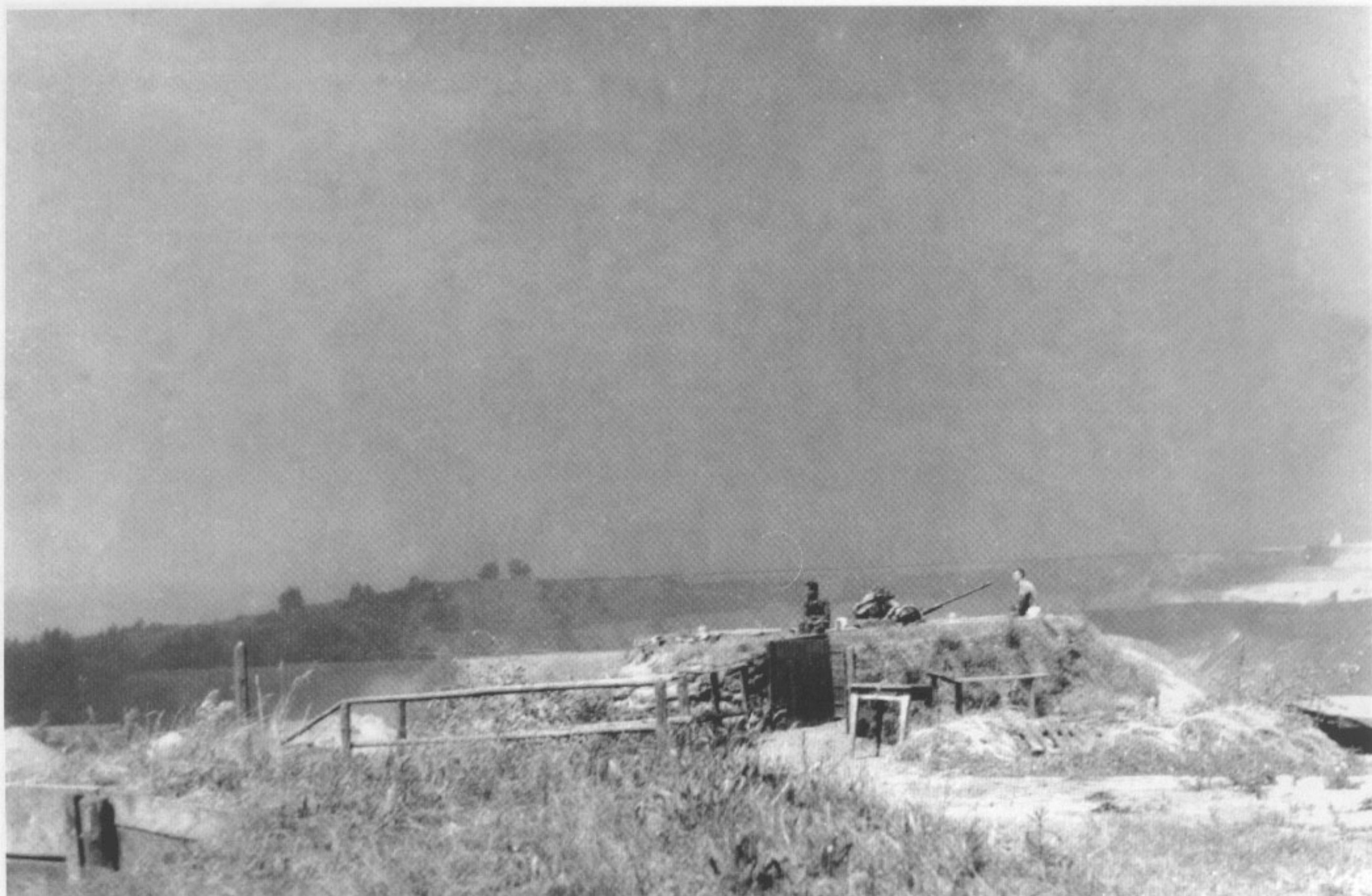
Der Erdstand für 2-cm-Fliegerabwehrkanonen 30 und 38 mit einer einfachen Bohlenwand aus Halbrundhölzern und Erdwall. Die Feuerstellung ist mit einer 2-cm-Fliegerabwehrkanone 38 besetzt.
