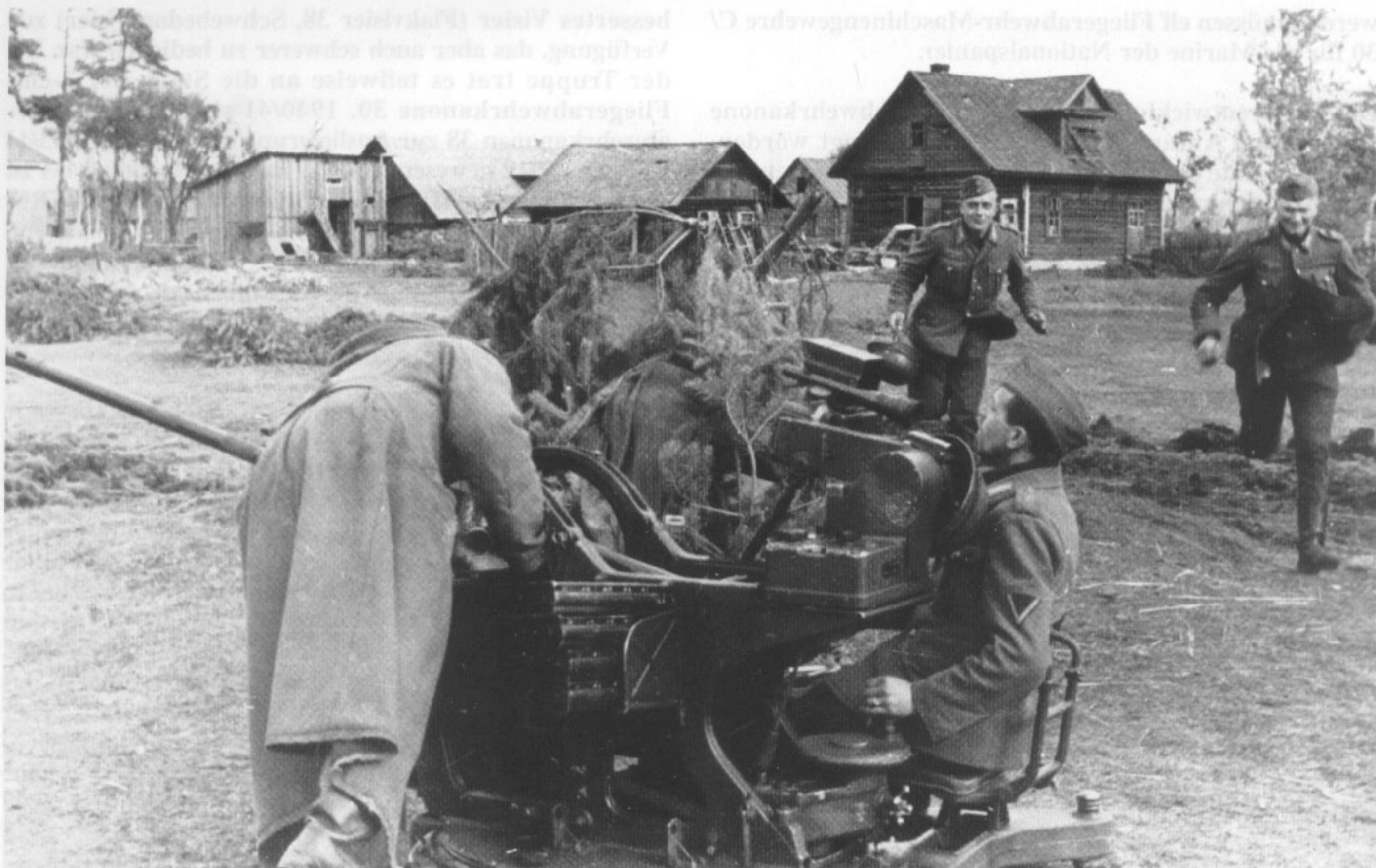
Alarm bei einem leichten Flak-Zug. Gut zu erkennen ist bei dieser 2-cm-Fliegerabwehrkanone 38 das Flakvisier 38 sowie das Erdzielfernrohr 3x8°. Bemerkenswert weiterhin die Halterung für vier 20-Schuß-Magazine an der linken Seite des Geschützes. Die Aufnahme ist im Spätsommer 1941 an der Ostfront entstanden.
