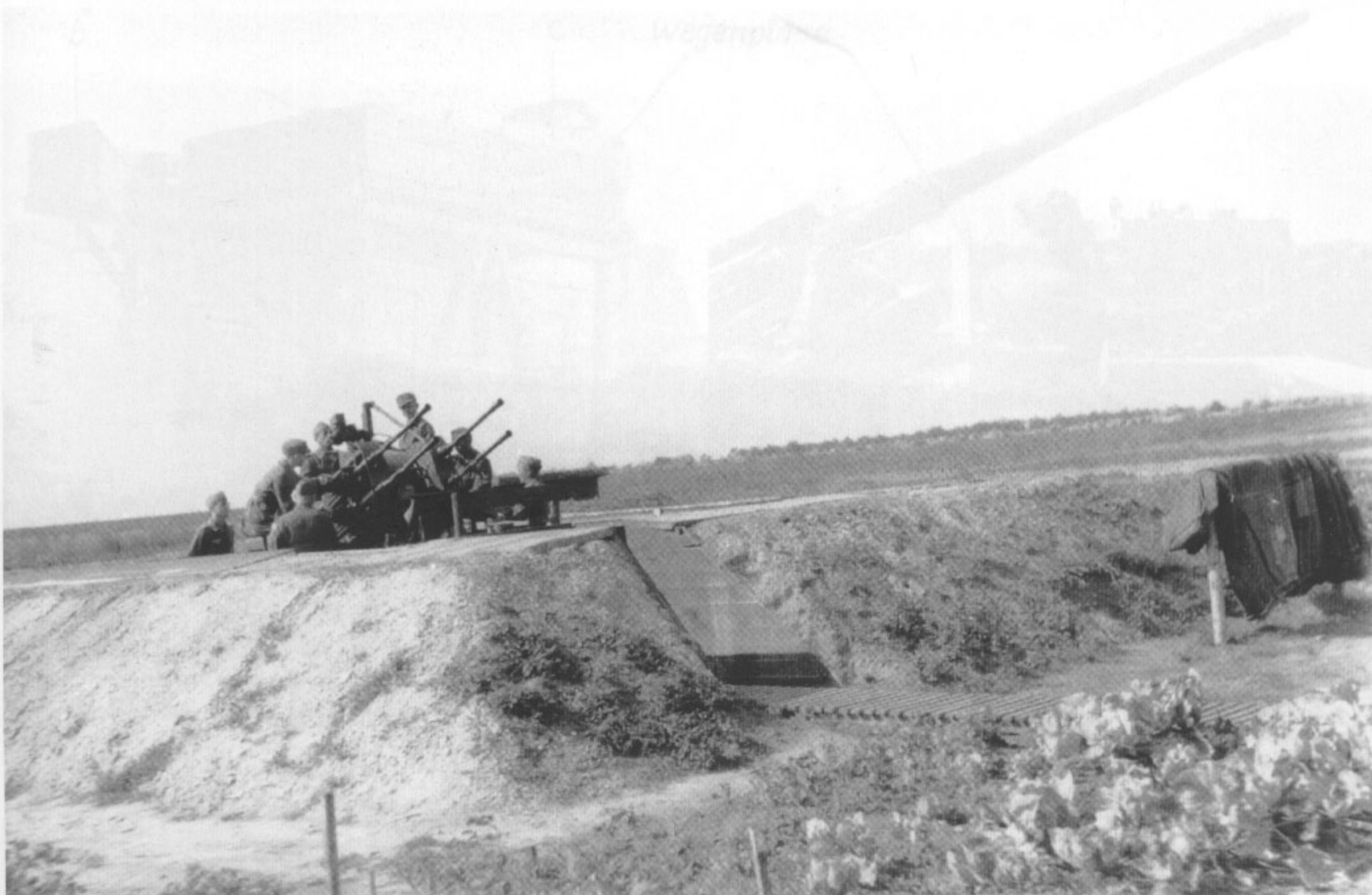
Ein Erdstand für eine 2-cm-Vierlings-Fliegerabwehrkanone 38. Er entsprach hinsichtlich seiner Abmessungen und Feuerstellung für die 3,7-cm-Fliegerabwehrkanone 18 und 36.
