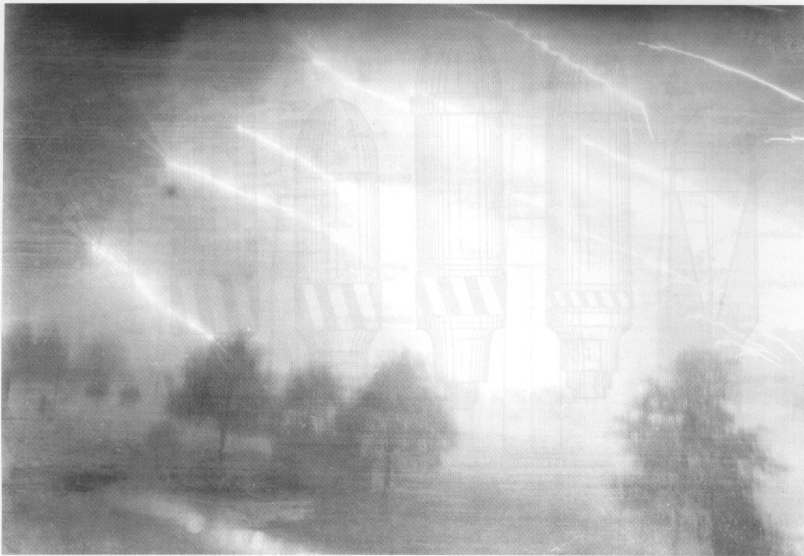
Eindrucksvoll ist diese Aufnahme vom Nachtschießen leichter Fliegerabwehrkanonen. Deutlich erkennbar am Ende der Flugbahn, die Selbstzerlegung der Geschosse. Das geschah nach einer Flugzeit von 5,5 bis 6,5 Sekunden.
