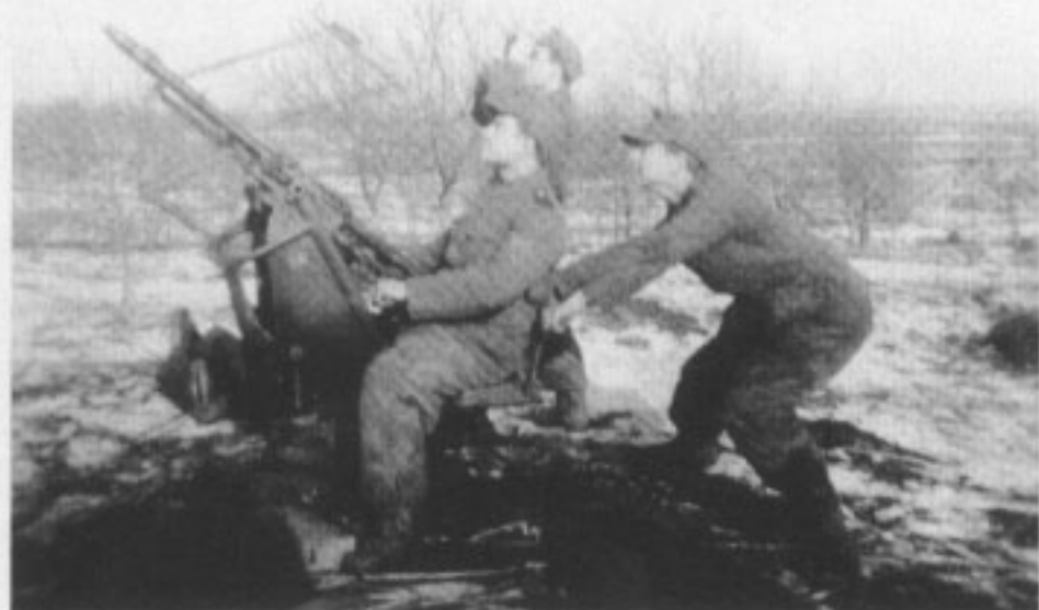
1944 veraltet, trotzdem noch zur Abwehr von Tiefangriffsflugzeugen verwendet - die Zwillingslafette 36 mit zwei 7,92-mm-Maschinengewehren 34 (Feuergeschwindigkeit 1800 Schuß/min).
