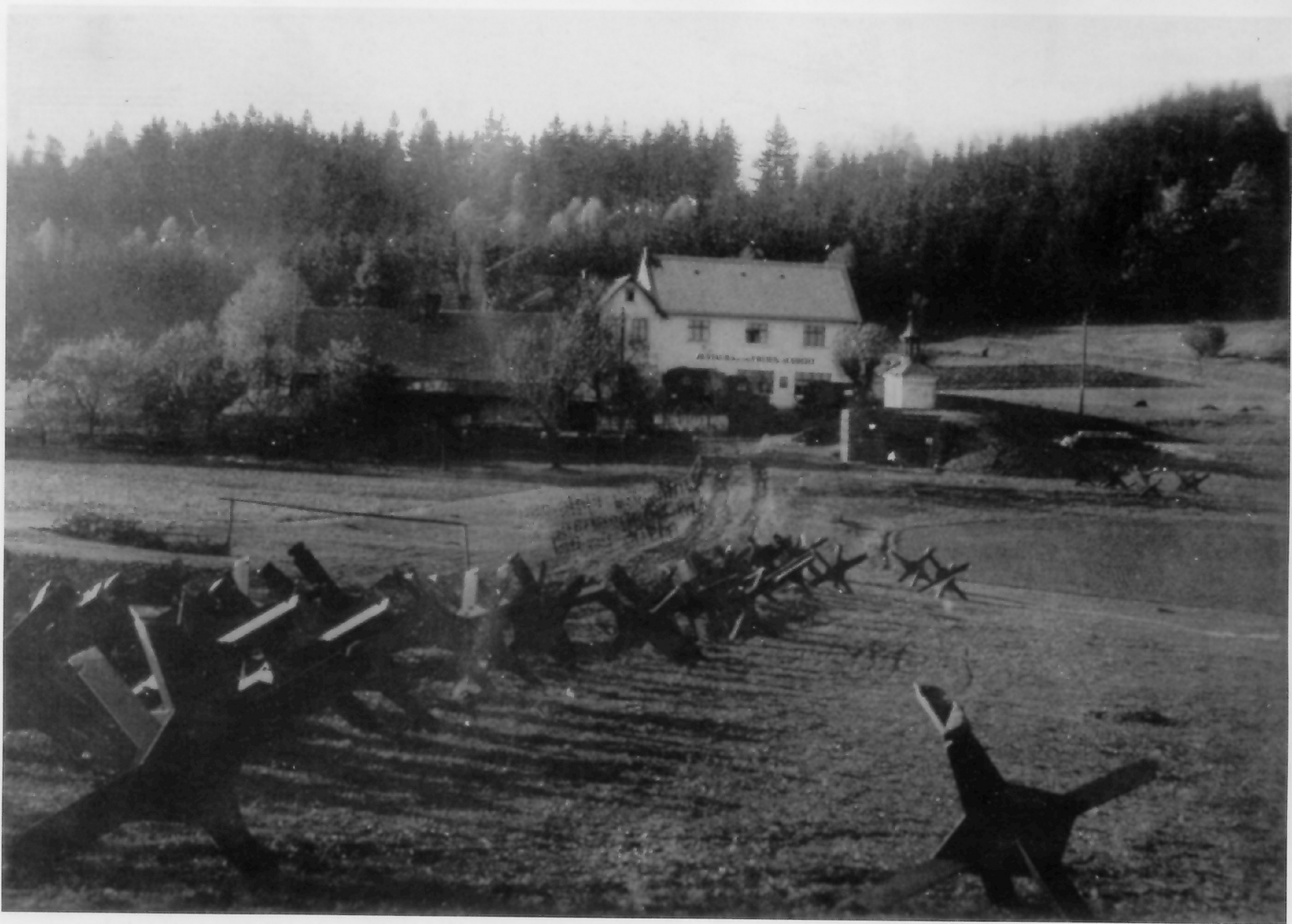
Im Bild Spanische Reiter in der tschechoslowakischen Befestigungslinie. Ortseingänge, Straßen und Brücken sind mit diesen mobilen Sperren geschlossen wurden, aber ohne flankierende Wirkung mit anderen Hindernissen oder Bewaffnung blieben sie unwirksam.
