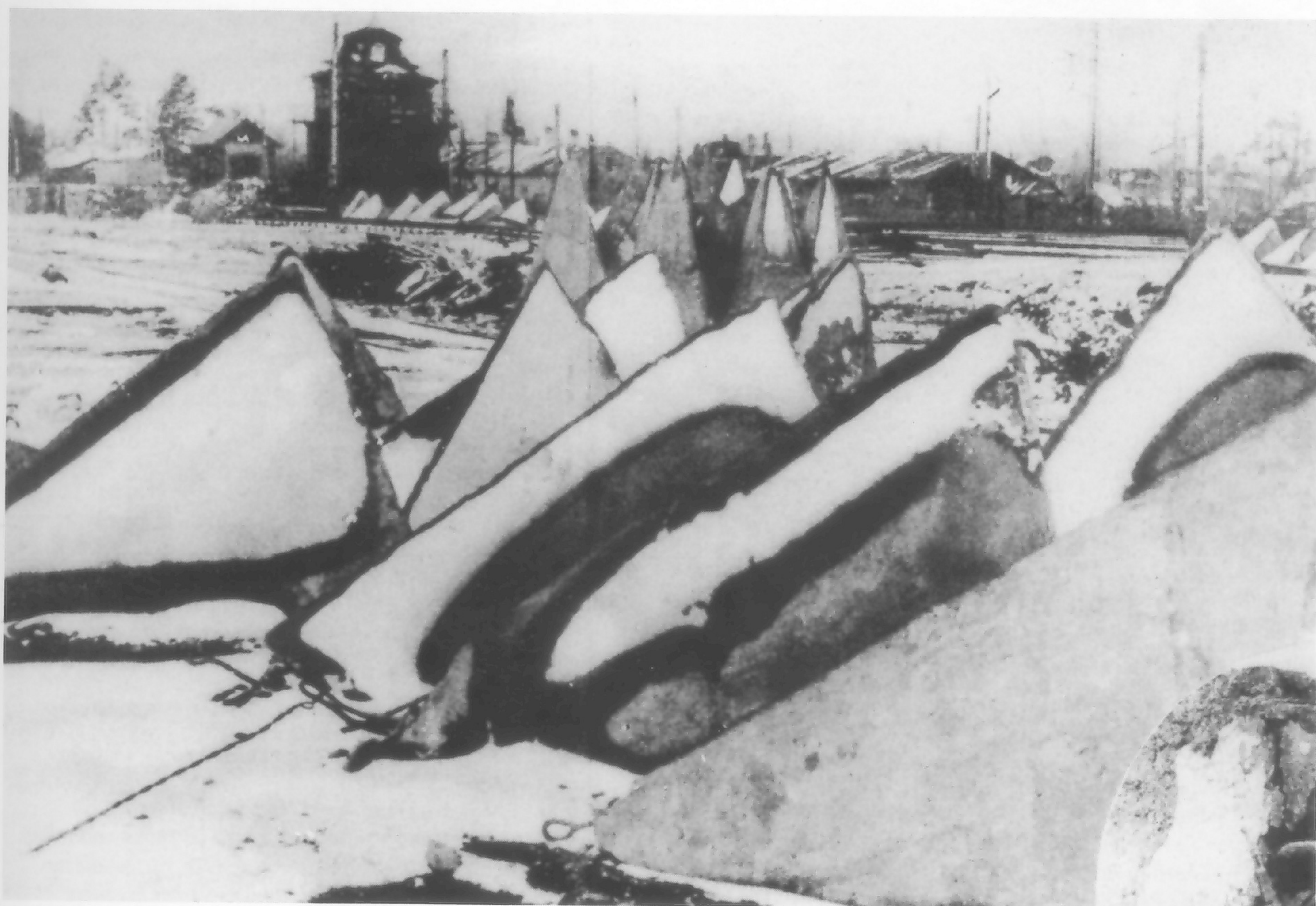
Transportable Panzersperren aus Betonfertigteilen. Bild oben in Polen 1939 und Bild unten Herbst /Winter 1941 in Rußland.
