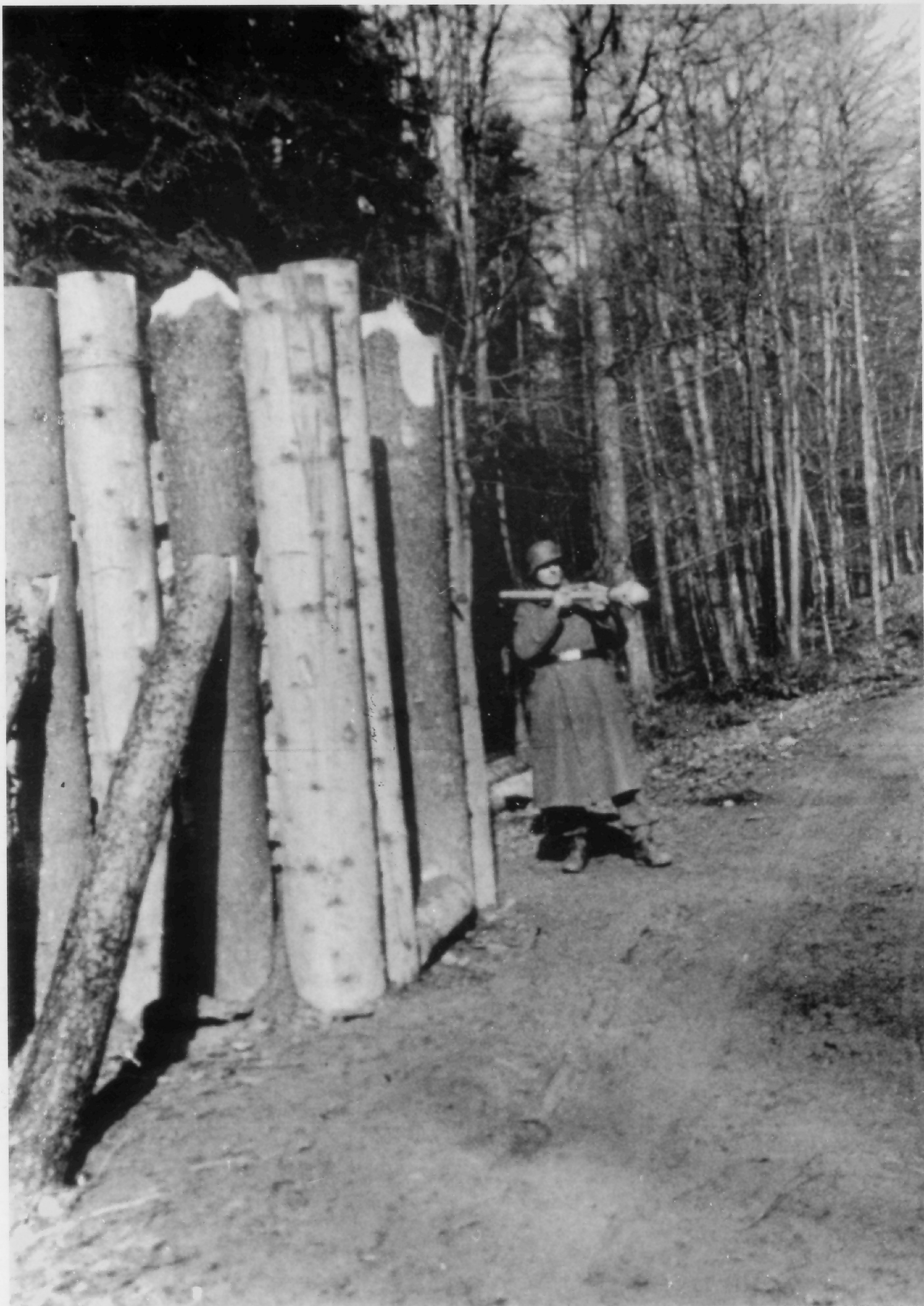
Eine Panzersperre aus Baumstämmen im Frühjahr 1945 in Österreich. Das Baumaterial wurde aus dem naheliegenden Wald geholt. Die Zwischenräume sind mit Schotter und Erde ausgefüllt.
