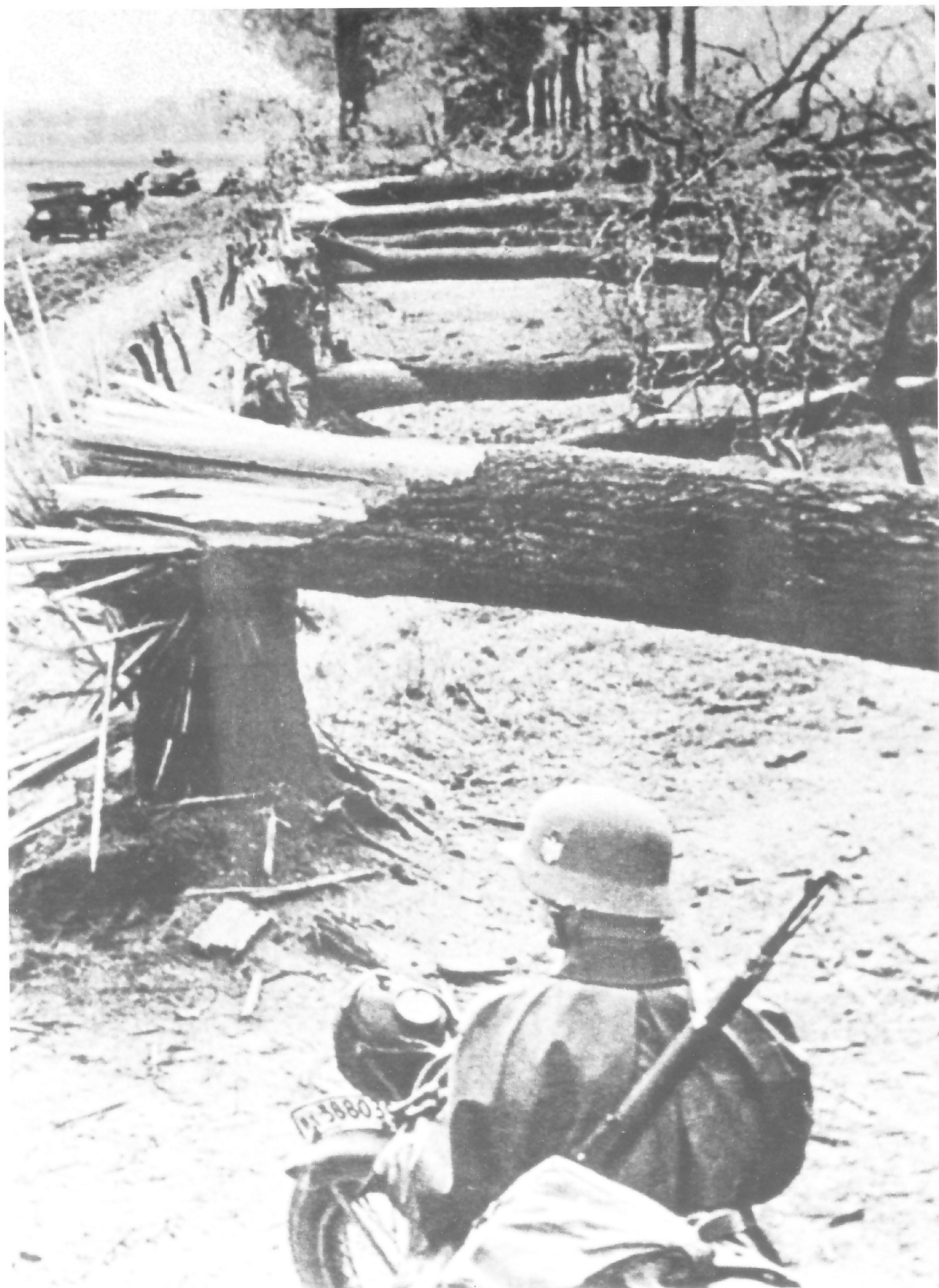
Schwere Baumsperre auf einer Straße in Holland 1940. Die Fahrzeuge sind gezwungen, den daneben liegenden Acker zur Durchfahrt zu nutzen. Im dichten Wald oder an nicht umgeharen Stellen können die Baumsperren den Gegner lange aufhalten. Die Aufräumarbeiten werden durch das Einflechten von Stacheldraht und versteckte Ladungen erschwert. Der Vorteil dieser Sperren ist, daß sie ohne großen Arbeitsaufwand nur mit Äxten, Schrot- oder Kraftsägen schnell errichtet werden konnten.
