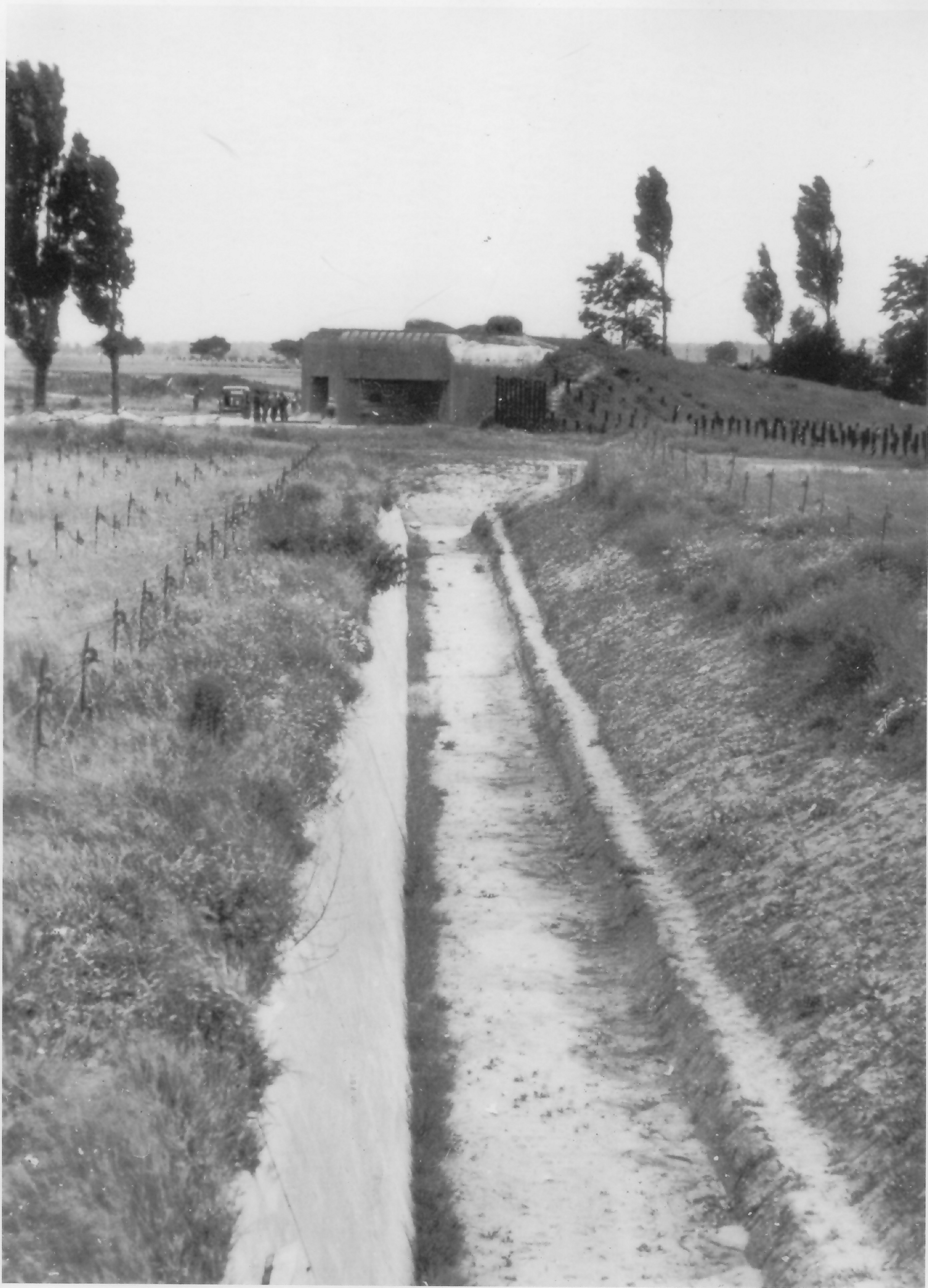
Diese Aufnahmen entstanden 1939 in den tschechischen Befestigungsanlagen, bei Engerau an der Donau. Der Panzergraben ist feindseitig betoniert. Das Bild zeigt anschaulich, wie man sich das Zusammenwirken von passiven und aktiven Panzerabwehrmitteln vorgestellt hat. Angreifende Panzer, die durch das Panzerhindernis aufgehalten wurden, wären dem Feuer der flankierend aus den Bunker wirkenden Geschützen hilflos ausgeliefert gewesen.
