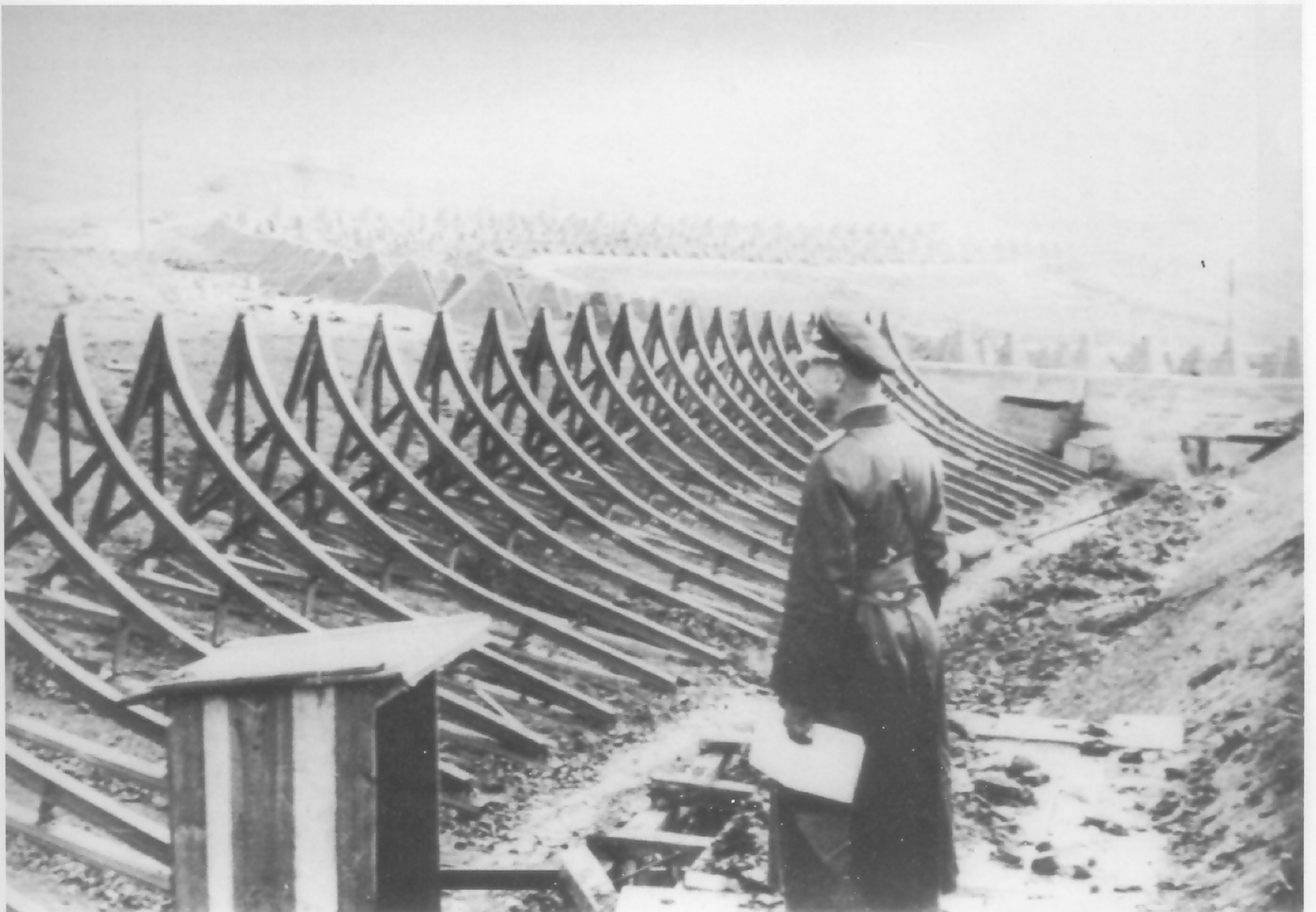
Hemmkurven sind 1937 in Deutschland speziell als Liniensperrung gegen Panzerkampfwagen in Festungskampffeldern entwickelt worden. Ihre Konstruktion gestattete auch den Einsatz als Straßensperre. In Verbindung mit Minen, Drahtverhauen, Höckerhindernissen wurden sie häufig flankierend eingesetzt. Die Aufnahmen stammen vom Westwall 1940.
