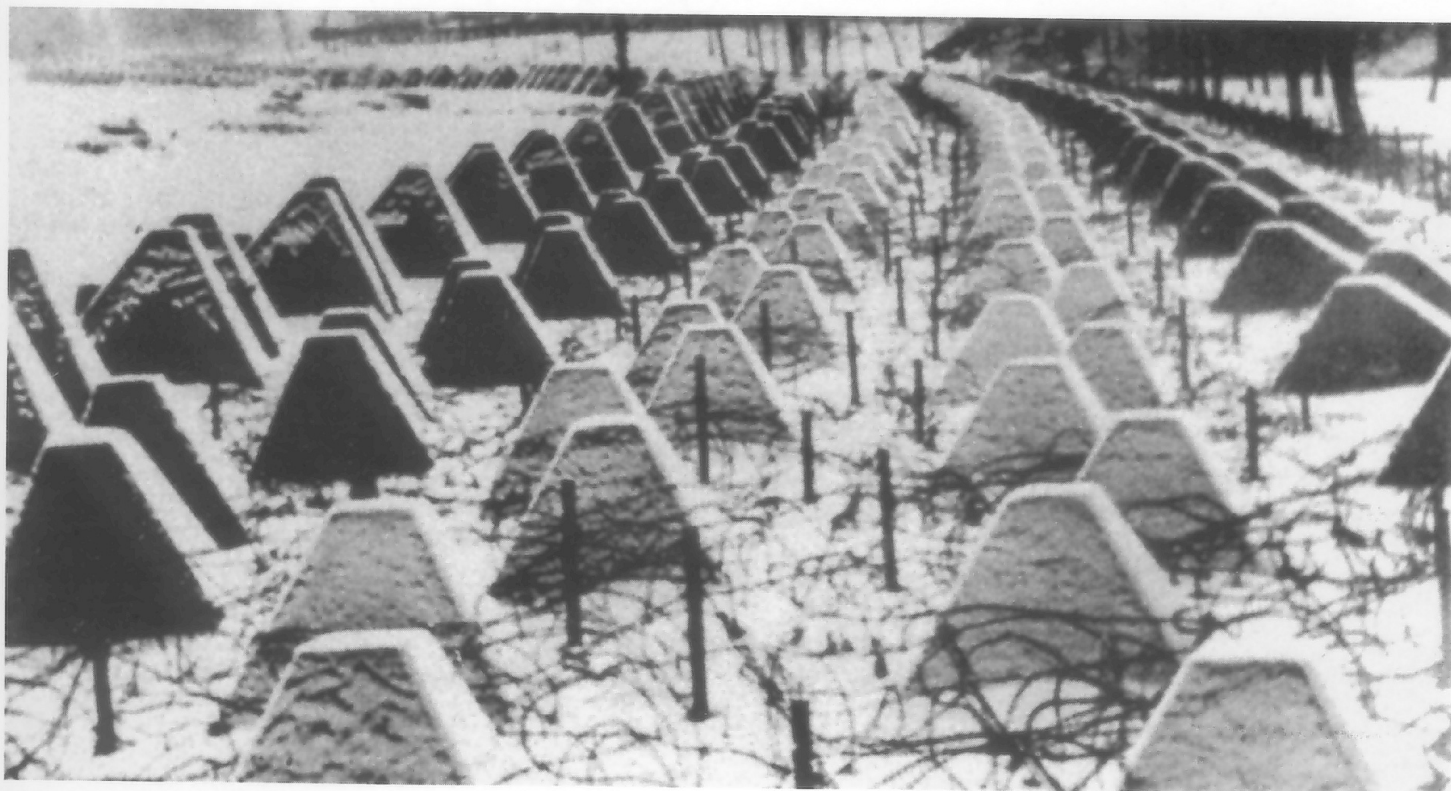
Höckerlinie aus der Befestigungsanlage im Westen Deutschlands. Verstärkt mit Stacheldraht.
