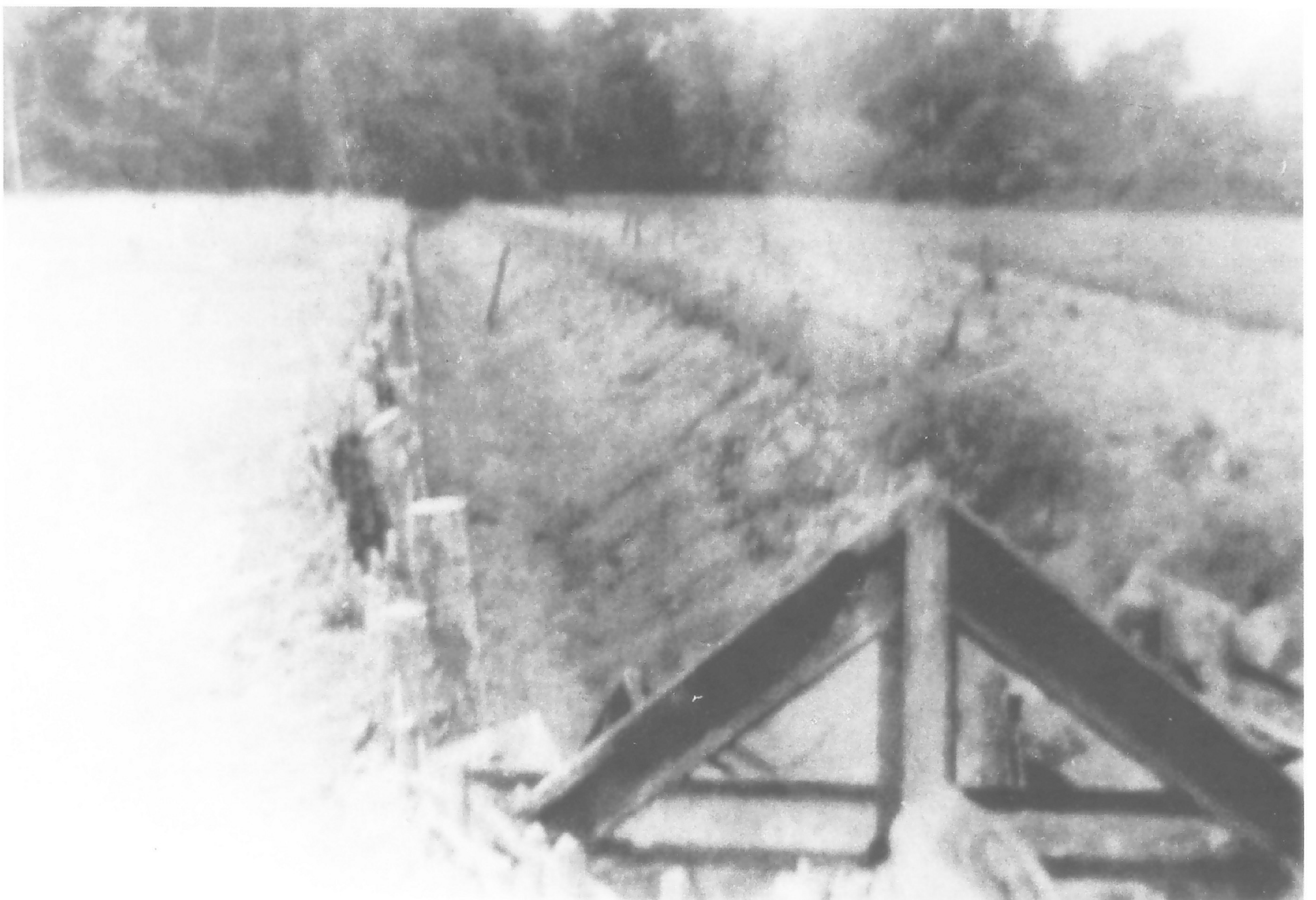
Belgischer Panzergraben aus dem Jahr 1940, feindseitig abgeschrägt und mit Holzstämmen gesichert.
