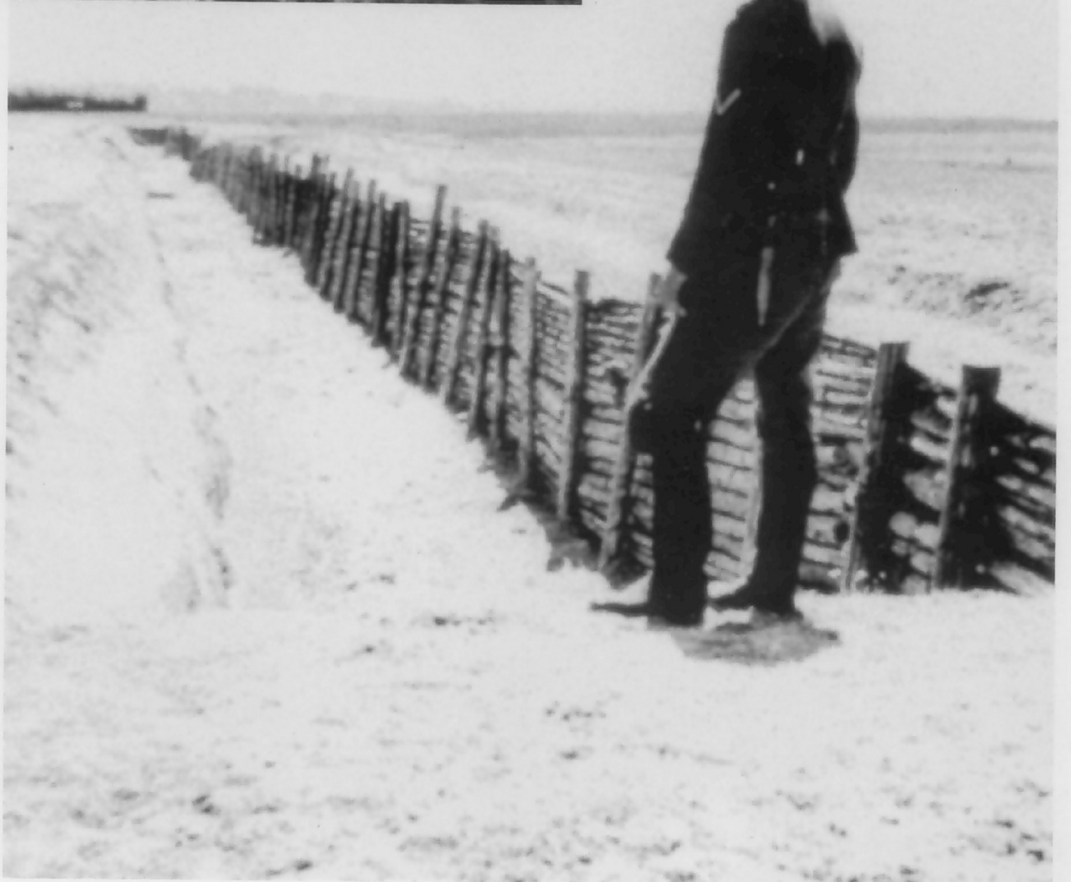
Russischer einseitig faschinierter Panzergraben im Südabschnitt der Ostfront 1941.
