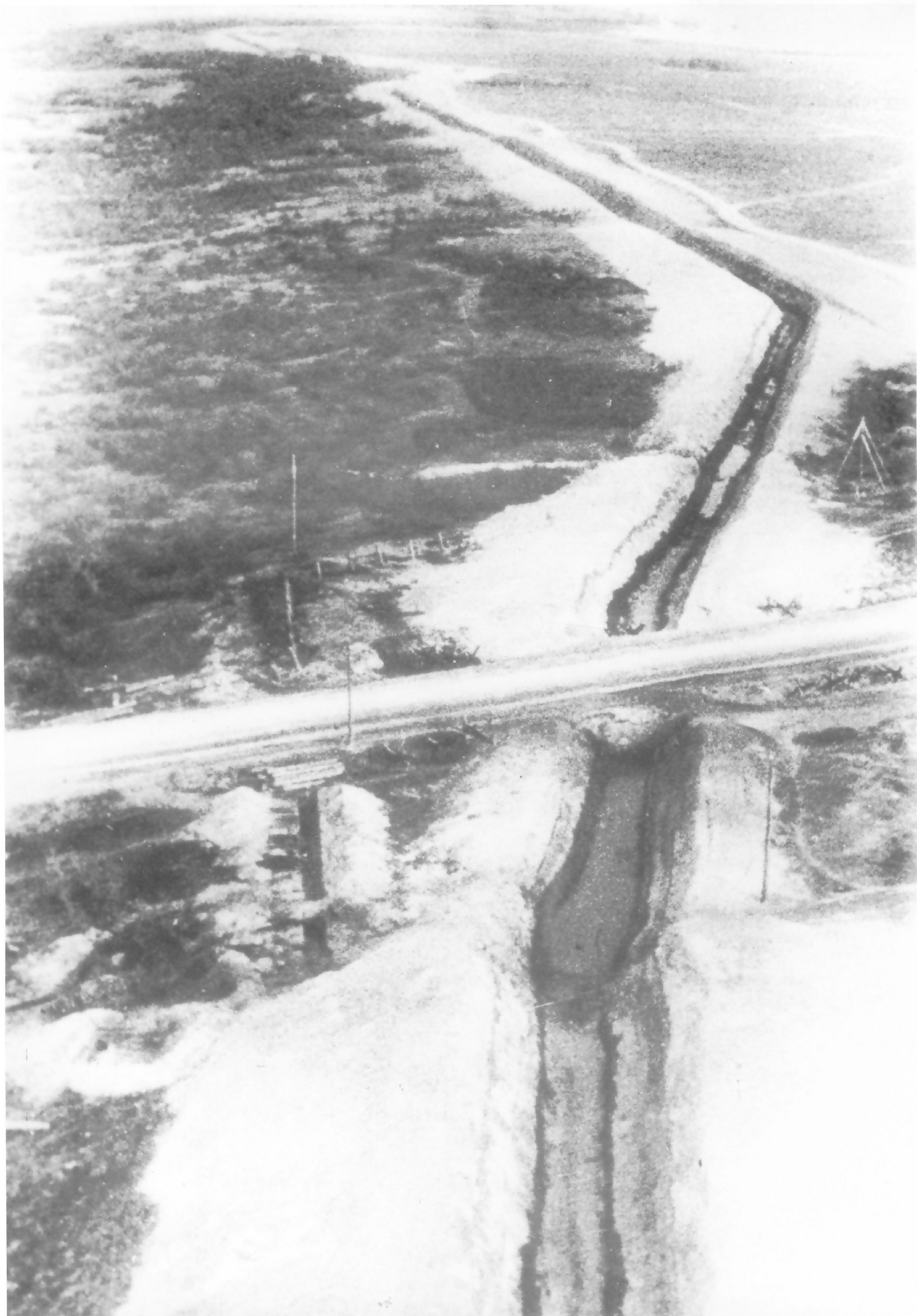
Panzerspitzgraben aus dem Verteidigungssystem der Stalin-Linie. Die frische Erdaufschüttung erleichterte das Erkennen seines Verlaufes. Aufnahmen vom Sommer 1941.
