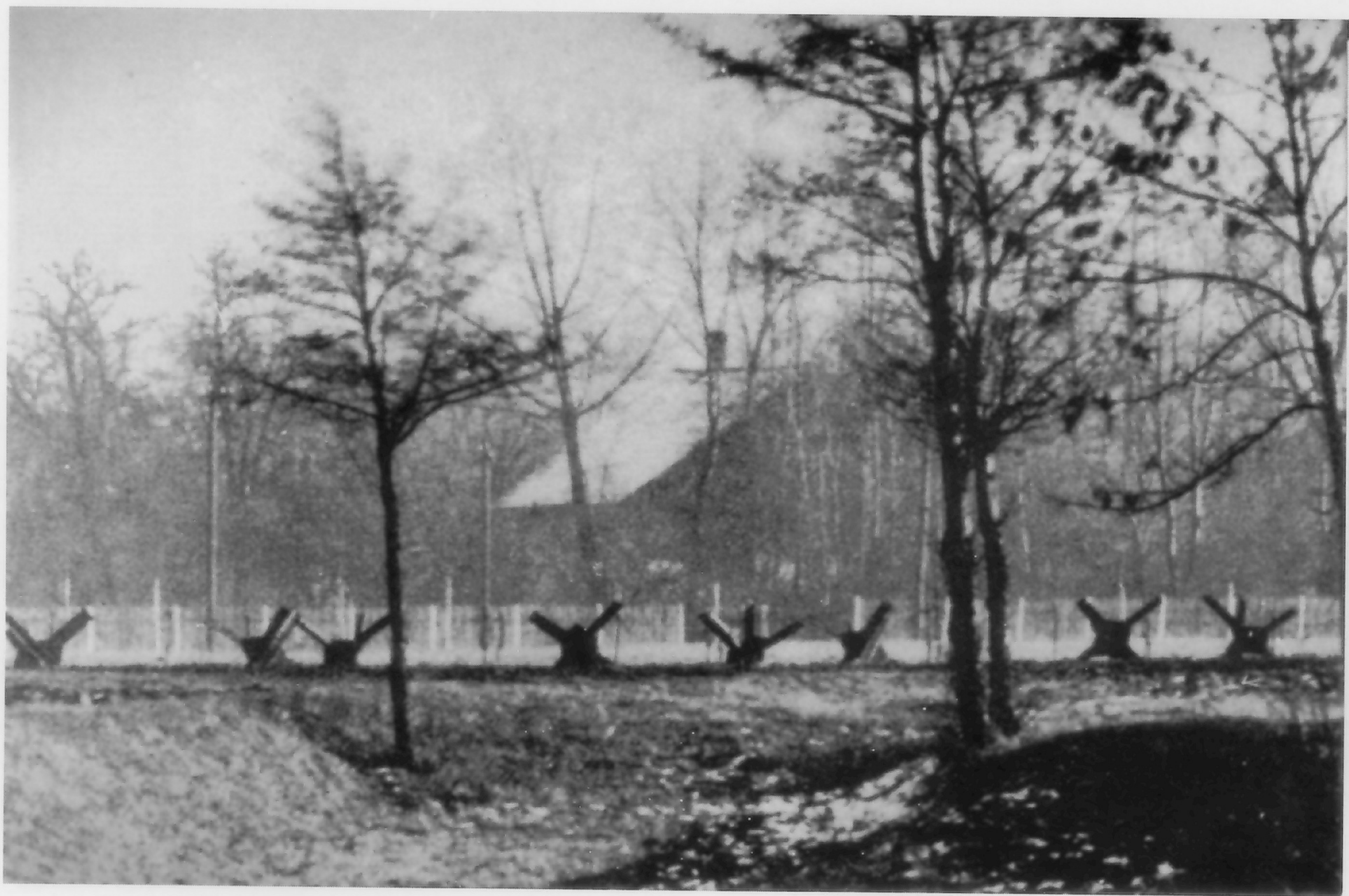
Im Bild Spanische Reiter in der tschechoslowakischen Befestigungslinie. Ortseingänge, Straßen und Brücken sind mit diesen mobilen Sperren geschlossen wurden, aber ohne flankierende Wirkung mit anderen Hindernissen oder Bewaffnung blieben sie unwirksam.
