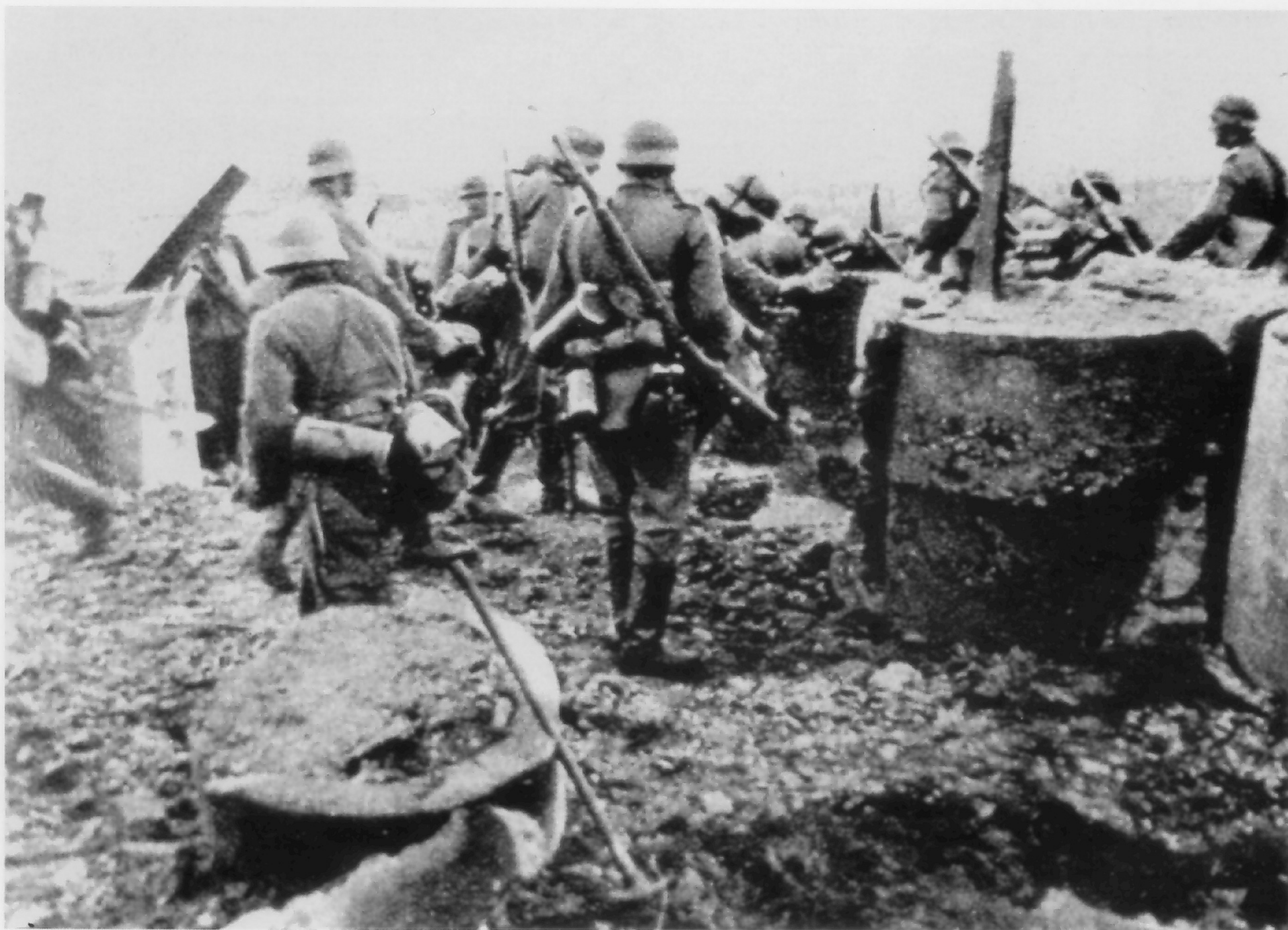
Diese aus Beton und Stahl errichteten Straßensperren erforderten zu ihrer Beseitigung einen erheblichen Arbeits- und Zeitaufwand.
