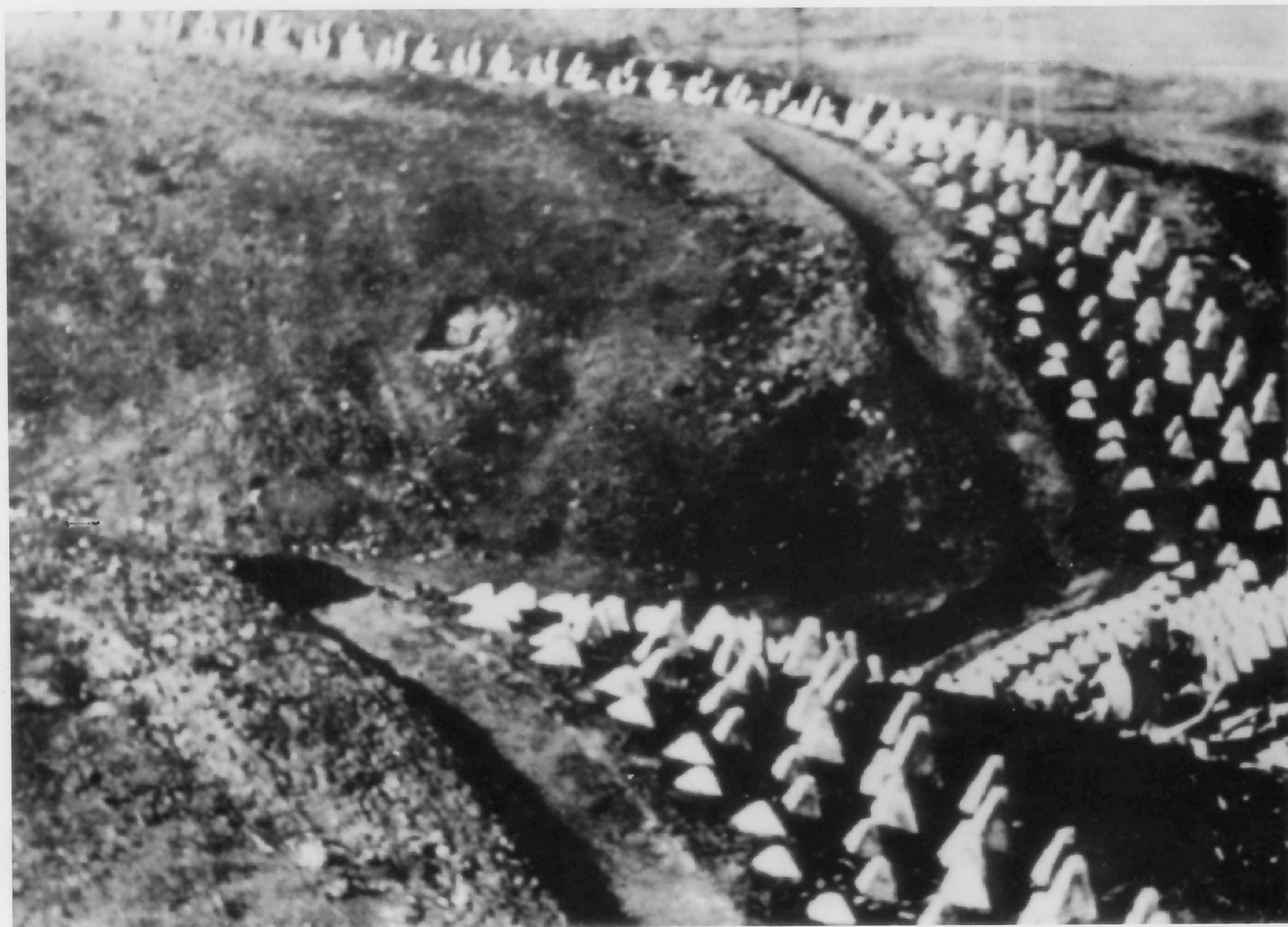
Prinzip der Höckerlinie war es, daß die Kampfwagen auf die erste Reihe aufrollen, sich dann festsetzen, um auf der letzten Reihe bewegungsunfähig liegenzubleiben.
