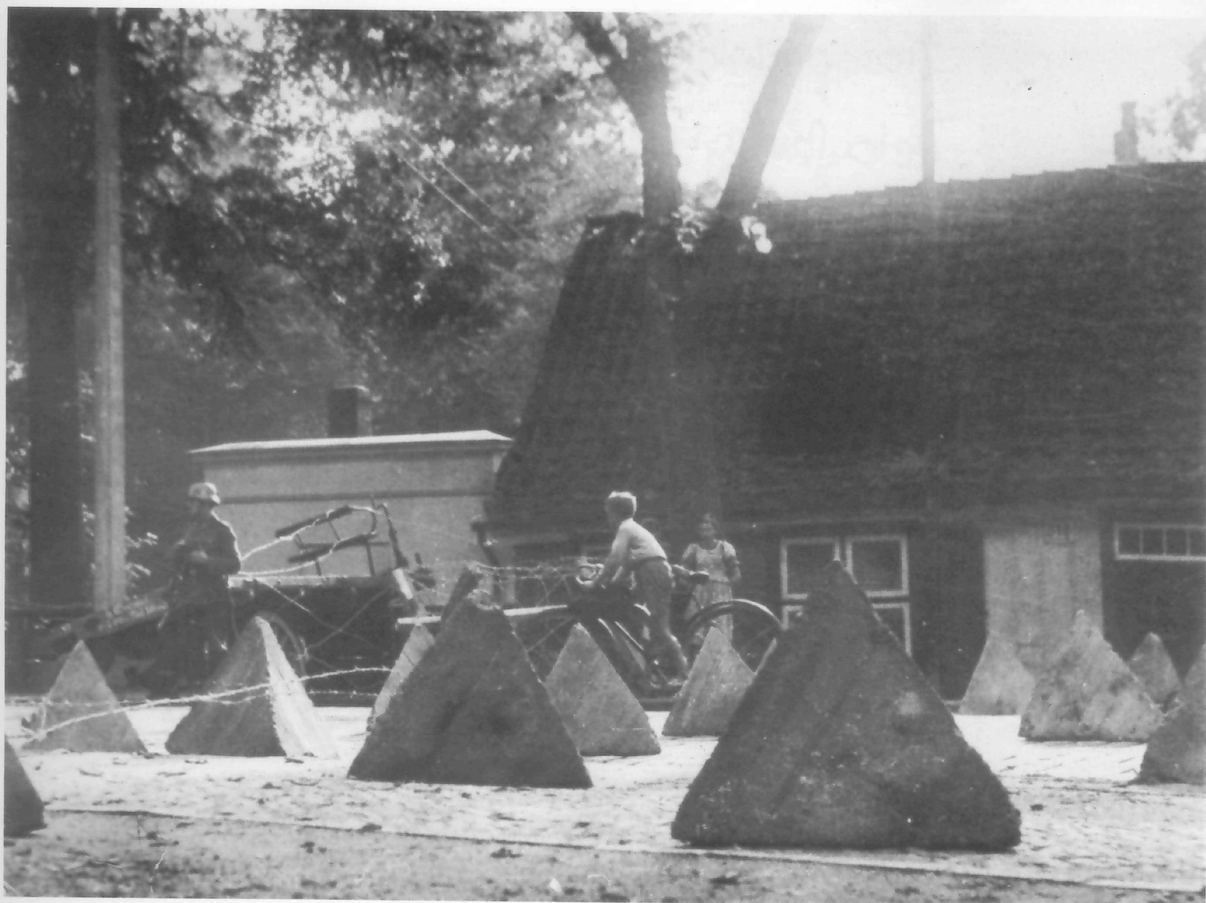
Transportable Panzersperren aus Betonfertigteilen. Bild oben in Polen 1939 und Bild unten Herbst /Winter 1941 in Rußland.
