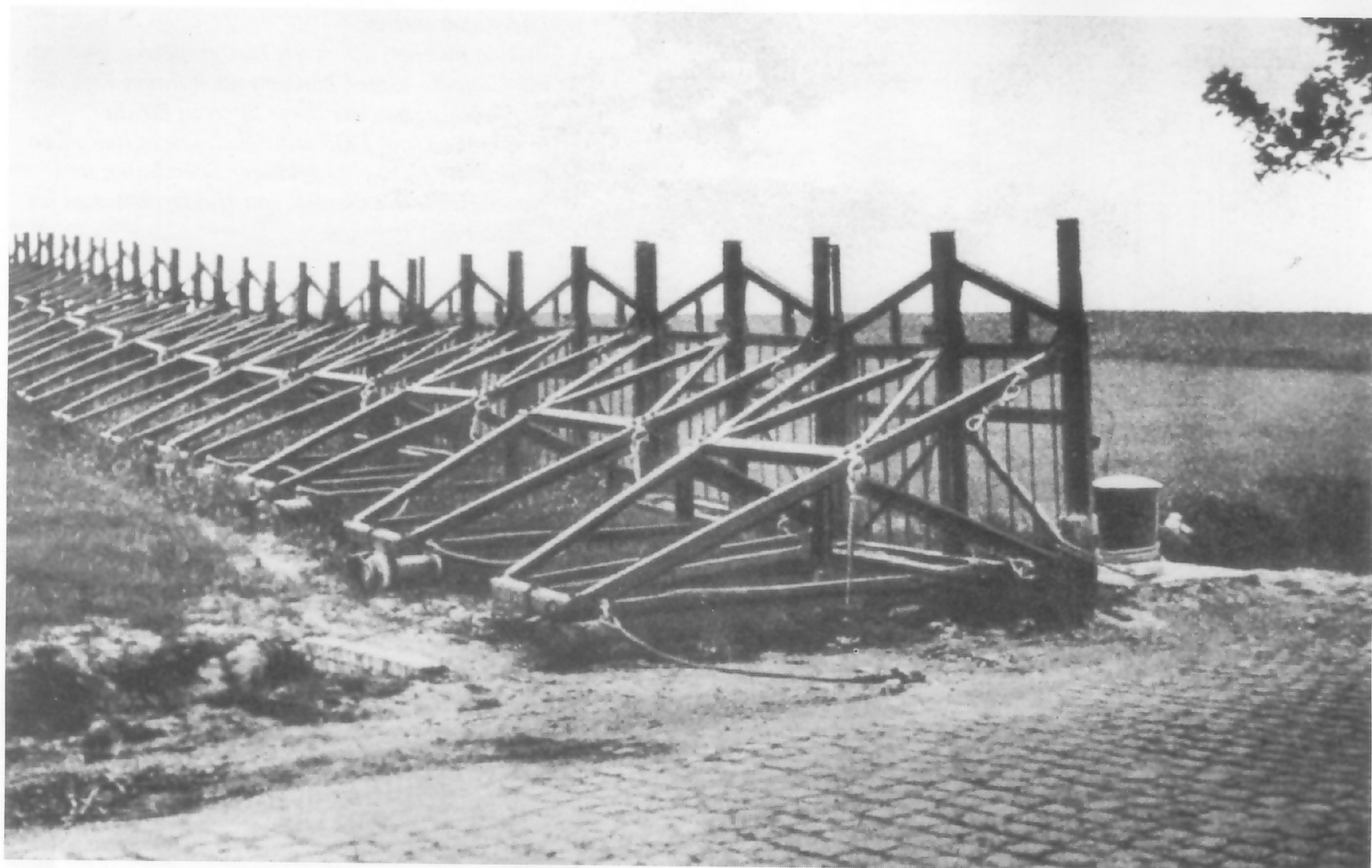
Im Bild gut zu sehen sind die einzelnen Gitterfelder der beweglichen Panzerhindernisse. Die 45. Gitter sind in Teilstücken von der Fabrik angeliefert und am Einbauort zusammengesetzt wurden. Ein Gitter wog etwa 1400 kg und war 3 m breit und 3,28 m tief. Die Höhe an der Frontseite betrug 2,50 m und die Höhe der Rückseite 1,20 m. Für die Durchfahrt wurden zwei Rollgitter herausgerollt. Mittels der Halbscharniere rechts und links jedes Gliedes und den 4 Haltetrossen konnten die Rollgitter wieder zu einer Sperrlinie verbunden werden.
