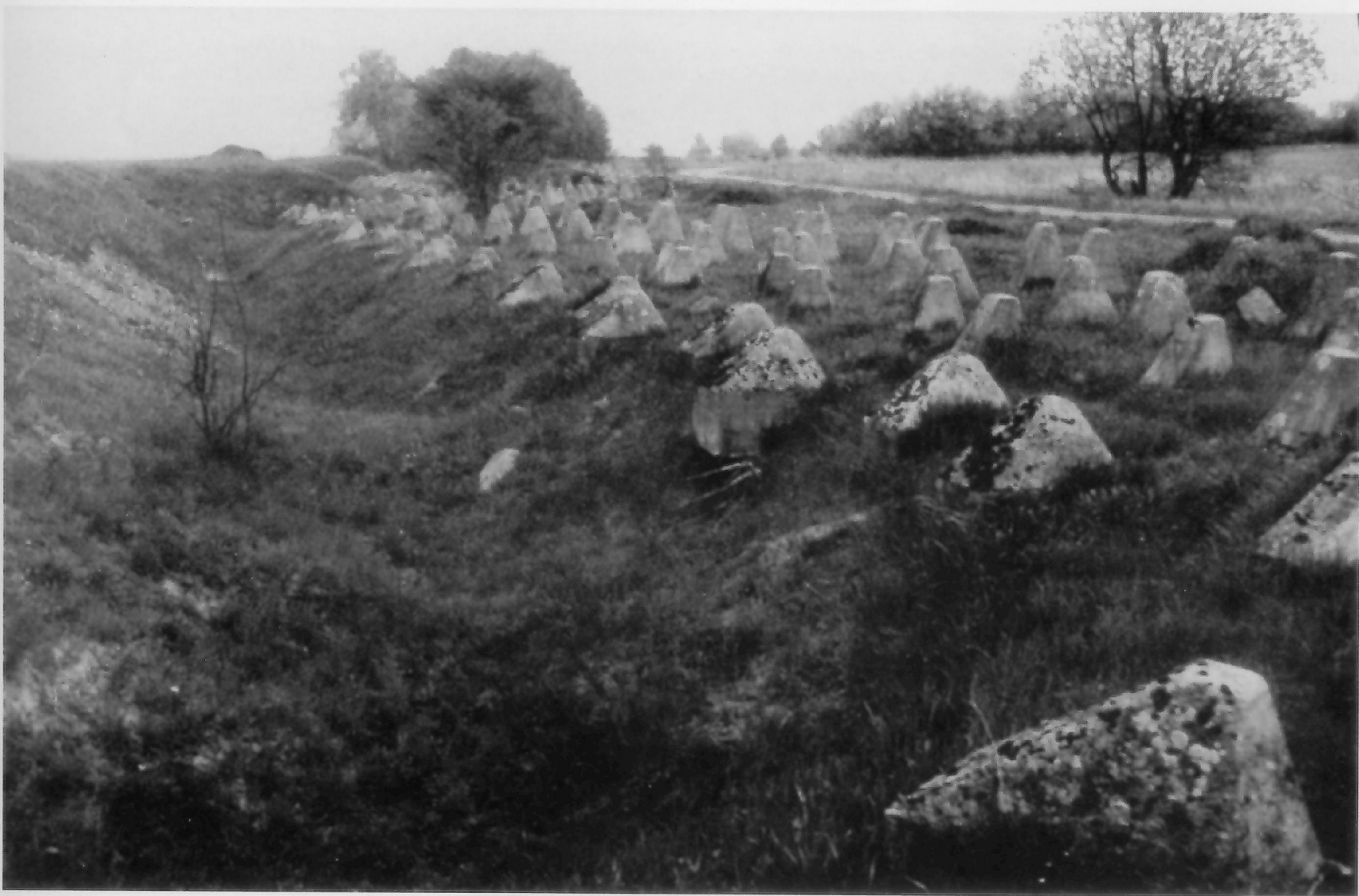
Auch Höckerhindernisse machten eine Entwicklung durch, die maßgeblich von der Weiterentwicklung, im Kampfwagenbau beeinflusst worden ist. Deren Leistungsfähigkeit erfuhr eine Steigerung, der Hindernisbau mußte sich den neuen Bedingungen anpassen. Deutlich macht das ein Vergleich der Höckerhindernisse der Festungsfront im Oder-Warthe-Bogen, mit denen des Westwalls. Letztere wurden später hergestellt und sind größer ausgebildet.
