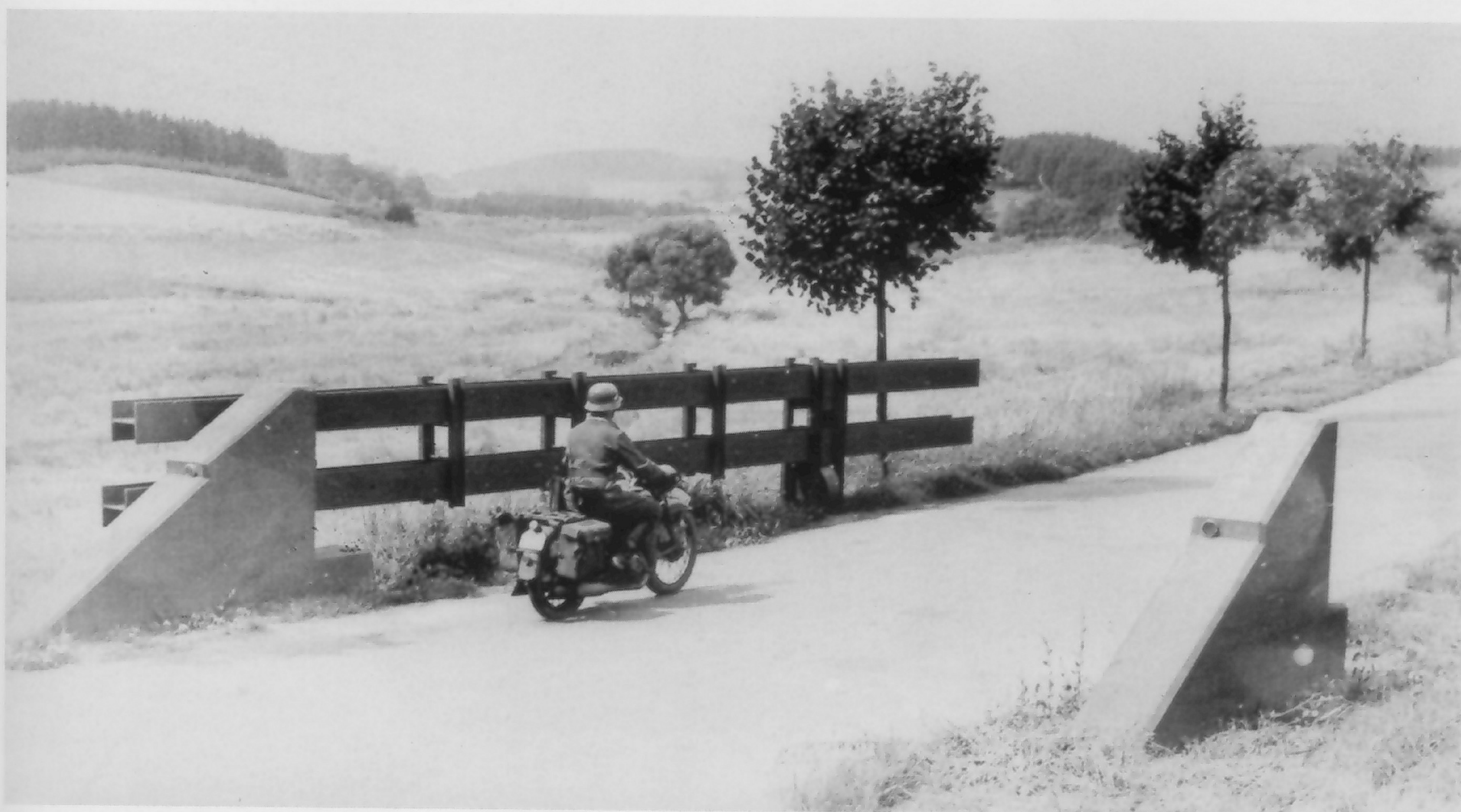
Durchlaß durch ein Panzerhindernis des Westwalls. Die aus zwei Doppelträgern bestehende Sperre wurde erst bei Annäherung gegen Kampfwagen eingeschwenkt und arretiert. Aufnahme vom Sommer 1939.
