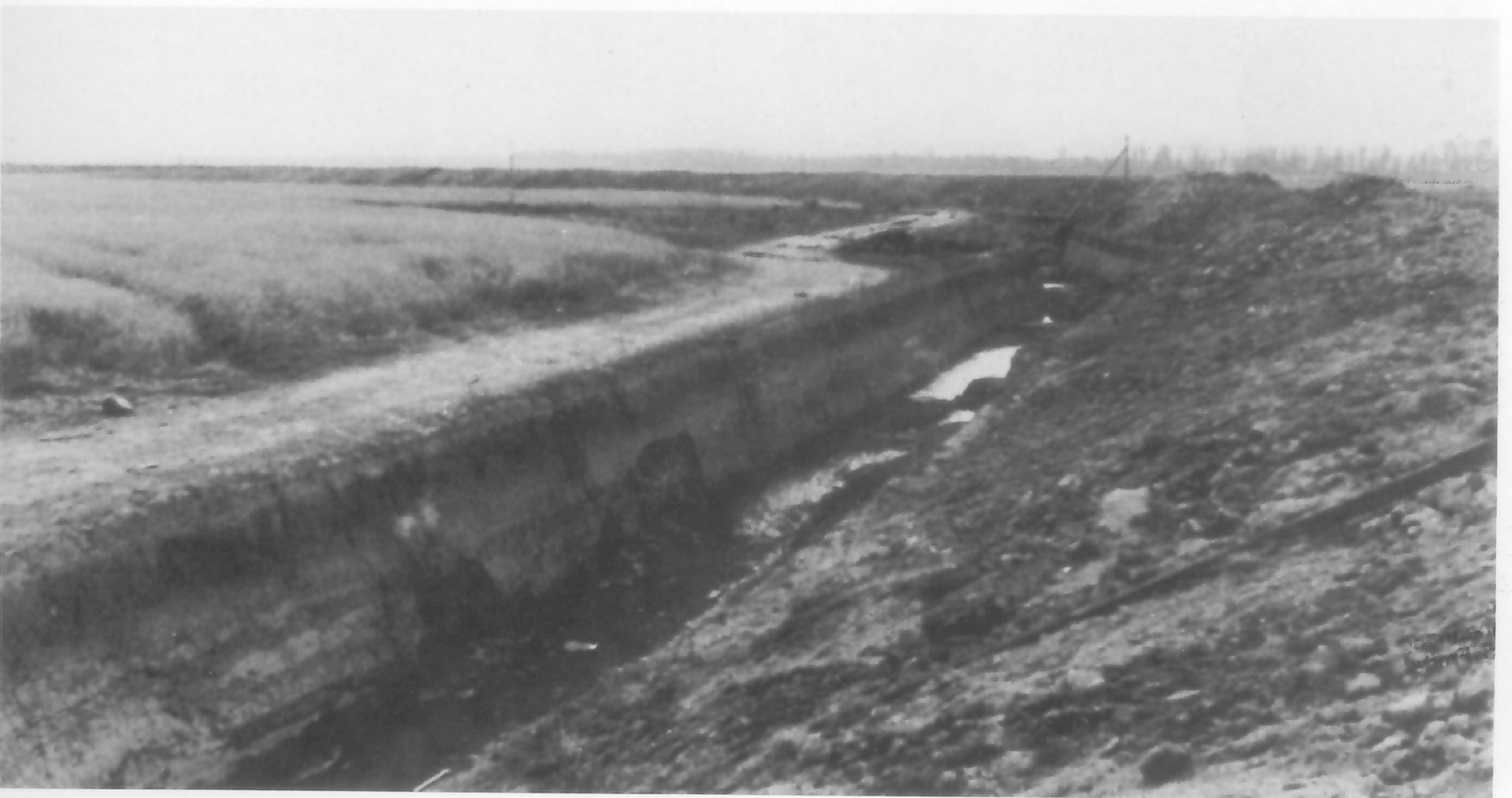
Im Bild ein russischer Panzergraben. Aufnahme vom Herbst 1941. Im Lagebericht der Panzergruppe 4 vom 29. 2. 1941 - 5.12.1941 heißt es zu den sowjetischen Panzergräben: sie sind 2 m tief, 3 bis 4 m breit und haben senkrecht abgestochene Wände. 7.
