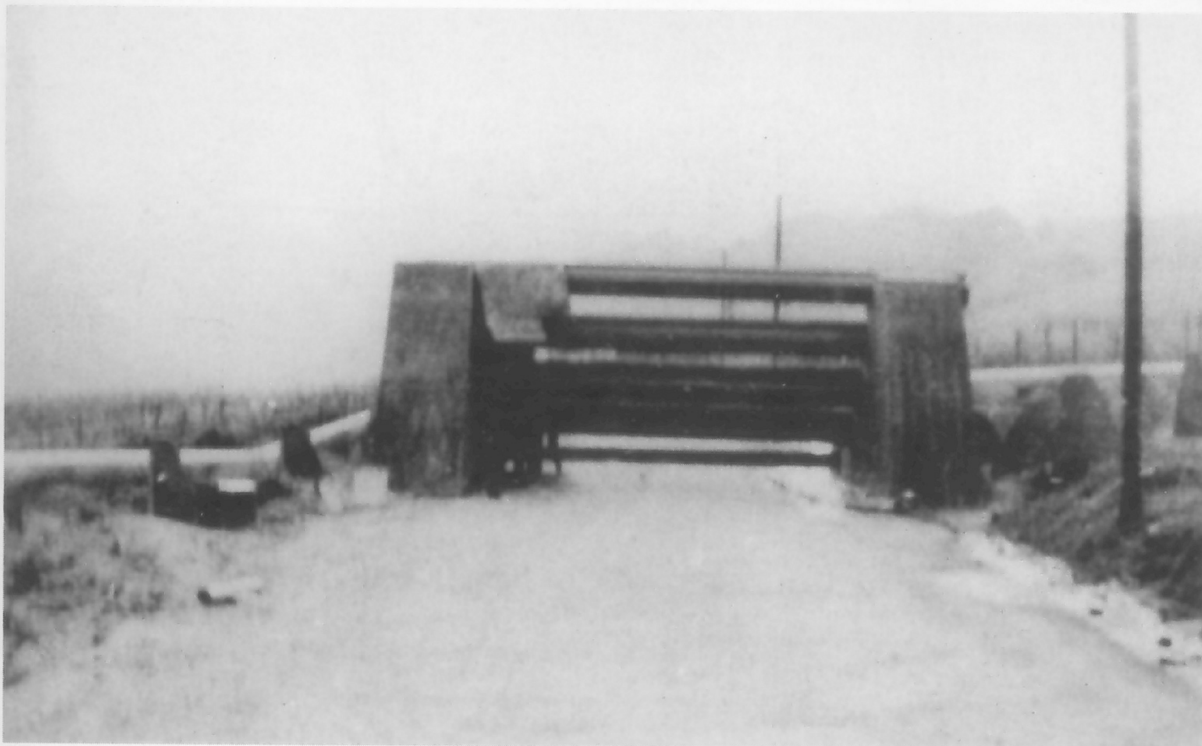
Im Bild eine für den Westwall typische Straßensperre mit fünf T-Trägern. Sie war speziell für die Höckerlinie entwickelt worden. Die T-Träger können bei Bedarf in die angebrachten Aussparungen eingelegt werden. An beiden Seiten sind Teile der Höckerlinie zu erkennen.
