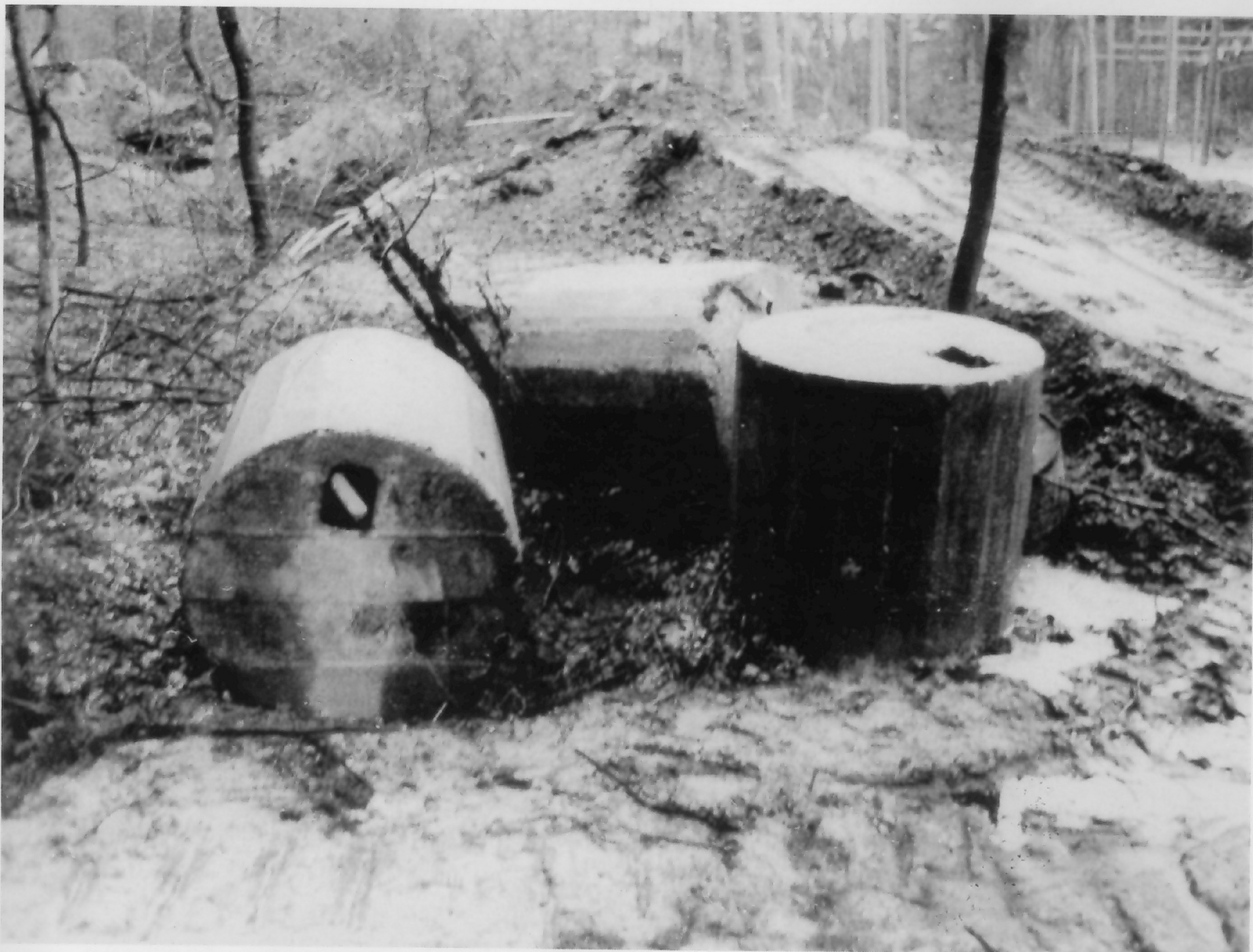
Straßensperre aus Betonzylindern und Stahlschienen. Derartige Sperren hatten die holländischen Streitkräfte bereits im Mai 1940 eingesetzt. Im Herbst setzten die Deutschen sie gegen alliierte Panzer ein, die nach Amsterdam durchstoßen wollten. Aufnahme aus dem holländischen Kriegs- und Widerstandsmuseum in Overloon aus dem Jahr 1995.
