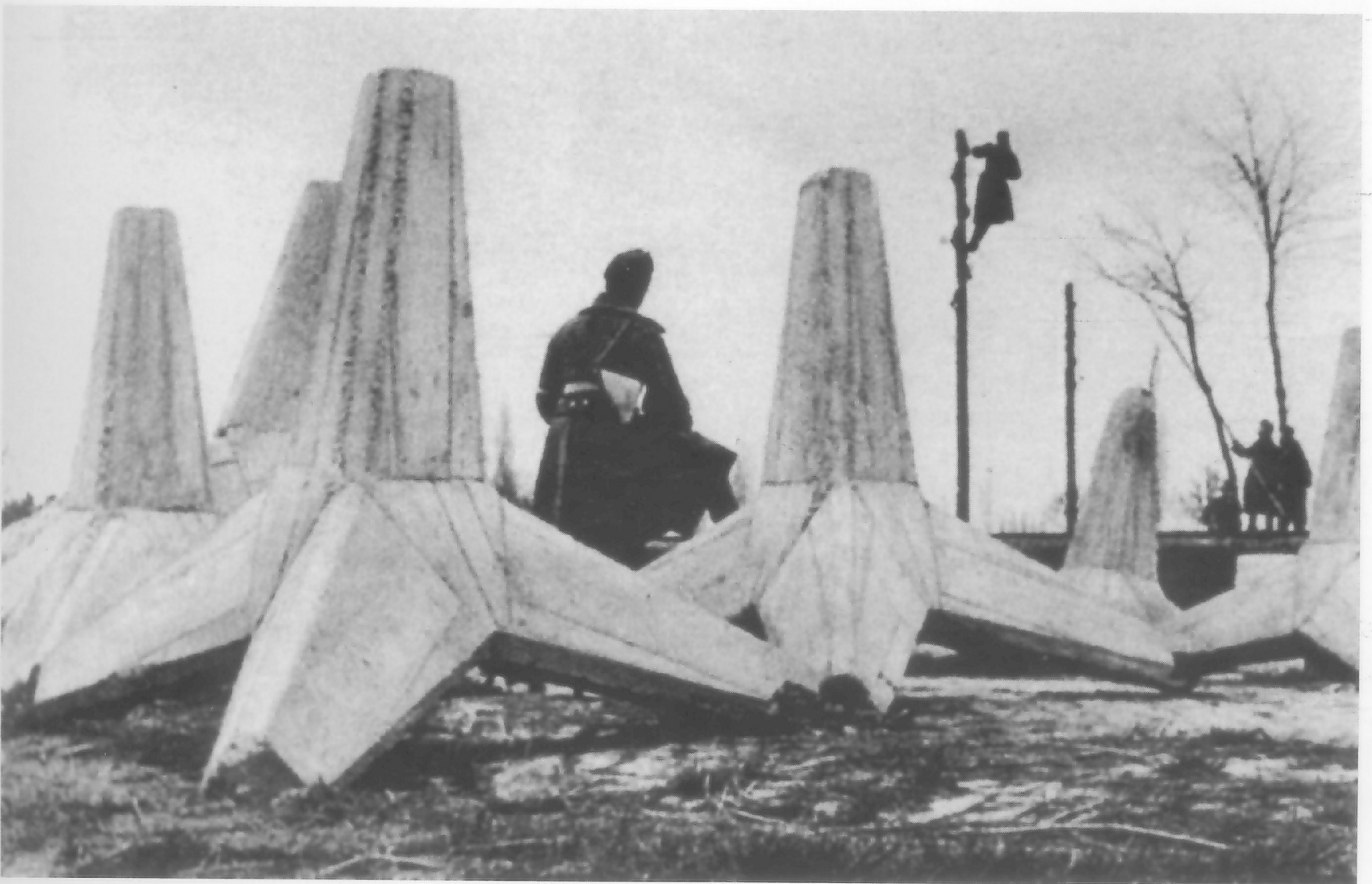
Eine Panzerstraßensperre aus „Tschechenigeln“ in Jugoslawien im Frühjahr 1941.
