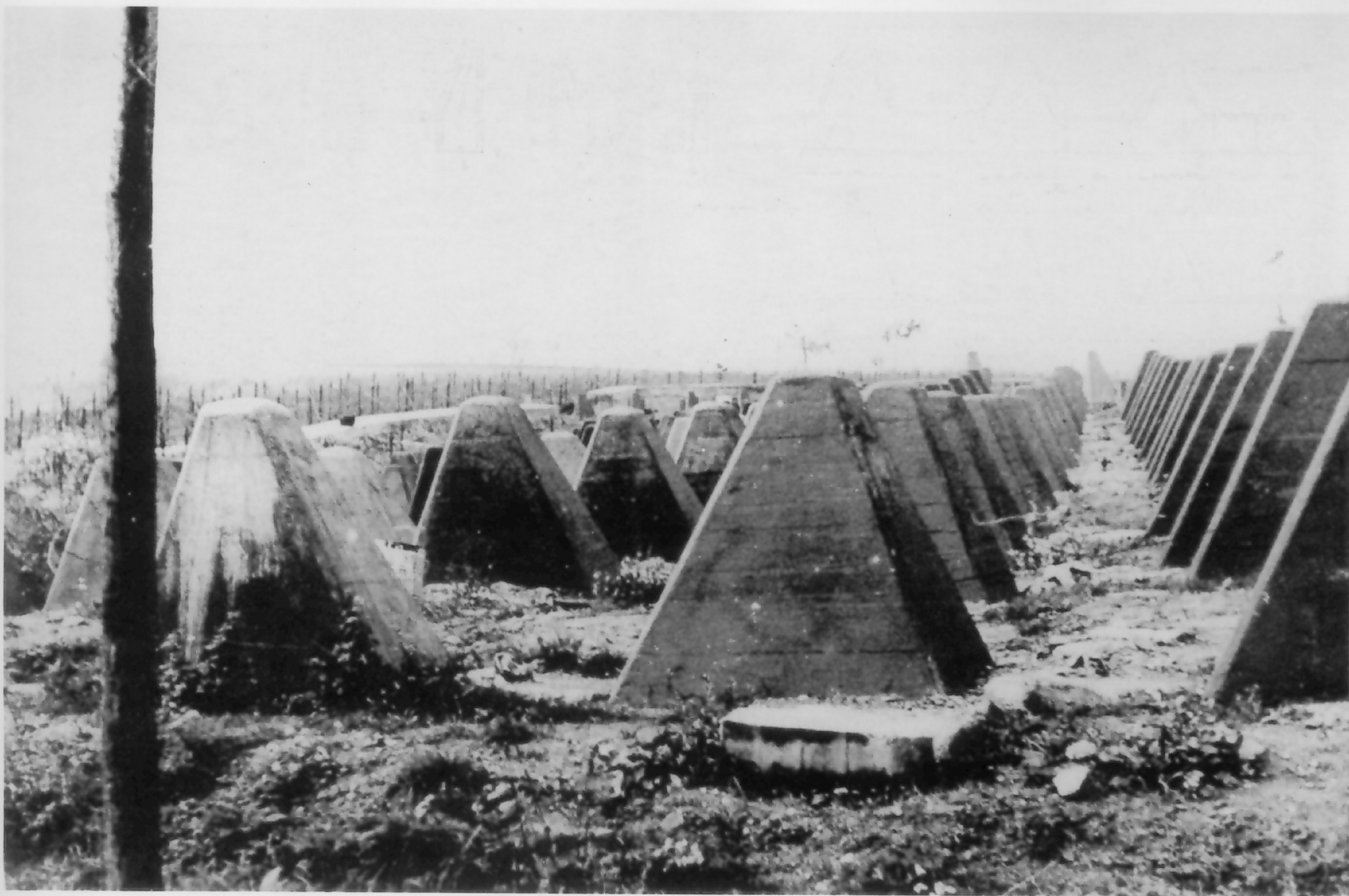
1944/45 konnte sich die deutsche Wehrmacht im Osten wie im Westen auf kilometerlange. Betonhindernisse zur Verteidigung der Festungsfronten stützen. Zu ihrer Verteidigung fehlten jedoch vielfach Kräfte und Mittel.
