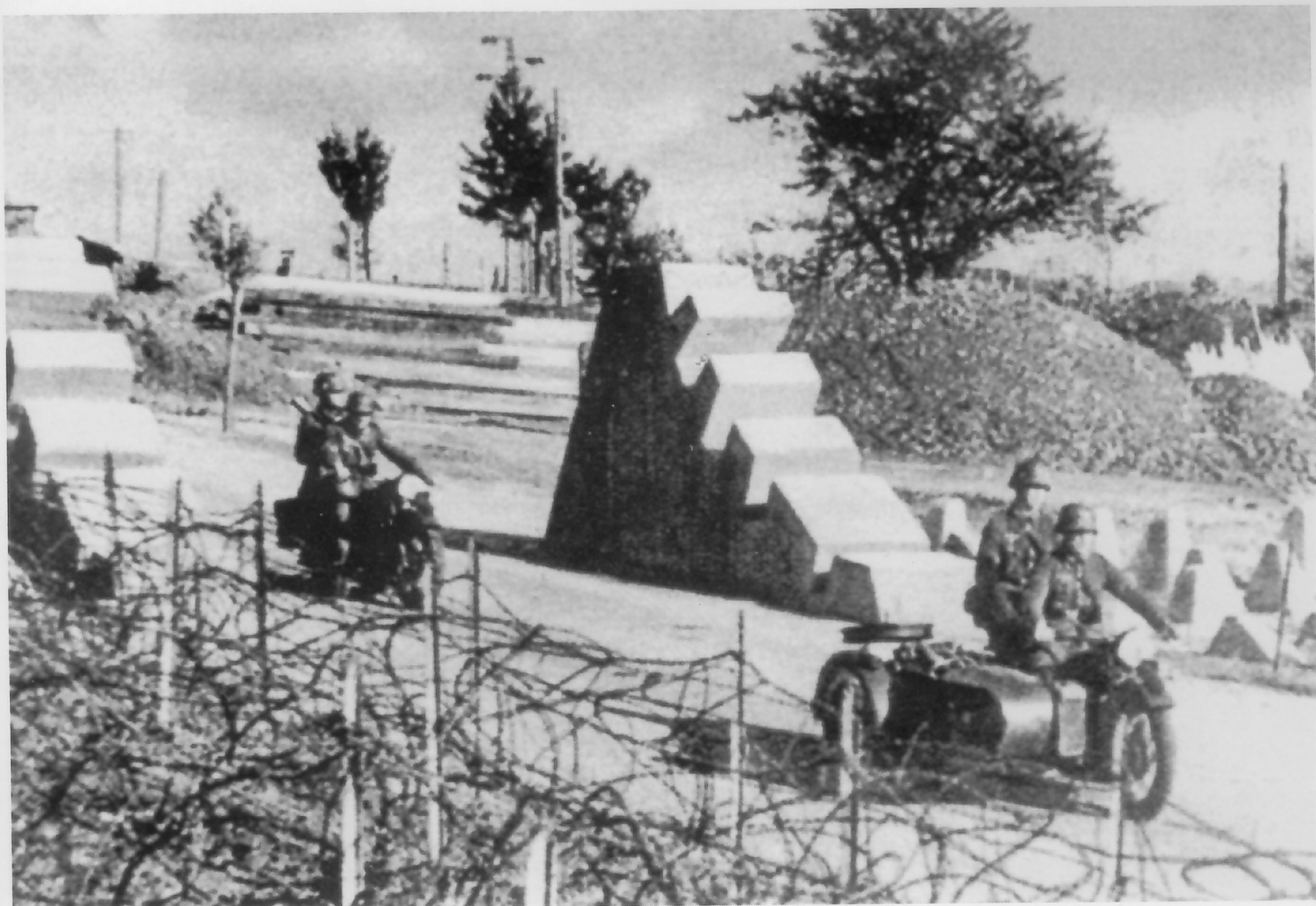
Bild oben: Die speziell für den Westwall entwickelte Höckerstraßensperre. 5 T-Träger oder Eisenbahnschienen wurden in die Aussparungen eingelegt. Bild unten: Straßenpanzersperre aus nur zwei Doppelträgern vor einer Eisenbahnbrücke in Verb am Westwall.
