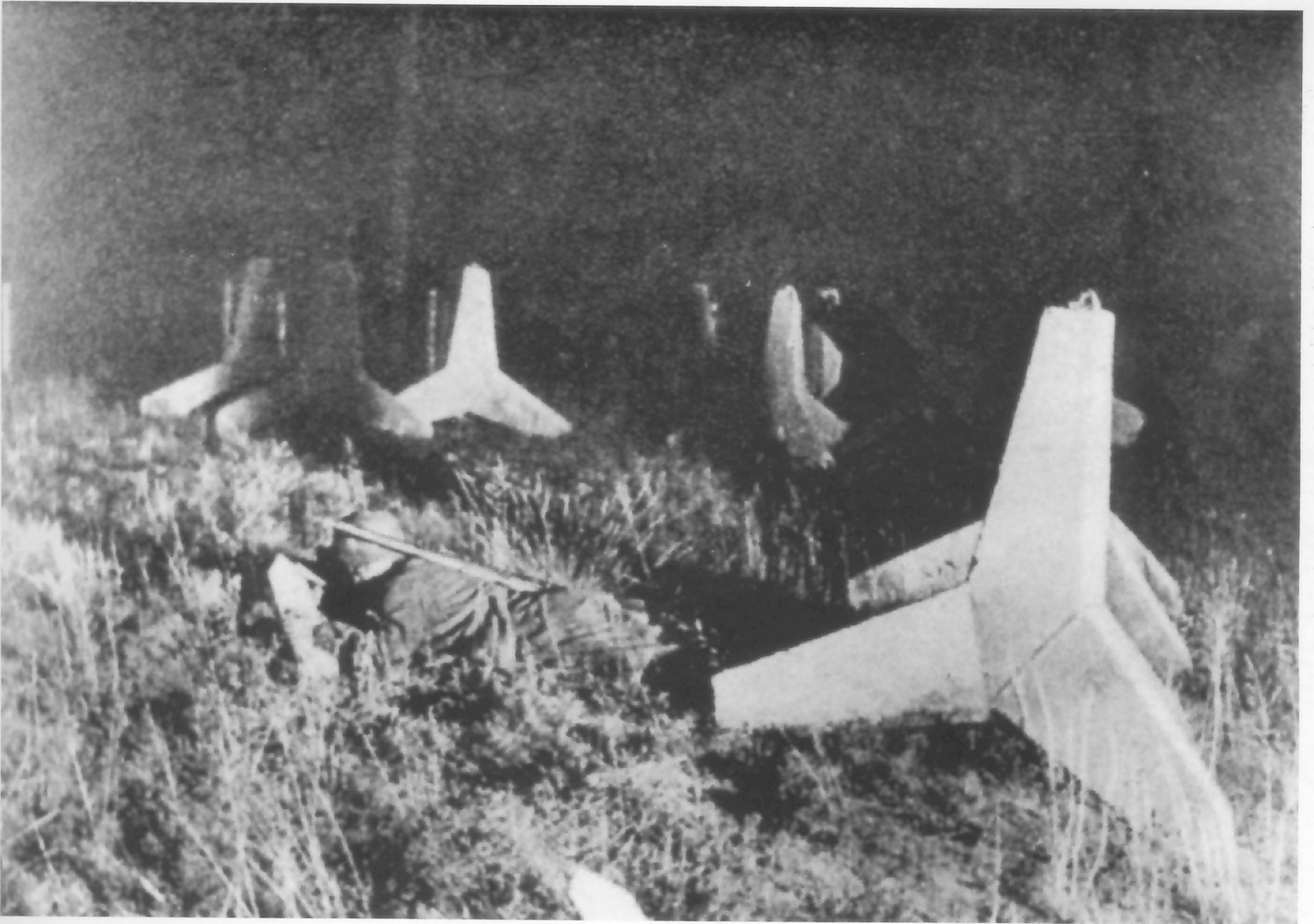
Zu den mobilen leichten Panzersperren zählen Betonigel, nach ihrer Herkunft auch „Tschechenigel“ genannt. Sie sind aus der tschechischen Verteidigungslinie ausgebaut und im Festungskampffeld des Westwalls wieder eingebaut worden. Hier im Foto Tschechenigel als Beute bei einer kombinierten Übung des Heeres von Panzern und Pionieren aus dem Jahr 1940.
