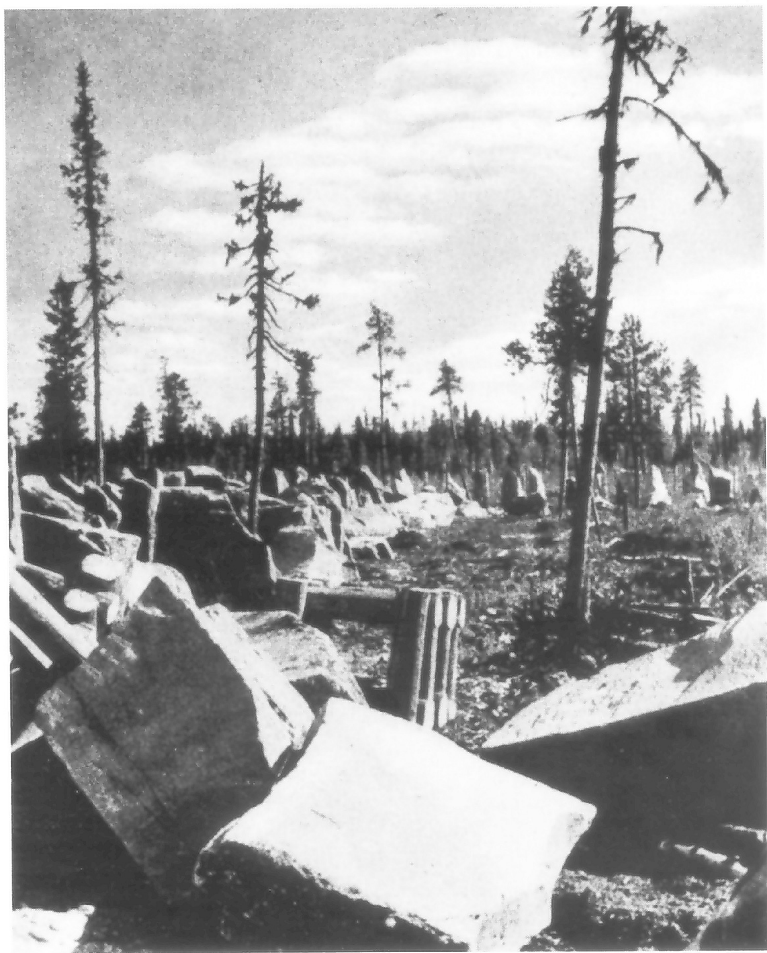
Zu den feldmäßigen Panzerhindernissen zählen auch künstlich errichtete Hindernisse wie zum Beispiel aneinander gereihte Felsblöcken.
