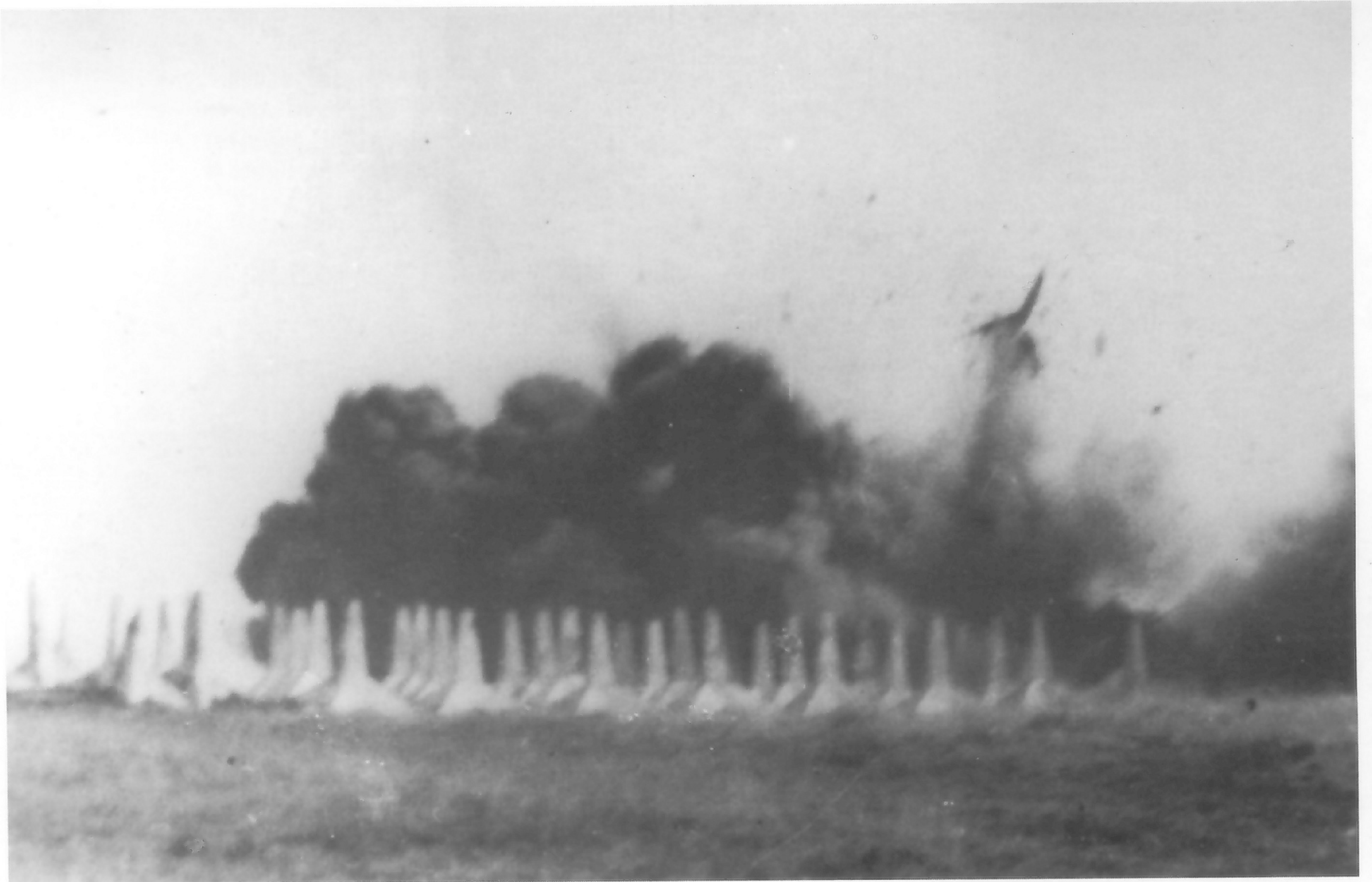
Diese Aufnahme entstand 1943/44 während eines Manövers. Mit Unterstützung von Pionieren übt eine Panzer - Ersatzabteilung die Beseitigung einer Panzersperre aus „Tschechenigeln“.
