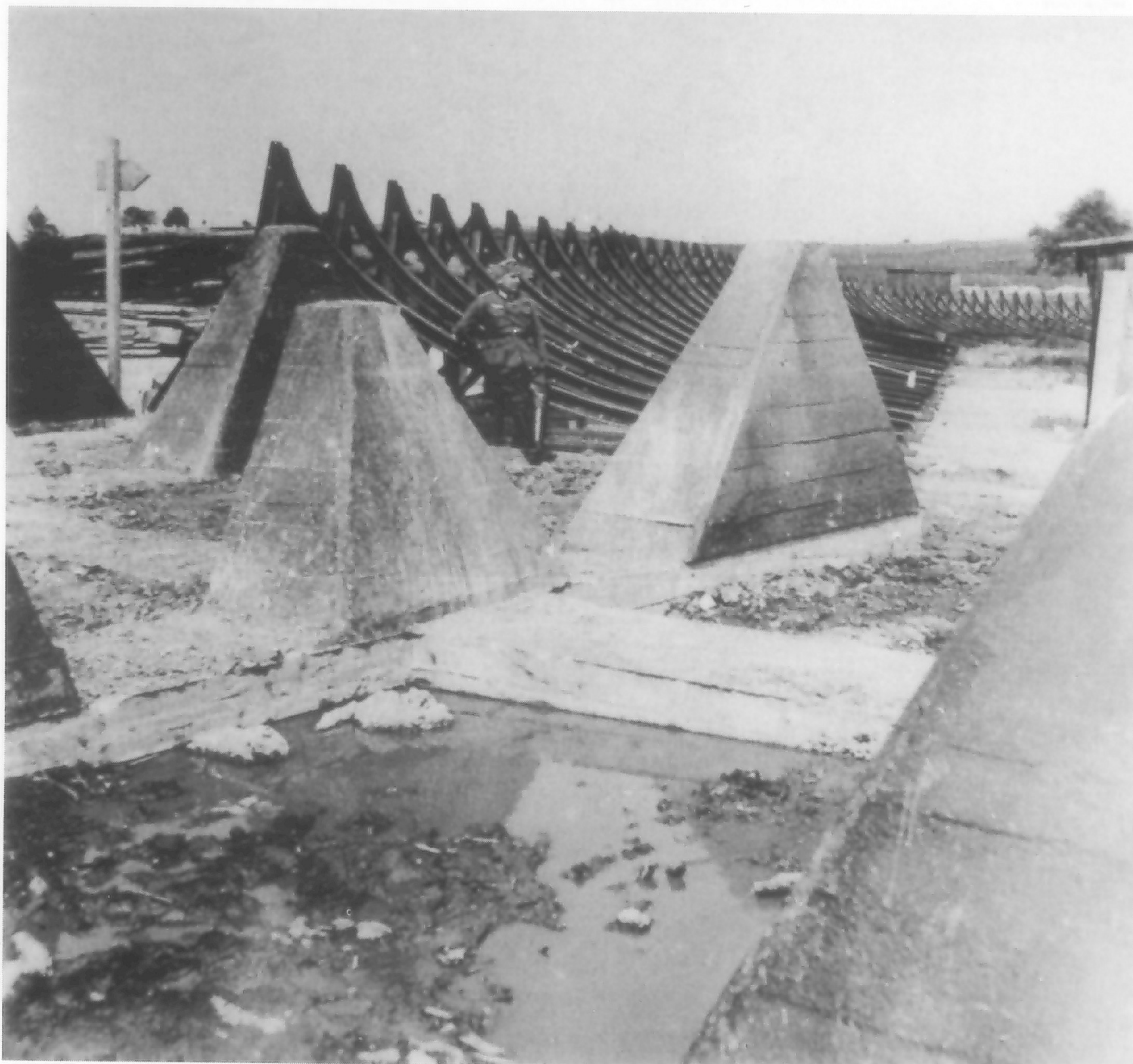
Ein Hemmcurvenfeld besteht aus 4 einzelnen Hemmcurven. Die Breite eines einzelnen Hemmcurvenfeldes betrug 5,70 m und hat einen 1,42 m großen Abstand von Hemmcurve zu Hemmcurve. Die Höhe entsprach etwa 2,30 m. Die Hemmcurven gab es als Stahl- und Betonschwellen.
