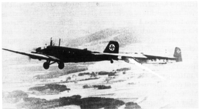
Während der Erprobung bei der Deutschen Forschungsanstalt für Segelflug (DFS) in Ainring bei Salzburg entstand dieses Bild einer Ju 52/3m, die einen DFS 230-Lastensegler (CB+ZB) im Starrschlepp mitführt.
