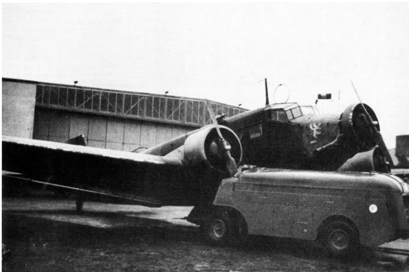
Zum Betanken der Ju 52/3 m auf dem Flugfeld wurden vielfach Flugbetriebsstoff-Kesselwagen (Ah. 454) verwandt.
