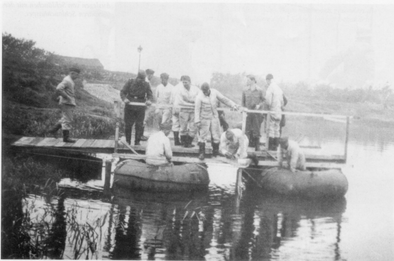
Um eine bessere Wasserversorgung zu gewährleisten, werden in kleinen Gewässern Schlauchbootfähren gebaut und darauf Pumpen zur Wasserförderung montiert.
