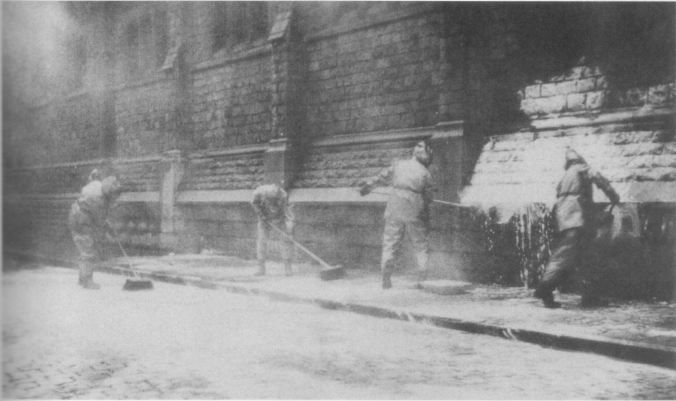
Entgiftung einer mit Kampfstoff verseuchten Häuserwand.
