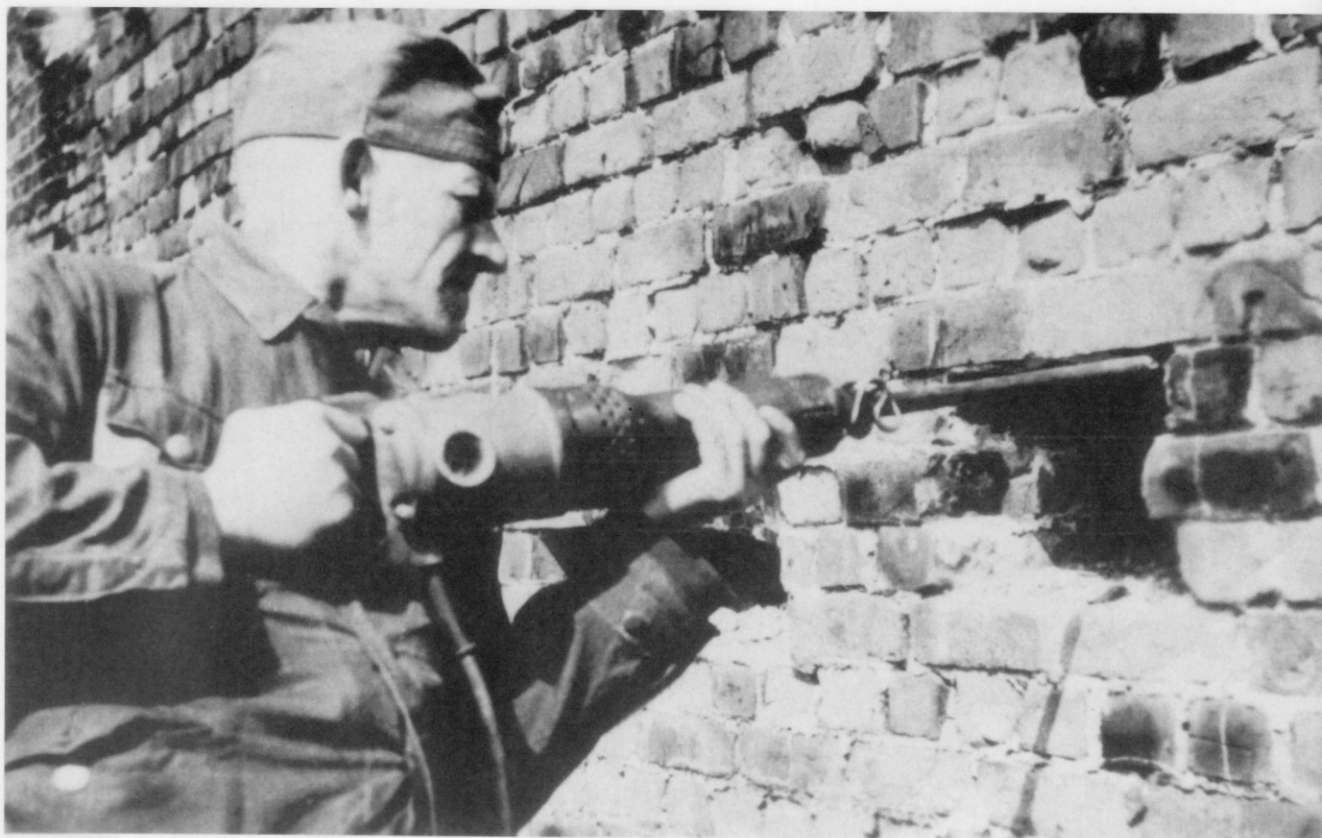
Der Bohr- und Aufbruchhammer im Einsatz. Der Soldat bereitet einen Mauerdurchbruch vor.
