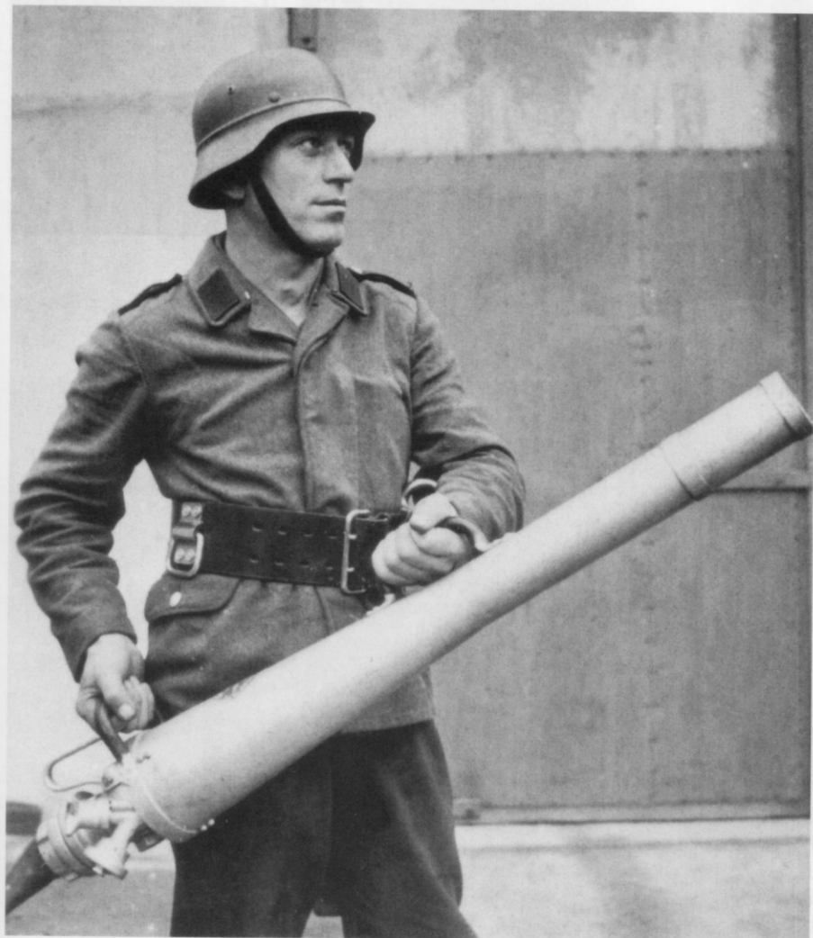
Ein Soldat einer Luftschutz-Abteilung demonstriert die Handhabung des Schaumrohrs. Die Schaumrohre kamen überwiegend bei den Tank- löschfahrzeugen zum Einsatz.
