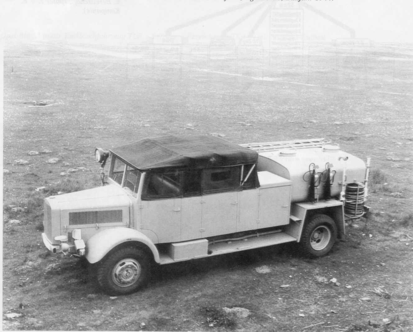
Vereinfachte Ausführung des Mercedes Benz L 4500 als Tanklöschfahrzeug TLF 25, Baujahr 1944.
