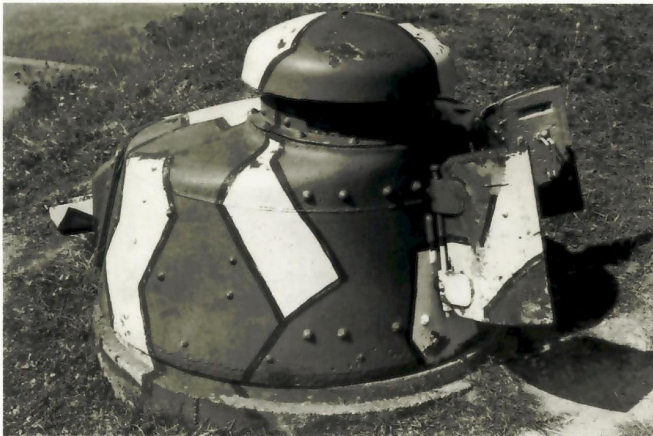
Auch entlang der dänischen Küste wurden erbeutete französische Panzertürme zur Küstenverteidigung eingebaut, wie dieser Renault FT 17 Turm mit 3,7 Kanone.
