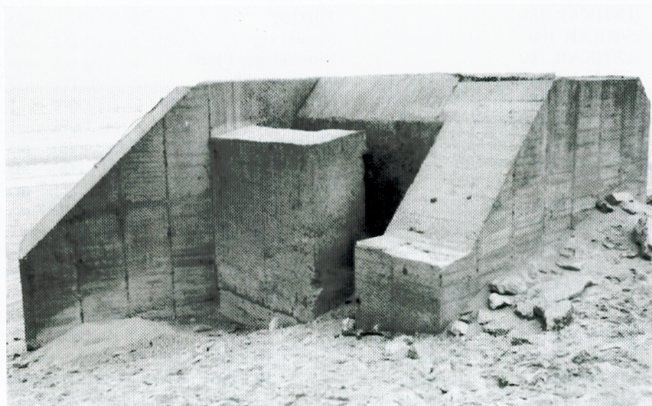
Der Eingang des Pakbunkers wurde durch eine Betonmauer abgedeckt.
