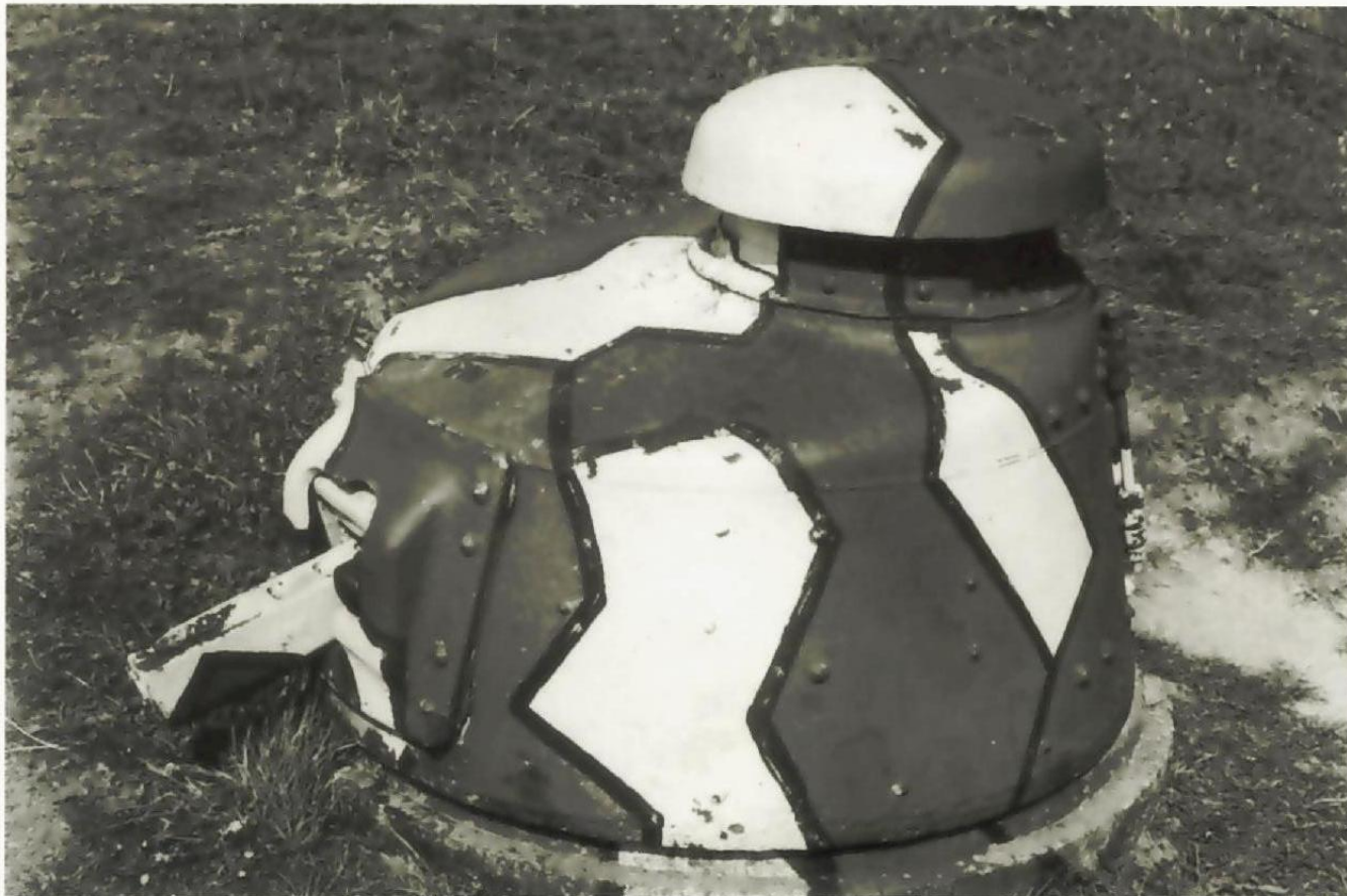
Auch entlang der dänischen Küste wurden erbeutete französische Panzertürme zur Küstenverteidigung eingebaut, wie dieser Renault FT 17 Turm mit 3,7 Kanone.
