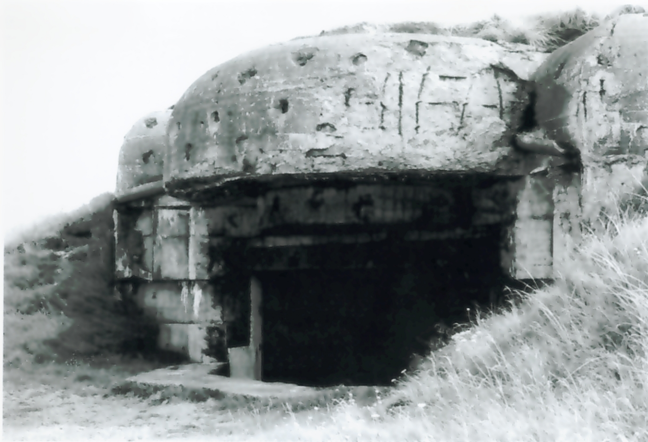
Bis 1943 standen die 17 cm SK L/40 Geschütze der Batterie Hansted I (MAA 1/118) in offenen Ringbettungen, danach baute man Scharnsteine vom Typ M270 für die Kanonen.
