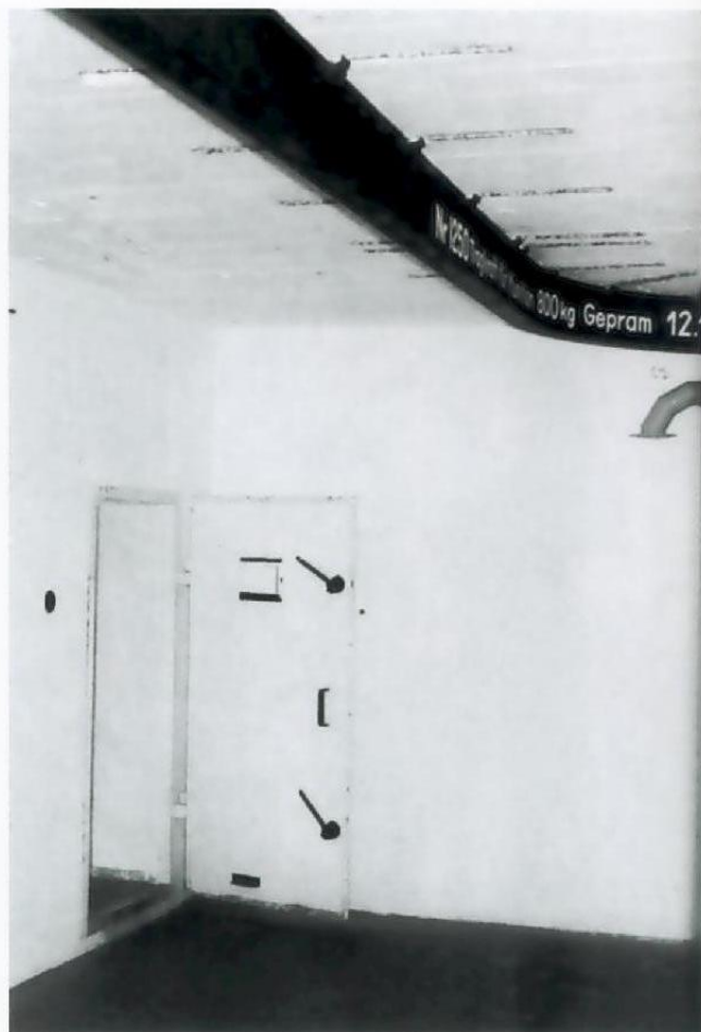
Die Granate und Kartuschen wurden durch eine Hängeförderungsanlage zur Munitionsschleuse befördert.
