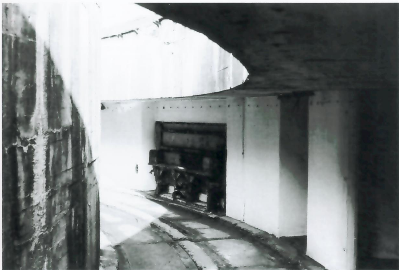
Ansicht des Ladegangs mit der Munitionsschleuse.
