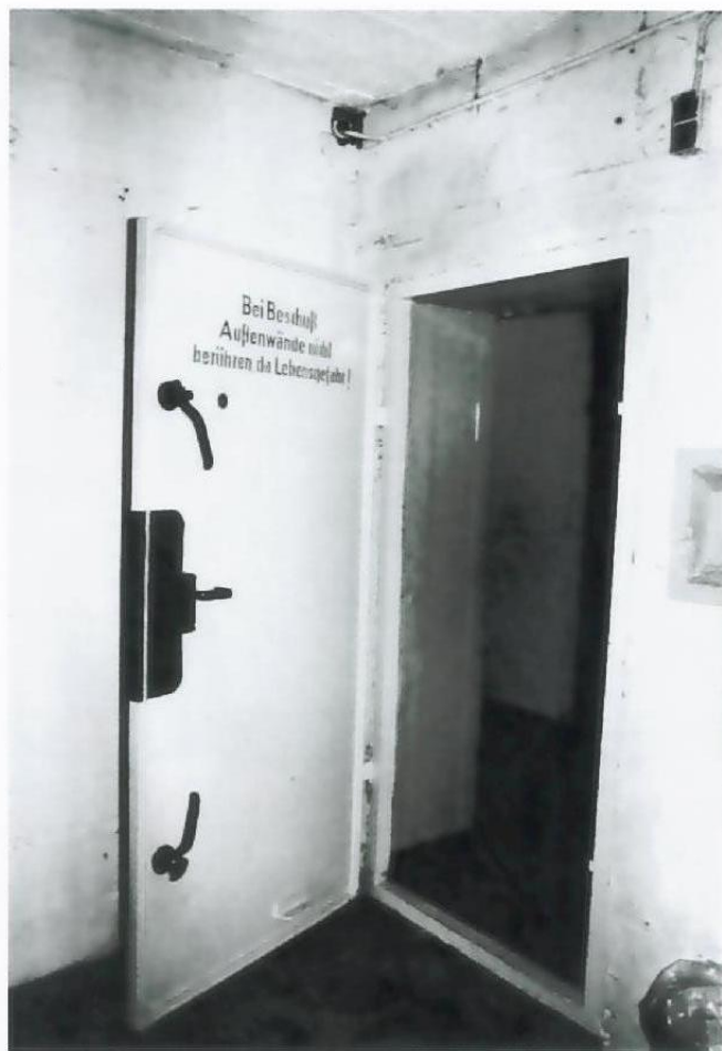
An der Südseite der Geschützstellungen schlossen sich Maschinenräume, Unterkünfte und Wachräume an. Dieser Teil des Bunkers war gasdicht ausgelegt. Das Foto zeigt eine Tür zum Maschinenraum.
