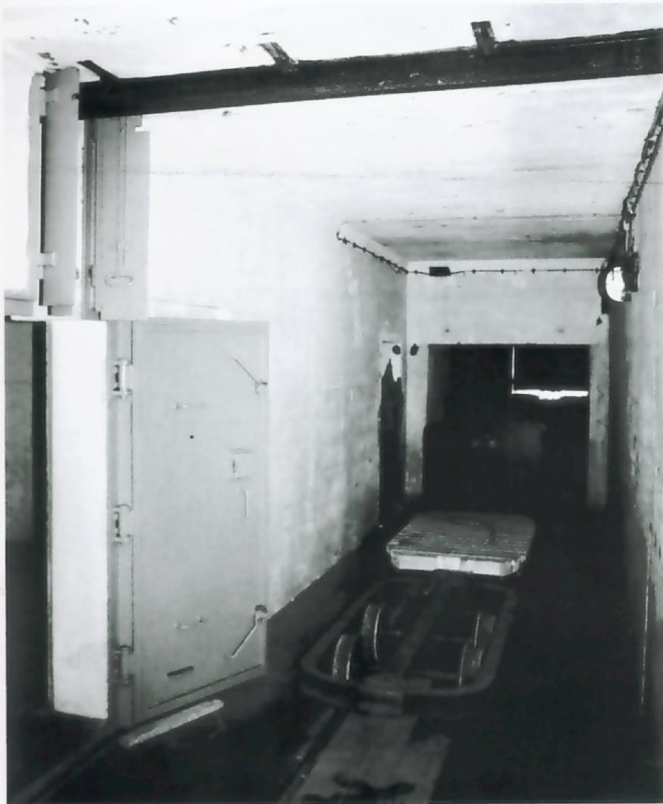
Eine Umladestation für Grana- ten und Kartuschen im Zufahrts- tunnel.
