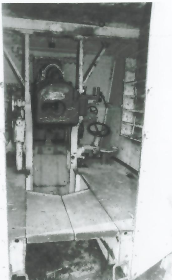
Blick in den Geschützturm. Auf der rechten Seite ist der Sitz des Seitenrichtkanoniers mit dem Richtrad zu sehen.
