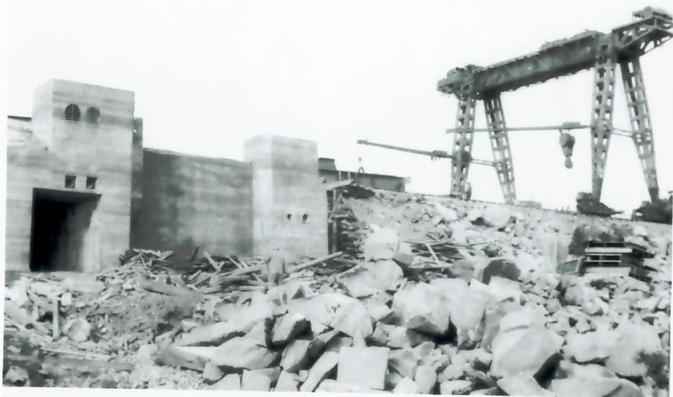
Der Bunker wurde teilweise angeschüttet um die Schienen des Kranes verlegen zu können.
