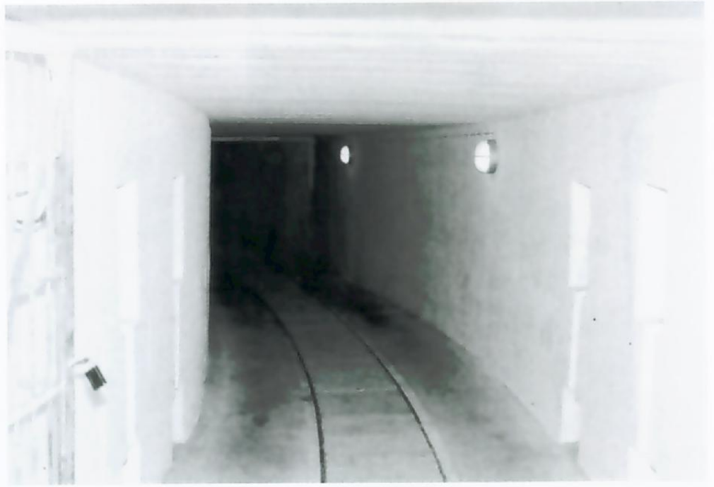
Der Zufahrtstunnel der Versorgungsbahn zu Turm 3.
