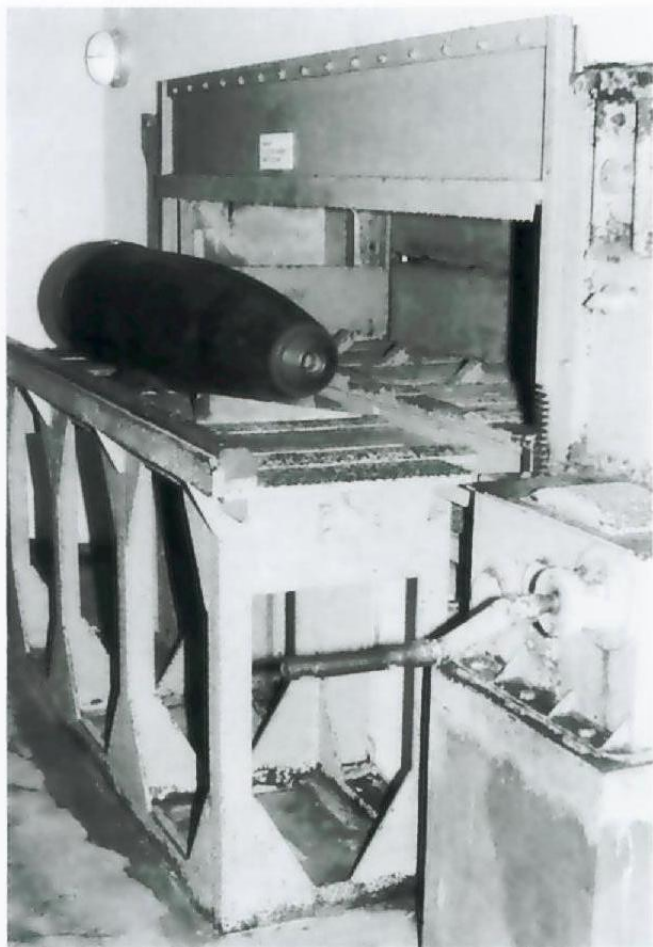
Die Munitionsschleuse zum Ladegang im Vorratsbunker mit einer 38 cm Granate.
