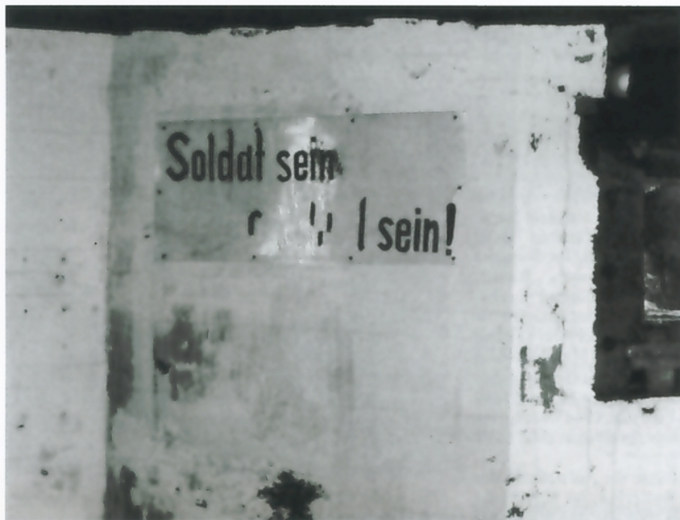
Auch nach über 50 Jahren ist der Bunker noch sehr gut erhalten.
