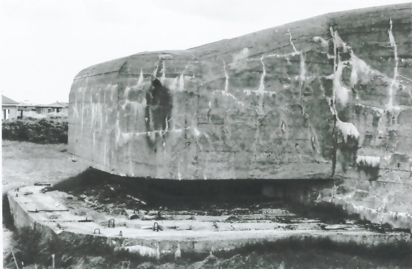
Befehlsstand einer Heeresküstenbatterie, Regelbau 636, auf der Insel Römö.
