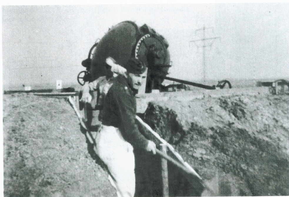
Die Scheinwerfer und Horchgeräte standen in einfachen Stellungen mit Erdanschüttung.
