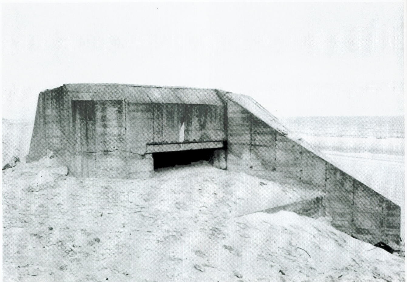
Flankierender Pakbunker am Strand von Esbjerg.
