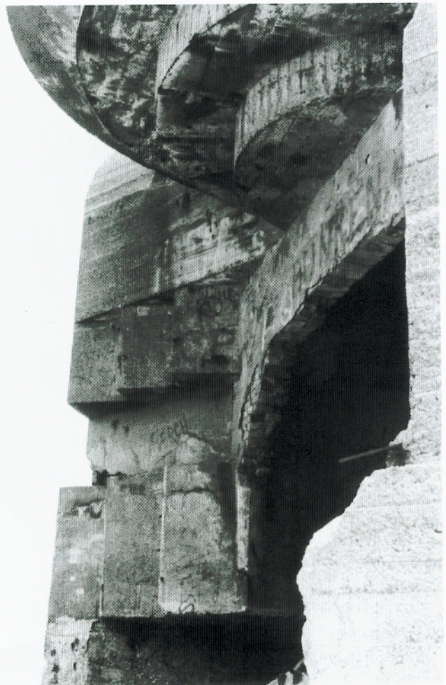
Scharte eines Regelbaus M272 der Batt. Lökken.
