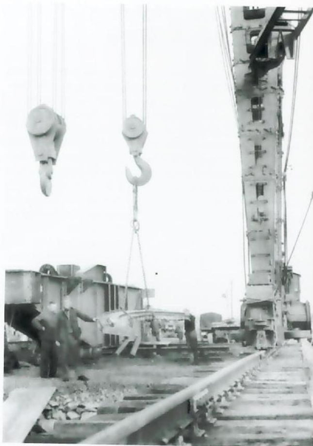
Der Portalcrane auf dem Geschützbunker mit Teilen des Geschützturmes.
