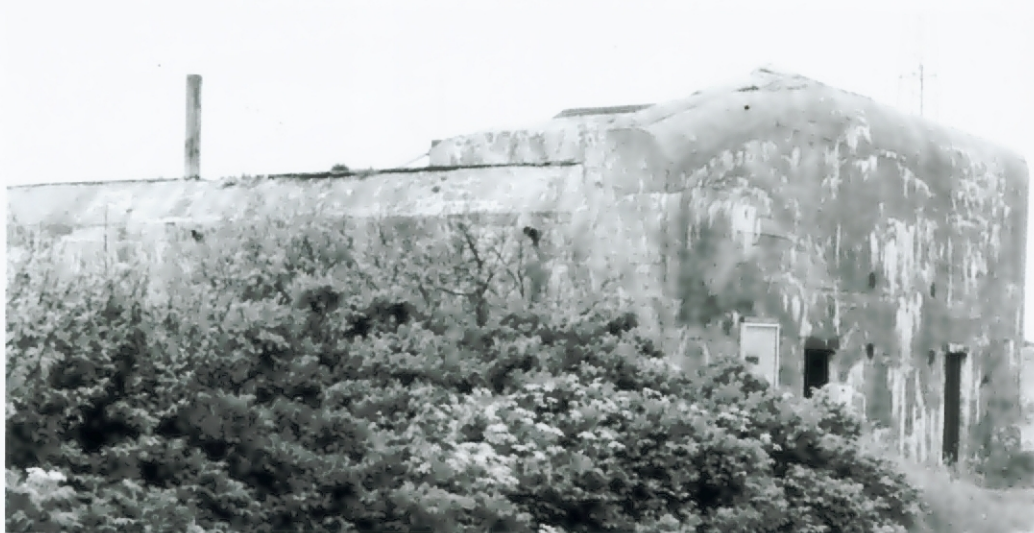
Regelbau L409A für eine 2 cm Flak.
