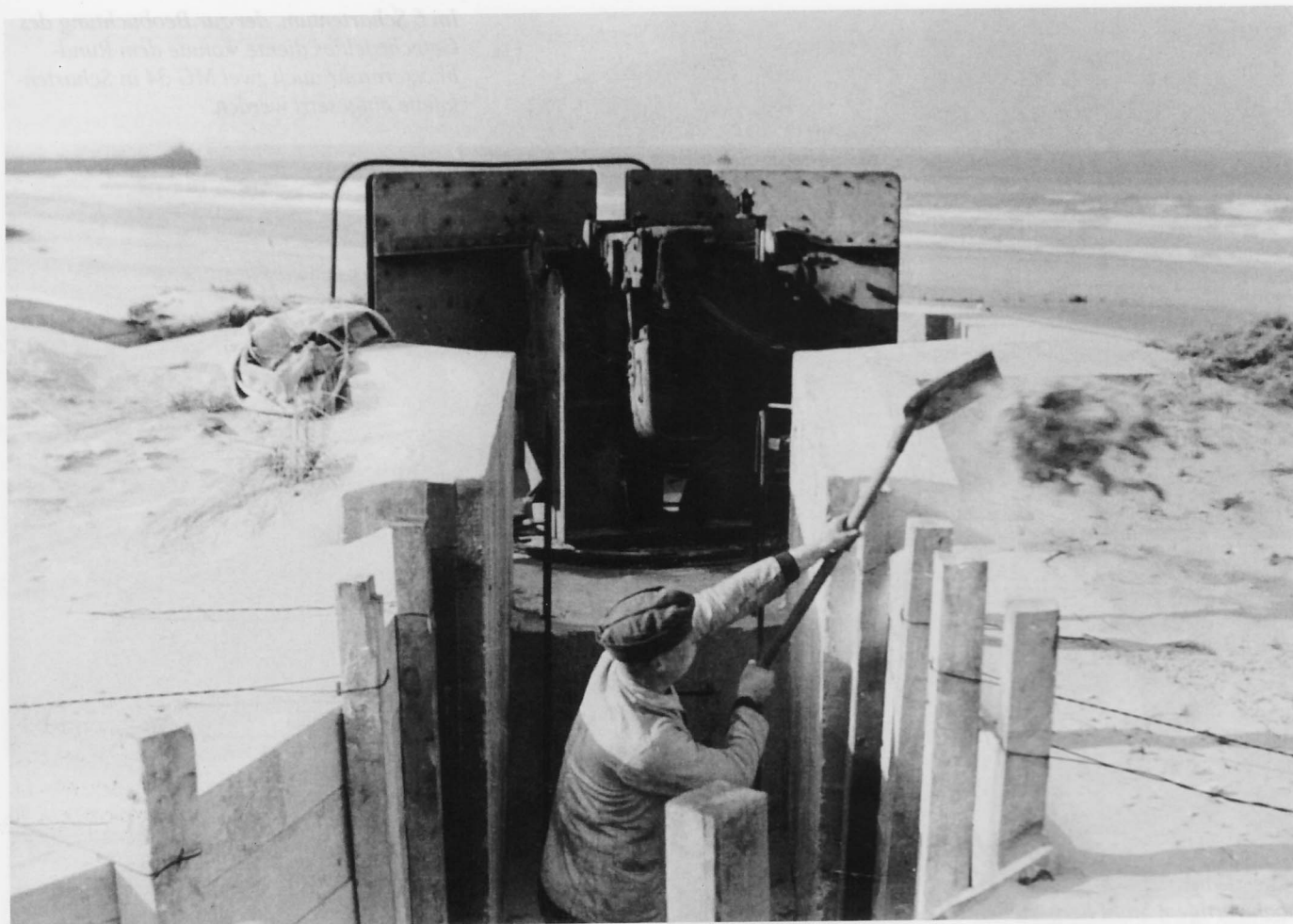
Zur direkten Panzerabwehr wurden auch entlang der belgischen Küste eine Reihe von 5cm KWK 39 eingebaut. Diese 5 cm Kanone im Regelbau 600 sicherte den Vorstrand bei Westende.
