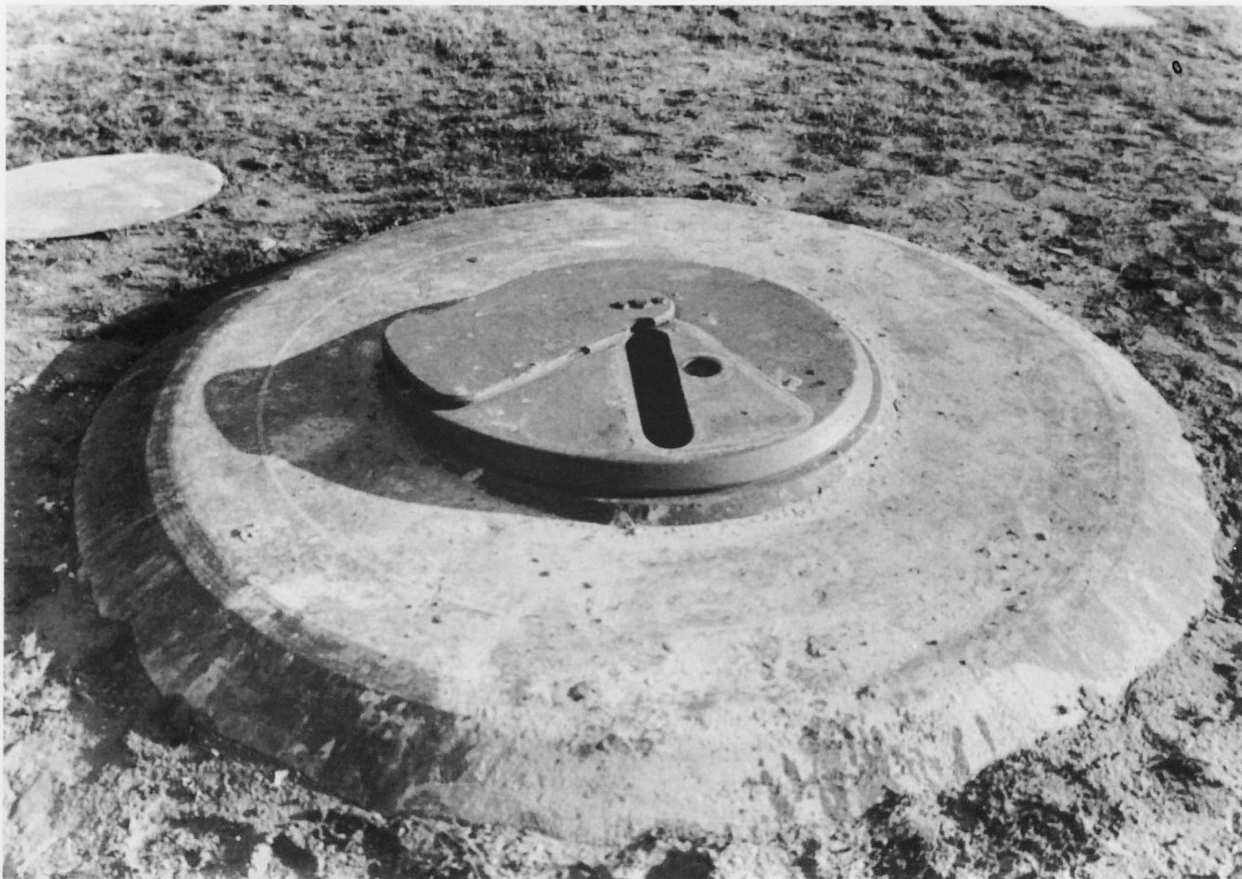
Zum direkten Strandbeschuß diente dieser M19 Maschinengranatwerfer im Panzerturm in einer Stellung bei Zeebrügge.
