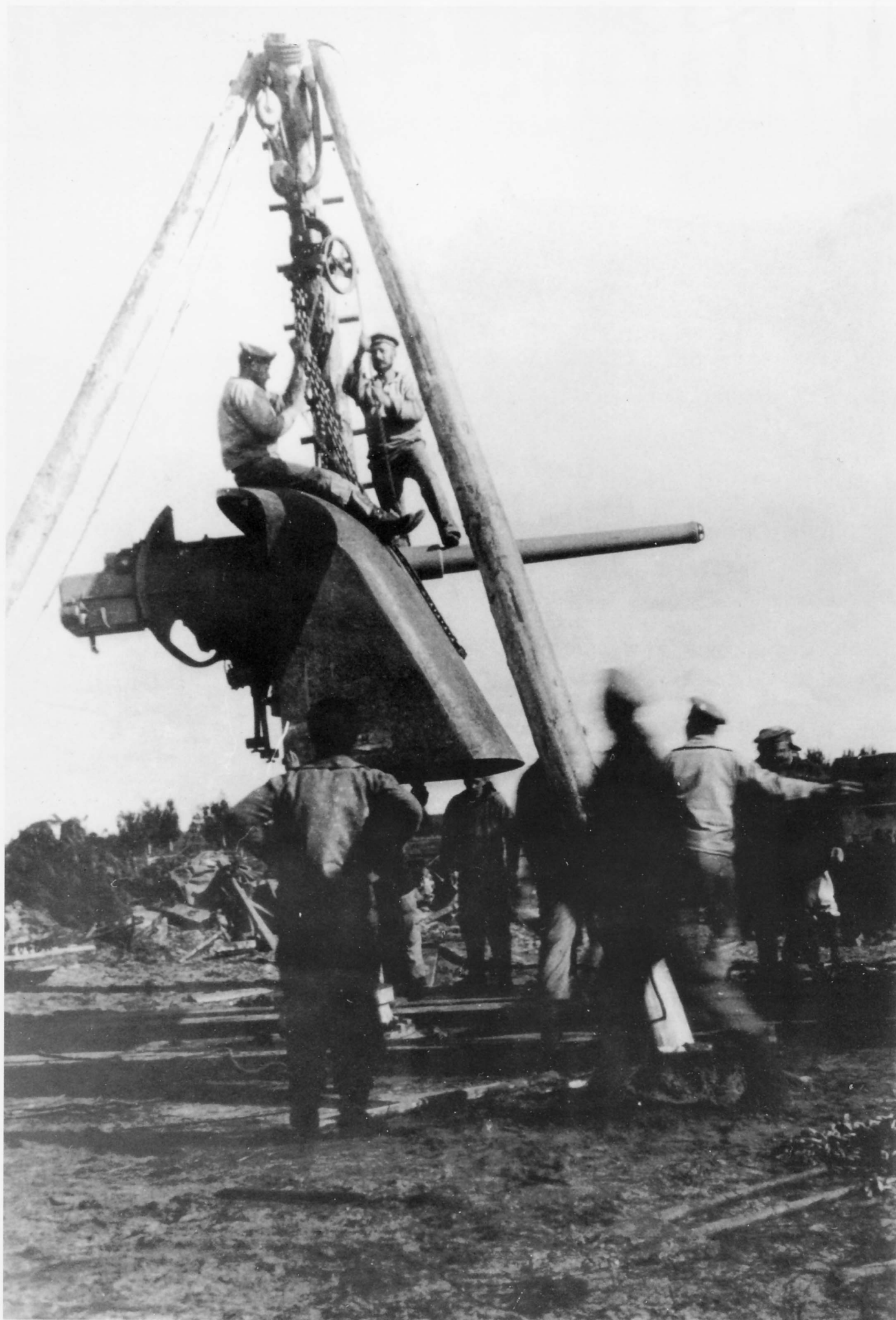
Montage einer 8,8 cm Flak L/45 in der M.P.L. C/13 bei De Haan.
