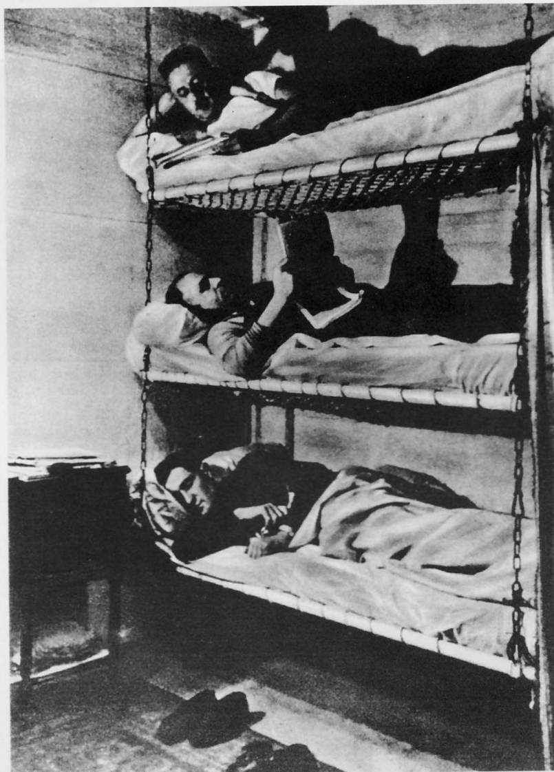
Ein Teil der Batteriebesetzung konnte in Bombensicheren Bunkern, sogenannten Gruppenunterständen für 10 Mann, Regelbau 621 und Doppelgruppenunterständen für 20 Mann, Regelbau 622 untergebracht werden.
