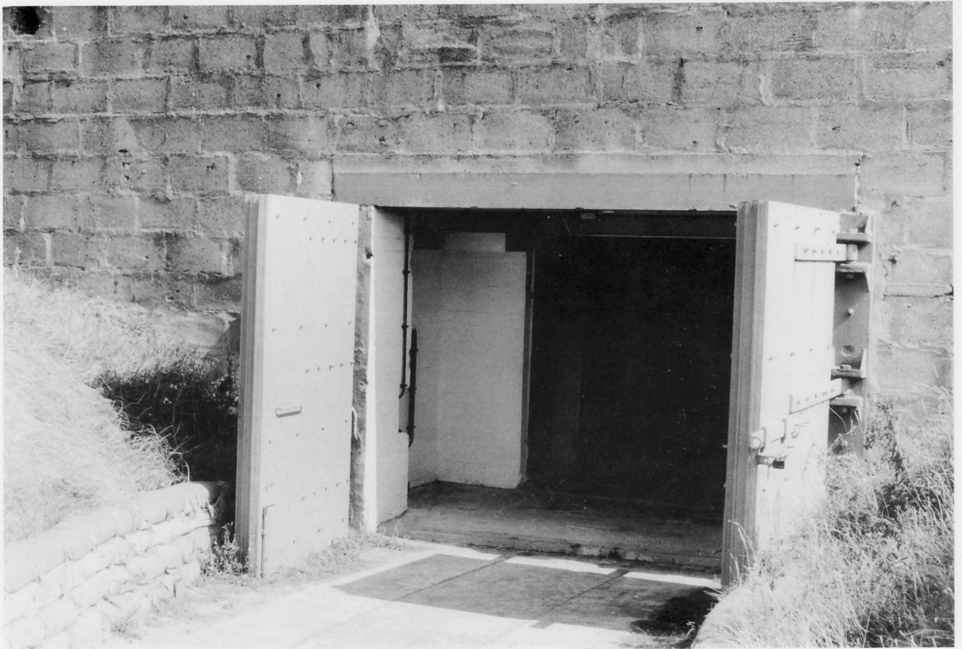
Die gepanzerten Eingangstüren an der Rückseite des Bunkers. Die Geschützcharte konnte ebenfalls mit Eisen- oder Holztüren verschlossen werden.
