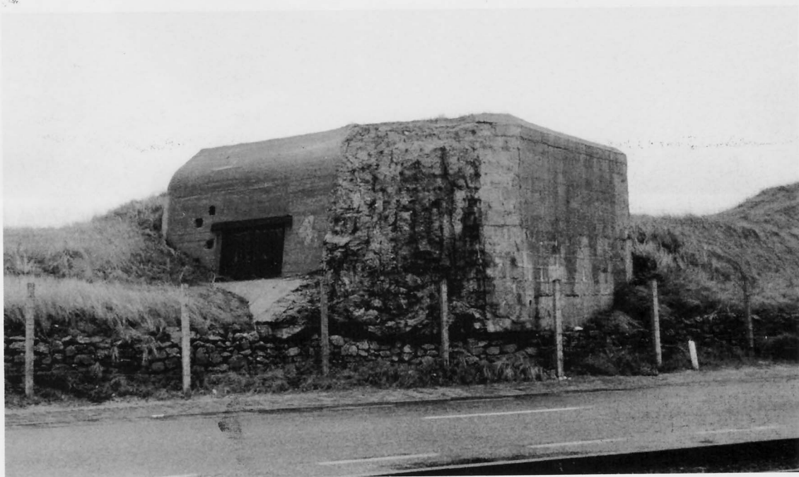
Regelbau 671 für die 10,5 cm SK L/40, die Geschützscharte wurde nach dem Krieg zugemauert. Im Zuge des Museumsbaus entfernte man diese und brachte den Bunker bis auf das noch fehlende Geschütz wieder in seinen Originalzustand.
