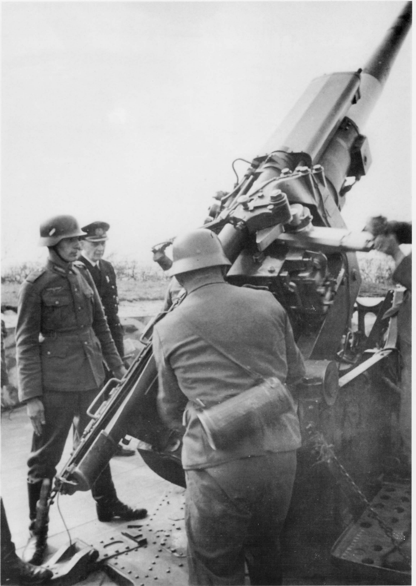
Übungsschießen mit der 9,4 cm Vickers Mk. 6 in der Batt. Malo Terminus. Vor der Ladekanonier auf der linken Gschützseite ist die abgeklappte Ladeschale zu erkennen. Verschossen wurden Spreng- und Panzerbrechende Hülsengranaten mit einem Gewicht von 12,74 Kg mit einer maximalen Reichweite von 19 760 m. (Foto: BA MW 1892/25)
