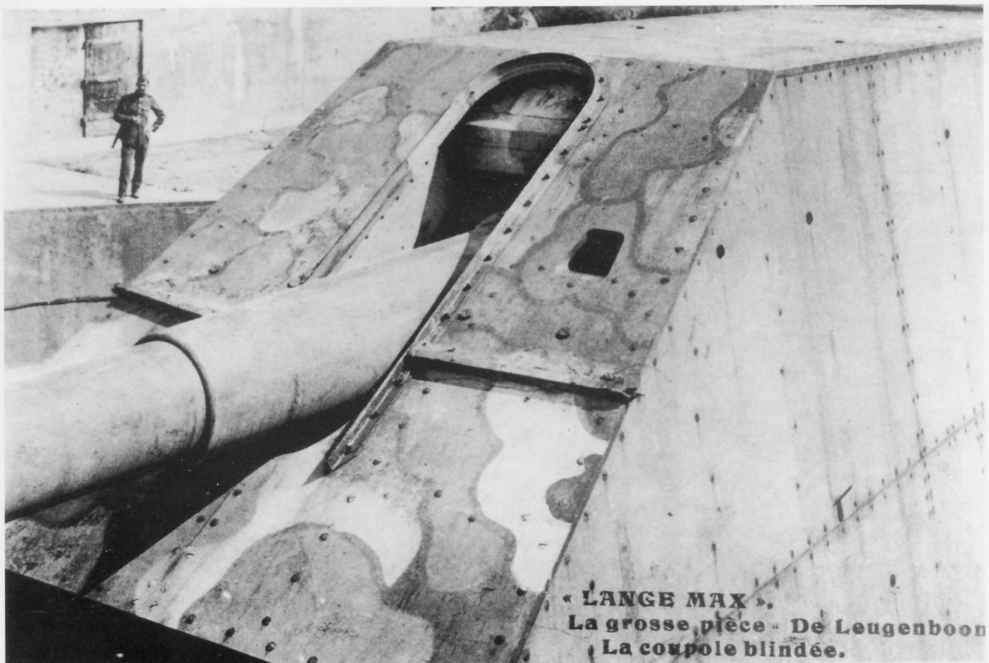
Frontansicht der 38 cm SK L/45 im Geschützturm, der mit 5 cm Stahlplatten verkleidet wurde.
