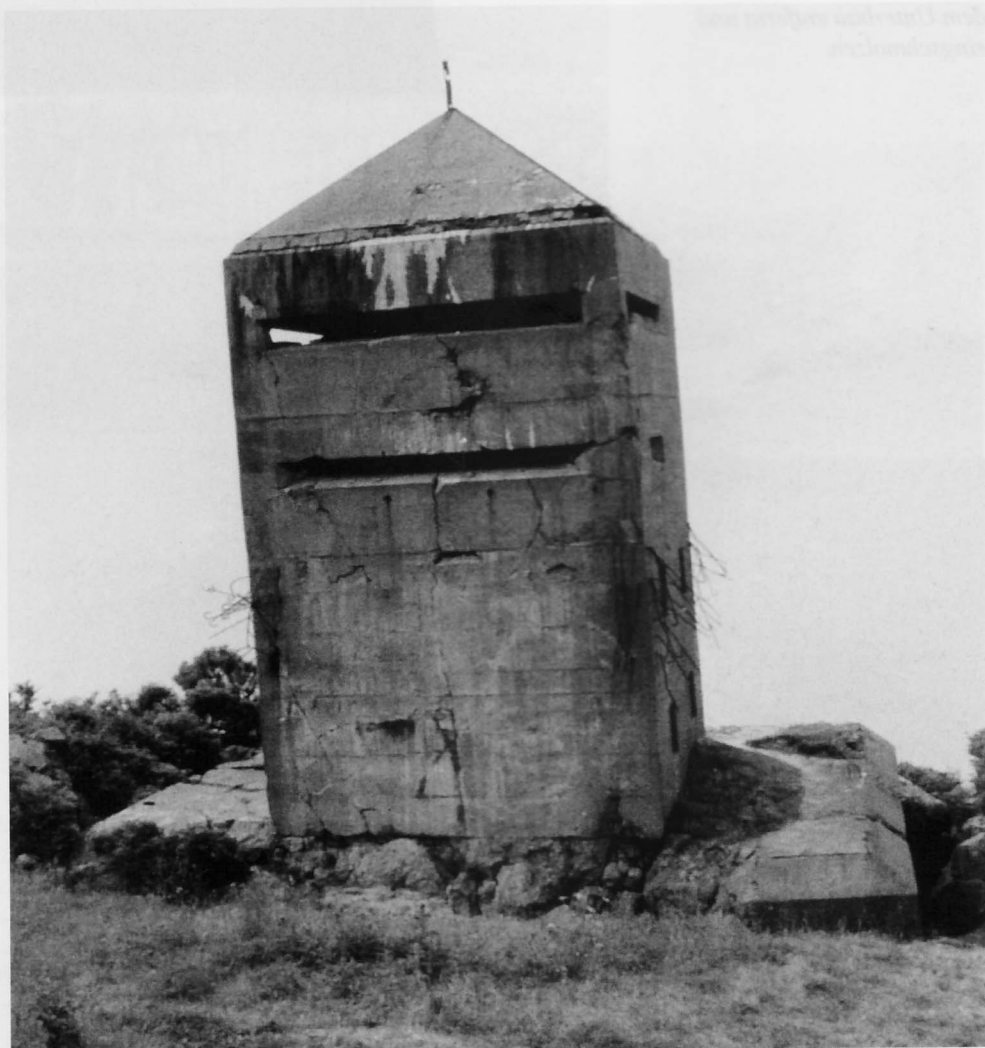
Zur direkten Panzerabwehr wurden auch entlang der belgischen Küste eine Reihe von 5cm KWK 39 eingebaut. Diese 5 cm Kanone im Regelbau 600 sicherte den Vorstrand bei Westende.
