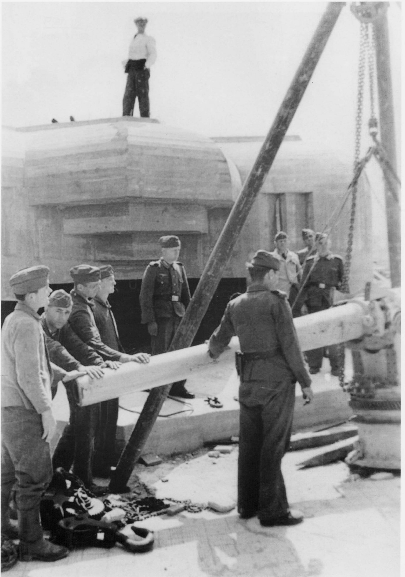
Hier wird das 10,5 cm Rohr mittels eines einfachen Flaschenzuges probetalber auf die Torpedobootslafette gesetzt.
