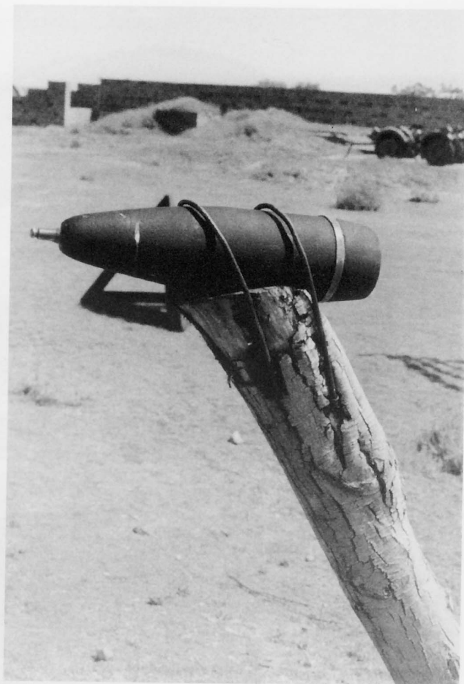
Diese Baumstämme an denen Tellerminen befestigt wurden, dienten zur Abwehr von gegnerischen Landungsbooten und Panzern.
