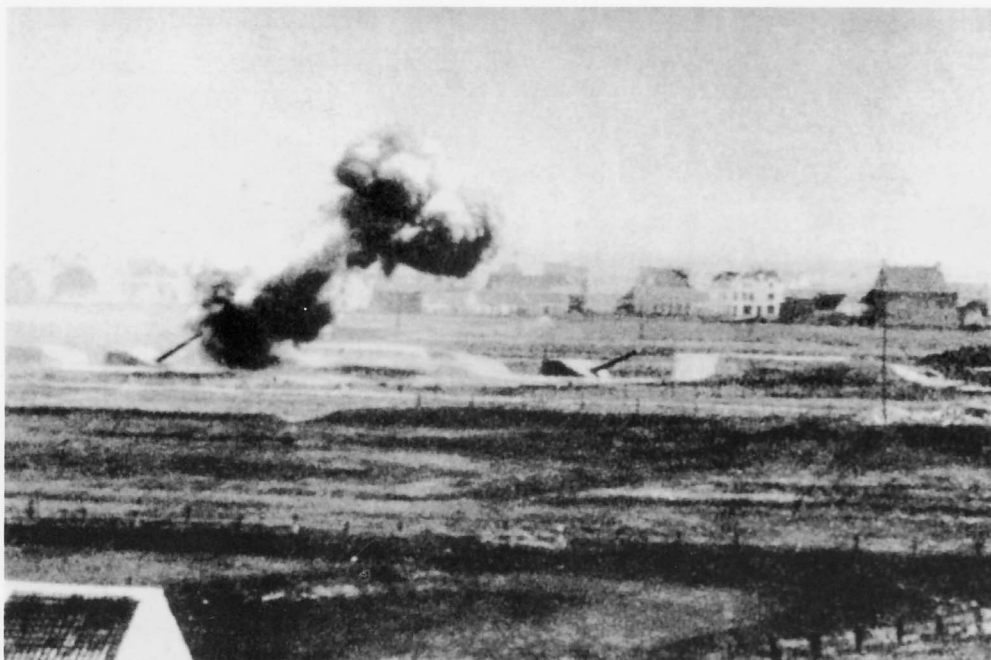
Ein 28 cm SK I/45 Geschütz der Batt. "Tirpitz" eröffnet das Feuer auf englische Monitore vor der Küste. Im Mai 1915 war mit dem Bau dieser Batterie begonnen worden und bereits in September desselben Jahres konnte Feuerbereitschaft gemeldet werden. Die Geschütztürme standen in offen Kesselbettungen die einen Radius von 360° erlaubten. Zur Luftabwehr wurden der Stellung zwei 8,8 cm Kanonen zu geteilt.
