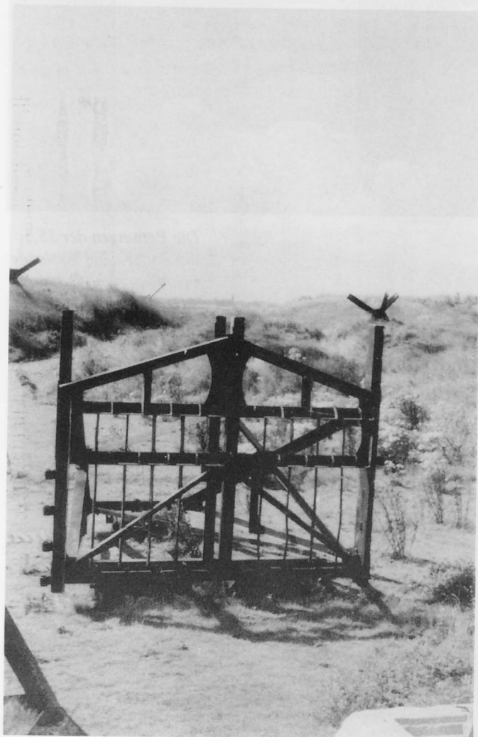
Auch diese Panzerhindernisse, sogenannte Belgische Tore, baute man zur Abwehr der Invasionstruppen an den Stränden. Vor dem 2. Weltkrieg waren sie ein Teil der belgischen Grenzbefestigung entlang zum Deutschen Reich.
