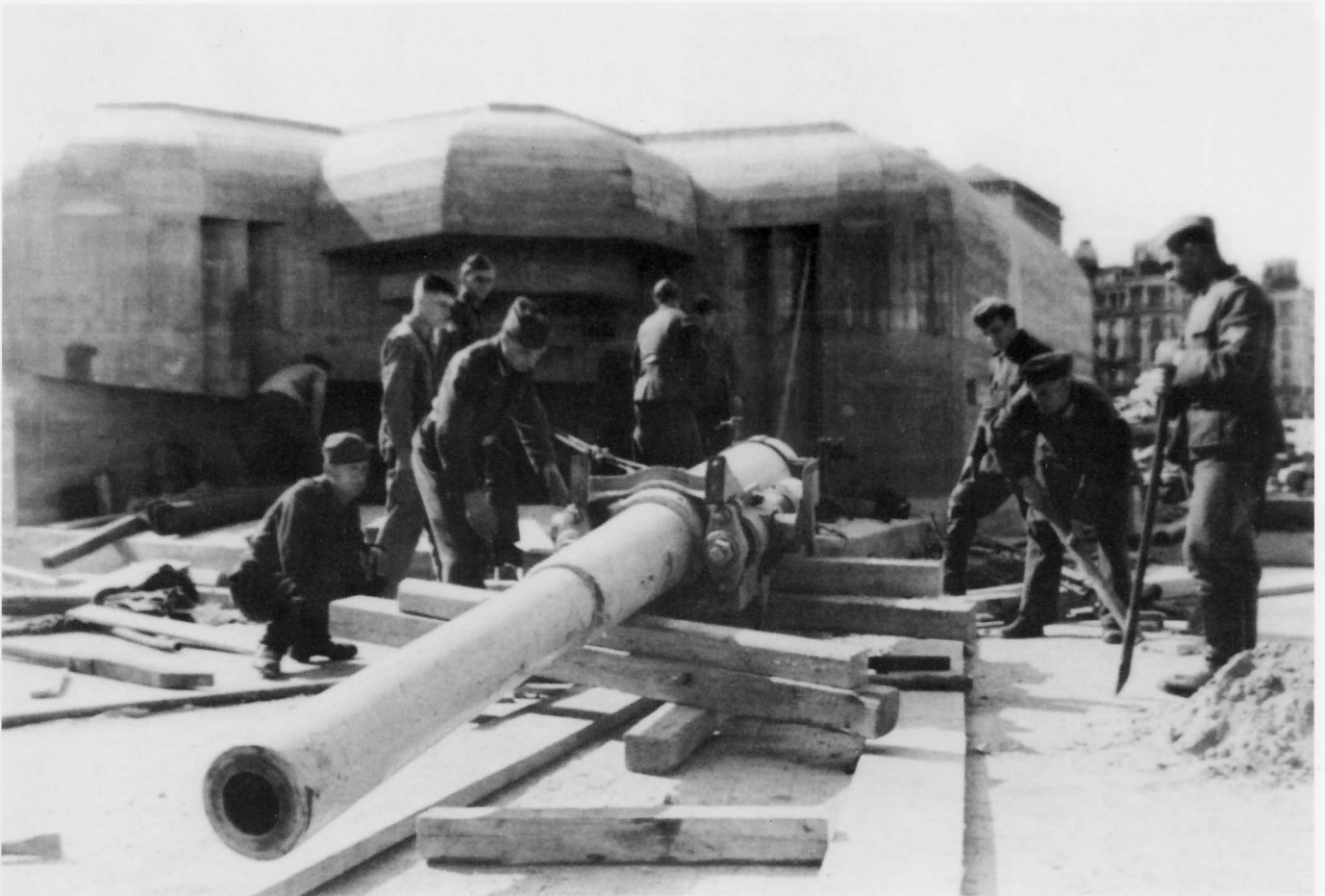
Die Marinebatterie "Kursaal" in Ostende bestand aus vier 10,5 cm SK L/40 Geschützen, die jeweils in einem Regelbau vom Typ 650 untergebracht wurden. Die Scharte des Regelbaus 650 erlaubte ein Seitenrichtfeld von 120^\circ und Höhenrichtfeld von -8^\circ bis +35^\circ . (Foto: BA 294/1531/12).
