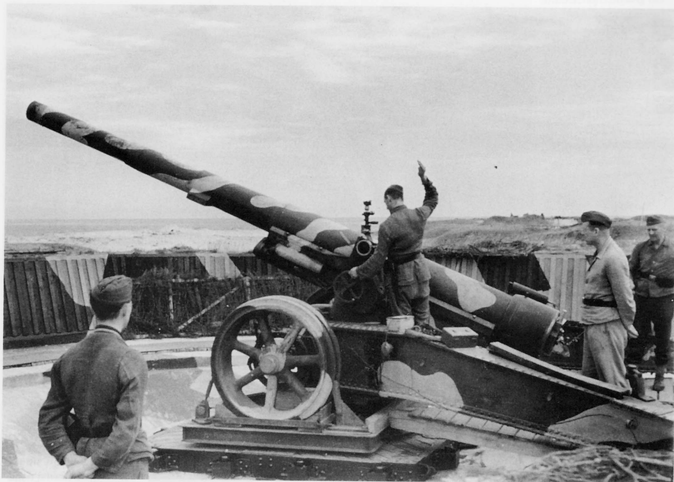
Eine 15,5 cm Feldkanone 418 (f) der HKAA 1240 in der offenen Ringbettung. Im Jahr 1940 übernahm die Wehrmacht 449 Kanonen dieses Typs aus französischen Beständen, von denen ein Großteil in der Küstenverteidigung Verwendung fand.
