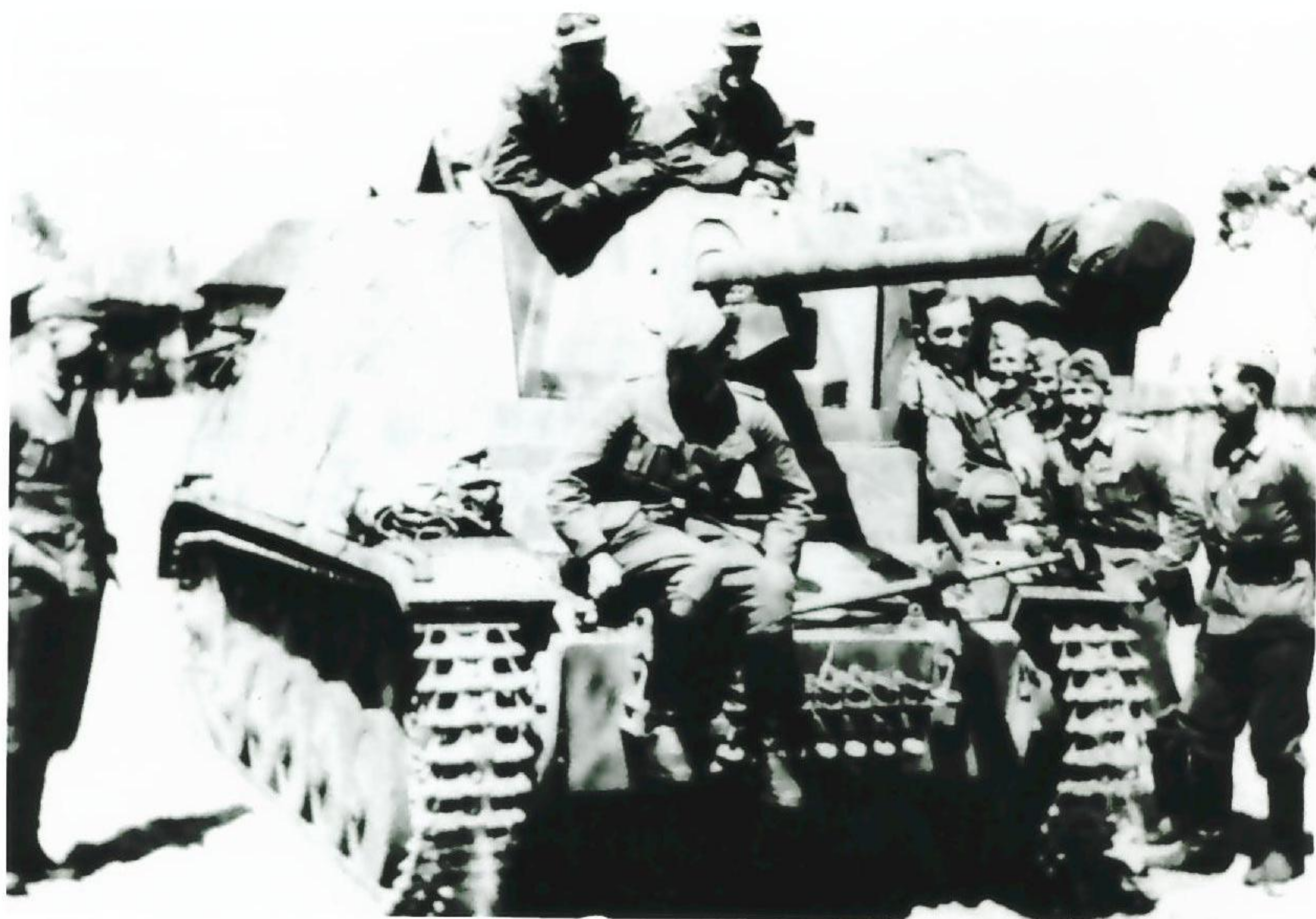
Die Einsatzmöglichkeiten der 7,5-cm-Panzerjägerkanone 40 wurden durch ihren Aufbau auf eine vollgeländegängige Selbstfahrlafette wesentlich verbessert. Allerdings verbot die schwache Panzerung der Fahrzeuge eine angriffsweise Verwendung nach der Art von Sturmgeschützen oder Jagdpanzern.
