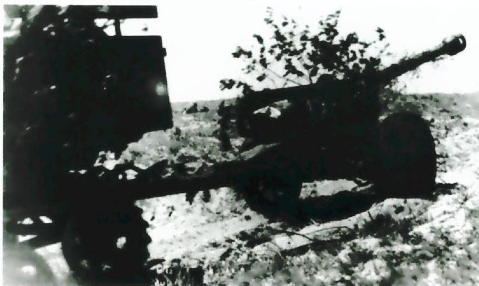
Hier wurde ebenfalls ein Gleiskettenlastkraftwagen 2 t "Maultier" (Sd.Kfz.3) als Zugmittel für die 7,5-cm-Panzerjägerkanone 40 genutzt. Die Aufnahme ist im Sommer 1943 bei der Panzerjägerabteilung 4 (14. Panzerdivision) in Frankreich gemacht worden.
