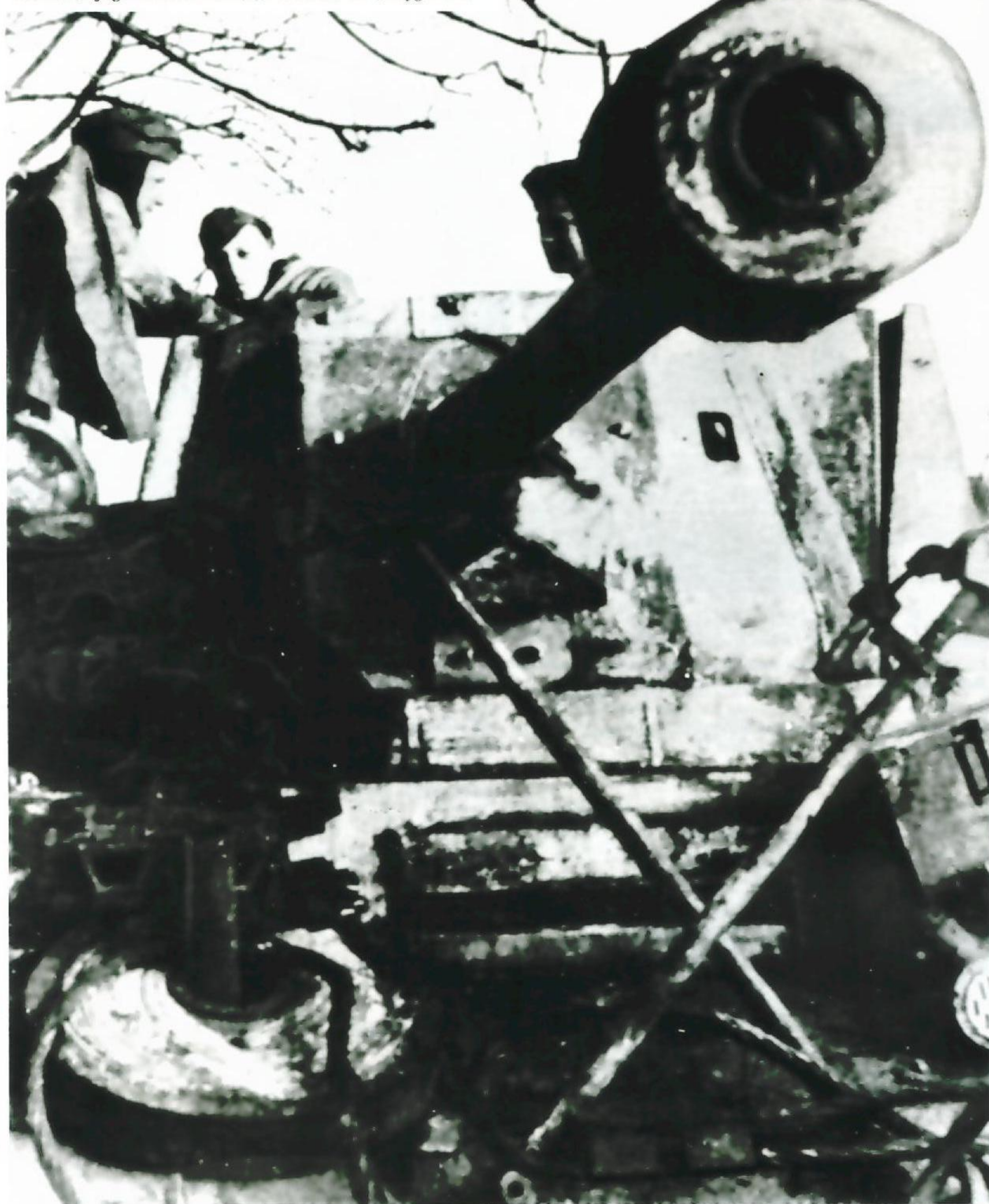
Auf dem Panzerkampfwagen II wurde ab Juni 1942 die 7,5-cm-Panzerjägerkanone 40/2 (7,5-cm-Pak 40/2) aufgebaut.
