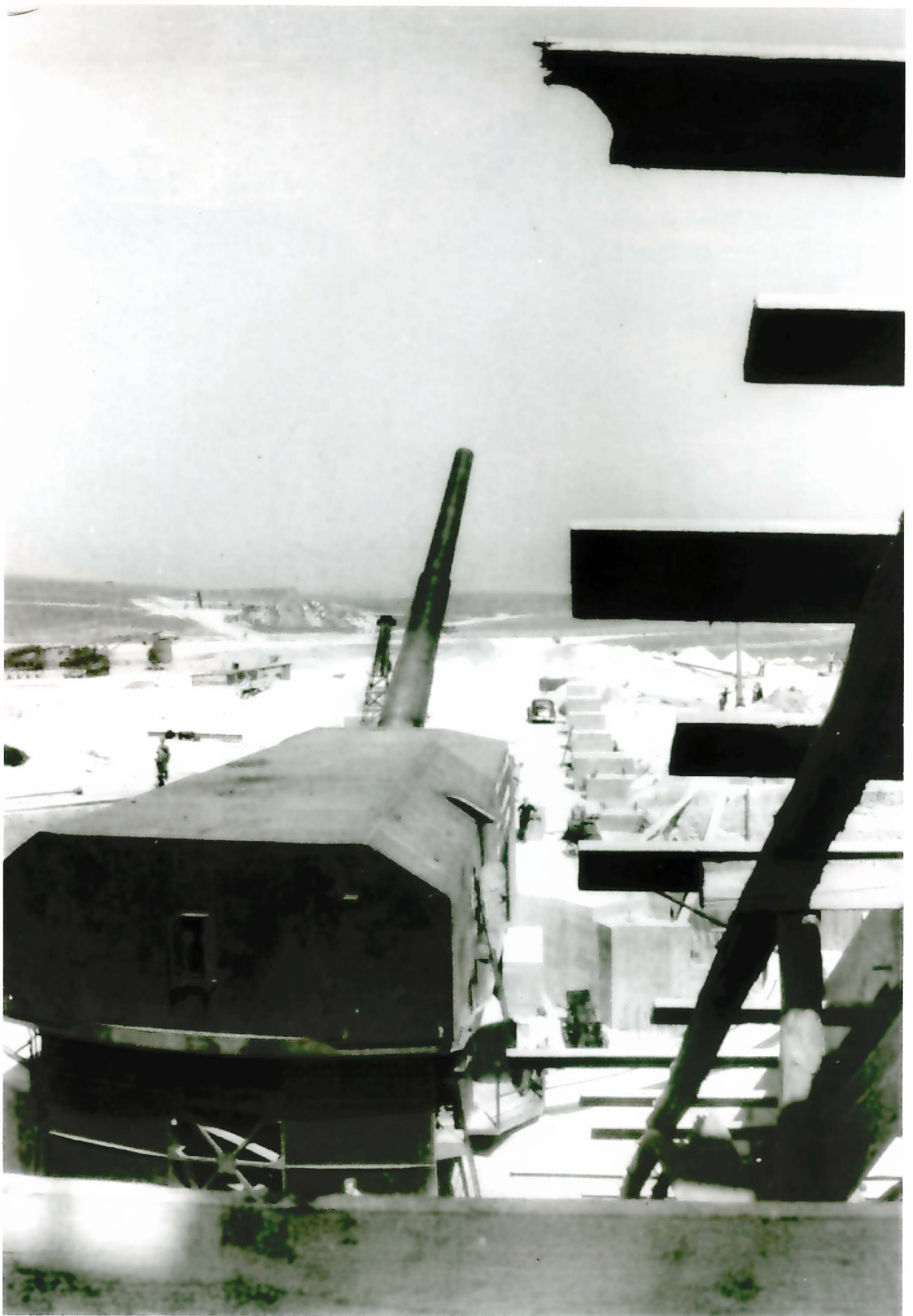
Turm Cäsar nach der Montage in der Kesselbettung. (BA)
