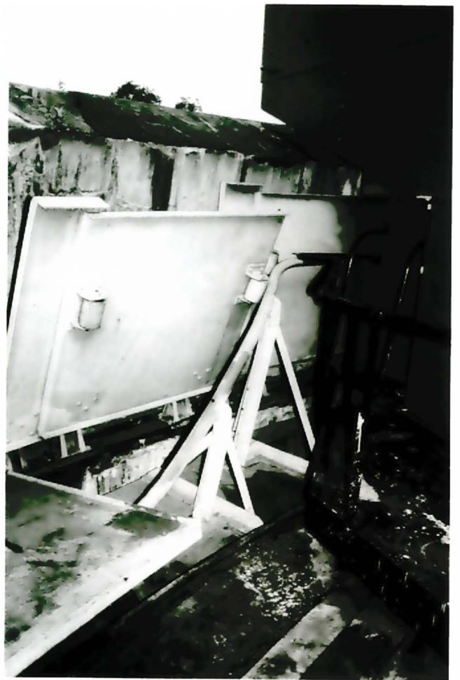
Der Munitionsgang, in dem die Granaten und Kartuschen aus den Vorratsräumen zum Geschützauzug befördert wurden, war mit Stahlplatten abgedeckt. Diese wurden bei Drehung des Turmes durch eine Vorrichtung angehoben und wieder abgesenkt.
