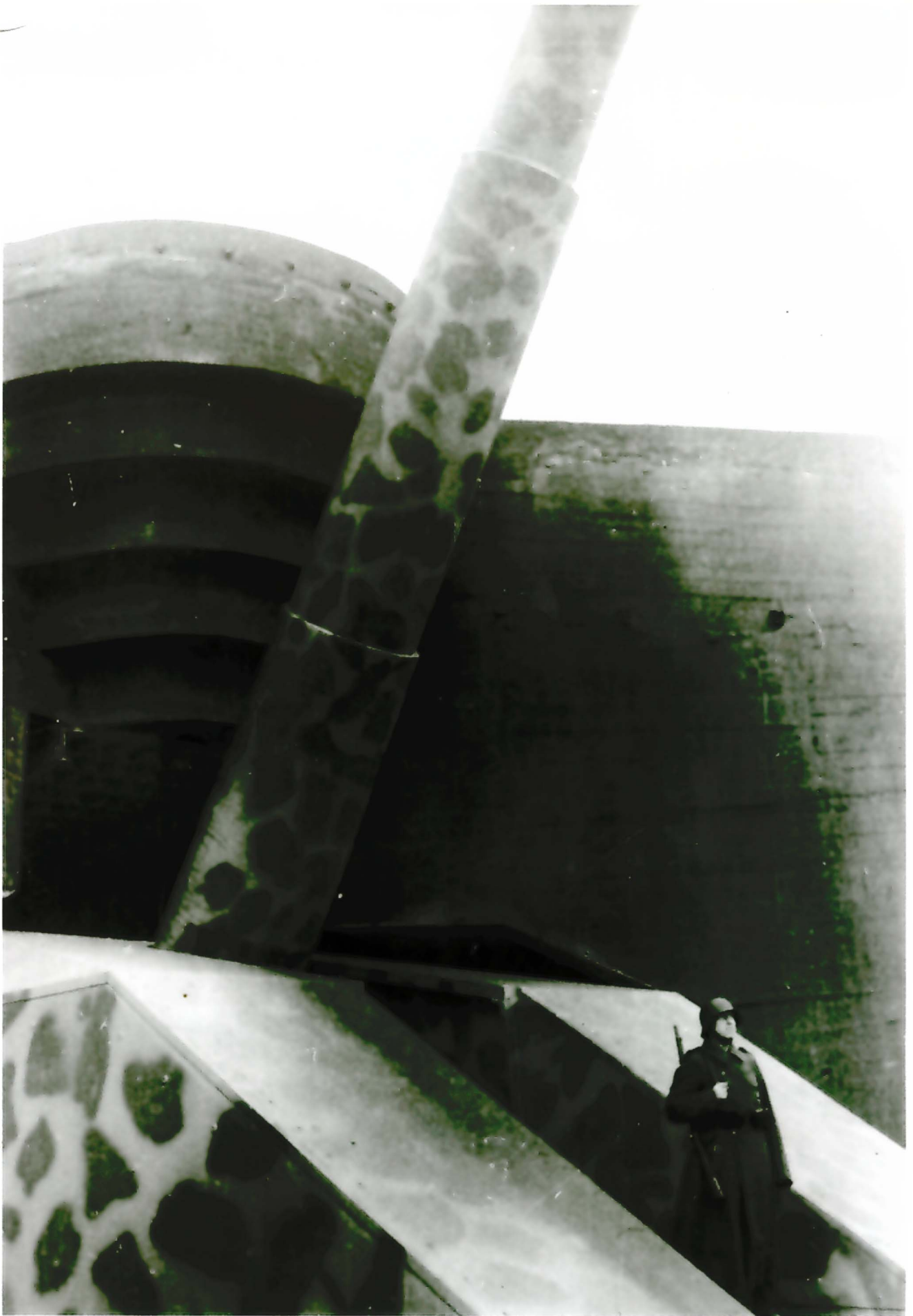
Das Rohr der 40,6 cm Schiffskanone C/34 im Turm Cäsar der Batt. "Lindemann" in höchster Stellung von 52°. (BA)
