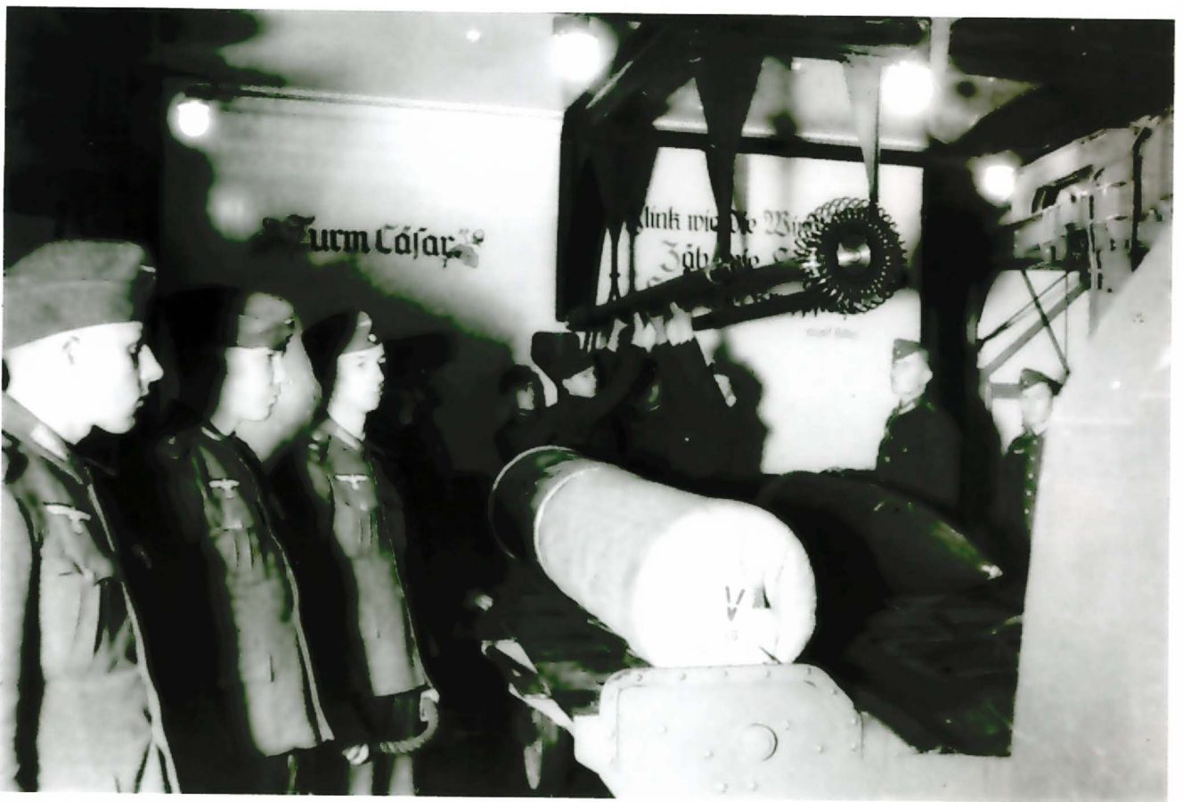
Rohrladen im Turm Cäsar: Vor dem Ladeloch liegt eine 1030 Kg schwere Sprenggranate, und auf dem Ladewagen befinden sich die Vor- und Hauptkartusche. (BA)
