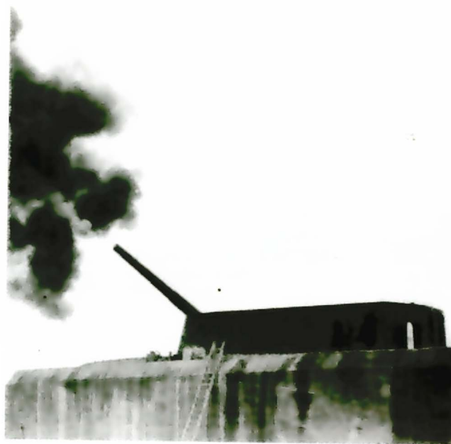
Am 28. Juni 1940 wurde die Batt. "Großer Kurfürst" gefechtsklar gemeldet. Alle vier Geschütze waren mit den Drehscheibenlafetten C/37 Sonderkonstruktionen S 412, in einstöckigen Bunkern eingebaut. Das Foto zeigt einen Turm der Batterie während des Feuerns auf feindliche Schiffe im Kanal. (BA)
