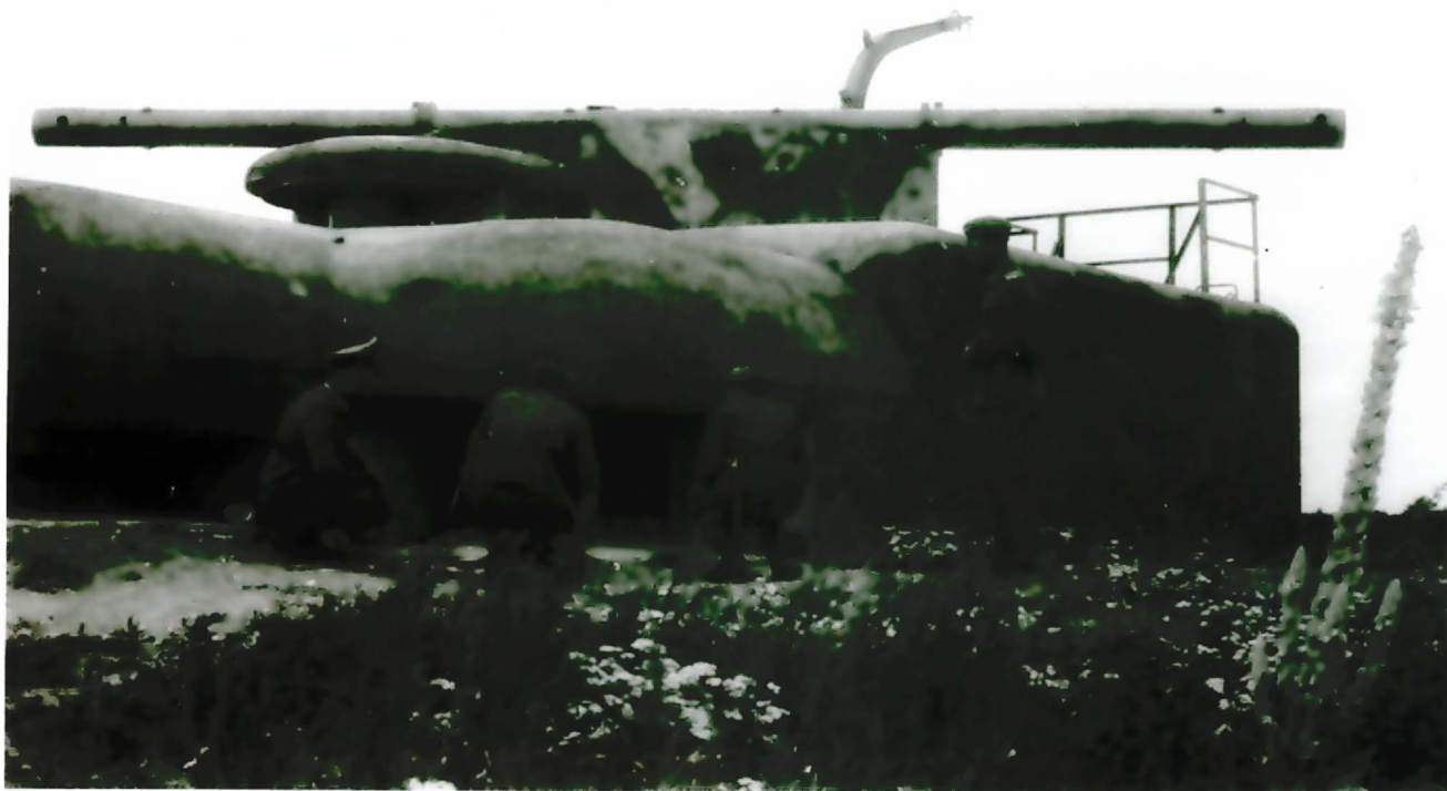
Der Hauptleitstand der Batt. "Crèche", mit dem 6 m E-Meßbalken. Vor dem E-Meßgerät ist das Schutzdach des Perikops zu sehen, mit dem das Gefechtsfeld beobachtet werden konnte.
