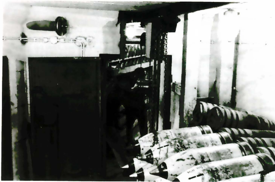
Zur Munitionsversorgung wurden im Batteriebereich zwei Reservebunker angelegt, die im Gegensatz zu den Geschütztürmen von kanadischen Pionieren nach Einnahme der Batterie nicht gesprengt wurden. Das Bild zeigt die Lagerung von Panzergranaten und Kartuschen in einem der Reservebunker. (AC)
