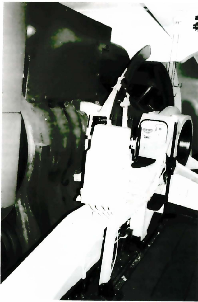
Die Rohrwiege der 38 cm SK C/34 mit dem Metererhöhungsbogen.
