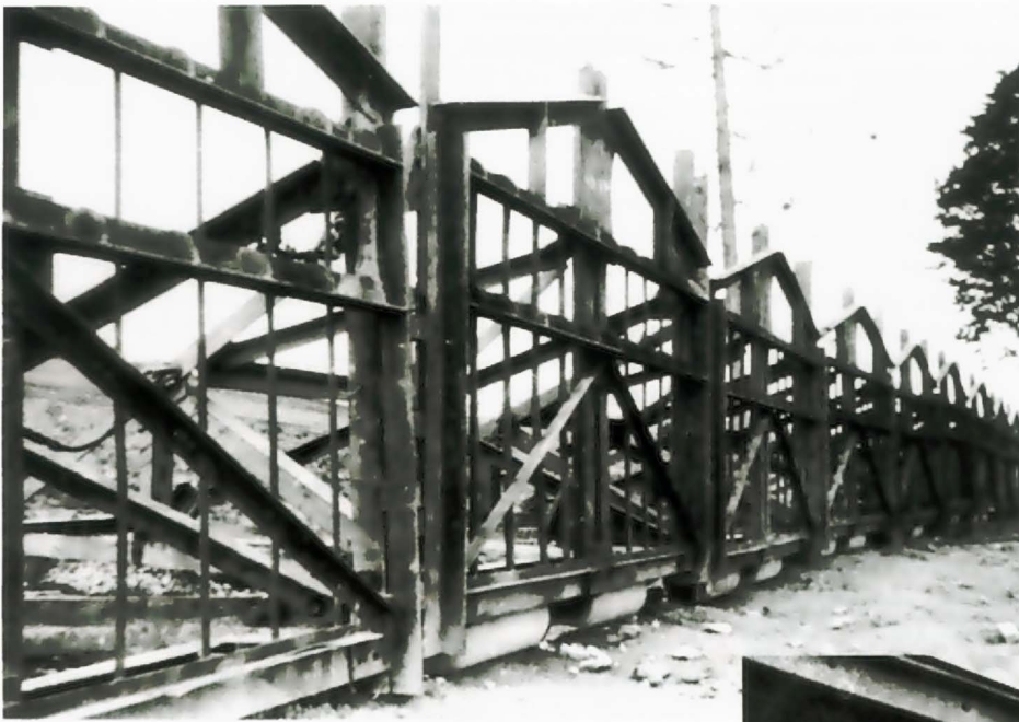
Vorstrandhindernisse aus sogenannten "Belgischen Toren". Diese 2,50 m hohen und 1400 Kg schweren Eisenkonstruktionen sollten gegnerische Fahrzeuge bis zu 20 t Gewicht aufhalten.
