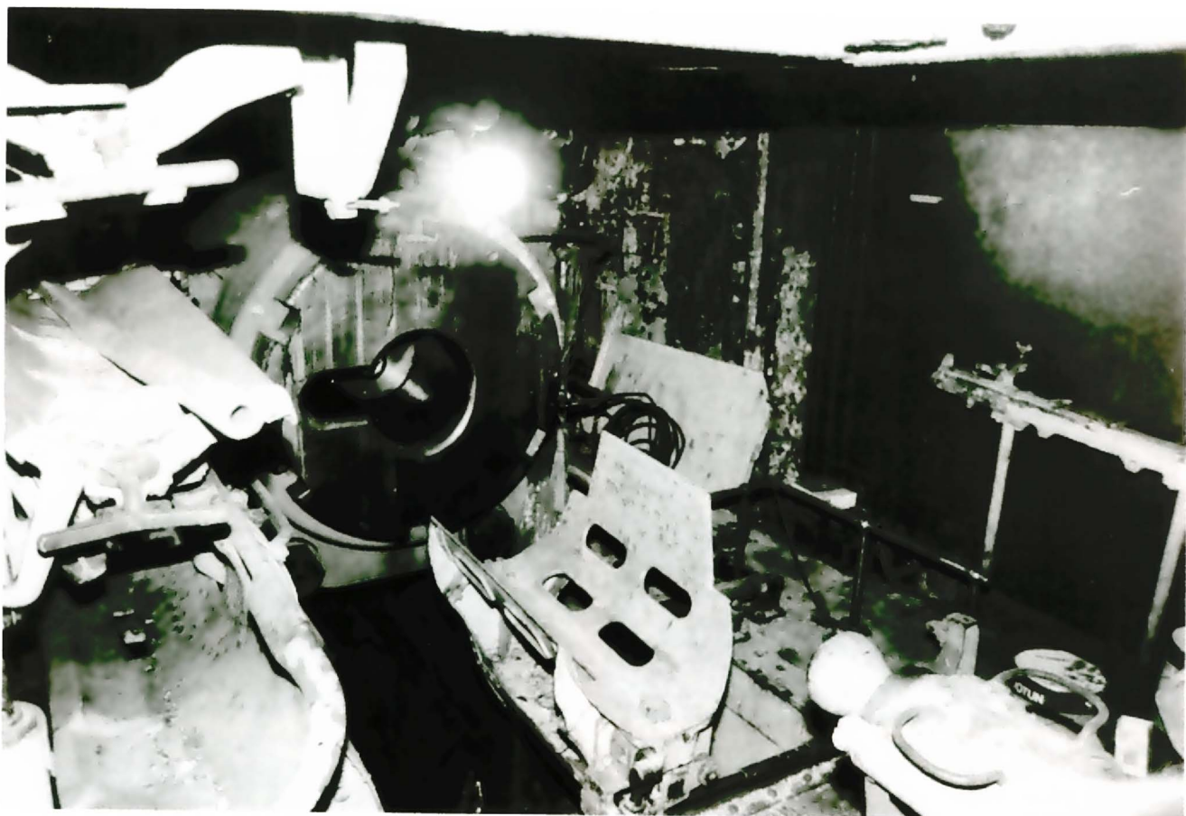
Das Bodenstück einer 28 cm SK L/50. Vor dem Ladeloch befindet sich die Ladeschale und der Geschößansetzer. Auf der linken Bildseite sind die Schalen des Munitions- und Kartuschenaufzuges zu sehen.
