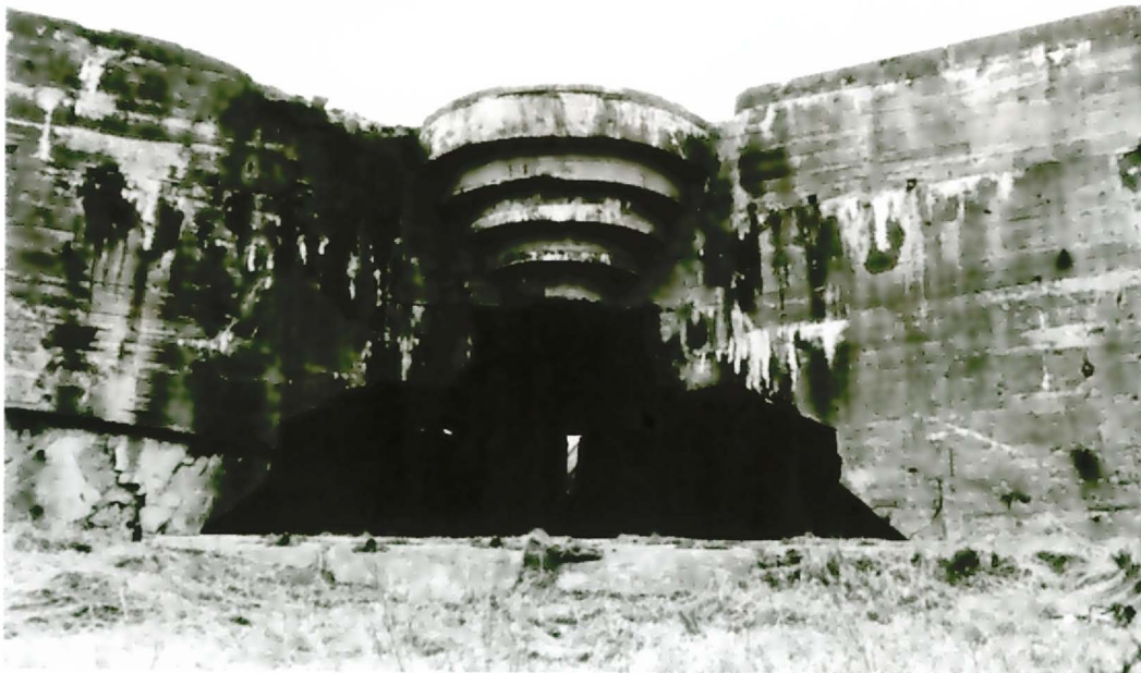
Oben: Nachkriegsaufnahme von Turm Cäsar, die umfangreichen Sprengarbeiten kanadischer Pioniere und das Entfernen aller Metallteile haben ihre Spuren an dem Turm hinterlas- sen.
