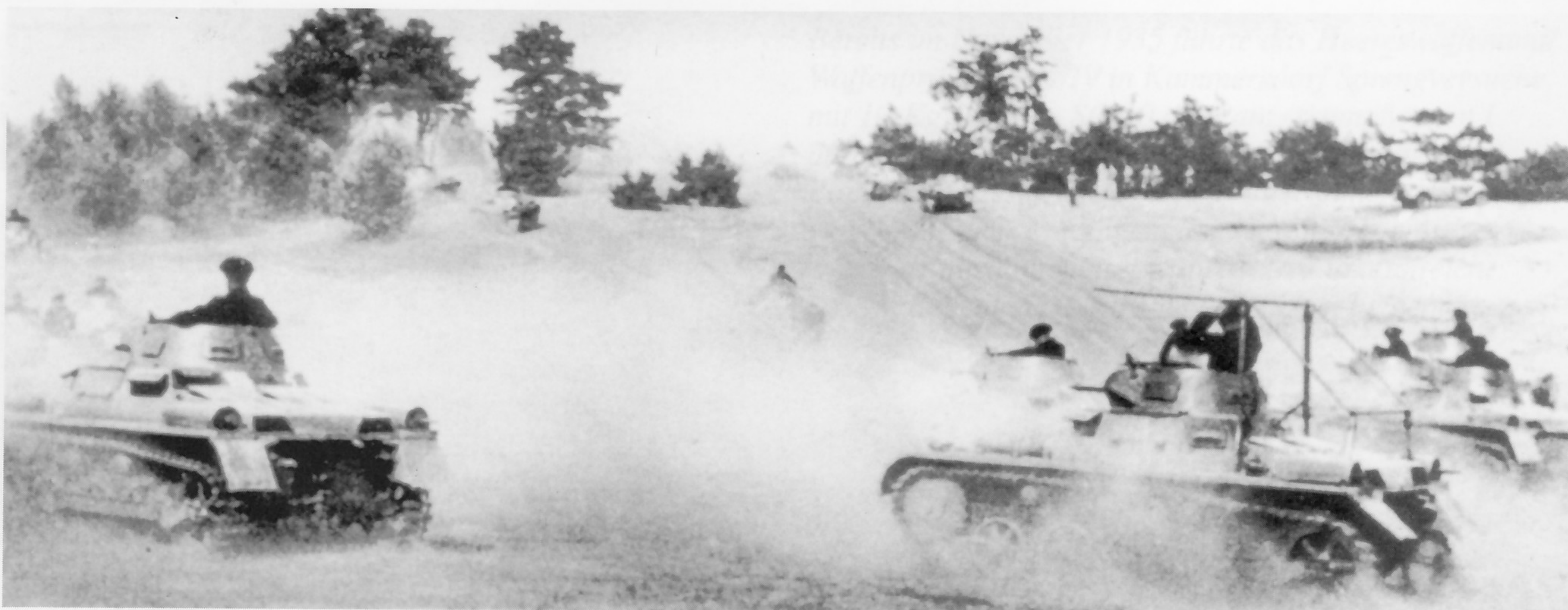
Rechts ein behelfsmäßiger, unter Verwendung eines normalen Panzerkampfwagen I (MG) (Sd.Kfz.101), Ausführung A hergestellter Panzerbefehlswagen beim Kraftfahrlehrkommando in Zossen. Aufnahme vom Sommer 1936.
