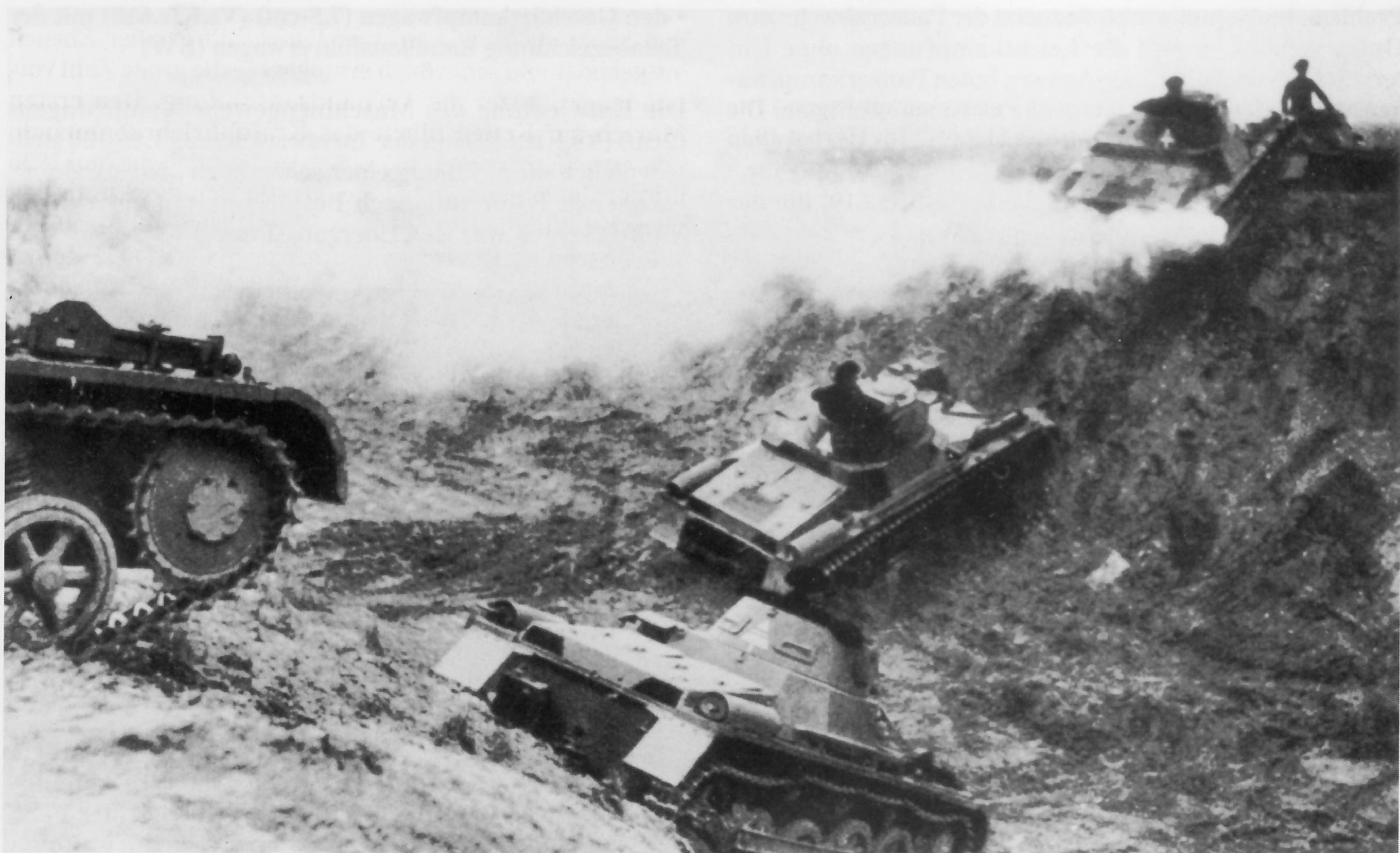
Panzerkampfwagen I (MG) (Sd.Kfz.101), Ausführung A im Gelände. In der Fahrvorschrift wurde empfohlen. Hänge möglichst im rechten Winkel anzufahren. Beim Befahren starker Steigungen sollte nur soviel Gas gegeben werden, daß der Motor gerade noch durchzog um so der Kette Zeit zum Greifen zu geben.
