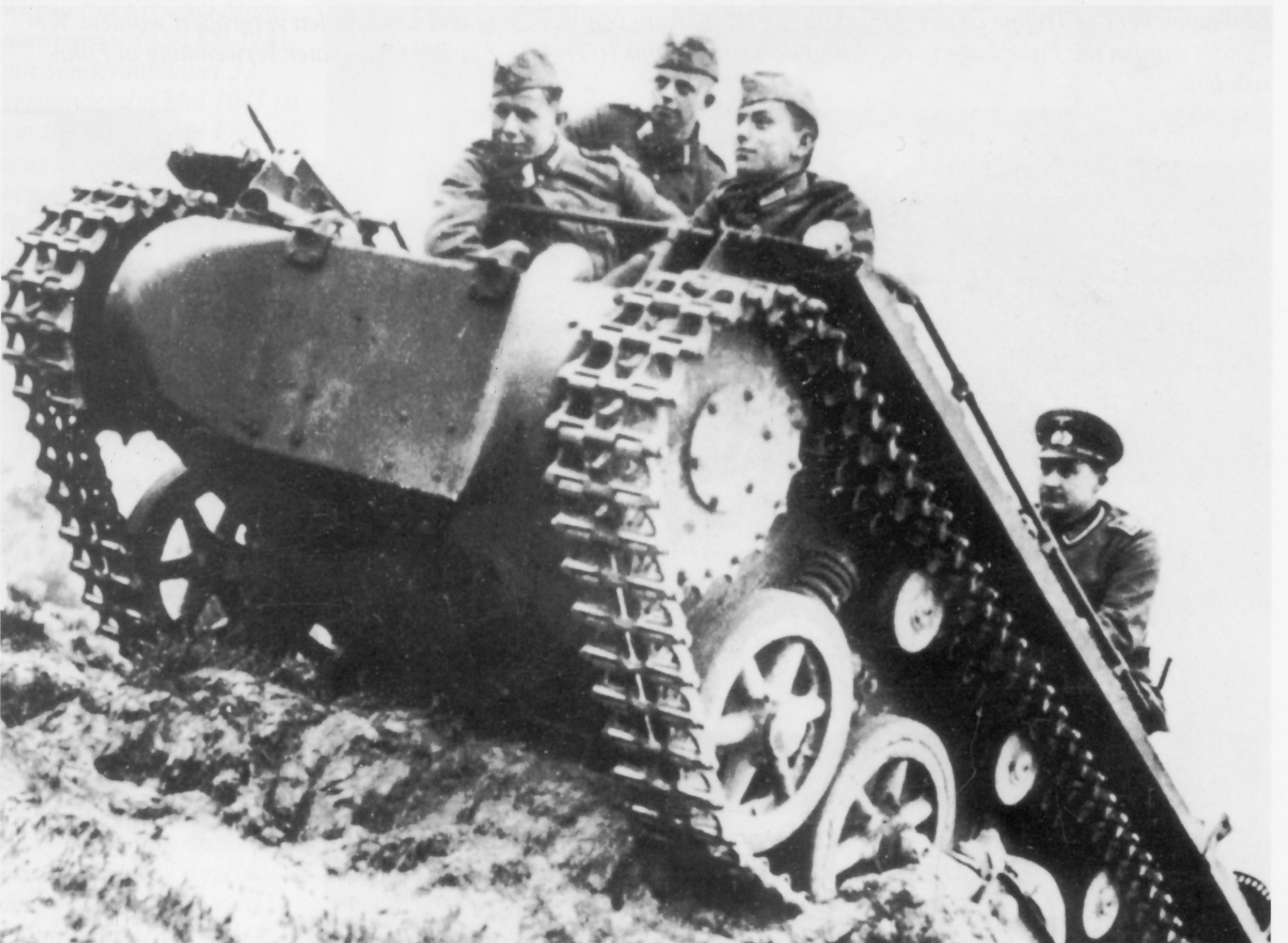
Ohne Aufbau und Turm wog der Fahrschulpanzer IA (LaS Krupp) etwa 3,5 t. Im Fahrerraum fanden neben dem Fahrlehrer mehrere Fahrschüler Platz.
