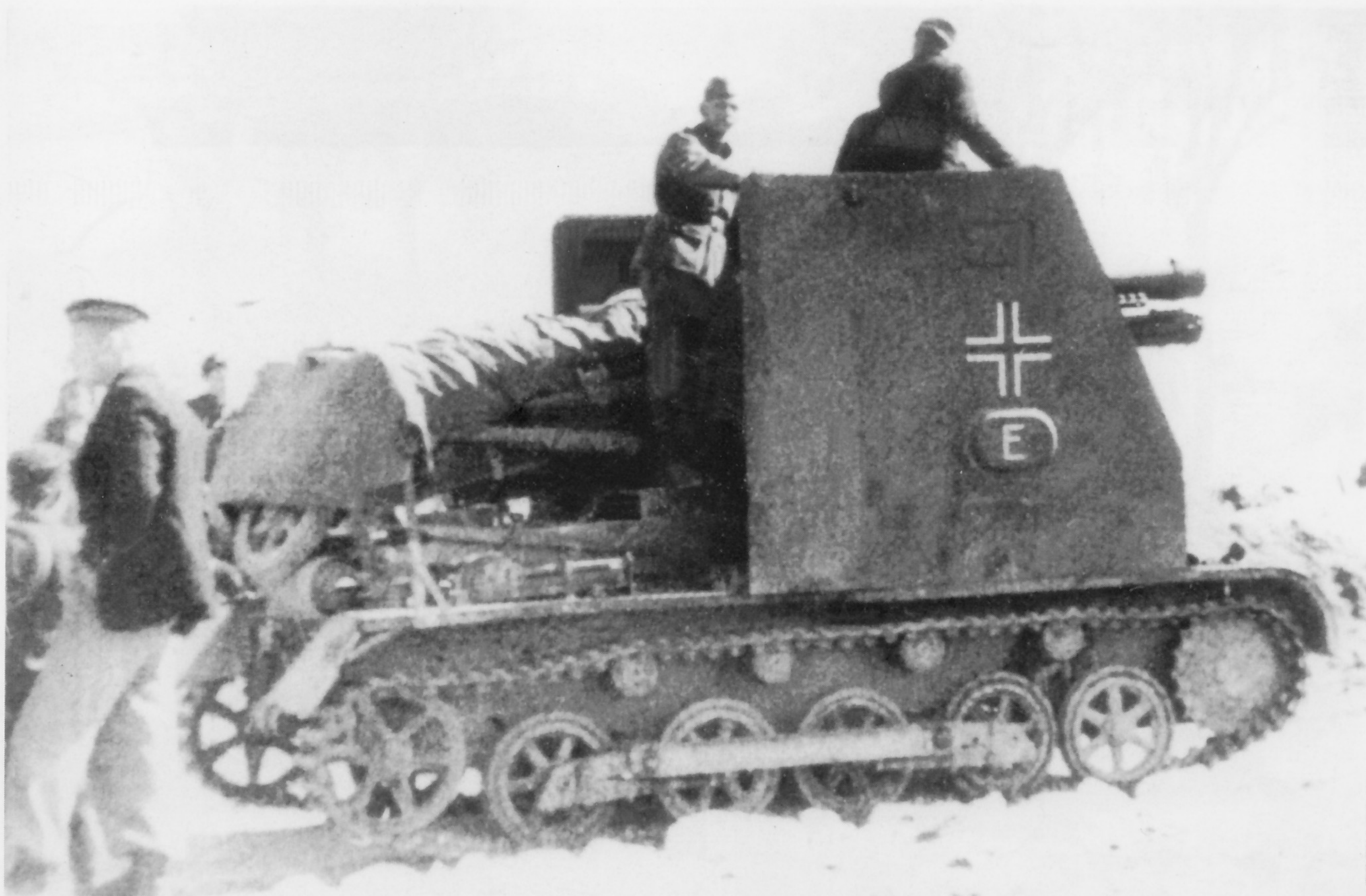
Die komplette Selbstfahrlafette wog 8,5 t und konnte 38 Km/h schnell fahren. Nachteilig erwies sich die Fahrzeughöhe, die mit 3,35 m angegeben ist. Dabei muß bedacht werden, daß diese Konstruktion zu den Infanteriewaffen zählt und die Schützenbataillone artilleristisch unterstützen sollte.
