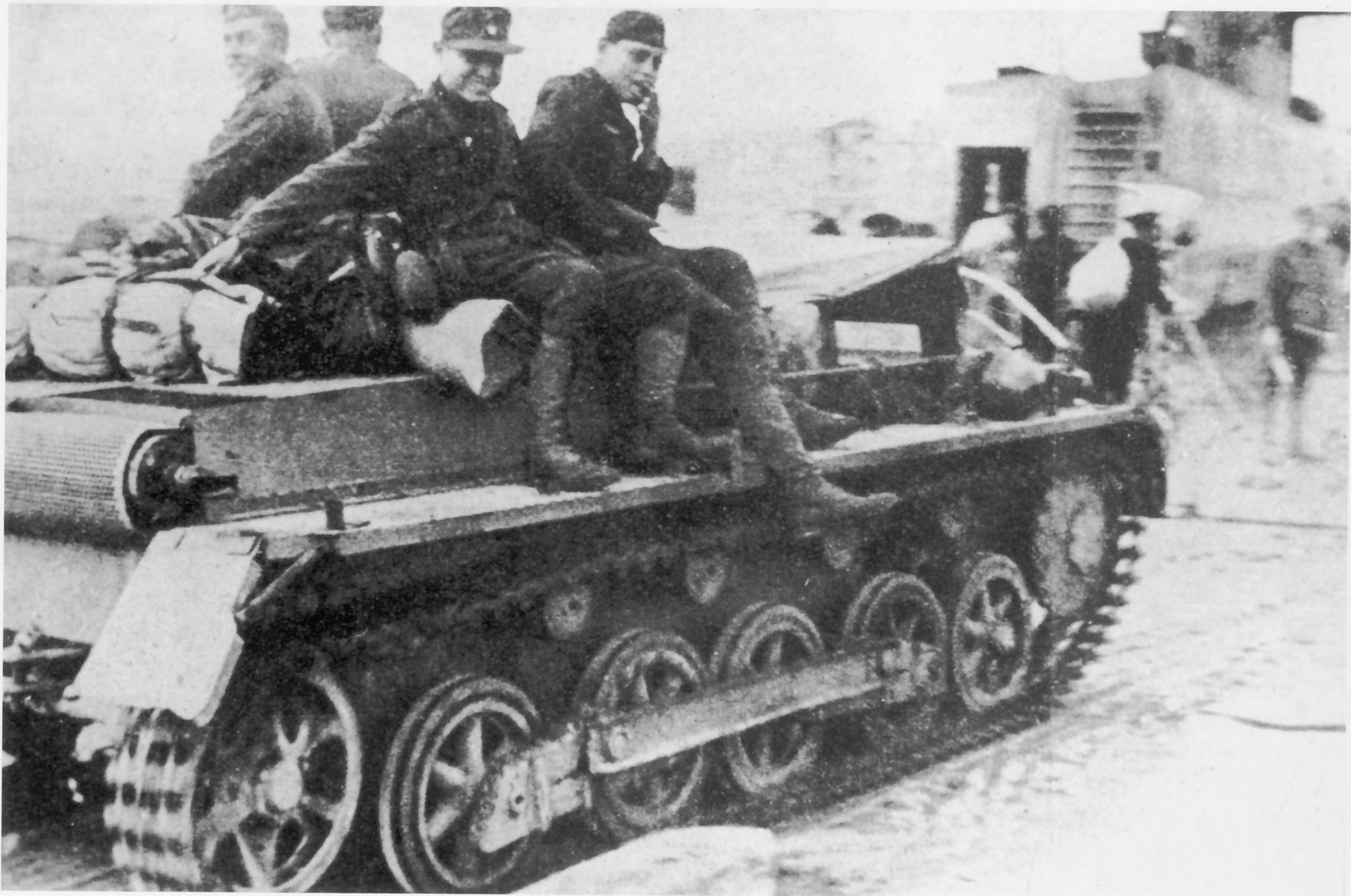
Zwischen dem November 1936 und November 1938 kamen 164 Instandsetzungskraftwagen I zur Auslieferung. Durch Umbauten bei der Truppe ist der Stauraum zur Mitführung von Werkzeug und Ersatzteilen vergrößert worden. Verwendet wurden die Fahrzeuge in den Instandsetzungstrupps (I-Trupp). Ein Teil fand später Verwendung in Fahrschulen.
