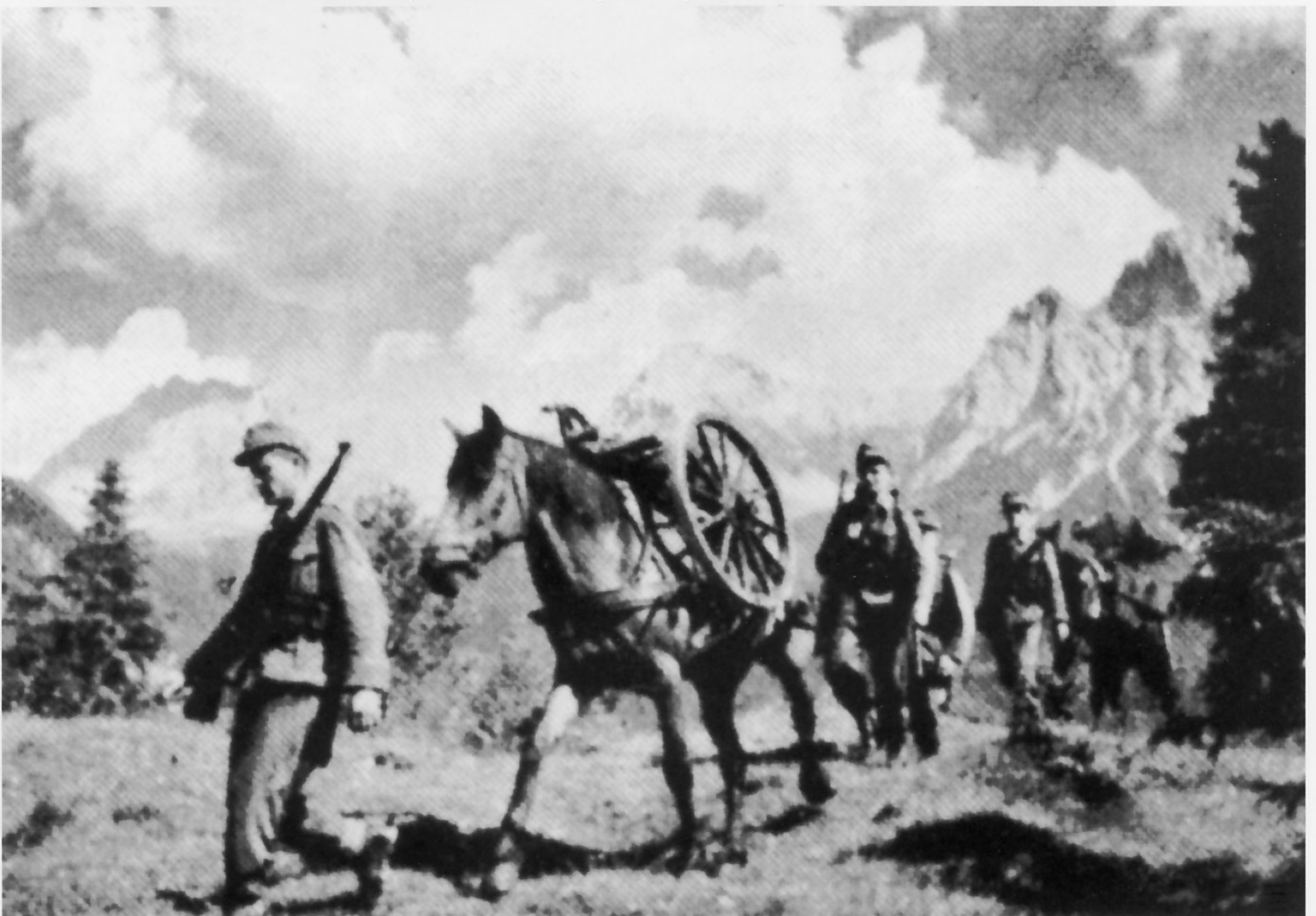
Räder als Seitenlasten und Hinterlafette (rückwärtiges Tragtier)
