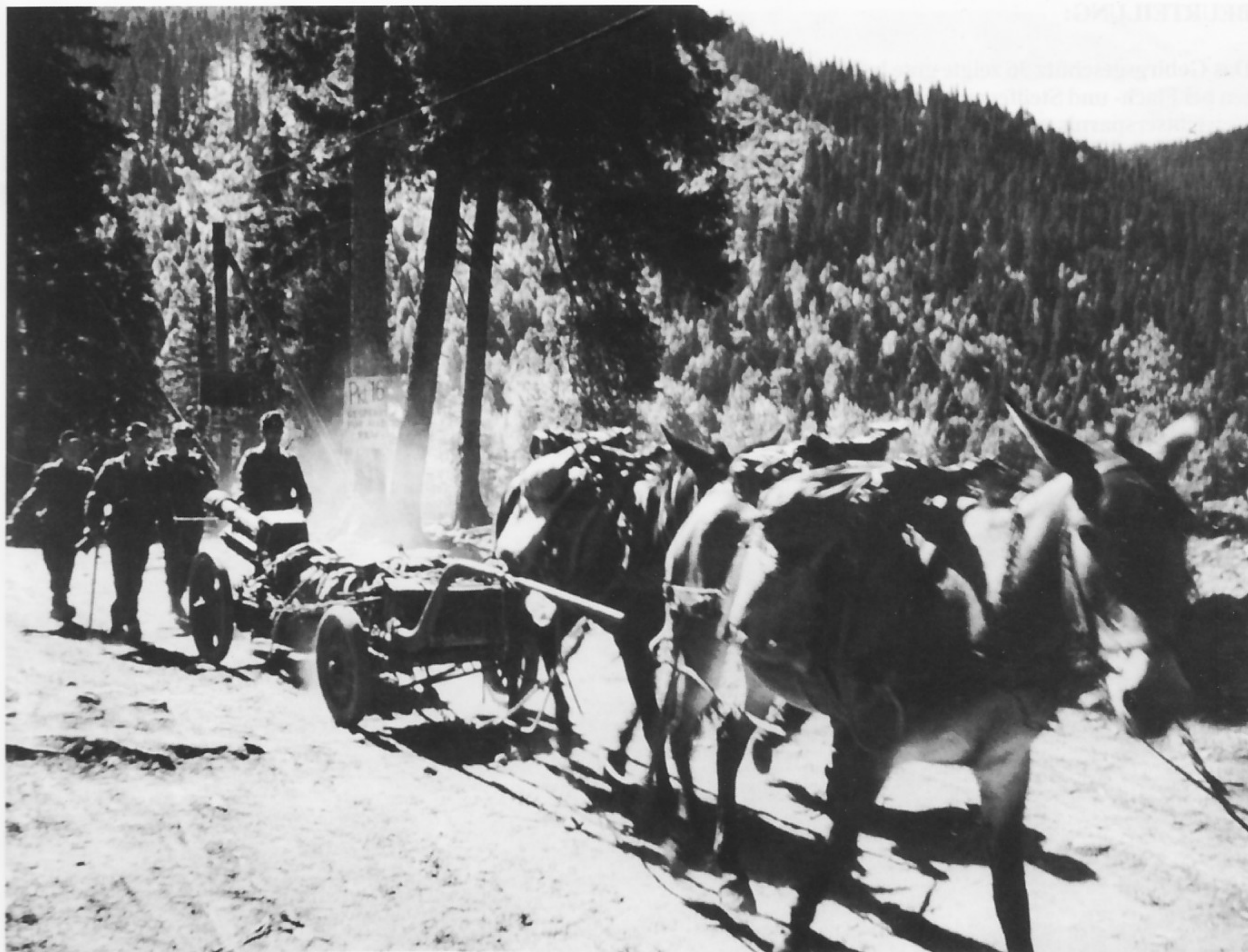
Gebirgsgeschütz 36 der I./Geb.Art.Rgt. 79 hinter kleiner Protze mit Tandembespannung in Gabeldeichsel beim Marsch in den Kaukasus (1. Geb.Div.)
