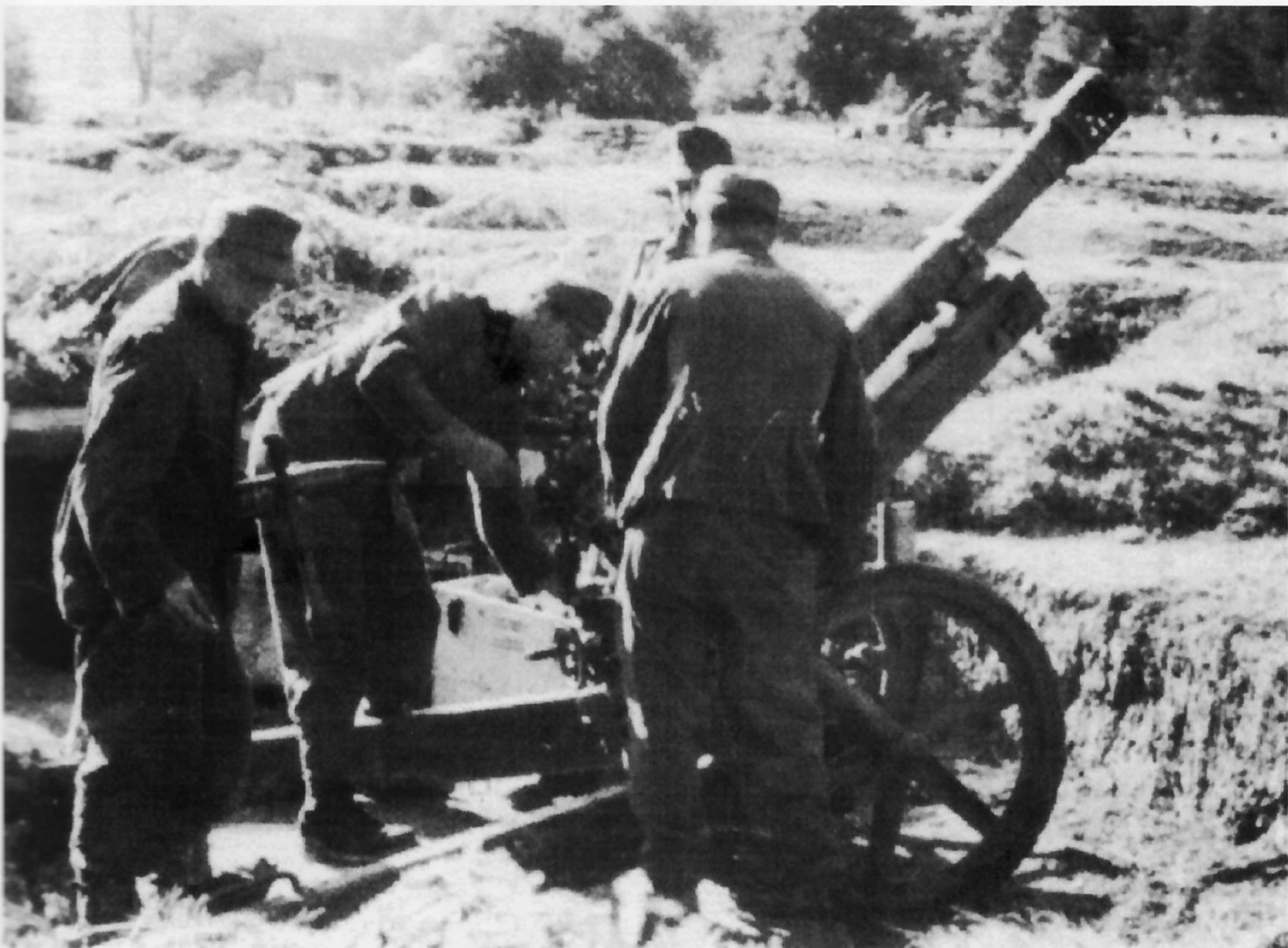
Das Gebirgsgeschütz 36 mit Speichenrädern und geschlitzter Mündungsbremse
