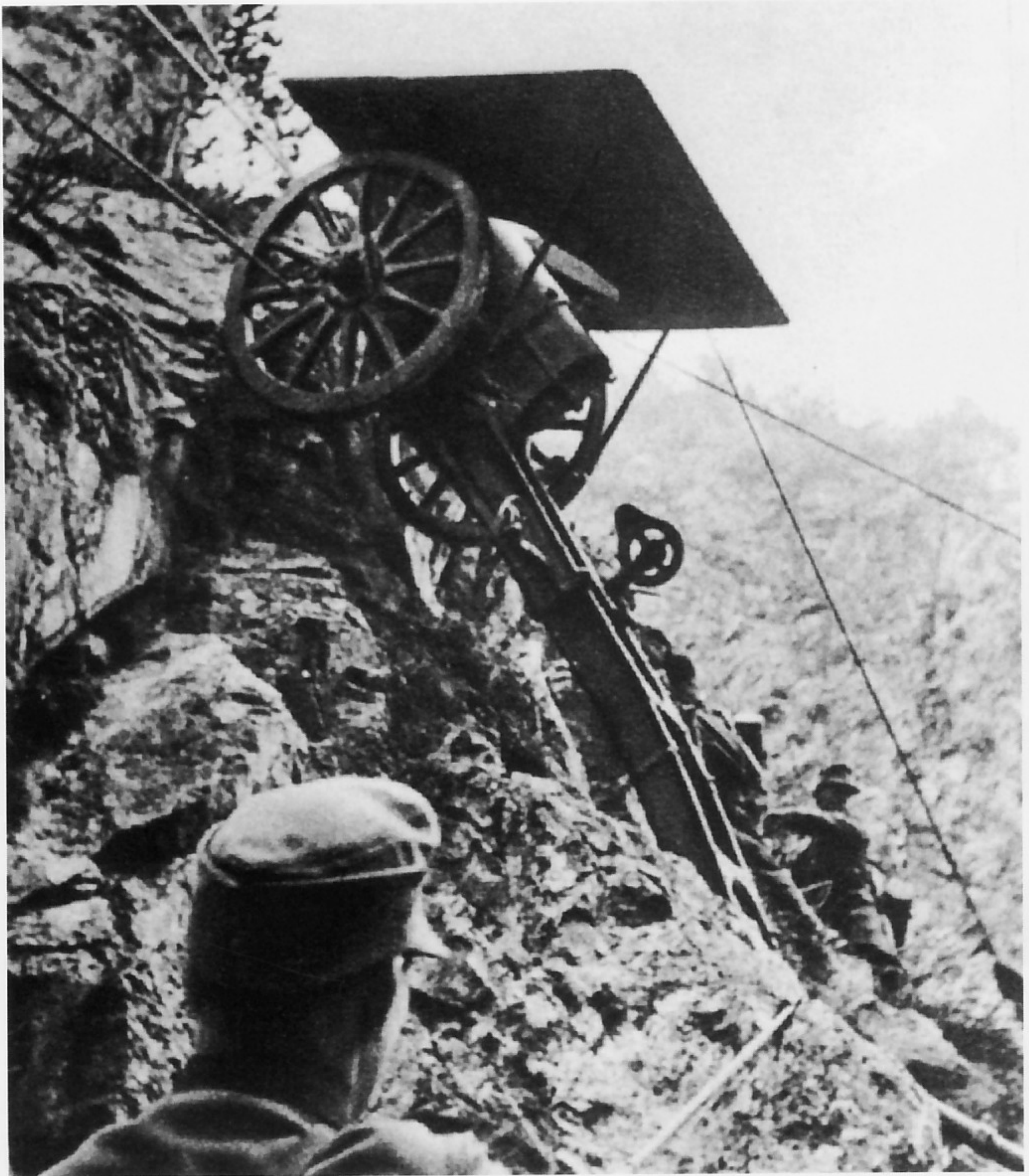
Auch dies wurde in Friedenszeiten geübt - Hochziehen eines ganzen Geschützes am Steilhang
