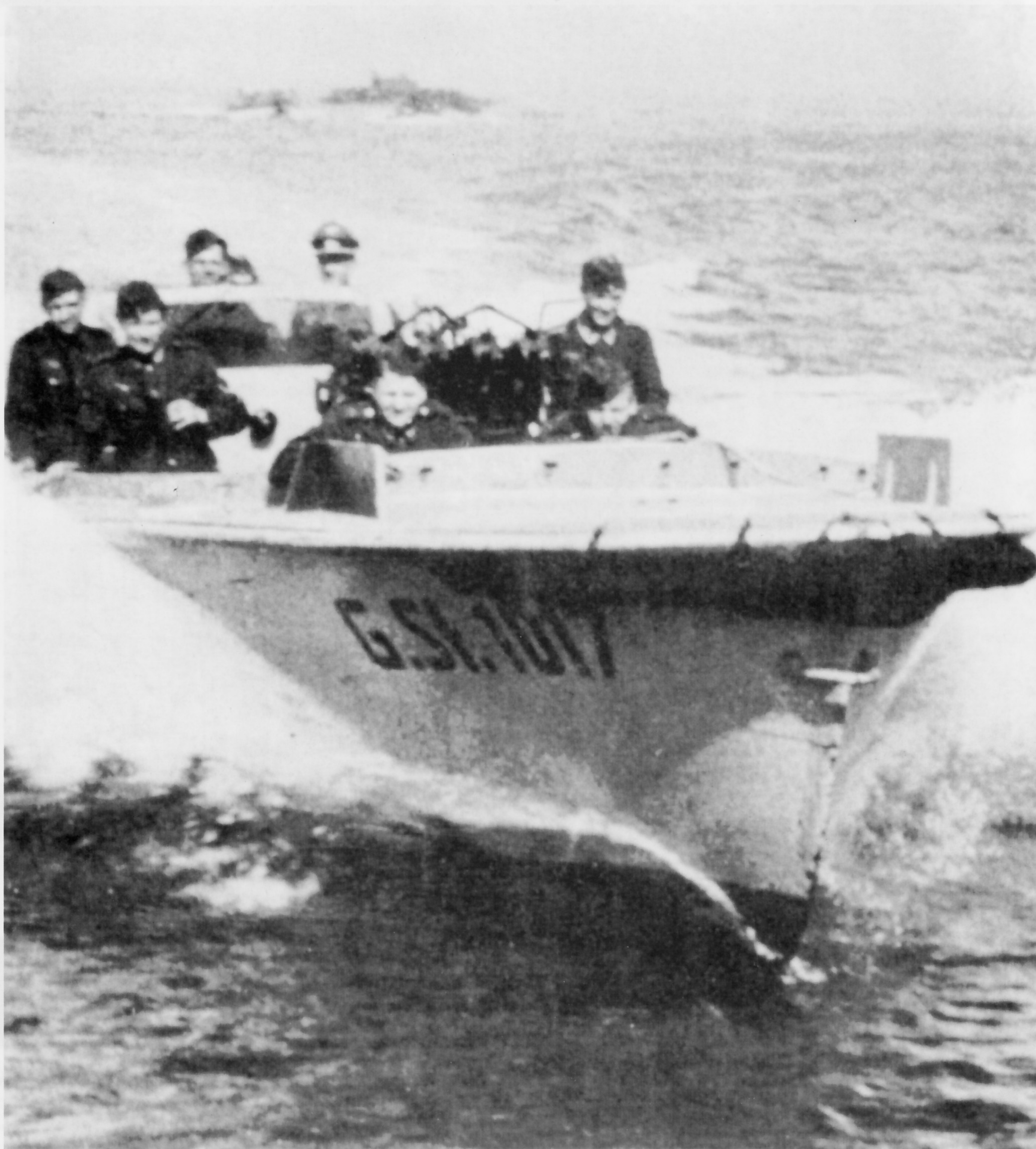
Ein Schweres Sturmboot 42 im Mittelmeer. Es erreichte Geschwindigkeiten von über 42 km pro Stunde.
