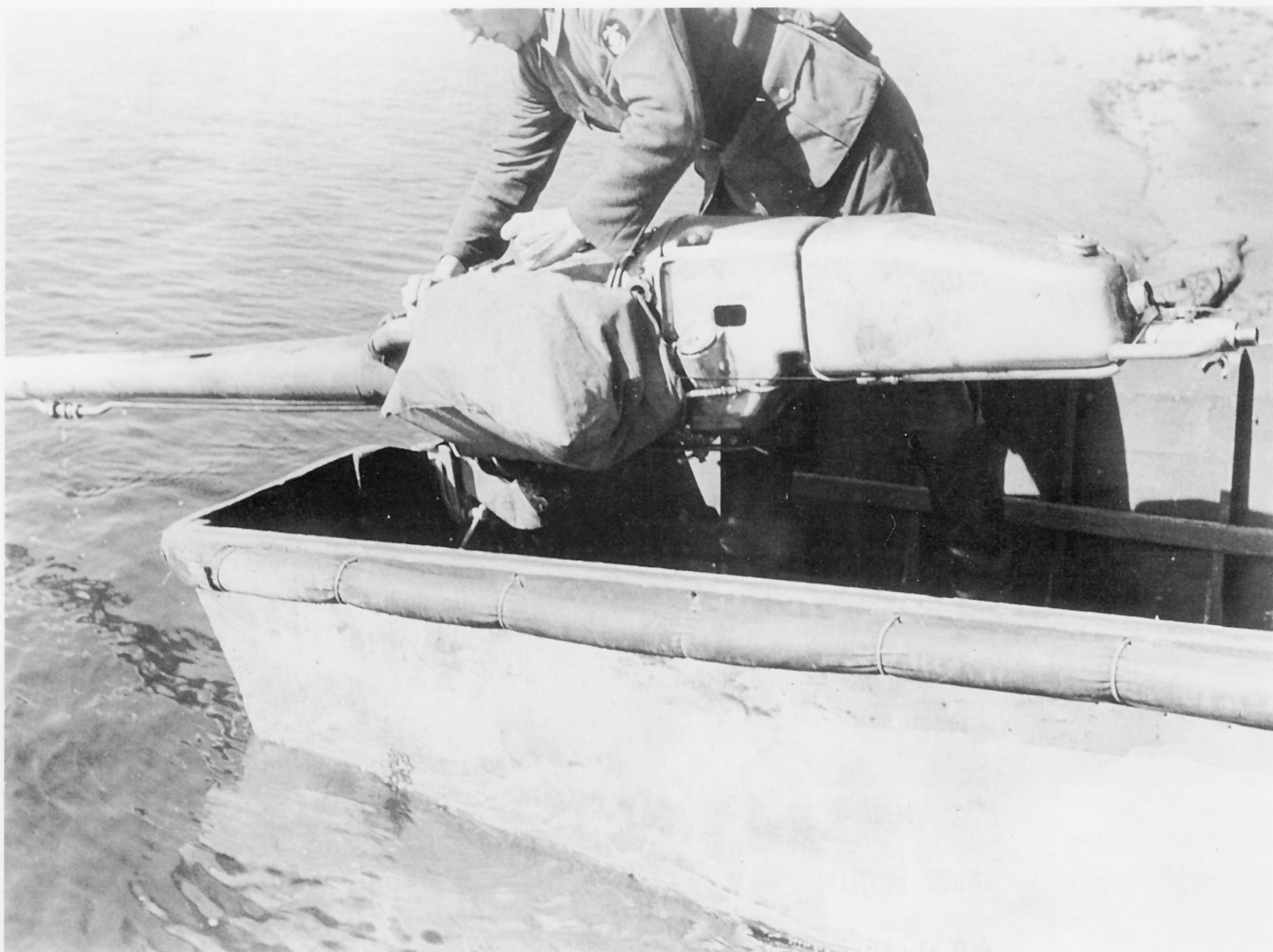
Anlegen einer Teilschutzplane am Motor gegen Witterungseinflüsse.
