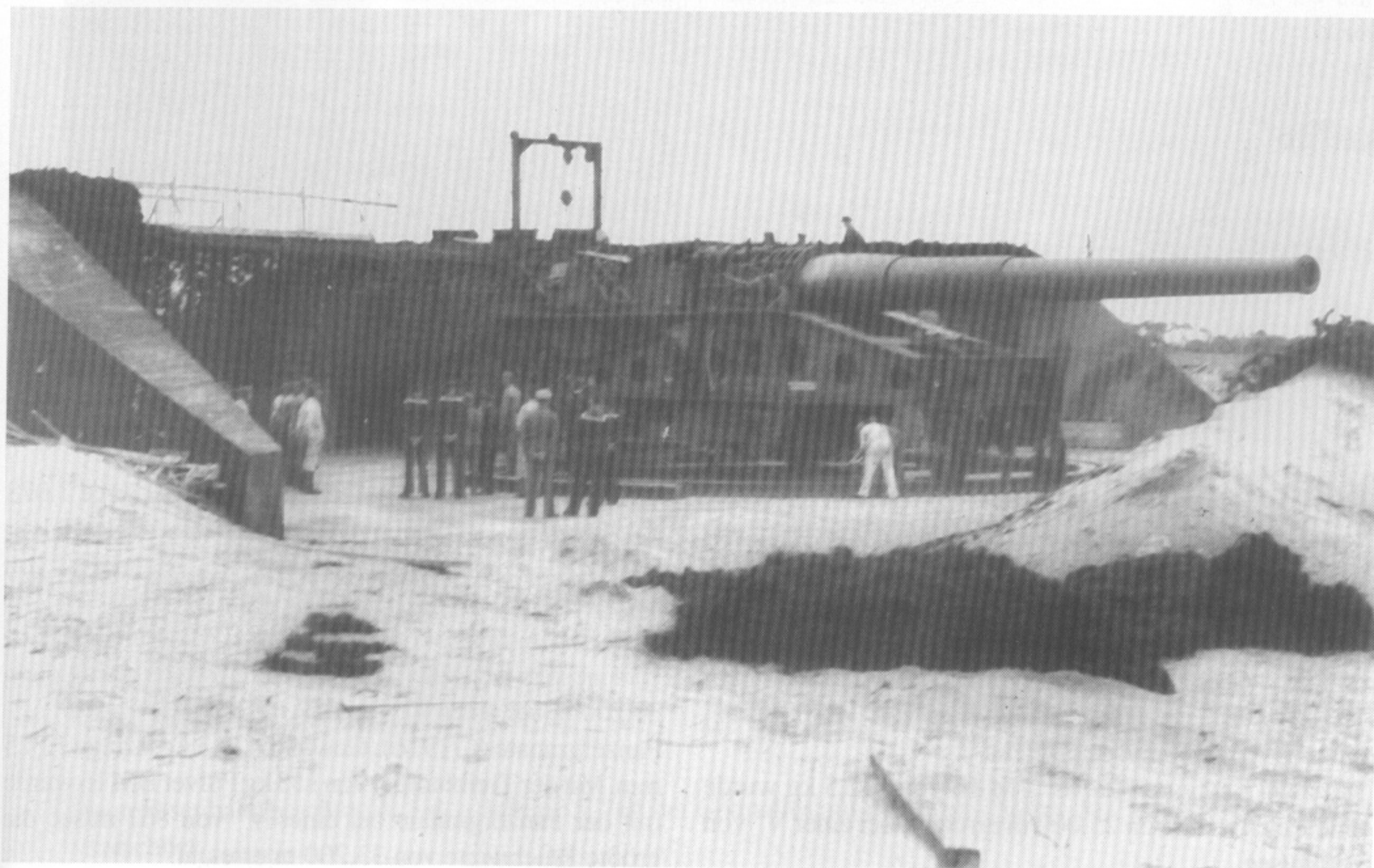
Unten: Das 3. Geschütz während des Einbaus in die Bettung.
