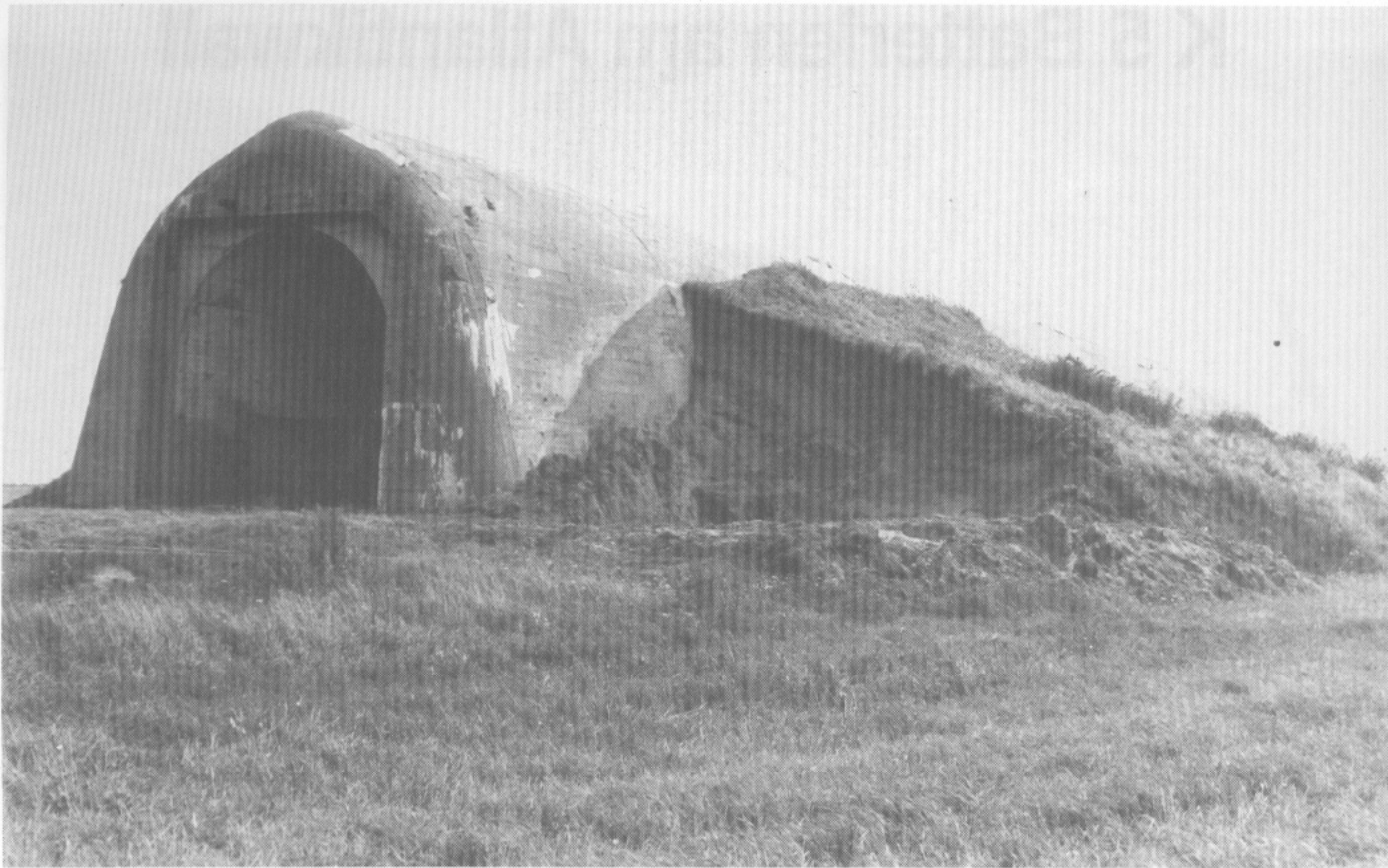
Dombunker der Batt. E 712 mit Erdanschüttung. Durch die gewölbte Form des Bunkerdachs sollten auftreffende Bomben zur Seite abgelenkt werden.
