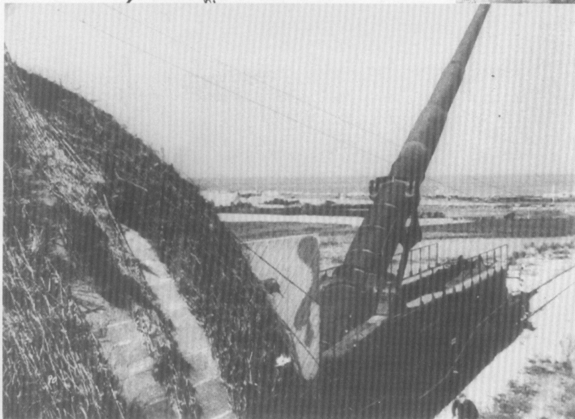
Blick in den Dombunker, der zwei K 5 Kanonen und der Diesellok Schutz bot.
