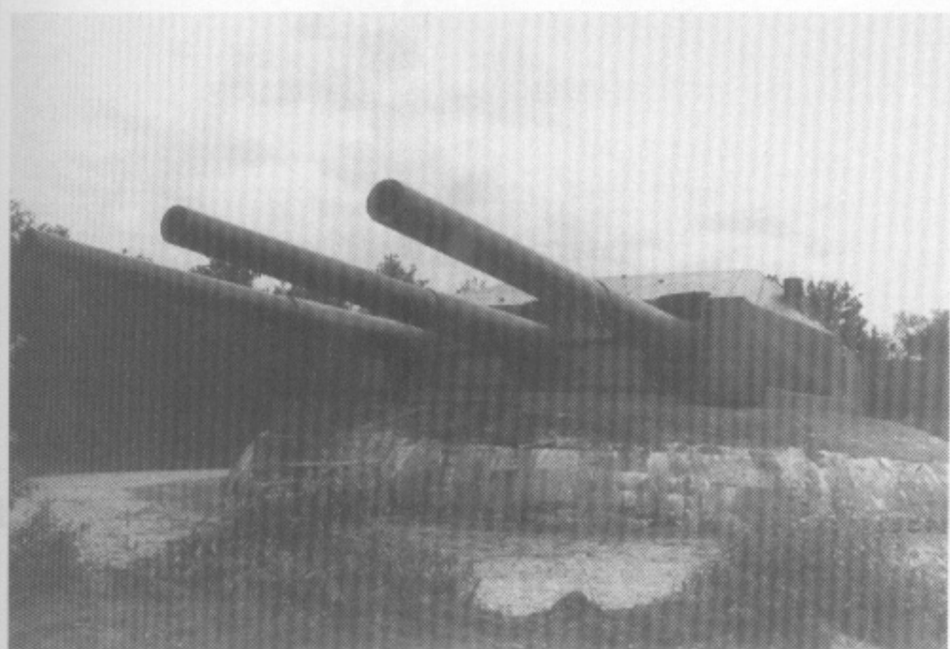
Die Batterie Oerlandet bei Trondheim in Norwegen war mit einem Drillingsturm des Kreuzers Gneisenau, Kaliber 28 cm, ausgerüstet.
