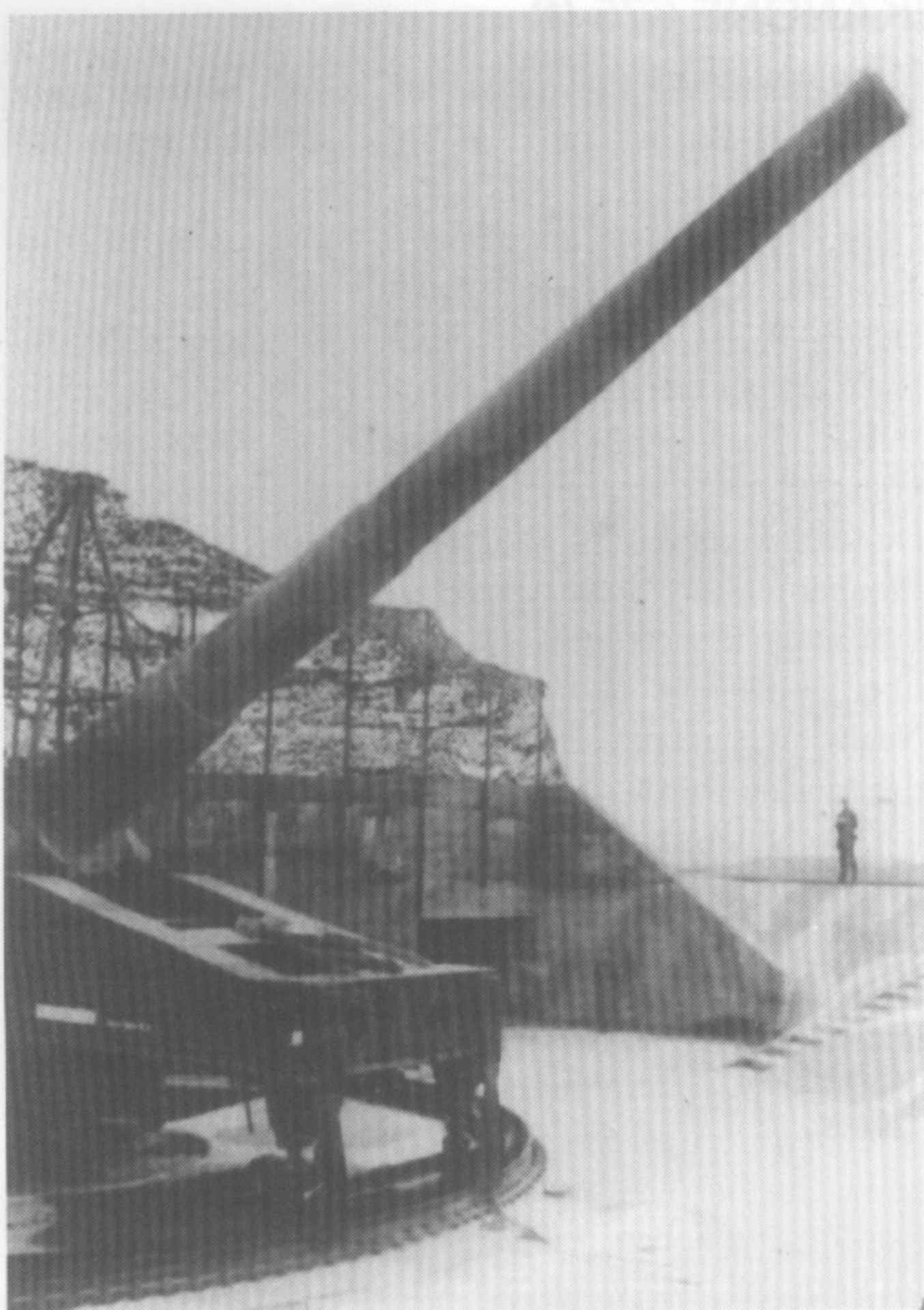
Das Rohr der 34 cm Kanone 675 (f) in größter Erhöhung von + 42°. Über den Bunker und den hinteren Teil des Geschützes sind Tarnnetze gezogen worden.
