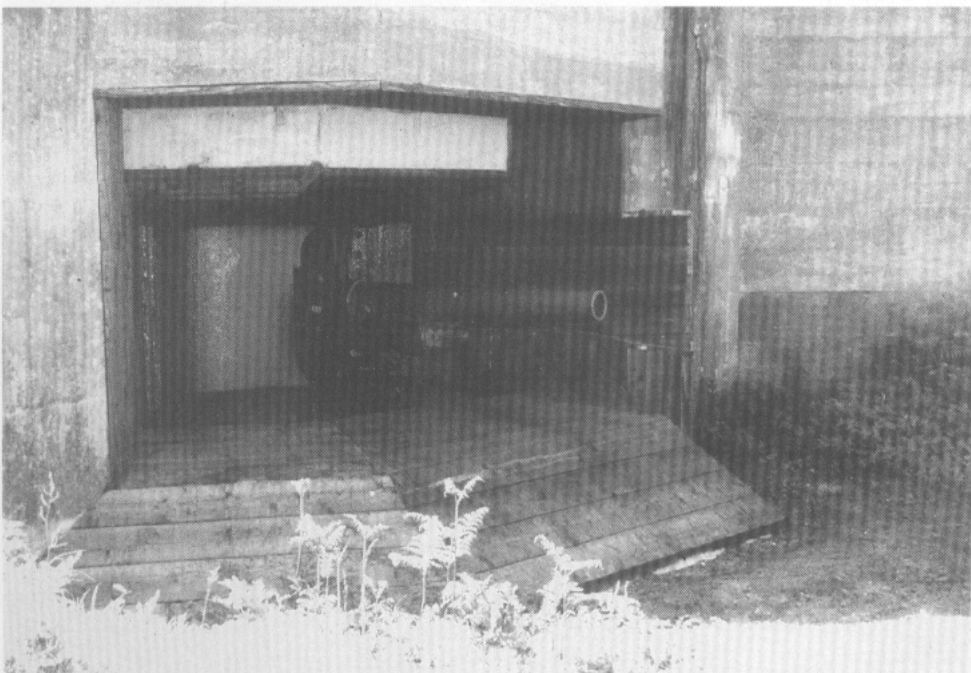
Links: Der mächtige Bunker bot Bedienung und Geschütz ausreichende Deckung, an der Scharte sind Holzbretter angebracht, die Granatsplitter auffangen sollten. (Zimmermann)
