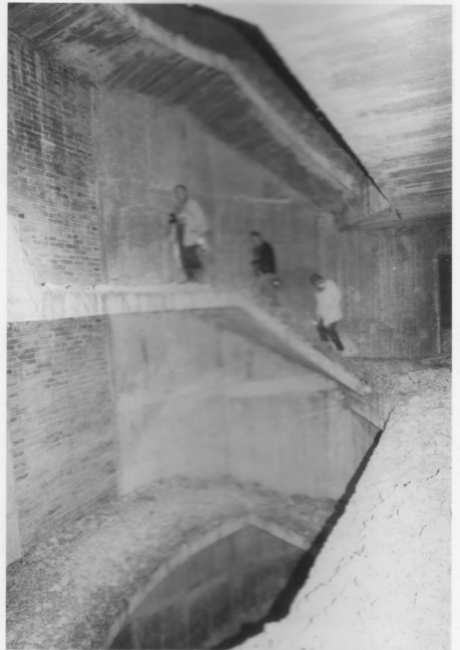
Gut sichtbar die Zerstörungen durch die Sprengung der Sowjets im G-Turm Augarten. Riesige Eisenbetonblöcke sind aus den Wänden des Innenbereiches herausgerissen worden. Rechts: die Größenordnung wird deutlich. Bevölkert wird der G-Turm durch Tauben, die durch die Öffnungen in der Außenwand in das Innere gelangen.
