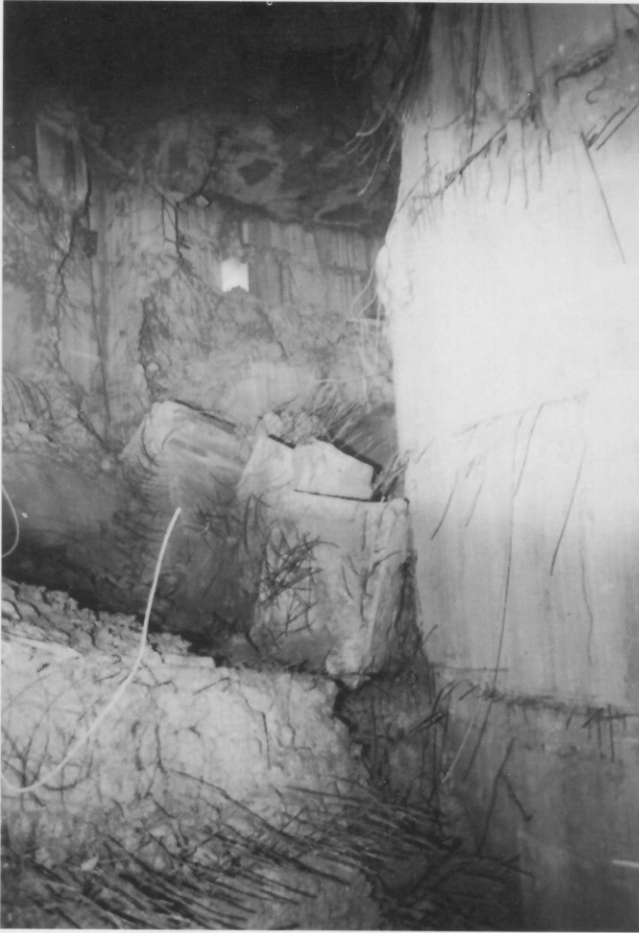
Gut sichtbar die Zerstörungen durch die Sprengung der Sowjets im G-Turm Augarten. Riesige Eisenbetonblöcke sind aus den Wänden des Innenbereiches herausgerissen worden. Rechts: die Größenordnung wird deutlich. Bevölkert wird der G-Turm durch Tauben, die durch die Öffnungen in der Außenwand in das Innere gelangen.
