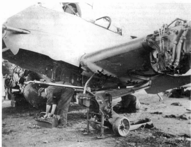
Bergung der bruch- gelandeten Me 210 SO+MU, W-Nr 281, offensichtlich durch RAF- Personal. Wie bei Bergungen üblich, wurde zunächst die Bewaffnung ausgebaut. Die nach vorn herausgezogen- en Schutz- rohre der beiden MG 151 sind deutlich sichtbar. So konnten die Waffen von unten entfernt werden. (Radlinger)
