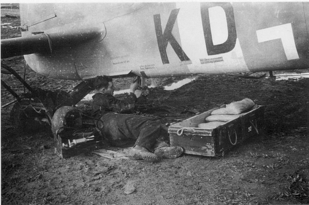
Reparaturarbeiten am Spornrad einer Me 210 der III./ZG 1 in Chinisia, Februar 1943. In der Aussparung des Rumpfbandes unter dem "D" steht: "Vor dem Aufbocken mit 500 kg belasten." (Petrick)
