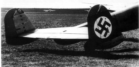
Das doppelte Seitenleitwerk der Me 210 V-1. Es wurde am 23. 9. 1939 gegen ein Zentralleitwerk ausgetauscht. (Mohr)
