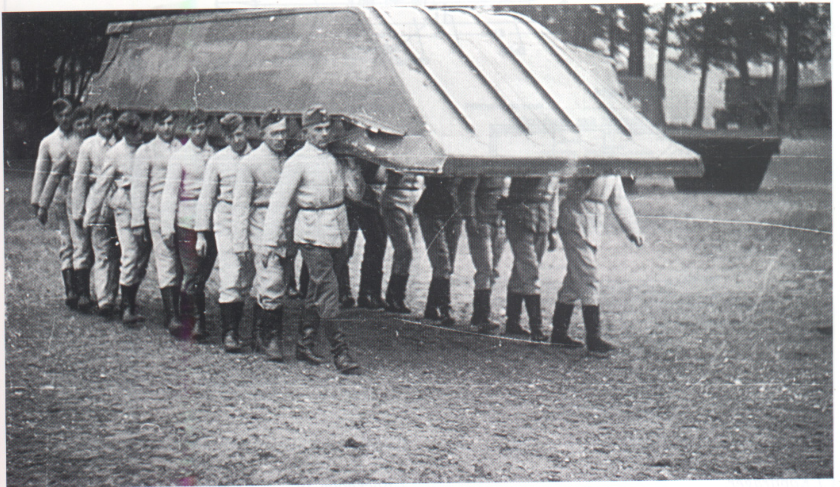
Fährenbau beim Pz.Pi.Btl. 49. Ein Endstück des Brückengerätes K wird von 18 Pionieren zu Wasser getragen (RF).
