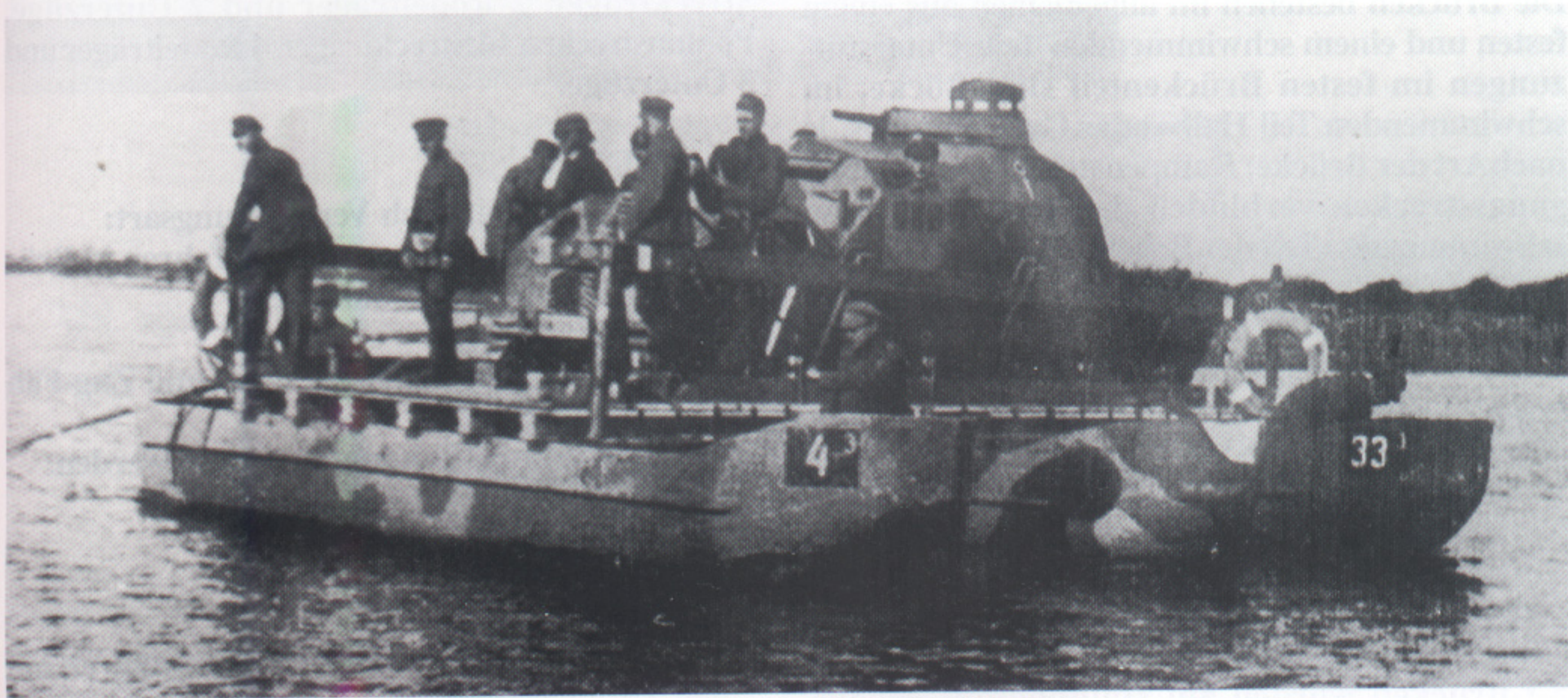
Übung des Pionier-Batl. 3, Küstrin, auf der Oder 1930. Auf einer 7 t-Fähre wird eine Panzerspähwagen-Nachbildung vom Typ Adler Standard 6 übergesetzt. (RF)
