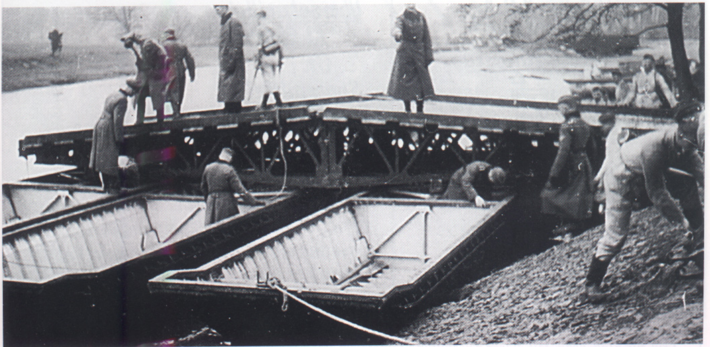
Eine kurze 16 t-Fähre wird zusammengebaut. 3 Pontons, bestehend aus 2 End- und 1 Mittelstück, sind fertig. Die Trägerendstücke liegen auf dem Pontonmittelstück. (RF)
