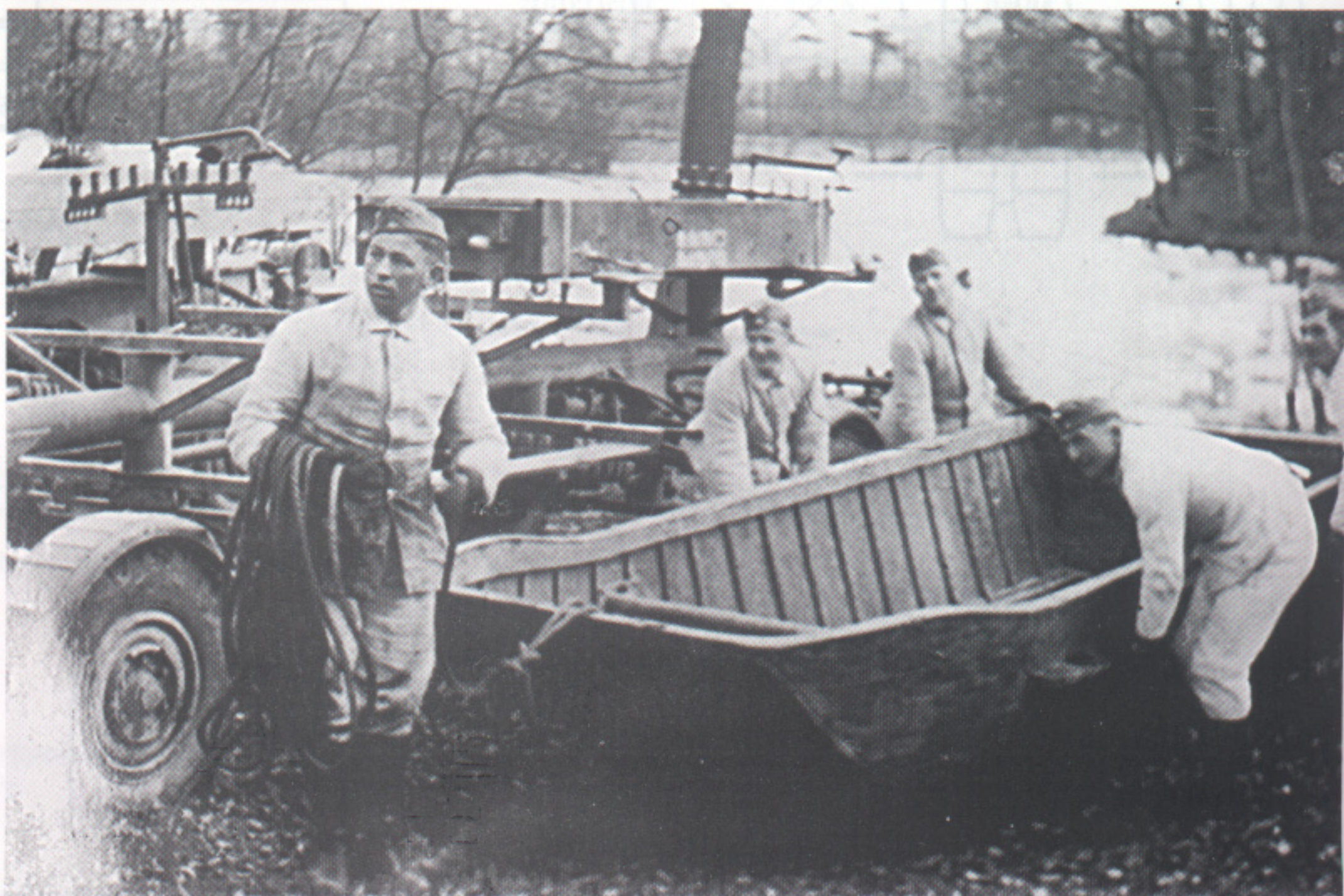
Der Brückenbau beginnt. Die Halb- pontons wurden vom Pontonwagen (Pf. 15) abgeladen. (RF)
