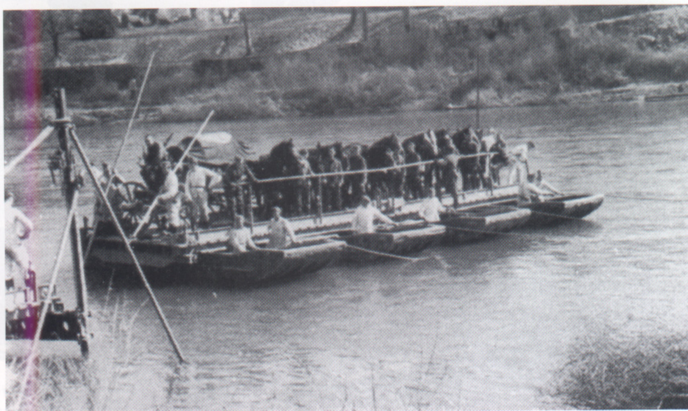
Übersetzübung bei St. Aubin an der Loire mit einer 8 t- Doppelfähre. (PzP)
