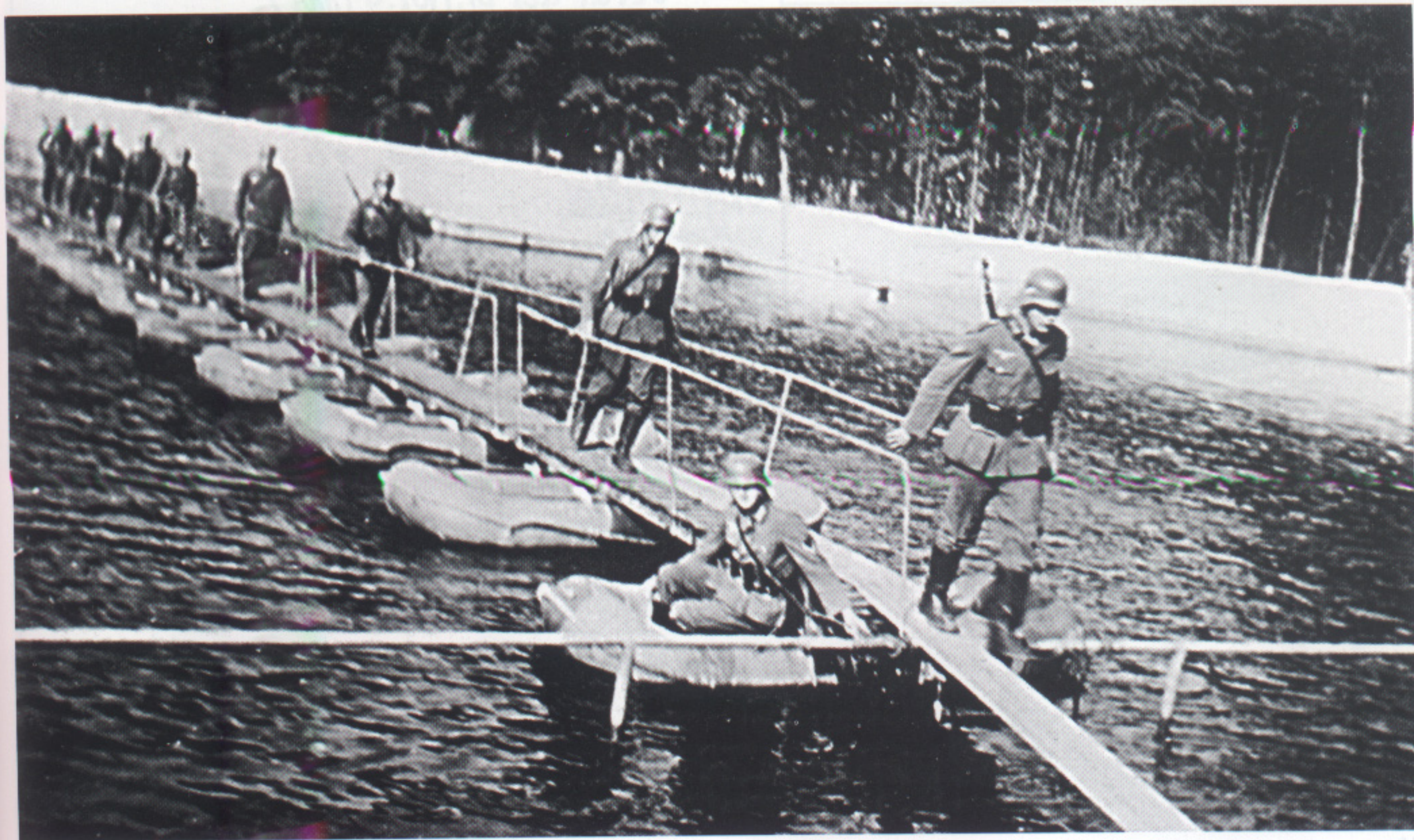
Ein Steg, gebaut aus kleinen Floßsäcken 34 und Brückentafeln des C-Gerätes, dient der Infanterie als Flußübergang. (RF)
