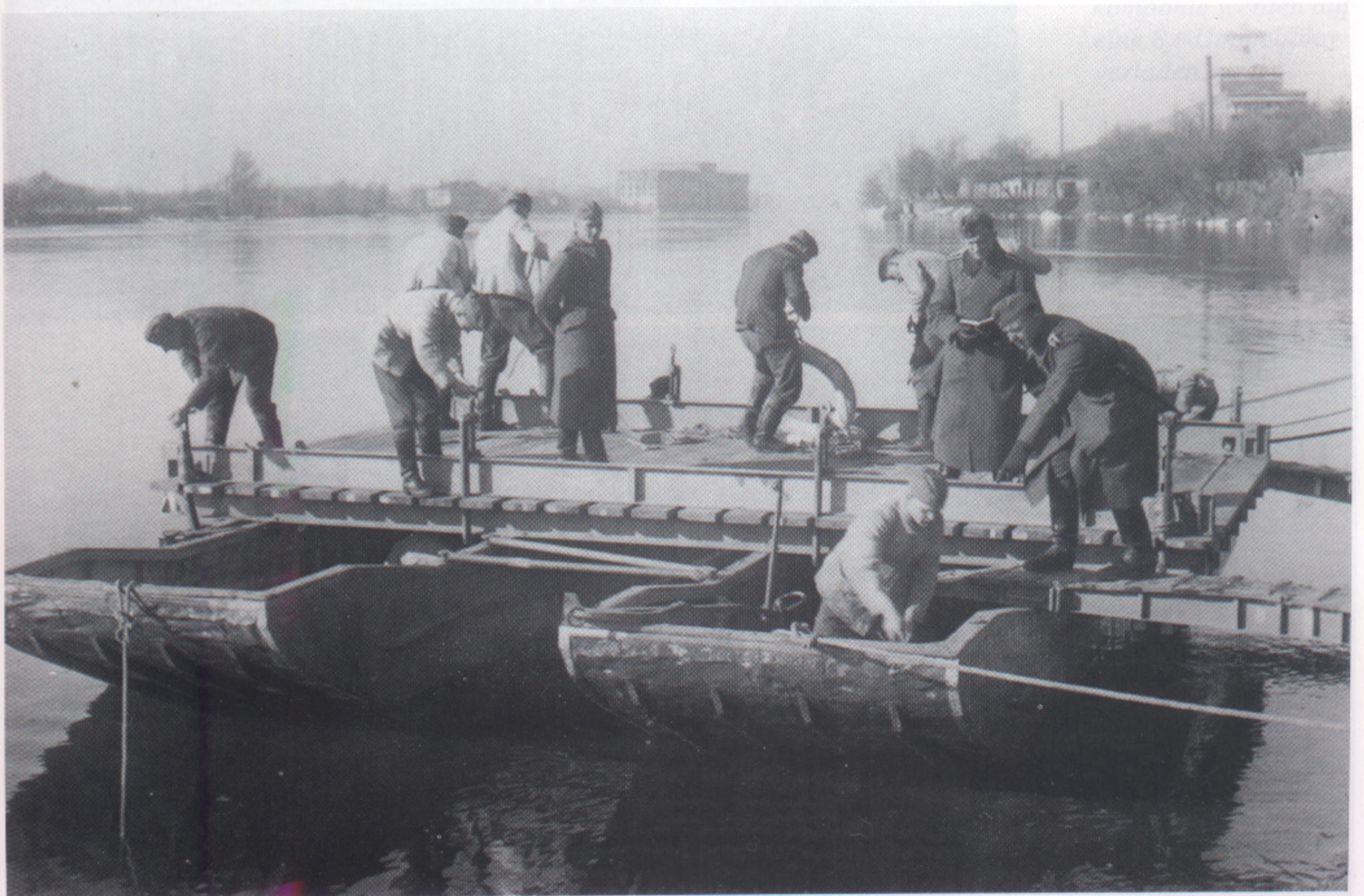
Eine 4 t-Fähre ist fast fertig montiert. Die Rödelträger werden befestigt. Als Verbindung zwischen Flußufer und Fähre wurden Übergangsschienen verlegt. (RF)
