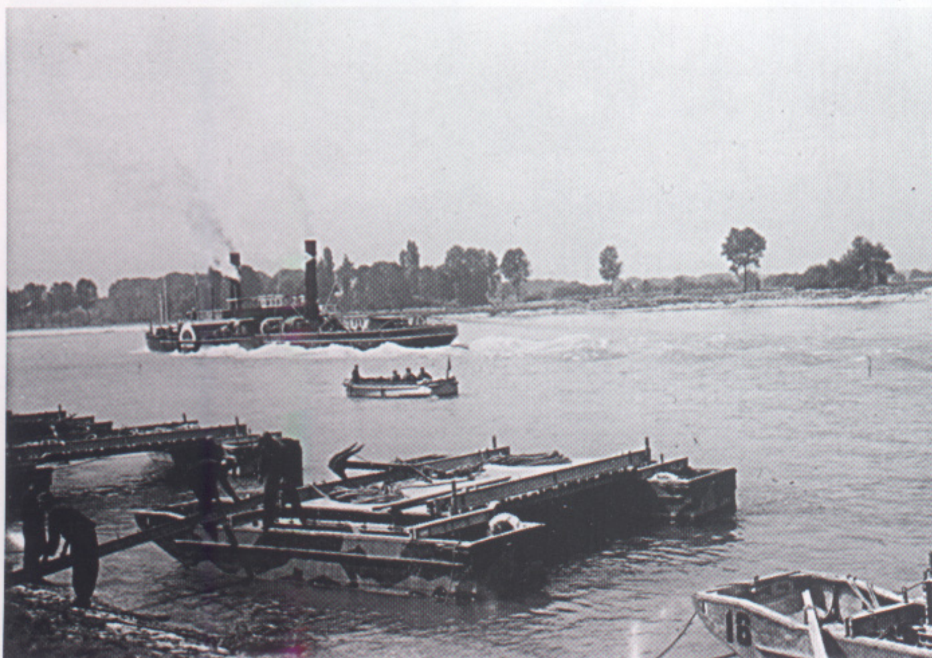
Hier werden 4 t-Fähren mit Zusatzgerät zusammengebaut. Die Pontons sind mit dem Dreifarben-Tarnanstrich versehen. Fähren mit Zusatzgerät wurden für Pontonbrücken verwendet, wenn der zu überbrückende Fluß eine hohe Stromgeschwindigkeit hatte. Durch den größeren Abstand von Ponton zu Ponton wurde der Brückenwiderstand verringert. (RF)
