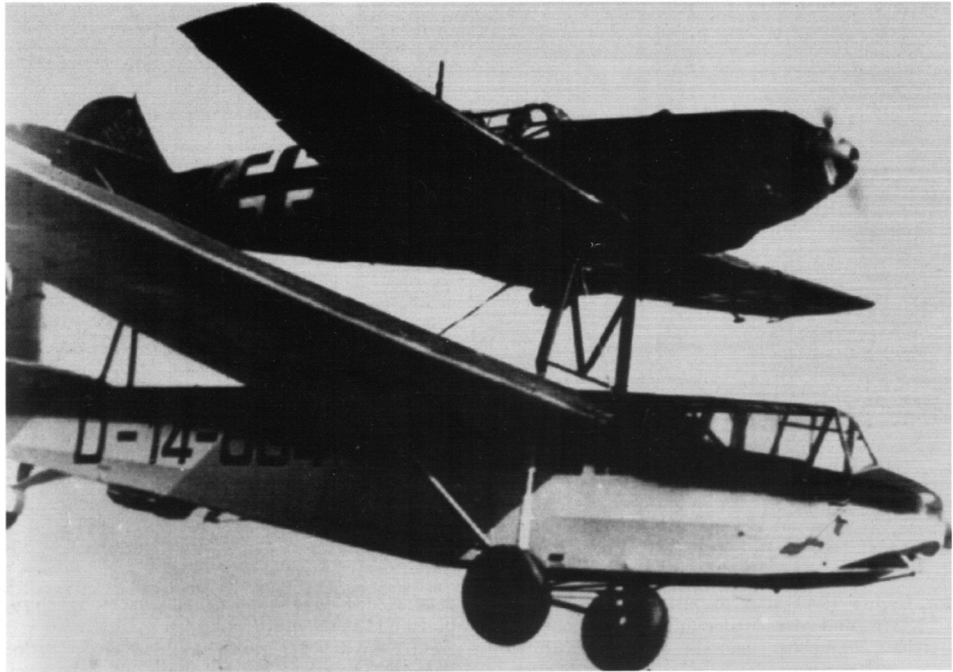
Bf 109/ DFS 230 mit einfachem Stützbock. Die unteren Fotos zeigen im Gegensatz dazu die Version mit Sturzbremse.
