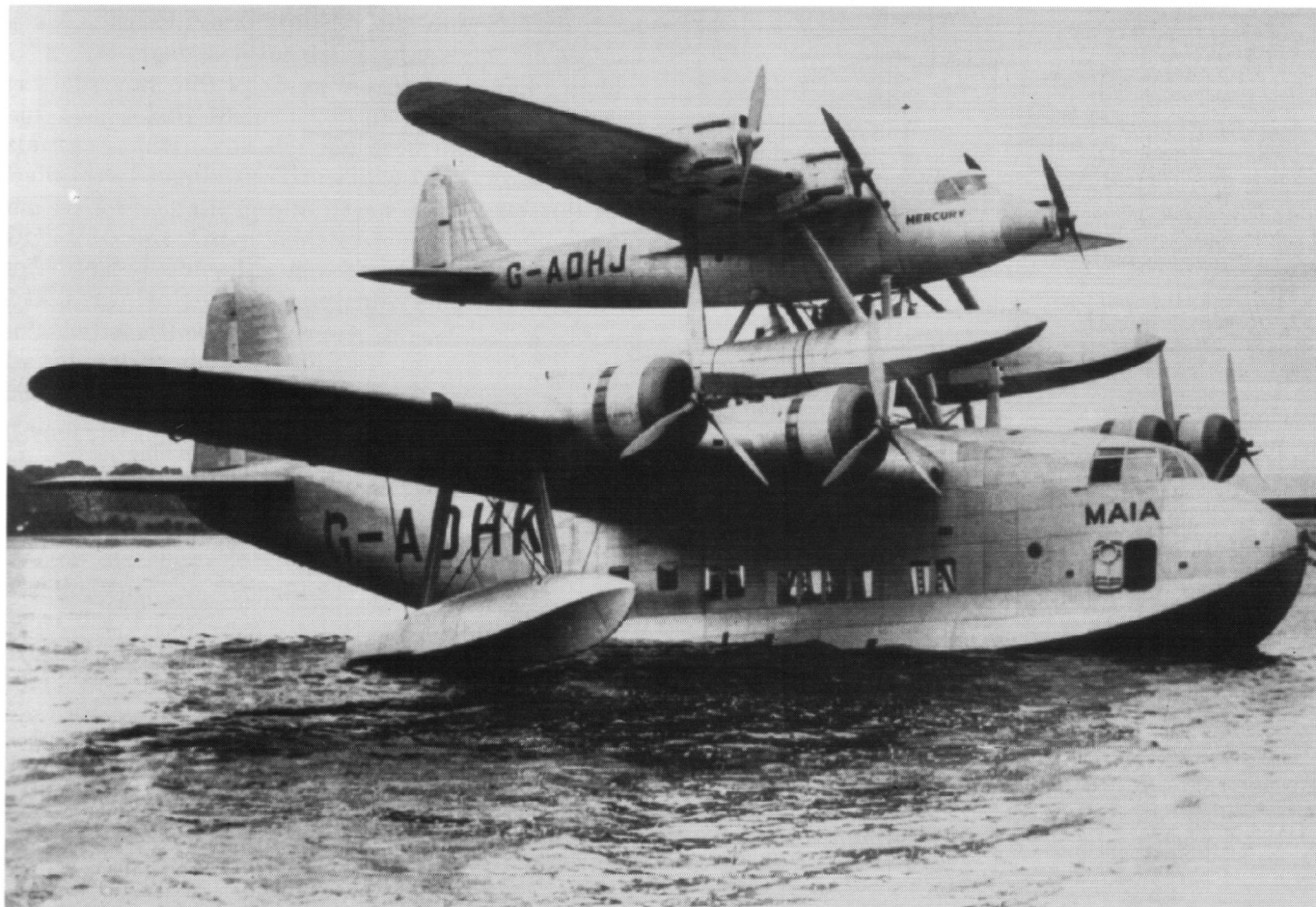
Erstes erfolgreiches Mistelgespann aus England: Short/Mayo Composite von 1937/38. Man erhoffte durch diese Huckepack-Version eine bessere Langstrecken-Bewältigung.
