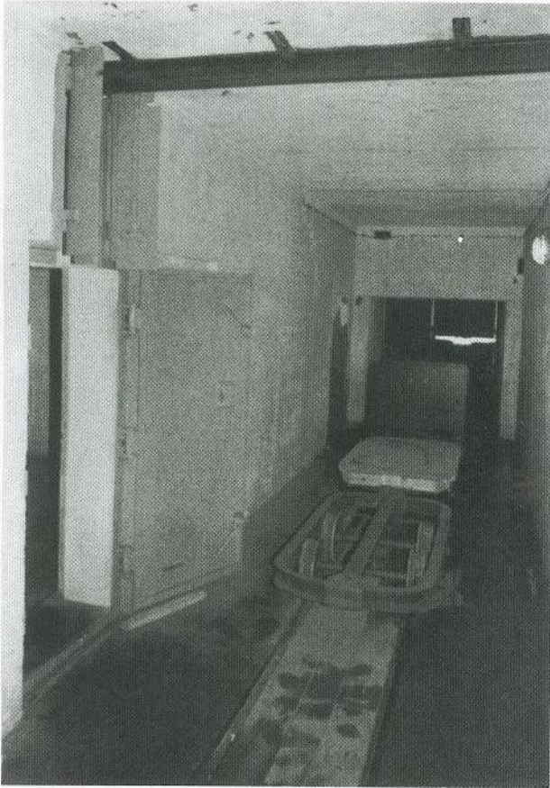
Die Schmalspurbahn im Zufahrtsgang des Bunkers. Mit der an der Decke sichtbaren Schiene der Hän- geförderanlage konnten Munition, Ersatzteile und Betriebsstoffe an Flaschenzügen in jeden Raum befördert werden.
