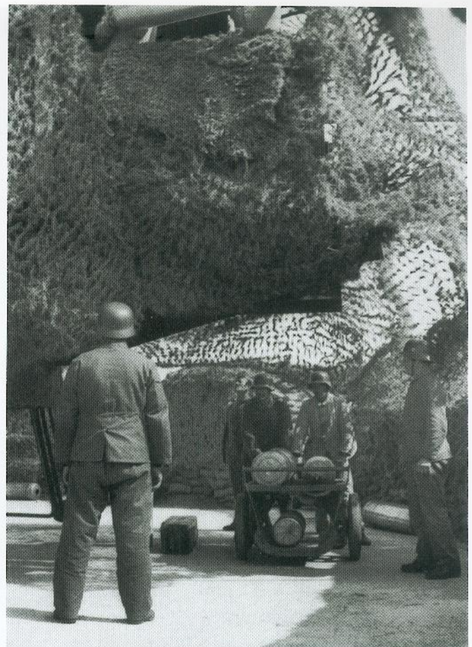
Ein neuer Transportwagen wird unter den Aufzug des Geschützes gefahren. Neben der Granate liegt die Hauptkartusche mit 89,9 kg Pulver, darunter die Vorkartusche mit 67,1 kg. Beide entsprachen einer vollen Ladung von 149 kg Pulver. (BA)
