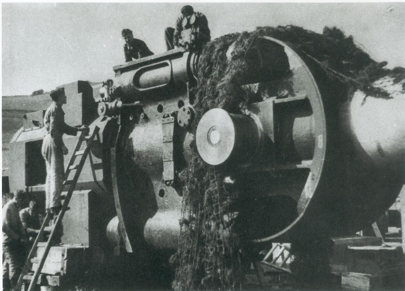
Oben: Dieses Foto zeigt die gewaltigen Ausmaße der 40,6 cm C/34. In der Bildmitte ist der Schildzapfen zu sehen, mit dem das Rohr in der Rohrwiege des Bettungsschießgerüsts C/39 verankert wurde. (BA)
