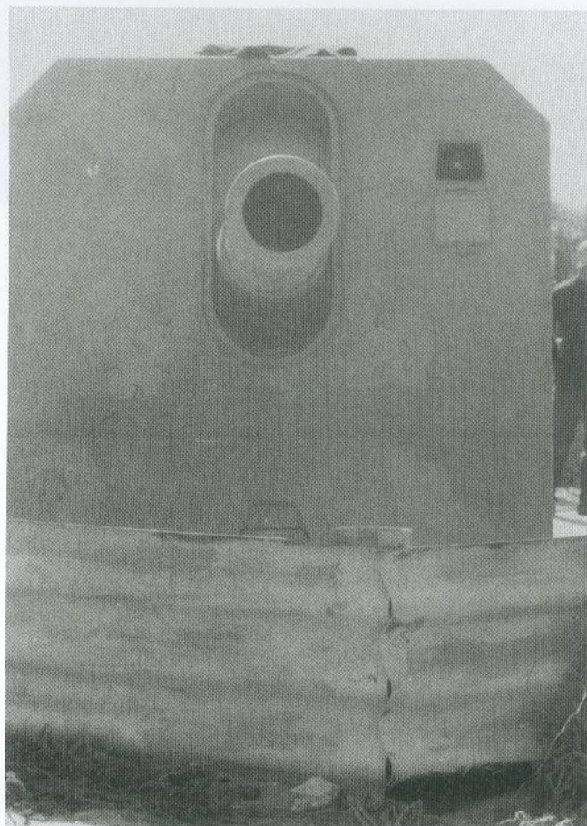
Oben: 15 cm SK C/28 der Batt. MI. Gut zu erkennen ist die 10 cm starke Frontpanzerung des Turmes, die Klappe des Zielfernrohres ist geöffnet. Mit diesem konnte der Richtkanonier die Trefferlage beobachten.
