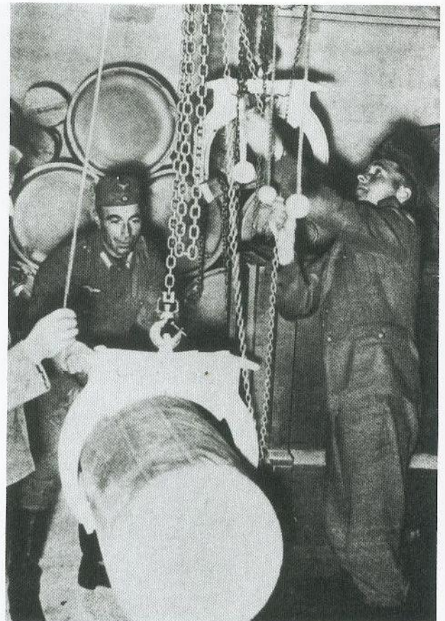
Eine 101 kg schwere Vorkartusche wird im Pulver- raum verstaut.
