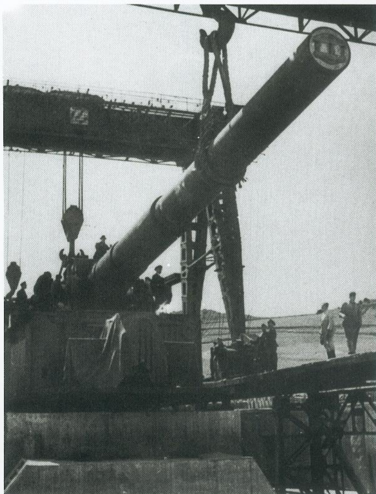
Oben: Dieses Foto zeigt die gewaltigen Ausmaße der 40,6 cm C/34. In der Bildmitte ist der Schildzapfen zu sehen, mit dem das Rohr in der Rohrwiege des Bettungsschießgerüsts C/39 verankert wurde. (BA)
