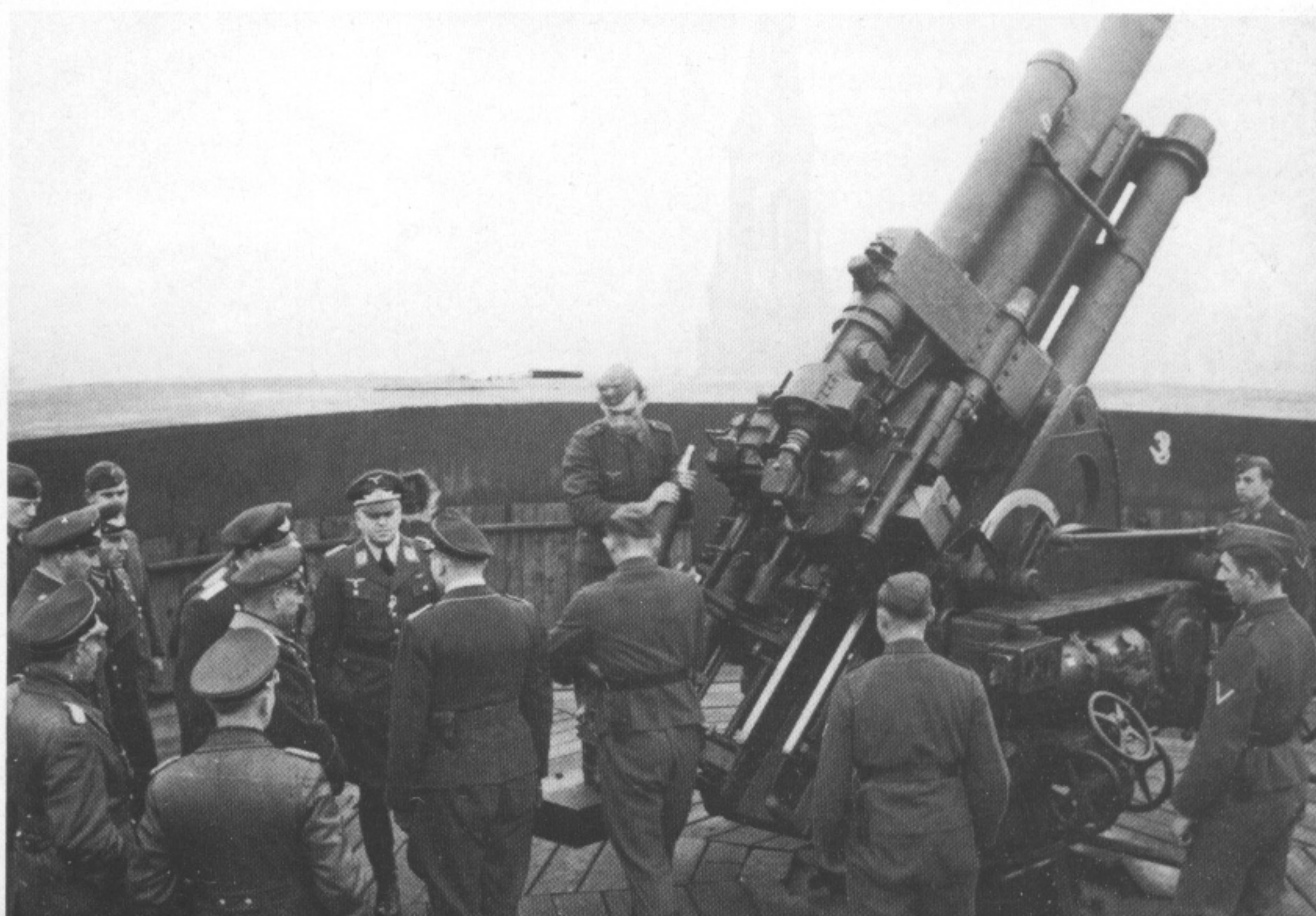
Zwei Bilder einer 10,5-cm-Batterie auf dem Flak-Turm Humboldthain in Berlin. Sie wird hier von in- und ausländischen Offizieren besichtigt. Auf dem G-Turm Humboldthain wurde später ebenfalls eine 12,8-cm-Zwillingsflak aufgestellt. Auffallend ist die primitive Holzabdeckung der Munitionsnischen.
