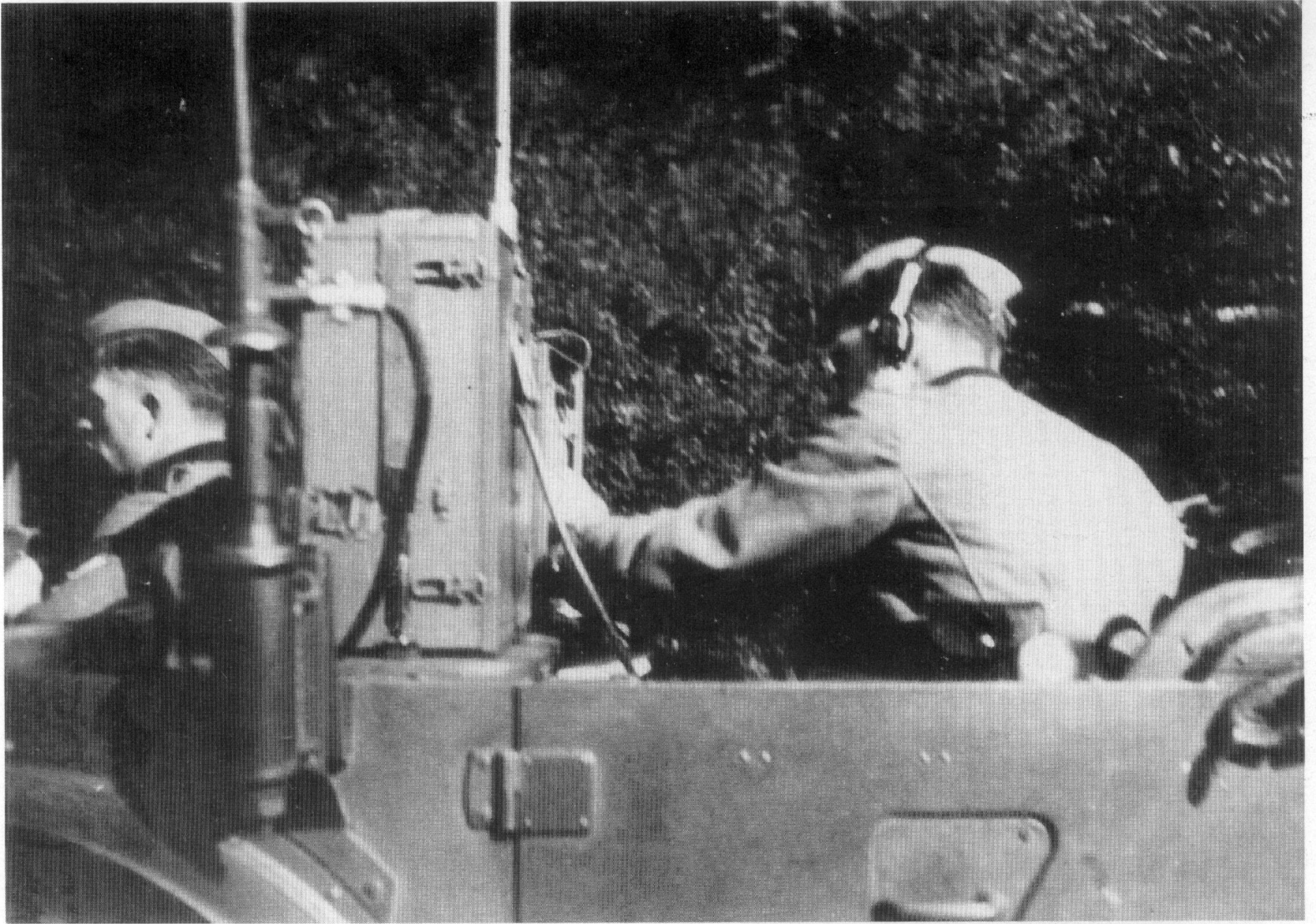
Die motorisierten Funktruppe des Heeres waren hauptsächlich mit kleinen oder leichten Funkkraftwagen (Kfz. 2 ) und mittleren geländegängigen Pkw. (Kfz. 15) ausgerüstet. Weiterhin waren für den Funkbetriebsdienst besonders ausgestattete mittlere PKW (Kfz. 17) im Bestand der Wehrmacht.
