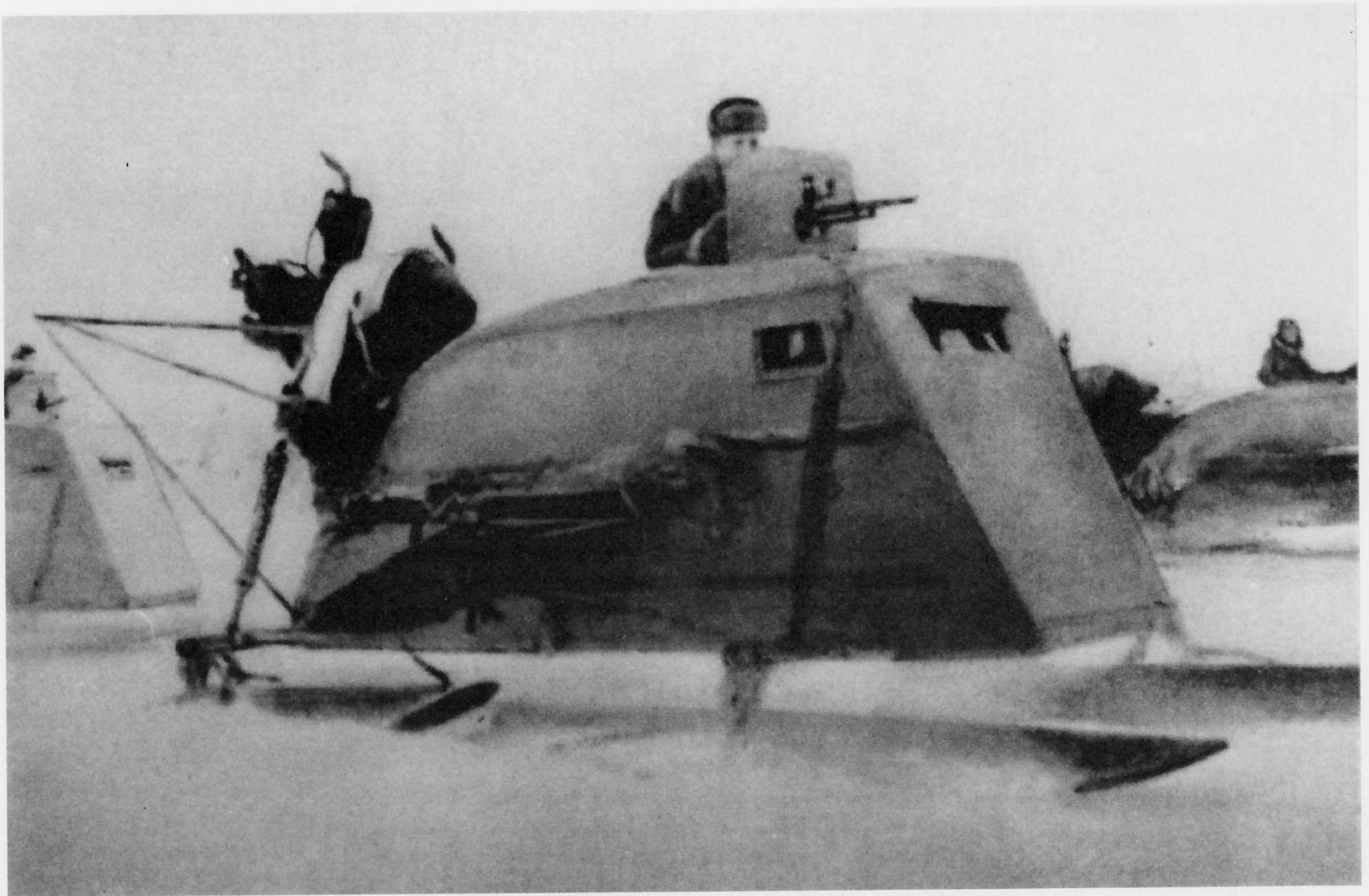
Die auf deutscher Seite eingesetzten Motorschlitten hatten ihren Ursprung in den russischen Vorbildern. Russische Motorschlitten wurden bereits im 1. Weltkrieg eingesetzt. Hier ist es ein NKL-26 mit einem MG auf einer drehbaren Lafette, der ab 1941 produziert wurde
