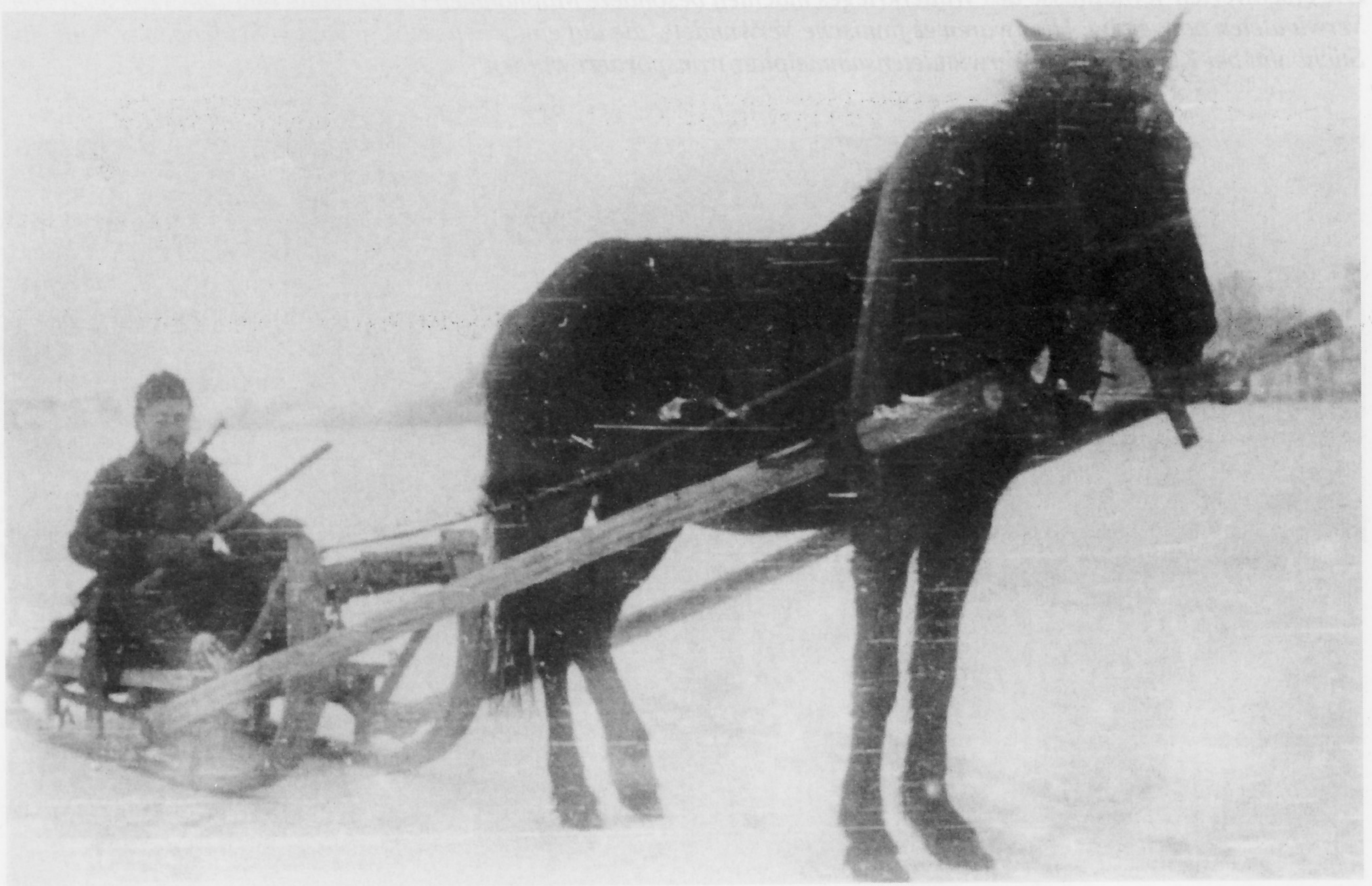
Auch hier handelt es sich um einen selbstgebauten Pferdeschlitten, der seinem Zweck als Kurierfahrzeug vollauf entsprach. Vieltausendfach wurden diese Schlitten in den Winterkriegen von den Holzhandwerkern unter den deutschen Soldaten in eigener Regie angefertigt.
