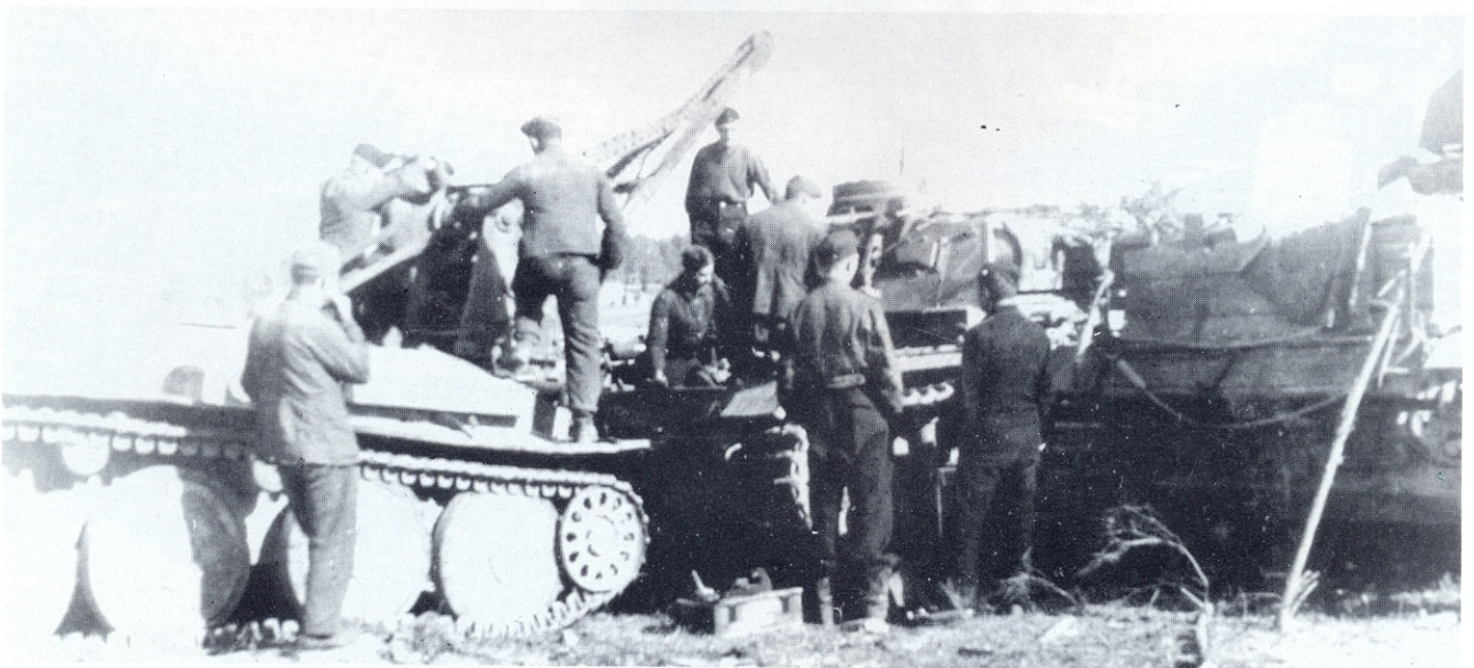
Einige Panzerkampfwagen 38(t) sind zu Bergepanzern umgebaut worden. Die turmlosen Fahrzeuge erhielten einen Kranausleger und eine Winde. Diese Abbildung zeigt die Verwendung eines Bergepanzers beim Motorwechsel an einem Panzerkampfwagen III.
