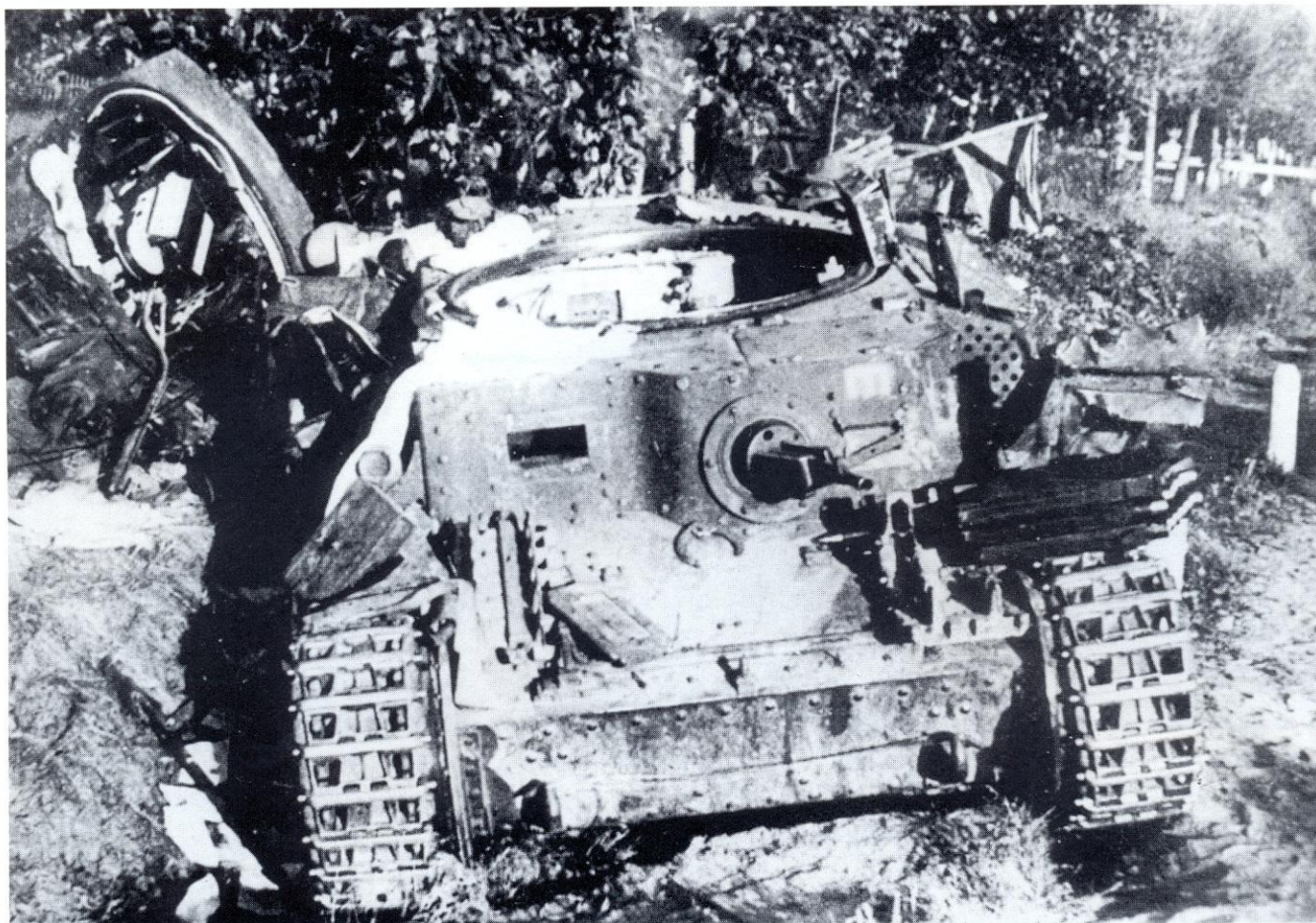
Dieser Panzerkampfwagen 38(t) (3,7-cm). Ausführung B hatte ebenfalls zum Bestand des Panzerregiment 21(20.Panzerdivision) gehört. Ein schwerer Artillerietreffer hat den Drehturm abgerissen. Die Aufnahme entstand Mitte Juli 1941 in der Nähe von Witebsk.
