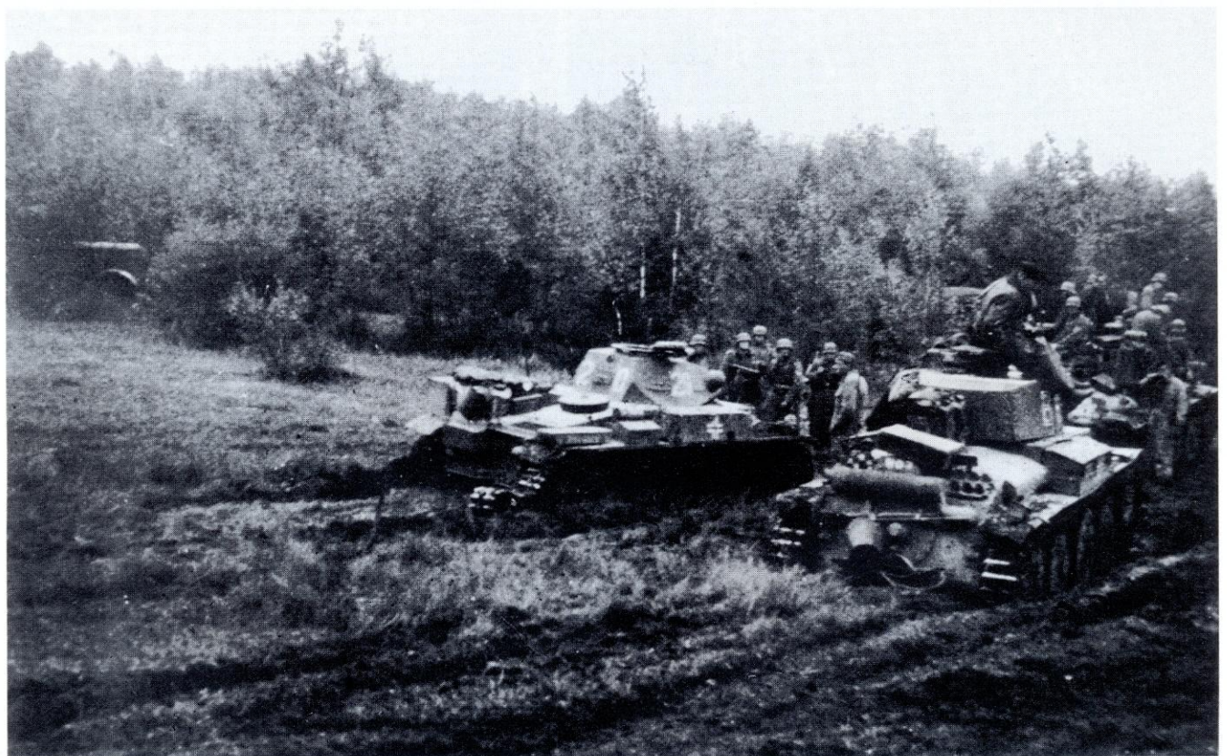
Vorbereitungen zum Bergen eines Panzerkampfwagen II(2-cm) (Sd.Kfz. 121), Ausführung A-C, der im schweren Gelände die Kette geworfen hat. Scheinbar mühelos umfahren die Panzerkampfwagen 38(t) (3,7-cm) den festgefahrenen Panzer.
