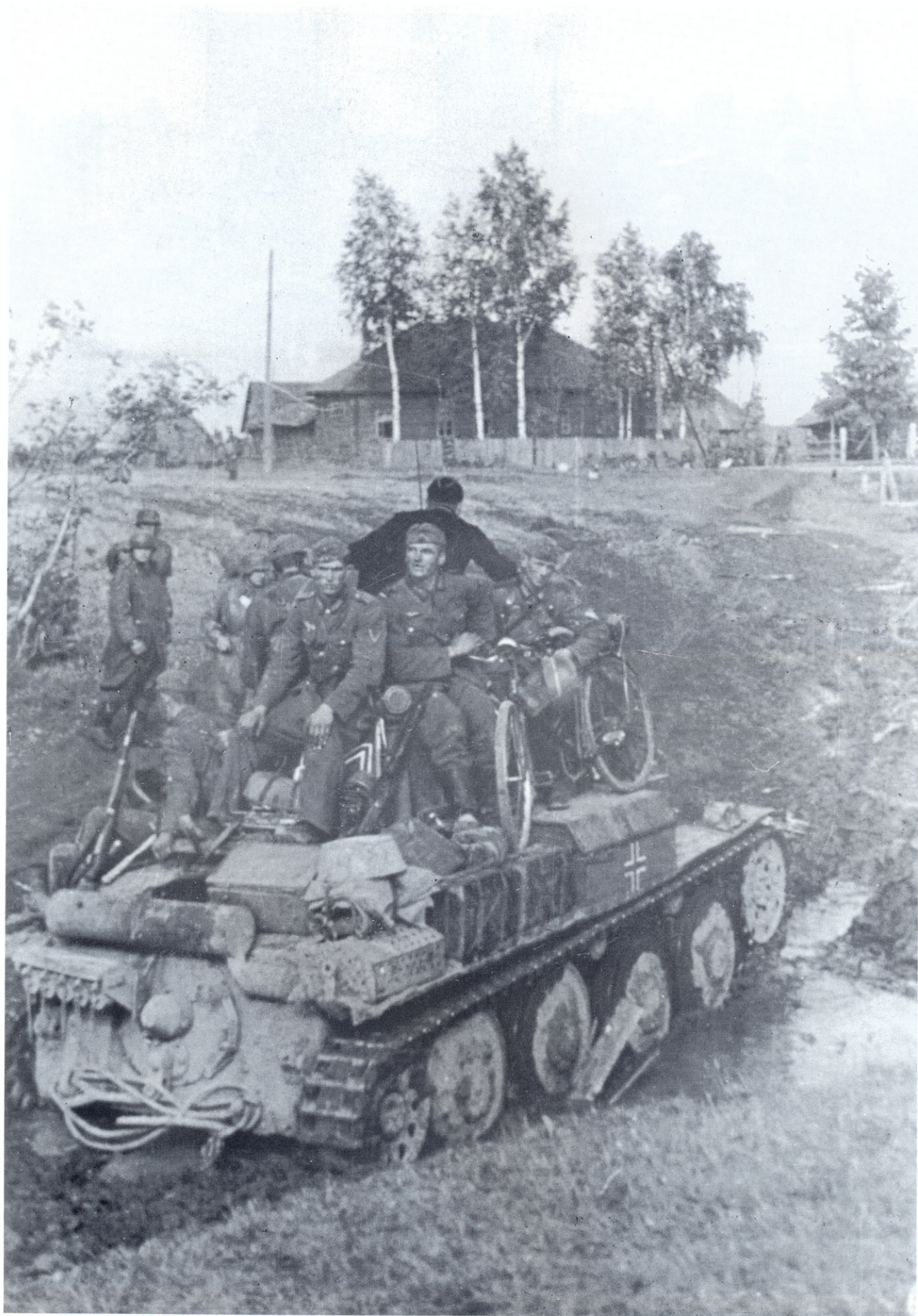
Diese Aufnahme entstand im Spätsommer 1941 an der Ostfront. Beachte die Halterung für die Nebelkerzen am Wannendeck des Panzerkampfwagen 38(t) (3,7-cm).
