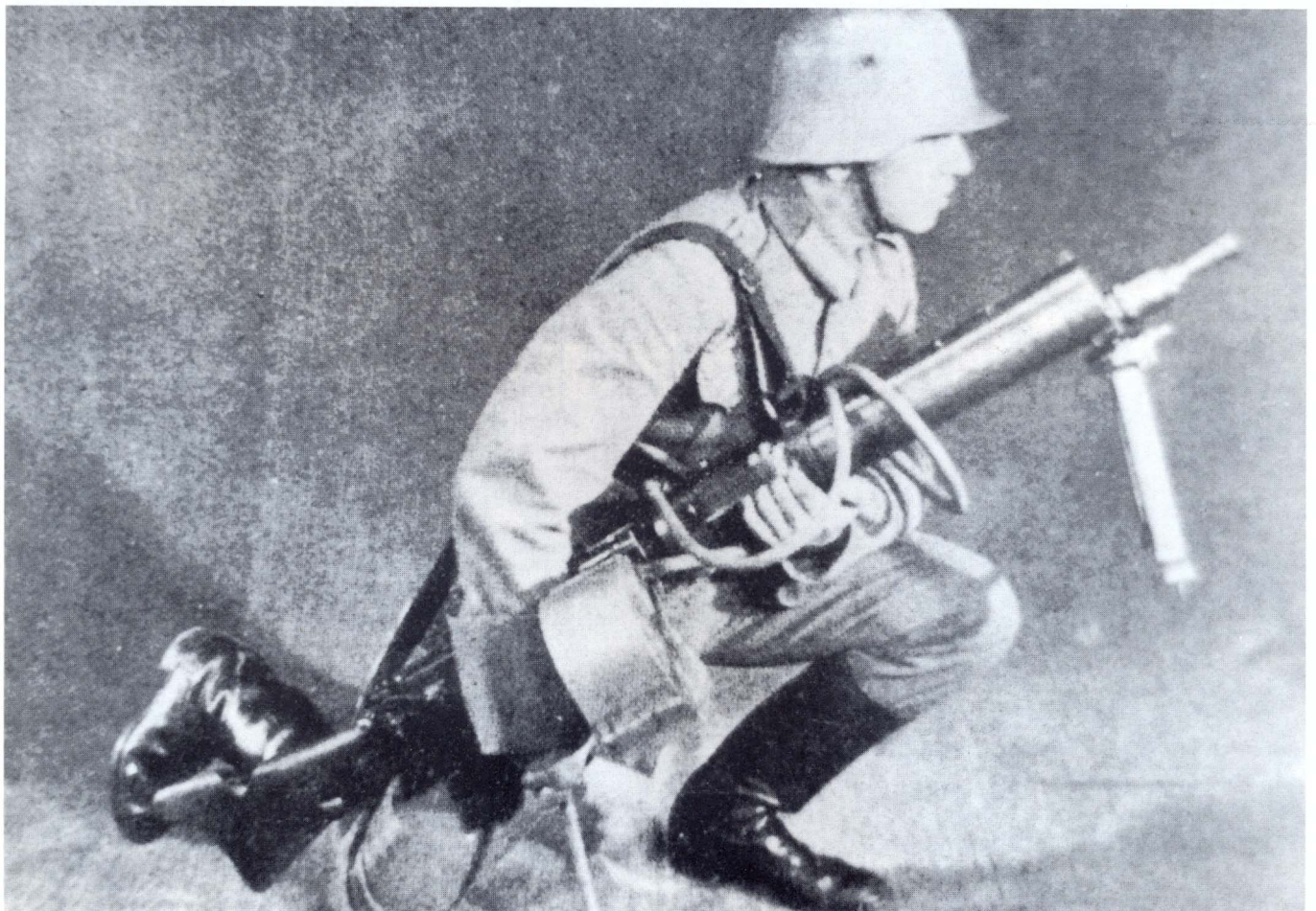
„Der Schütze im Vorwärtsstürzen“ „Das M.G. wird so vor dem Körper getragen, daß es vom Gegner nicht als solches erkannt wird“ Beachte Gabelstütze, Gurttrommel (Patronenkasten 16), Dampfablaßschlauch
