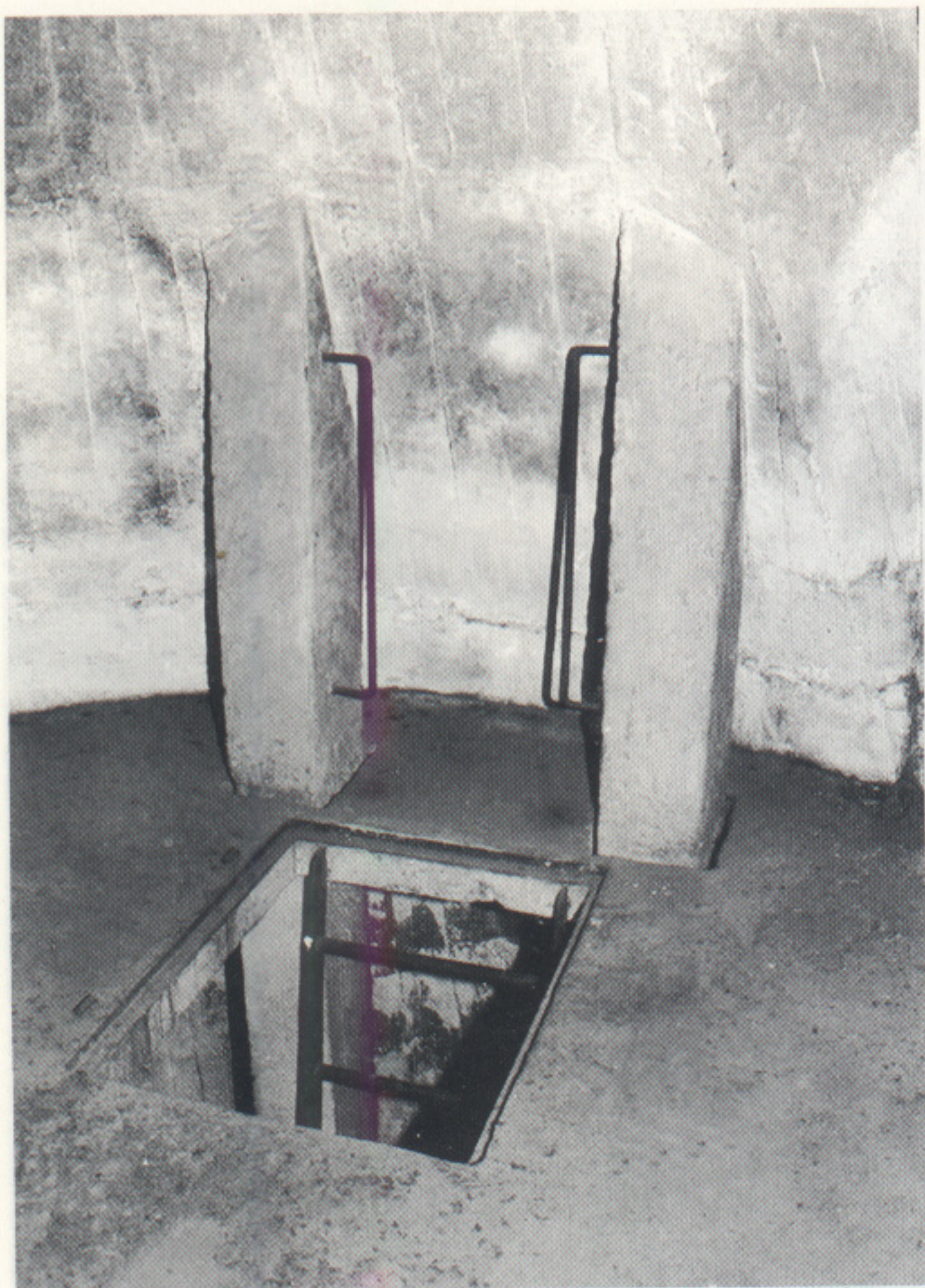
Deckenöffnung zu obersten (8.) Stockwerk, Platz der Turmbeobachter. Rechts: Sehschlitz für den Turmbeobachter und Abluftrohr
