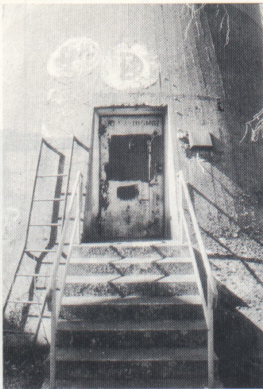
Links: eiserne Steigleiter zum zugemauerten 1. Obergeschoss (Wünsdorf). Mitte: Winkel-Turm in Gießen, von den US-Truppen genutzt und mit einem gelben D bezeichnet. Die Betonstufen sind nach 1945 gebaut worden. Rechts: von den Russen gebaute Steigleiter mit Geländer am Winkelturm Nr.12 in Wünsdorf.
