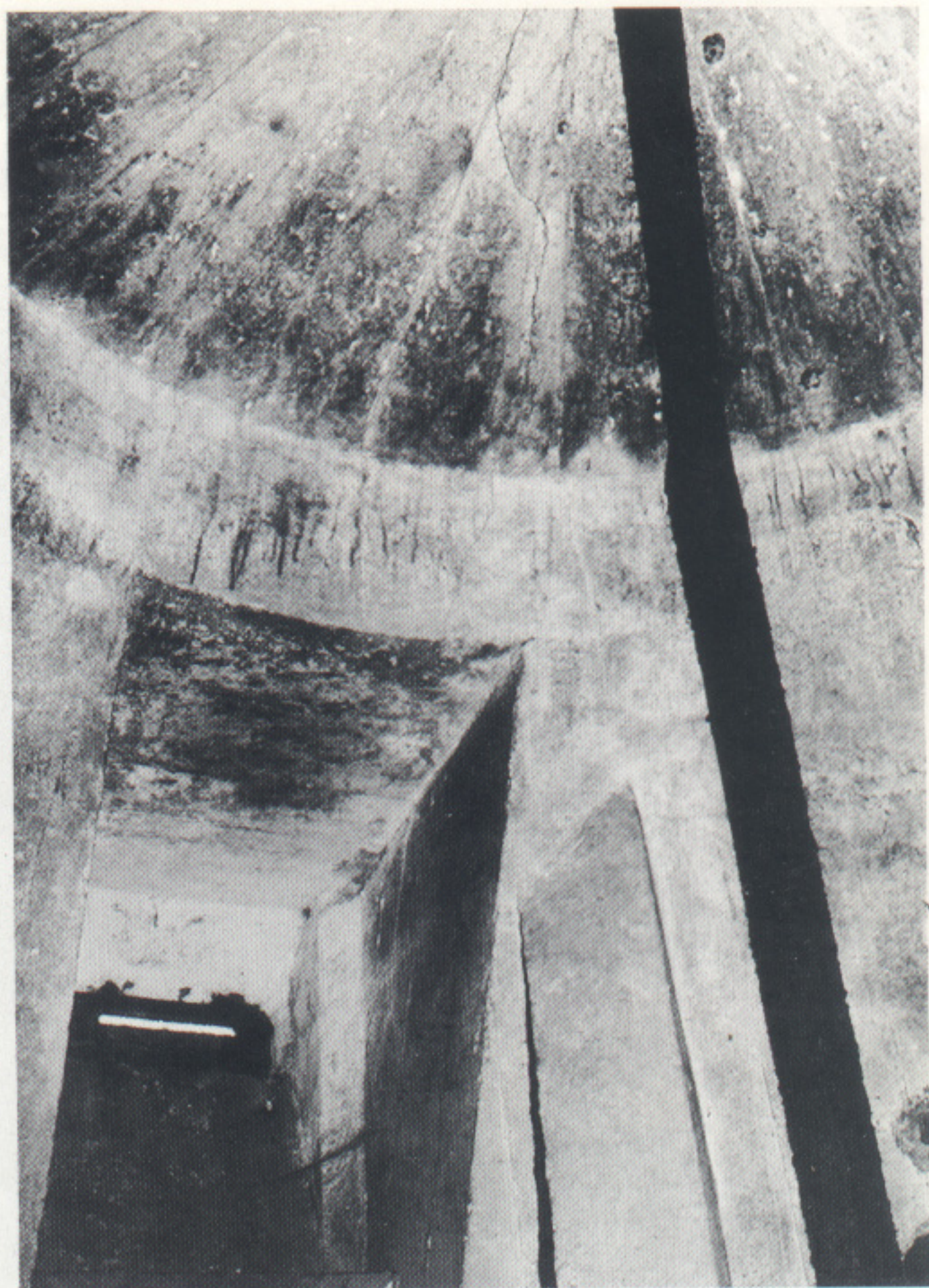
Deckenöffnung zu obersten (8.) Stockwerk, Platz der Turmbeobachter. Rechts: Sehschlitz für den Turmbeobachter und Abluftrohr
