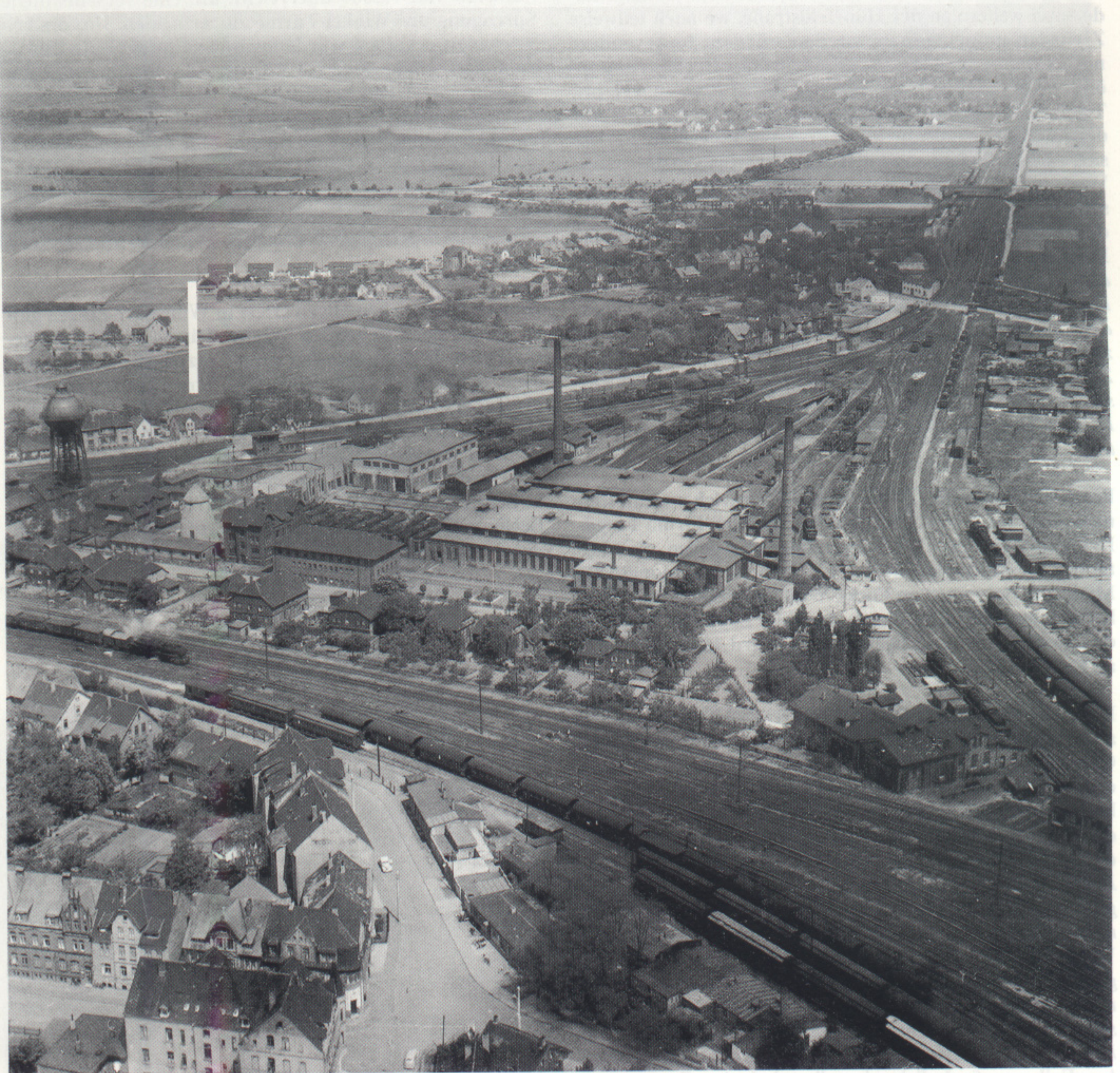
Luftbild vom Verschiebebahnhof (Gleisdreieck) Lehrte mit einem Winkel-Turm 2 c (Pfeil) © Stadtarchiv Lehrte
