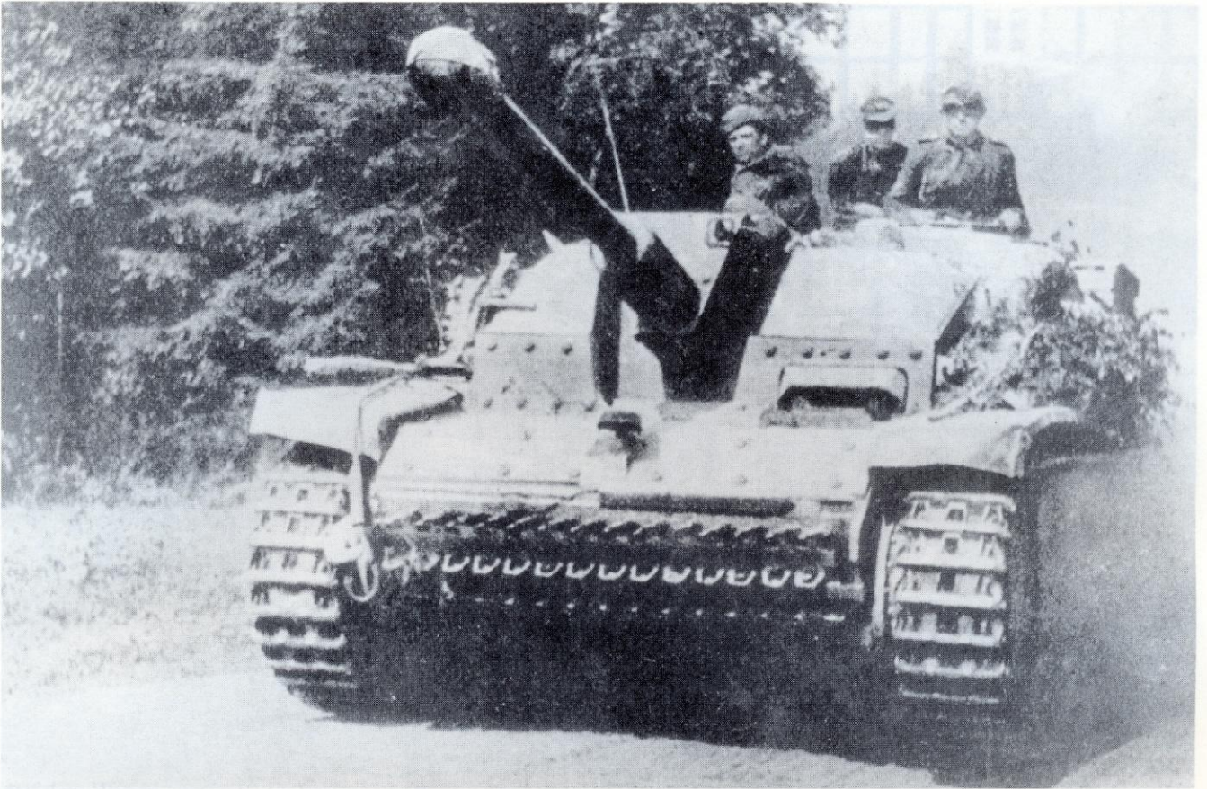
Beachte die aufgeschraubte Zusatzpanzerung am Wannenbug und der Fahrerfront. Der obere abgeschrägte Teil des Panzeraufbaus ist mit Beton verstärkt. Die Aufnahme entstand im Sommer 1944 im Nordabschnitt der Ostfront.
