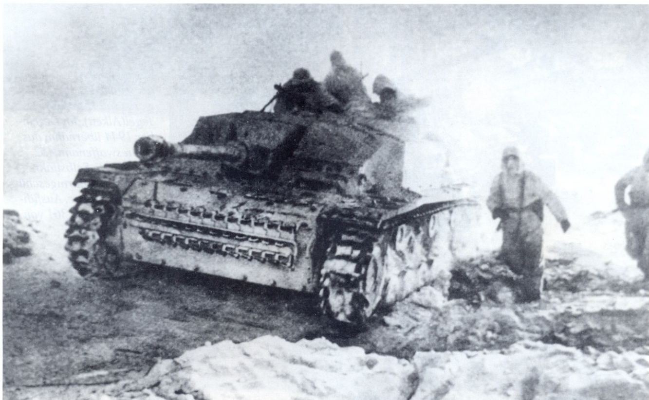
Oben: Eine gepanzerte Selbstfahrlafette für Sturmgeschütz 7,5-cm-Kanone, Ausführung G aus der Dezember- Fertigung 1942 während der Kämpfe im Süden der Ostfront. Beachte die aufgeschraubte Zusatzpanzerung; noch nicht vorhanden, daß Schutz- schild für das Maschinengewehr vor der Ladeschützenluke.
