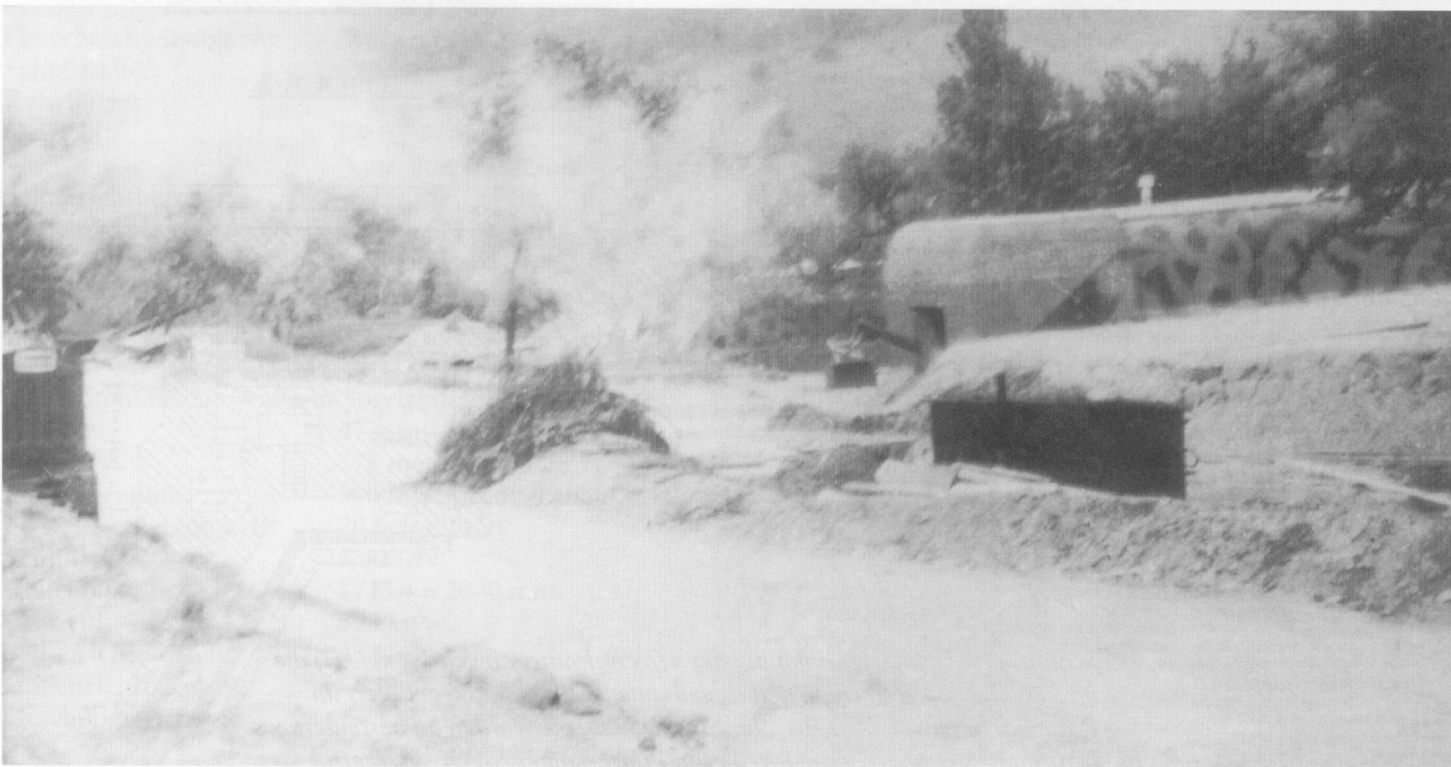
Die kurze und die mittlere 10-cm-Kanone K wurde in Panzerkasematten und in Drehtürmen eingebaut. Regelbau 30 P8, Ausführung A und 31 P8 in Ausführung B.
