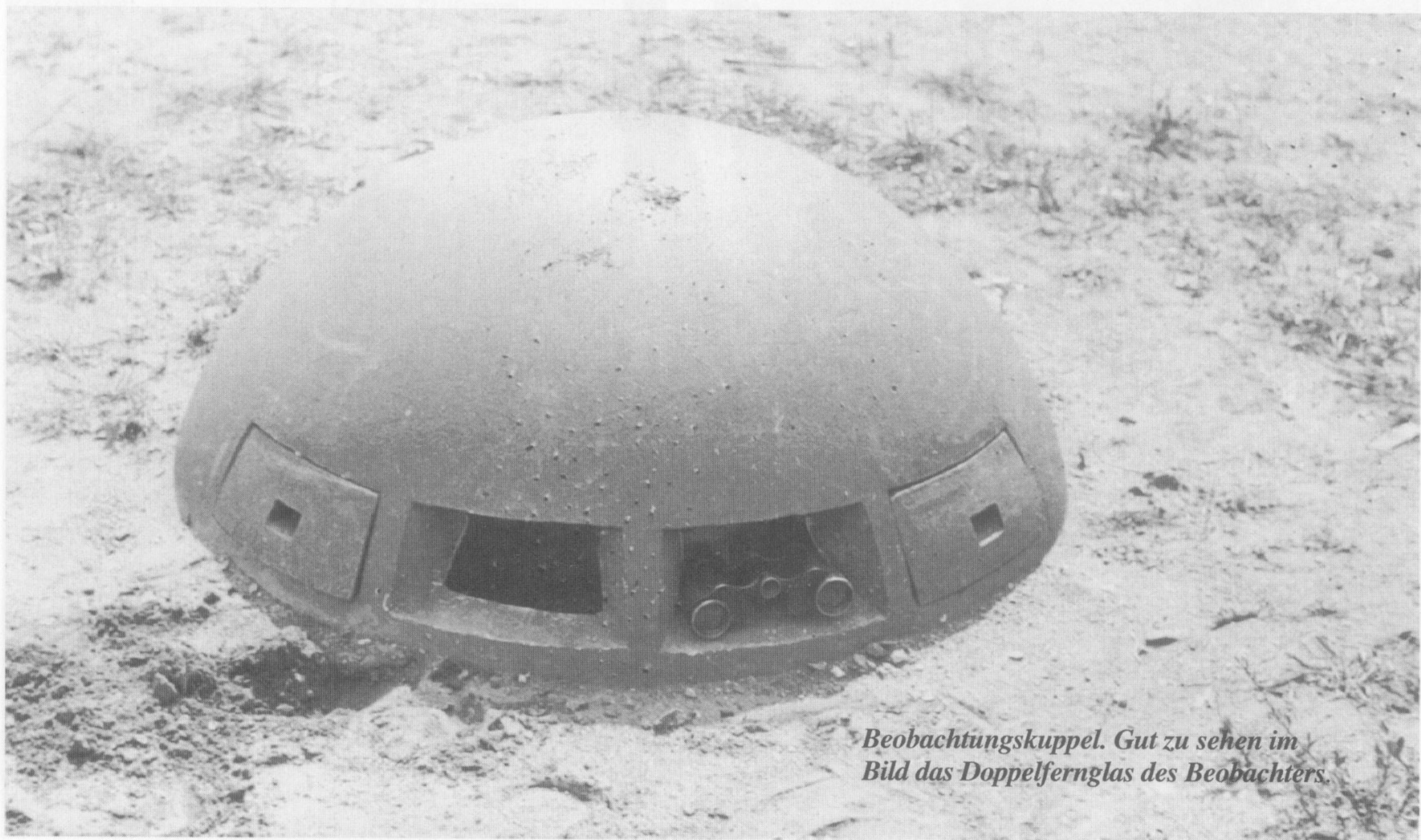
oben: Eine Panzerglocke vor dem Einbau. In den Festungsanlagen wurden verschiedene Panzertürme für die Infanteriebeobachtung eingebaut
