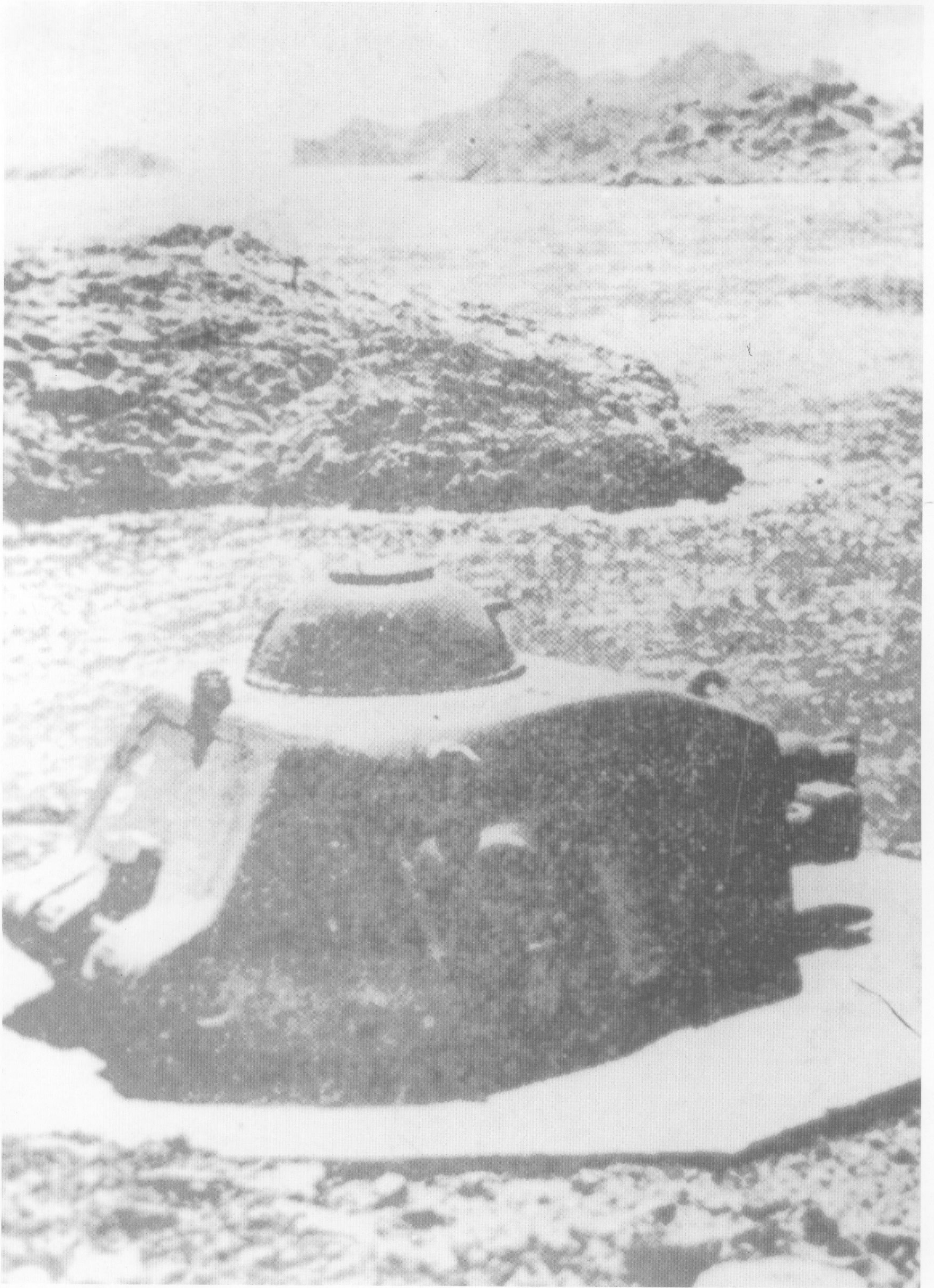
Französischer Panzerturm APX mit einer 3,7-cm-Kanone und einem Maschinengewehr. Mit diesen Türmen waren die französischen Panzer R-35 und H 35 bestückt. Sie wurden in größerer Zahl von deutschen Truppen erbeutet und als Festungspanzerdrehtürme verwendet.
