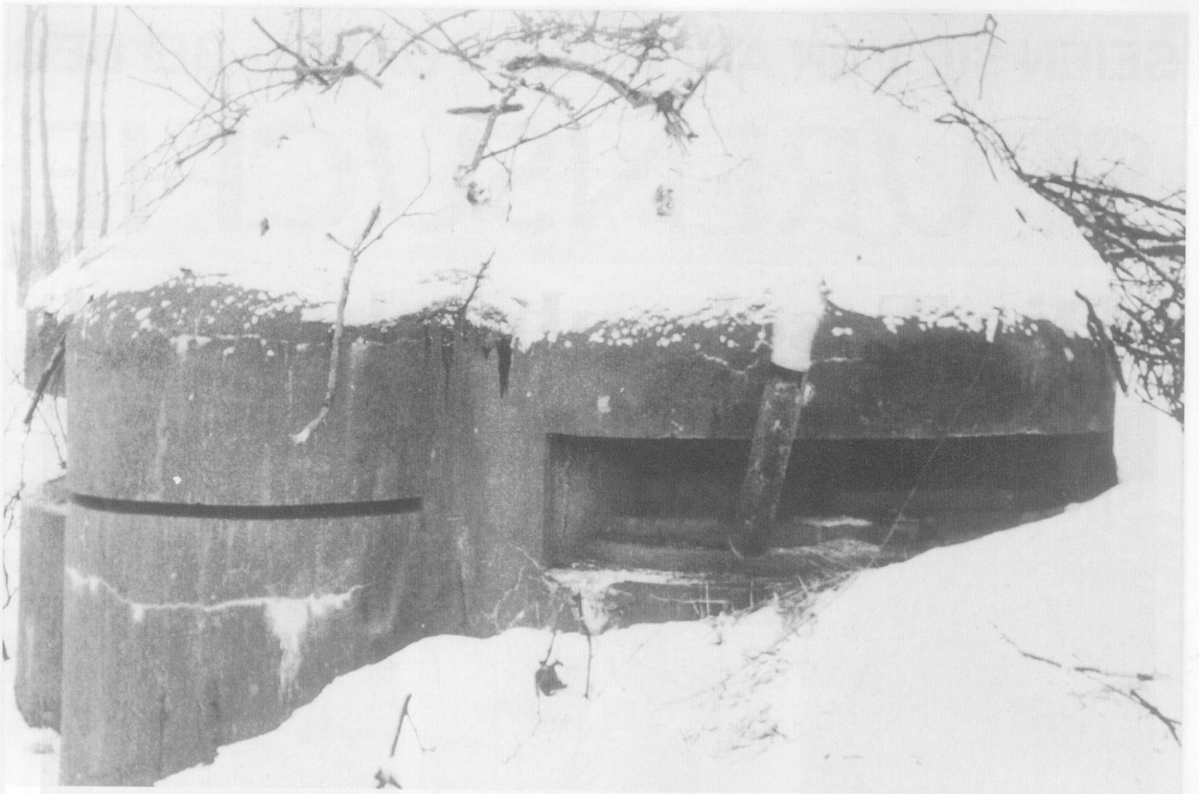
Betonierter Kampfstand im Brückenkopf Colmar. Beobachtungsstand mit Maschinengewehrstand.
