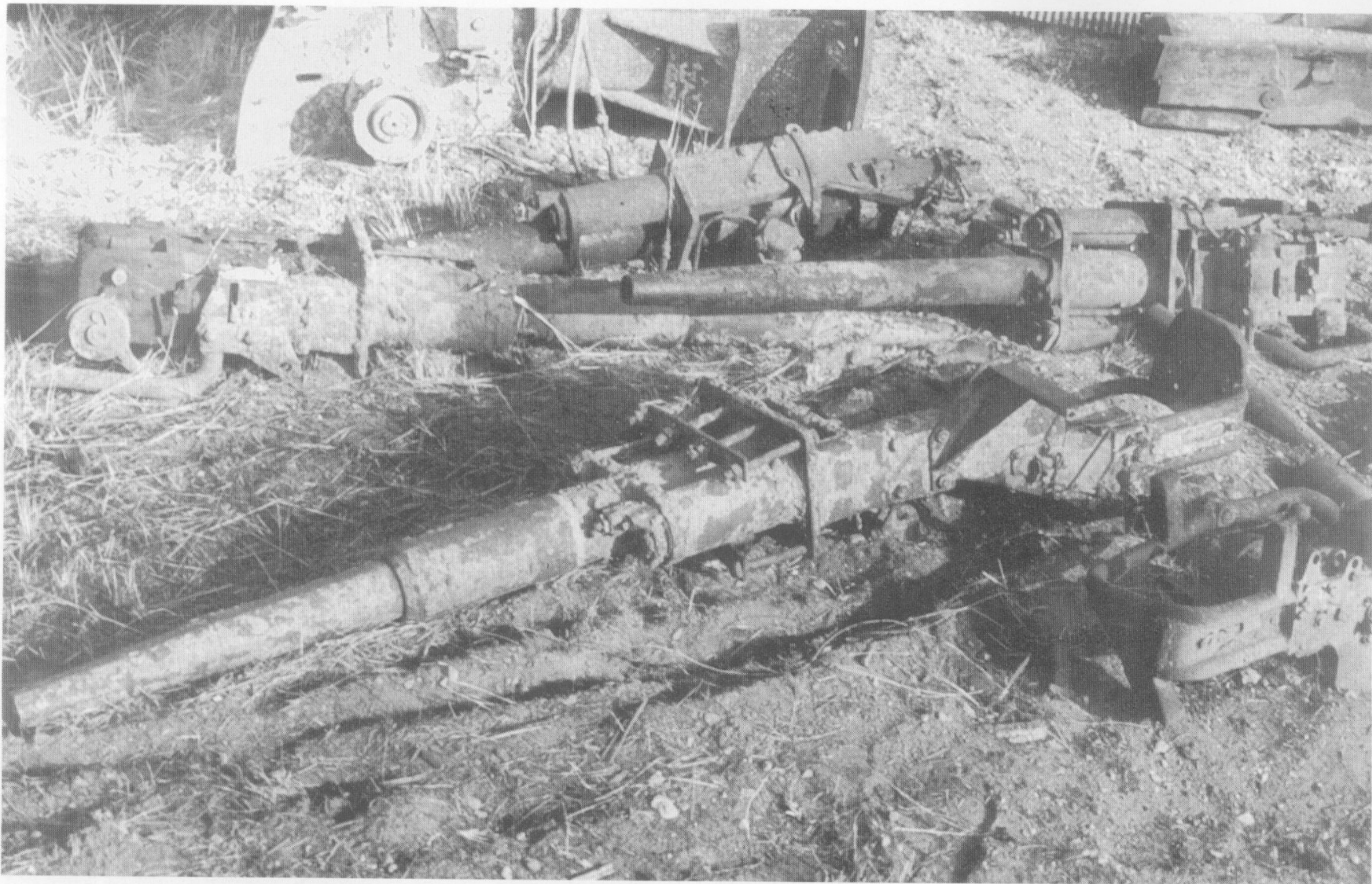
Diese 3,7-cm-Kampfwagenkanone war ursprünglich auf einer Sockellafette montiert und kam zum Kriegsende ebenfalls in Dresden als Panzerabwehrkanone zum Einsatz. Sie wurde in den 80er Jahren im Norden der Stadt geborgen.
