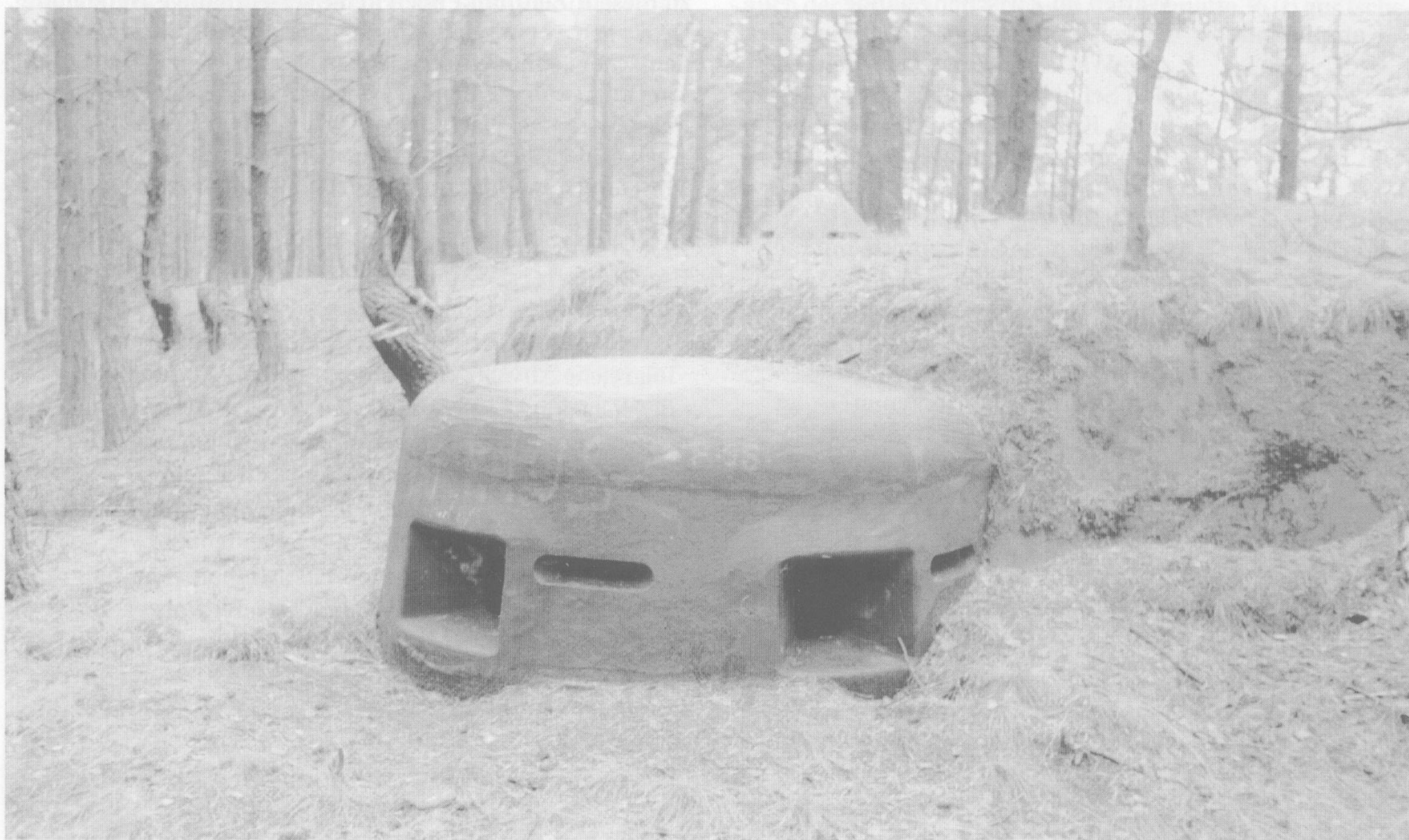
Anfang der 30iger Jahre begann der Ausbau der ständigen Befestigungen im Osten Deutschlands. Hier im Bild ein Dreischartenturm alter Art vom Typ 2P7 in der Panzerstärke B, aus dem Jahr 1936 im Oder-Warthe-Bogen. Diese Aufnahme entstand im Herbst 1997.
