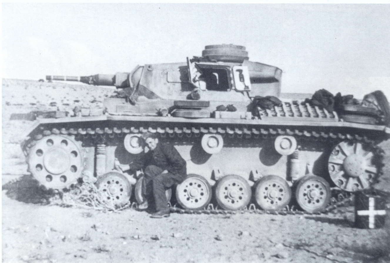
Nachdem der Einbau der 5-cm-Kampfwagenkanone L/42 in den Panzer III begonnen hatte, wurden die Fahrzeuge als G-Ausführung bezeichnet. Gleichzeitig wurde eine neue Kommandantenkuppel aufgebaut. Fahrgestellmäßig änderte sich zunächst nichts. Nach wie vor wurden die 360 mm breiten Ketten mit den gelochten Antriebs- und den Scheiben-Leiträdern verwendet. Panzer III G (Tp) in Nordafrika.
