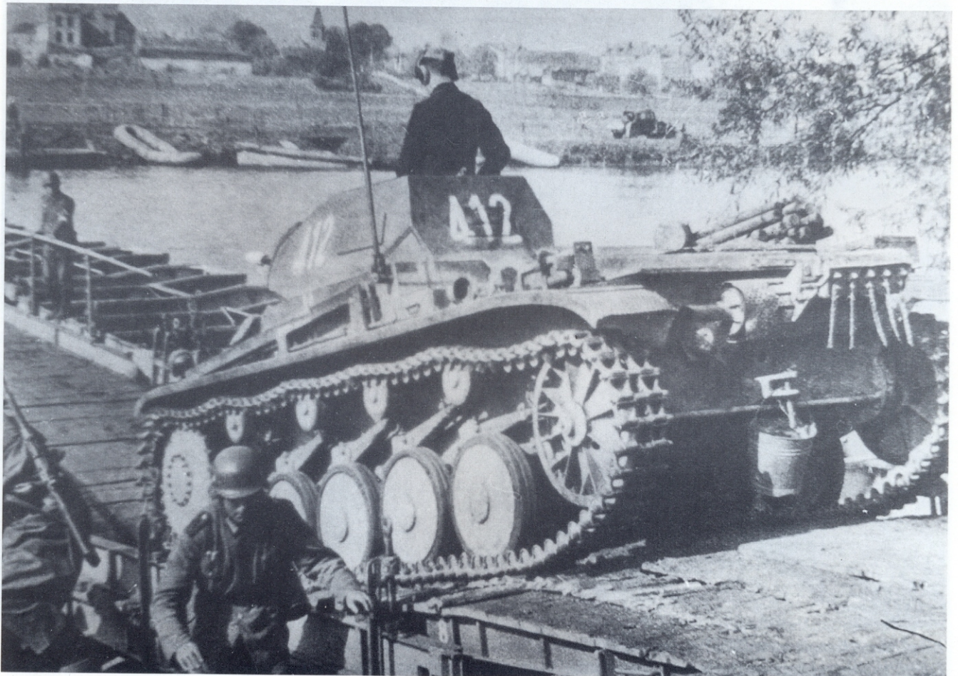
Mit der Einzelaufhängung an Viertelfedern erhielten die Panzer II ab 1937 ein leistungsfähiges Laufwerk. Panzerkampfwagen II Ausführung c bei der Ausbildung und (unten) beim Überqueren der Maas in Frankreich, Mai 1940.
