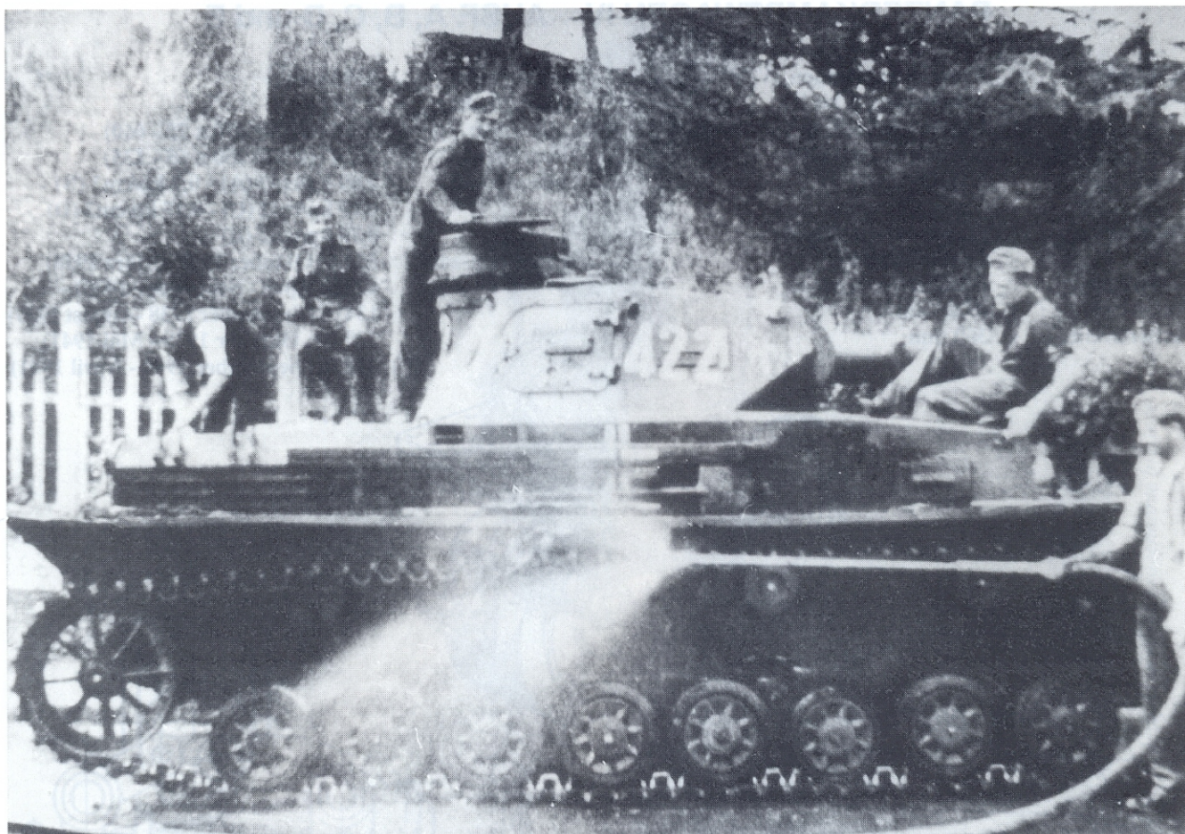
Als Unterstützungsfahrzeug für die schwächer bewaffneten Panzer wurde der Panzerkampfwagen IV mit 7,5-cm-Kampfwagenkanone 37 L/24 eingeführt. Erkennbar an den acht Laufrollen.
