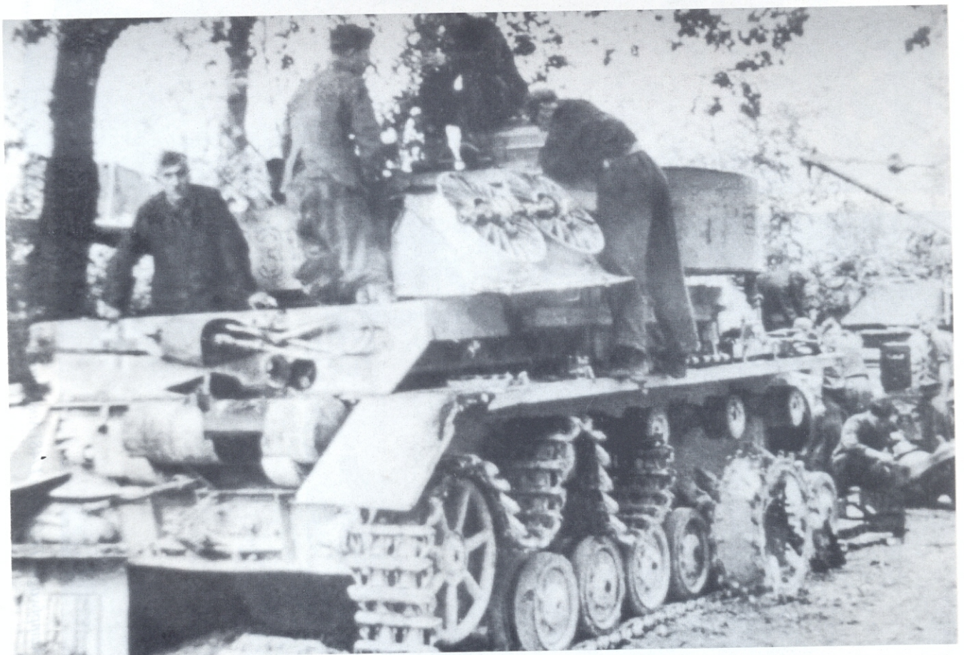
Feldinstandsetzung mit Auswechseln der Antriebsräder und Reparatur des Antriebsaggregats bei einem Panzerkampfwagen IV (7,5 cm L/48) Ausführung H (Sd.Kfz. 161/2) in Nordfrankreich 1944.
