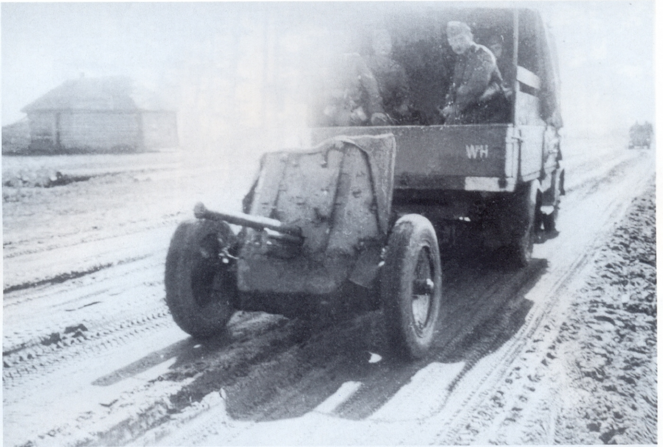
Sommer 1941 an der Ostfront. Als Zugmittel für die 3,7-cm-Panzerjägerkanone diente hier ein leichter Lastkraftwagen 1,5 t (4x2) Opel-Blitz 2,5-32. Beide, Zugmittel und Geschütz, genügten zu diesem Zeitpunkt nicht mehr den Anforderungen.
