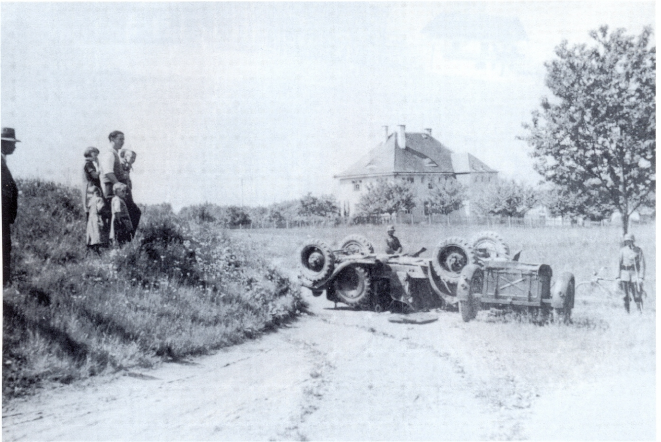
Ein Kfz. 12 mit Sonderanhänger ist während eines Manövers in der zweiten Hälfte der 30er Jahre verunglückt. Auf dem Anhänger wurden mitgeführt: ein Ergänzungskasten, 180 Panzergranatpatronen und 36 Sprenggranatpatronen.
