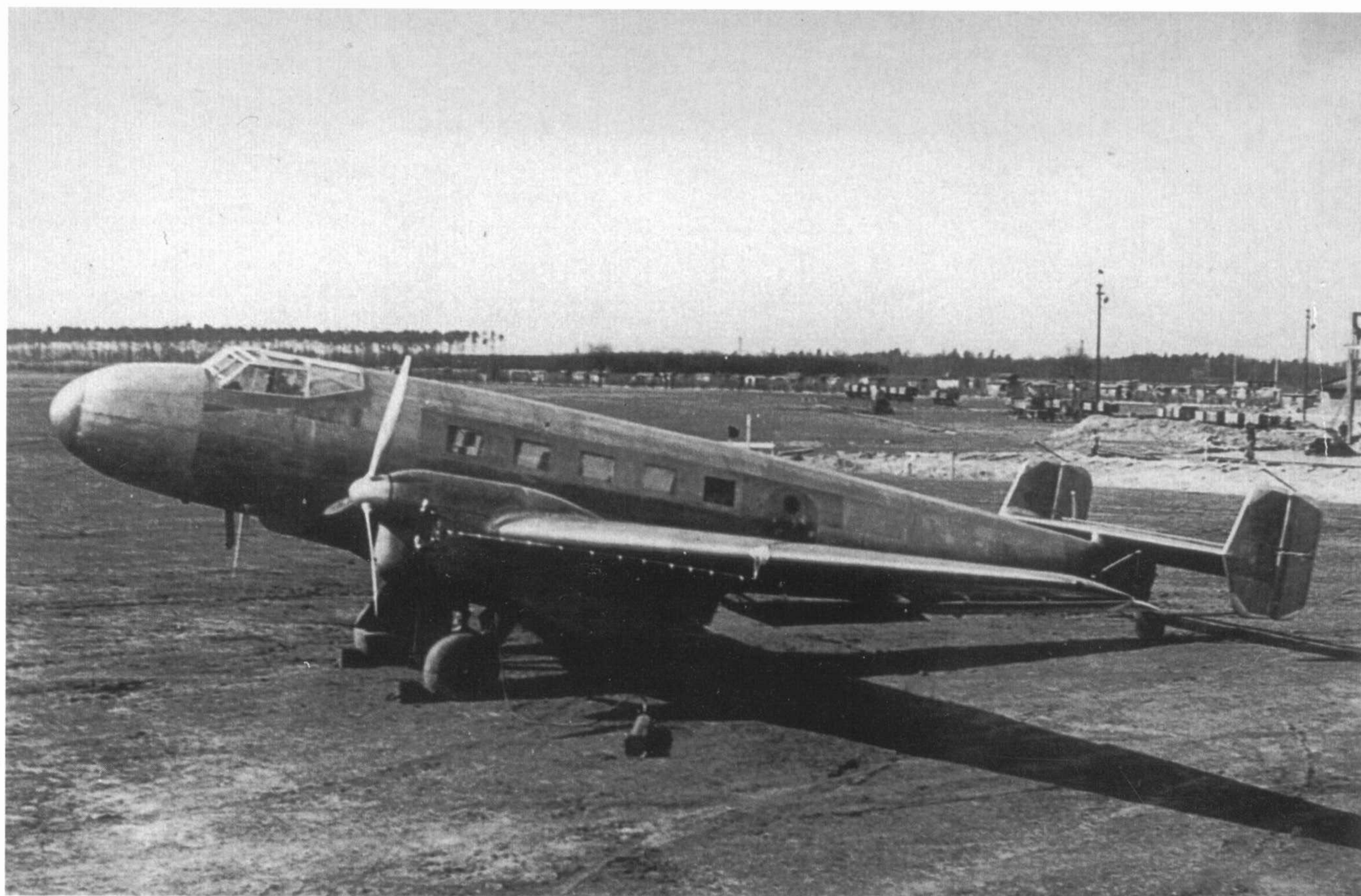
Musterflugzeug zur Erprobung neuer Jumo 205-Motorenausführungen.
