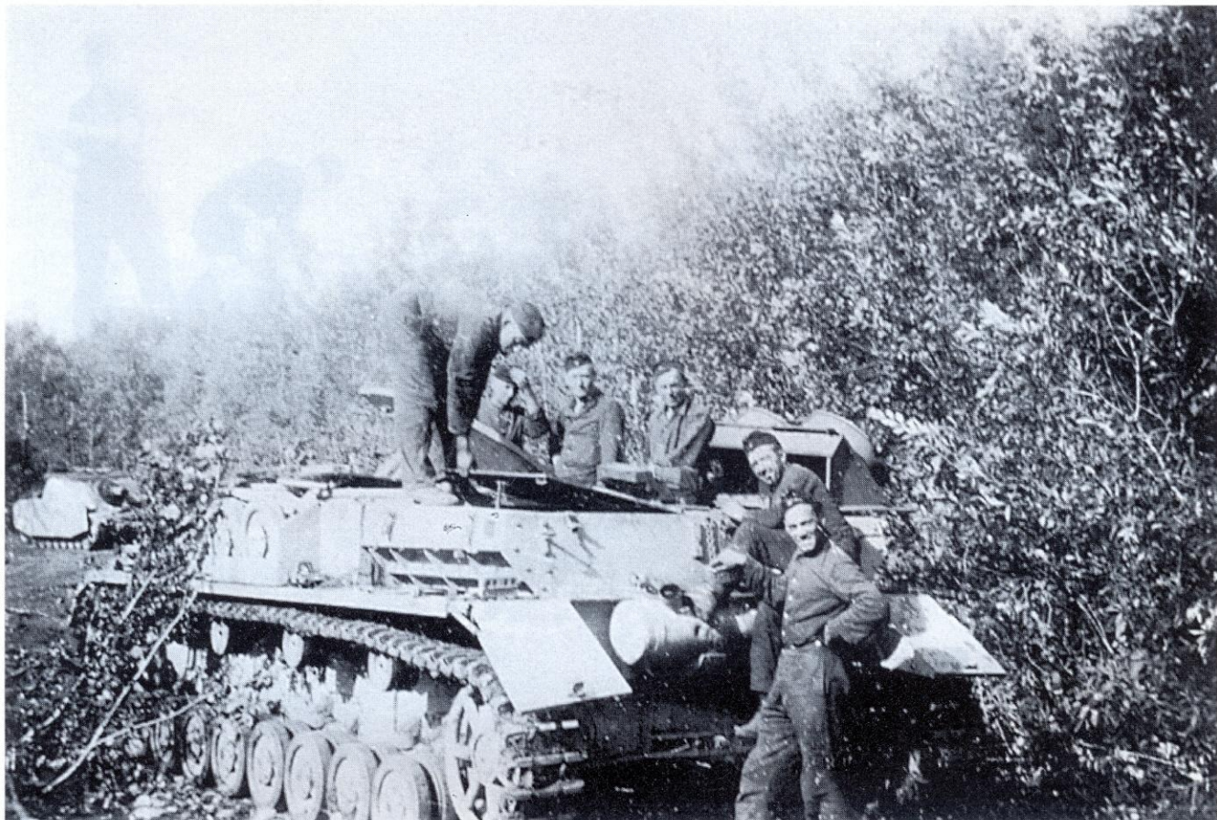
Oben und unten: Die Sturmpanzer-Abteilung 216 hatte von Mai 1943 bis 1944 mehrere Panzerkampfwagen IV - Fahrge- stelle, die als Munitionsträger eingesetzt wurden. (Fotos KHM via G. Taute [oben] und H. Herzle [unten])
