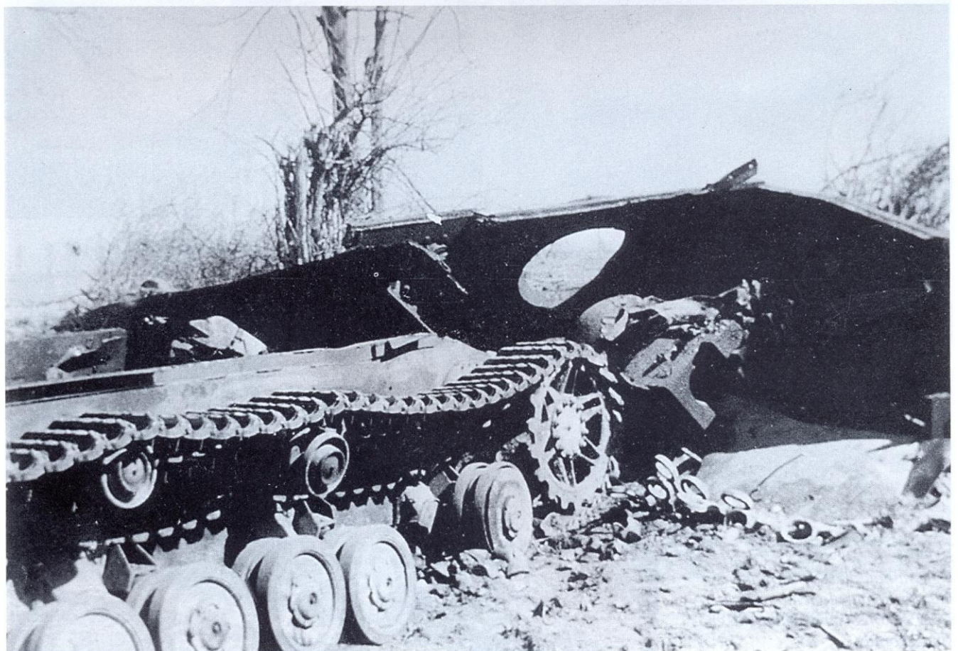
Anfang 1945 erhielt die Sturmpanzer-Abteilung 219 größere Mengen fehlerhafter Munition. Die Granate explodierte beim Abschluß, zerstörte das Fahrzeug und tötete jeweils die Besatzung.
