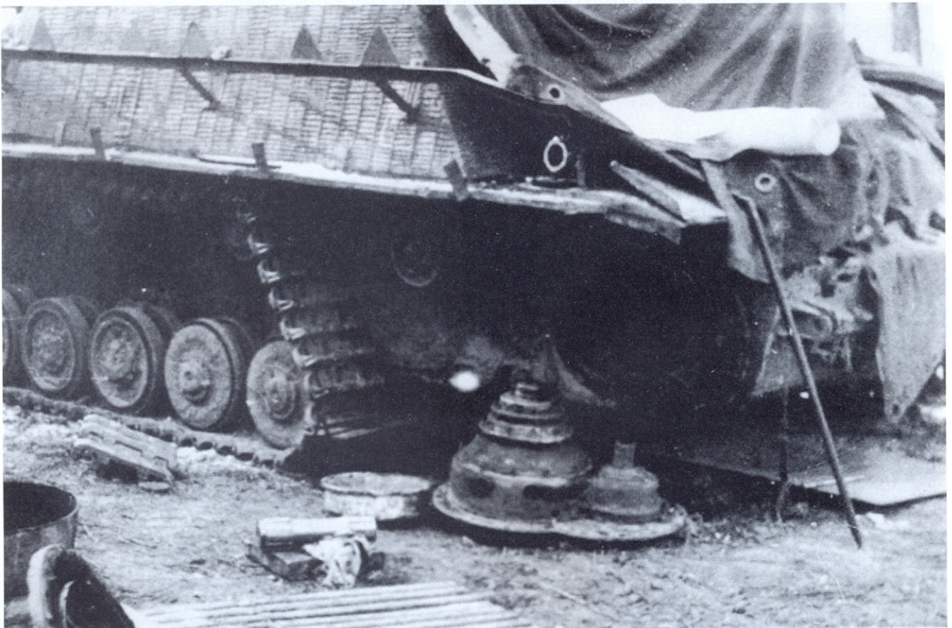
Auch bei der späten Ausführung des SdKfz 166 konnten die Mängel mit den Seitenvorgelegen nicht abgestellt werden. Bei diesem Sturmpanzer 43 sind die beiden vorderen Rollenwagen mit Stahllaufrollen ausgerüstet.
