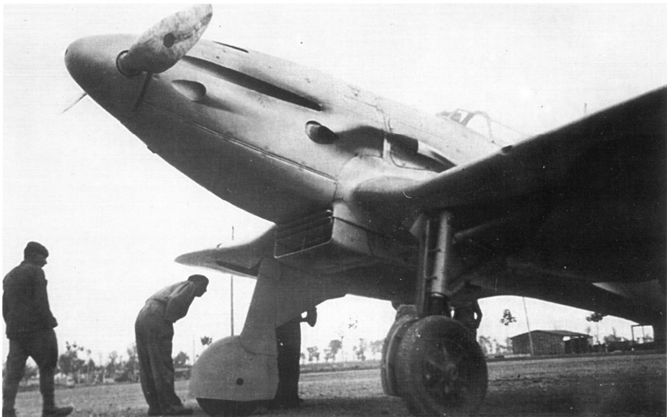
Oben: He 112 B-0, die für den Auslandsexport gebaut wurden. Unten: He 112 B-1, ebenfalls Exportmaschinen. Die Muster unterschieden sich äußerlich hauptsächlich in der geänderten Auspuffanlage.
