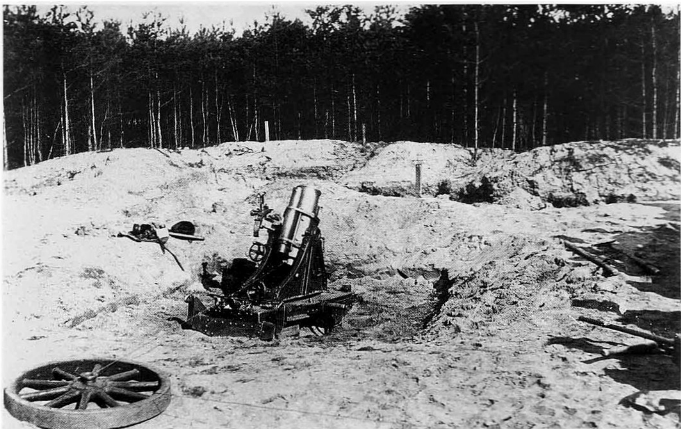
Der schwere Minenwerfer auf dem Schießplatz. Aufnahme vom Sommer 1917. In Feuerstellung betrug das Gewicht 570 Kg, davon entfielen auf das Rohr 148 Kg, auf die Rohrwiege und Bremsenrichtung 110 Kg. Die Feuerhöhe lag bei 525 mm.
