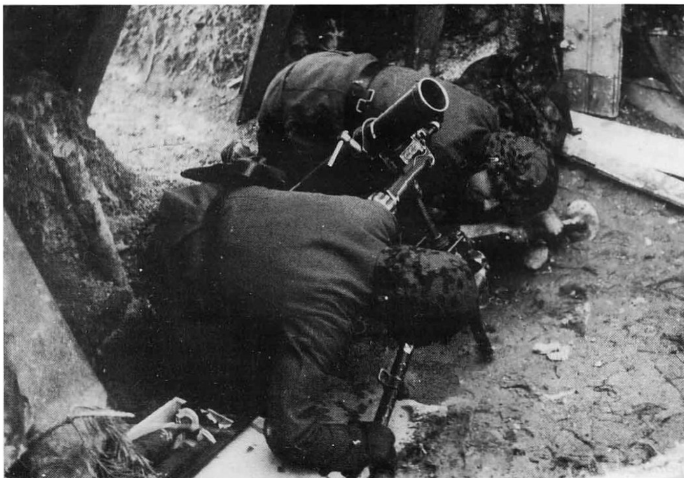
In der D 147, Anleitung für die Ausbildung am schweren Granatwerfer 34 (8 cm), kann man unter der Position 42 Feuern nachlesen: Nach dem Kommando "Feuer frei!" läßt der Schütze 2 die bis dahin noch festgehaltene Wurfgranate in das Rohr gleiten und nimmt sofort beide Hände von der Mündung fort. Werferführer, Schütze 1 und 2 beugen sich nach vorn und nehmen den Kopf herunter. Sie halten das Zweibein während der Schußabgabe fest.
