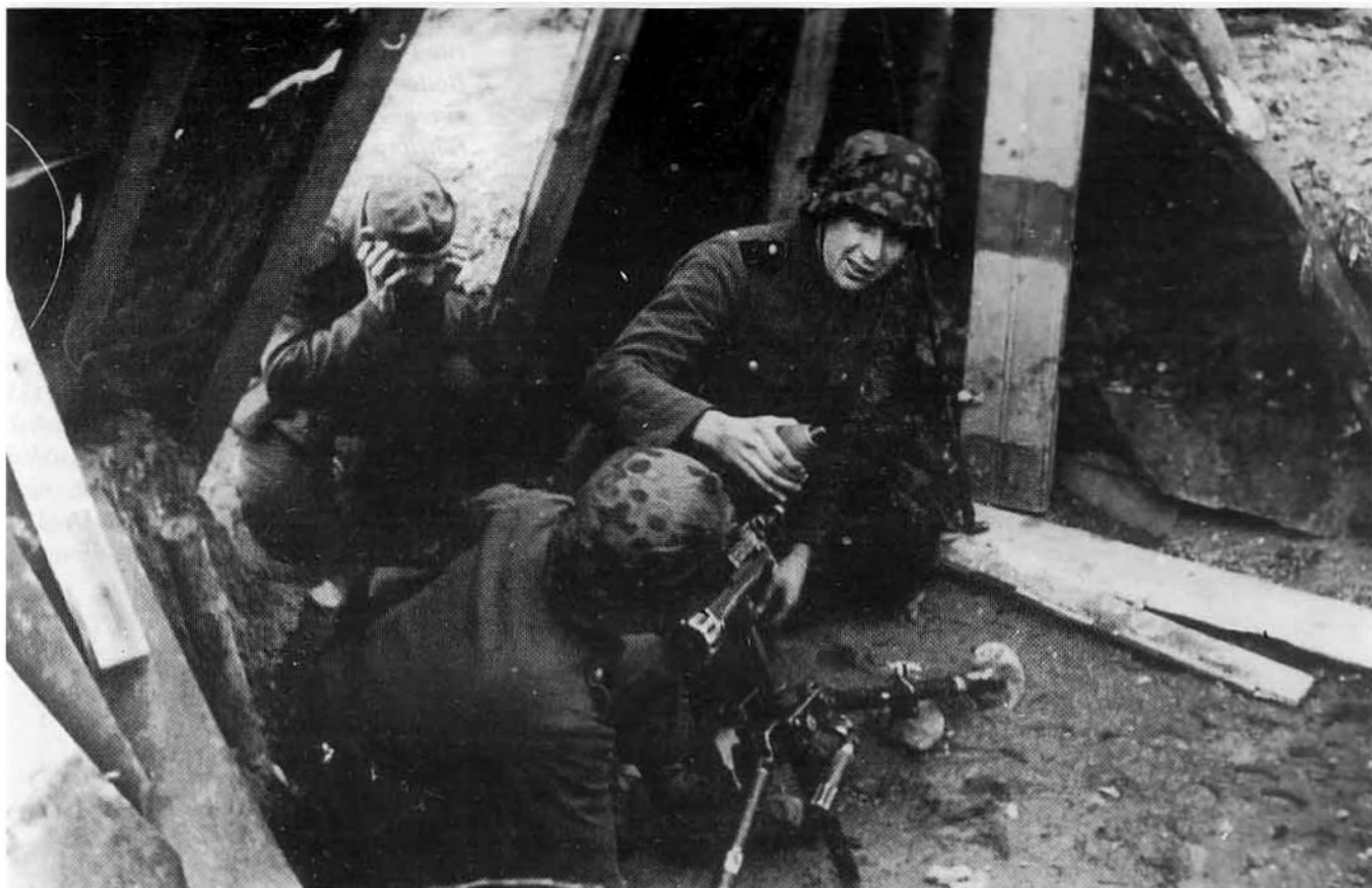
In der D 147, Anleitung für die Ausbildung am schweren Granatwerfer 34 (8 cm), kann man unter der Position 42 Feuern nachlesen: Nach dem Kommando "Feuer frei!" läßt der Schütze 2 die bis dahin noch festgehaltene Wurfgranate in das Rohr gleiten und nimmt sofort beide Hände von der Mündung fort. Werferführer, Schütze 1 und 2 beugen sich nach vorn und nehmen den Kopf herunter. Sie halten das Zweibein während der Schußabgabe fest.
