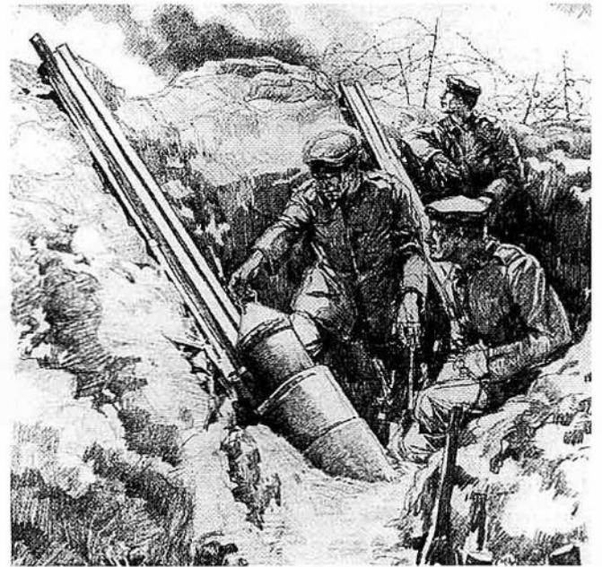
Zeitgenössische Darstellung aus der in Leipzig verlegten "Illustrierten Zeitung", die einen behelfsmäßigen Minenwerfer, den sogenannten Erdmörser im Einsatz zeigt. Im Bild zu sehen ist die schwere Sprengmine für Erdmörser. Sie war aus Stahlblech mit einem Holzboden, wog 24 Kg (davon 12 kg Sprengladung) und hatte einen Durchmesser von 245 mm.
