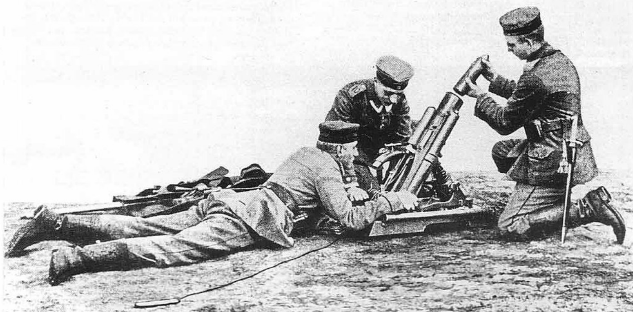
Leichter Minenwerfer in Feuerstellung. Der Ladewart muß vor dem Laden des Werfers die Wurfmine vorbereiten. Dazu ist es notwendig den Geschößboden abzuschrauben und die befohlene Treibladung zusammenzustellen.
