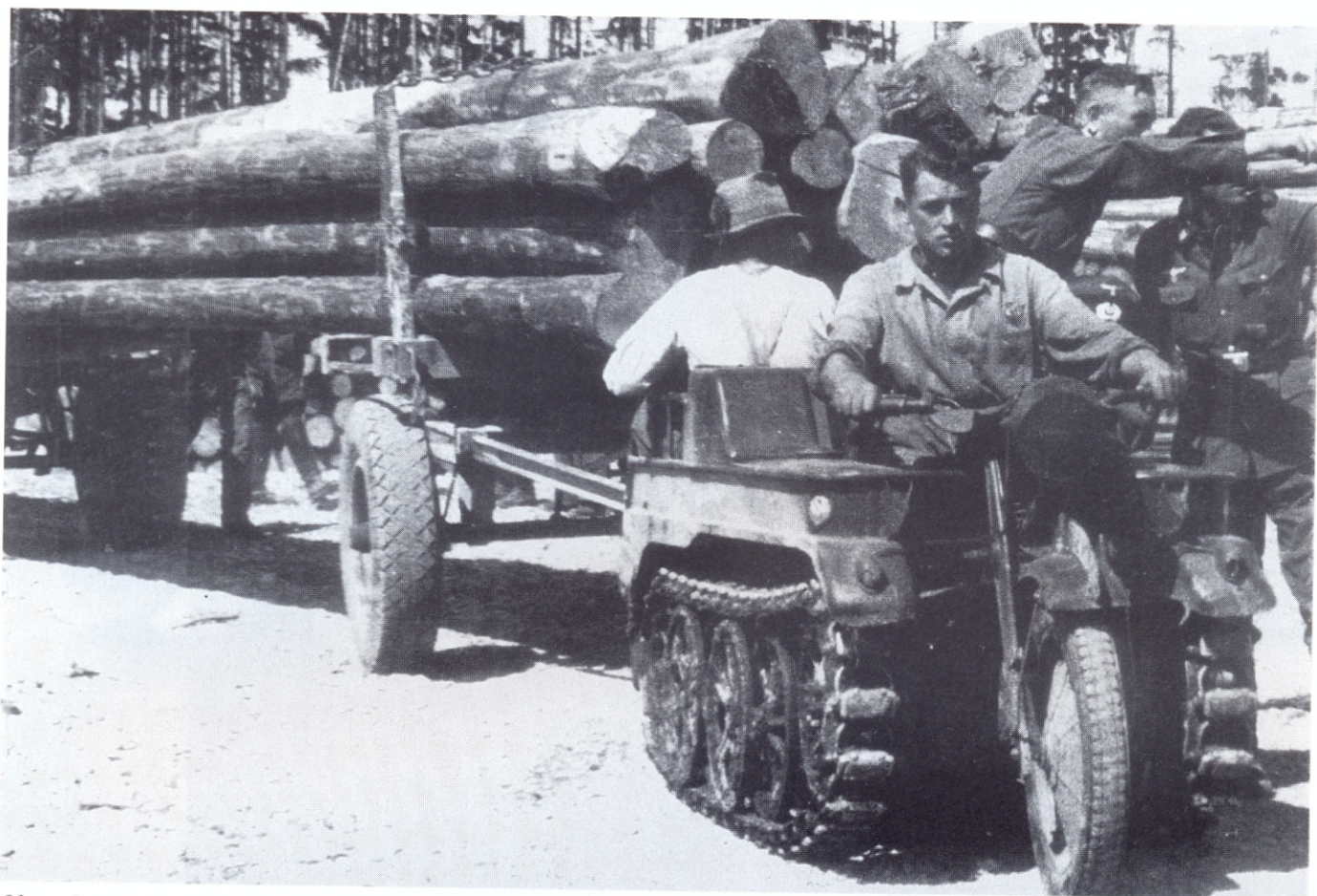
Oben: Im Pionier- und Brückenbau wurde das Kettenrad zu einem unverzichtbaren Zugmittel, wenn es darum ging, über schmale Waldwege das erforderliche Baumaterial heranzuschaffen.
