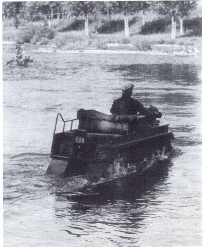
Hier wird die Watfähigkeit des Kettenkrades im seichten Wasser des Neckars demonstriert.
