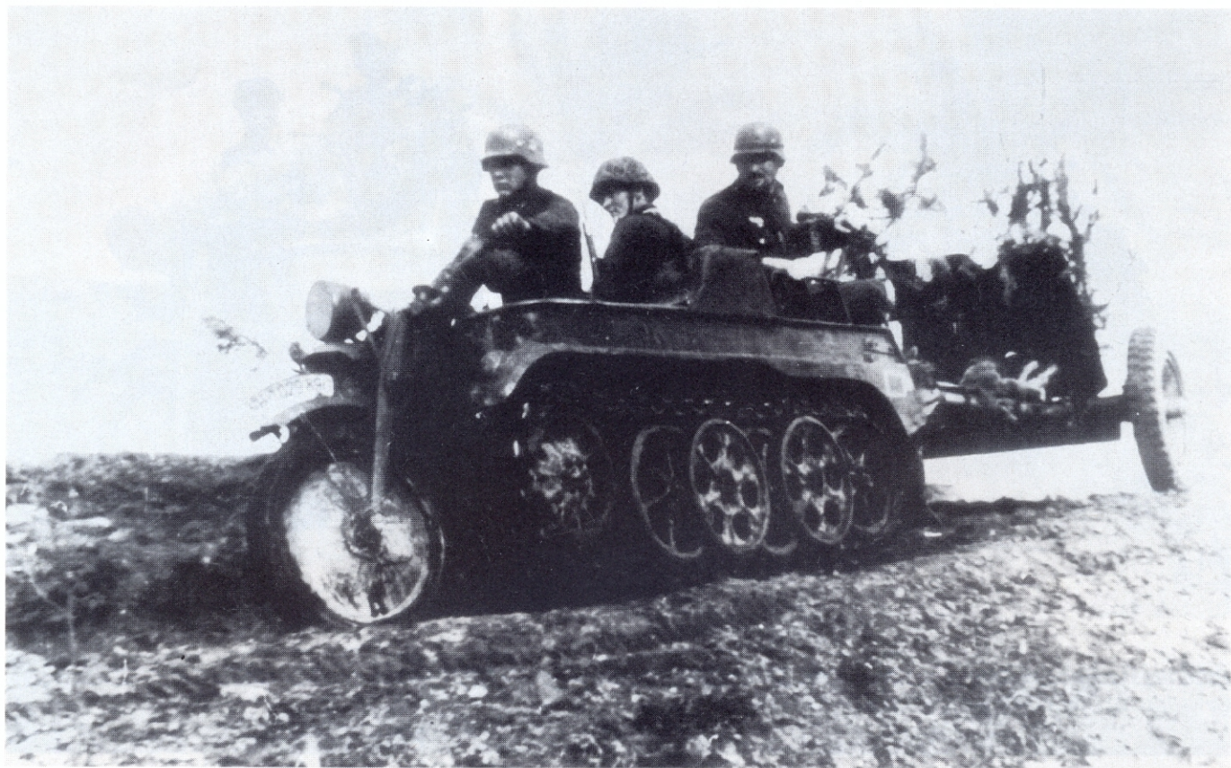
Als Zugmaschine für die Pak hat sich das Kettenkrad in den unwegsamen Geländebedingungen des Ostens hervorragend bewährt. Beachte die fehlende Scheinwerferabdeckung, die zum Teil noch vorhandene weiße Tarnfarbe an den Rädern sowie den Abschlepphaken am oberen Teil der Wanne.
