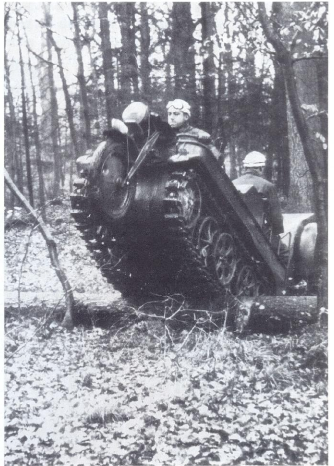
Rechts und unten: Eindrucksvolle Demonstrationen der Steigfähigkeit des Kettenkrades auf dem Versuchsgelände der NSU Werke in Neckarsulm. Kettenkräder dieser Baureihe wurden bereits auf allen Kriegsschauplätzen eingesetzt.
