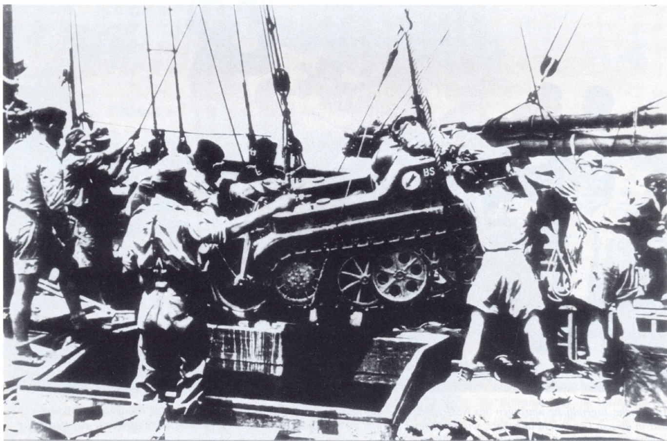
Oben und unten: Verladung von Kettenkrädern für den Einsatz in Nordafrika. Gut zu erkennen sind die achtspeichigen inneren Laufräder, mit denen die "erste Generation" dieser Fahrzeuge ausgerüstet war.
