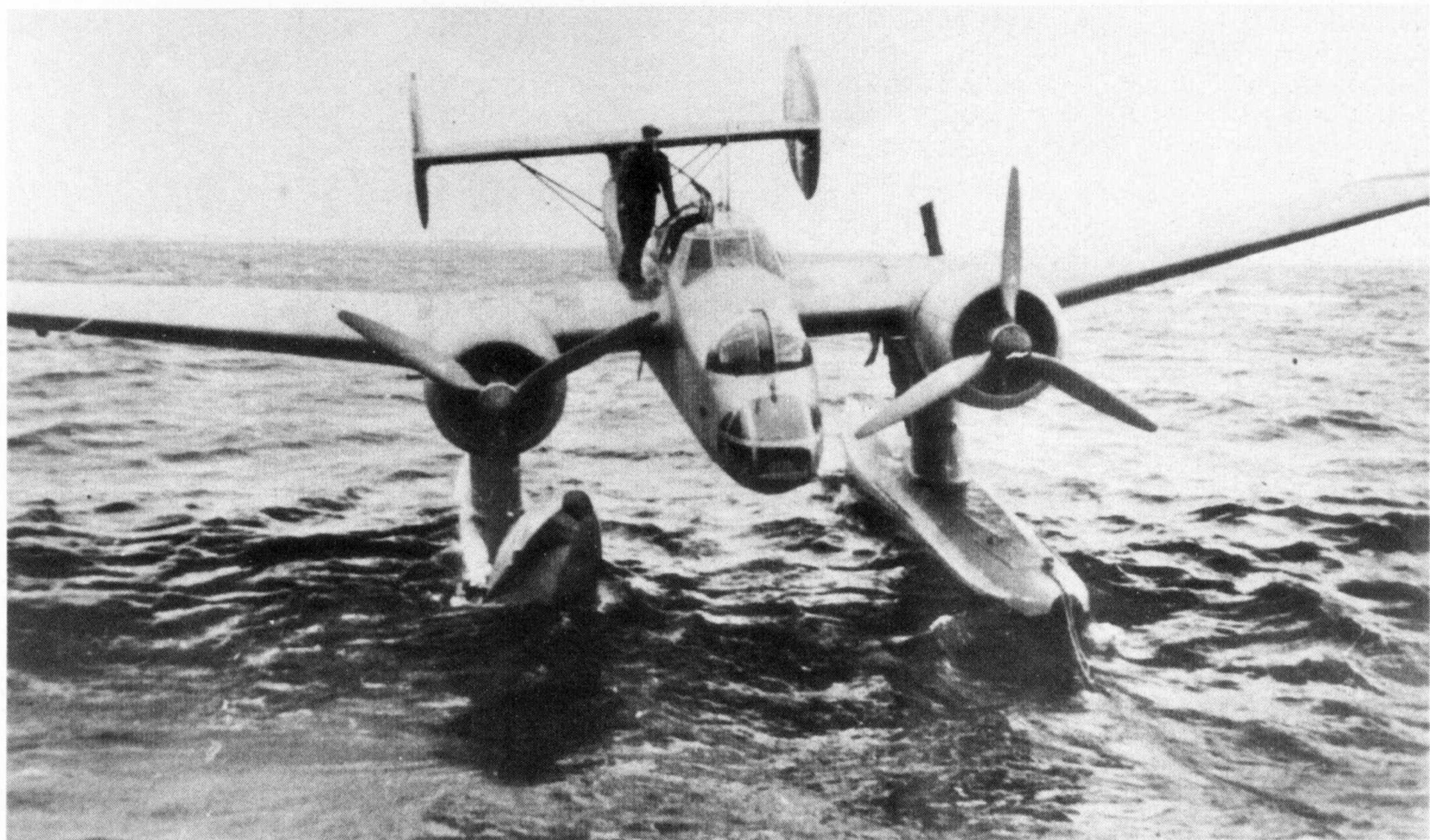
Pech! Schwimmerbruch und Steuerbordmotor aus der Halterung gebrochen - das Aus für die He 115 von Blohm und Voß als Serienflugzeug.
