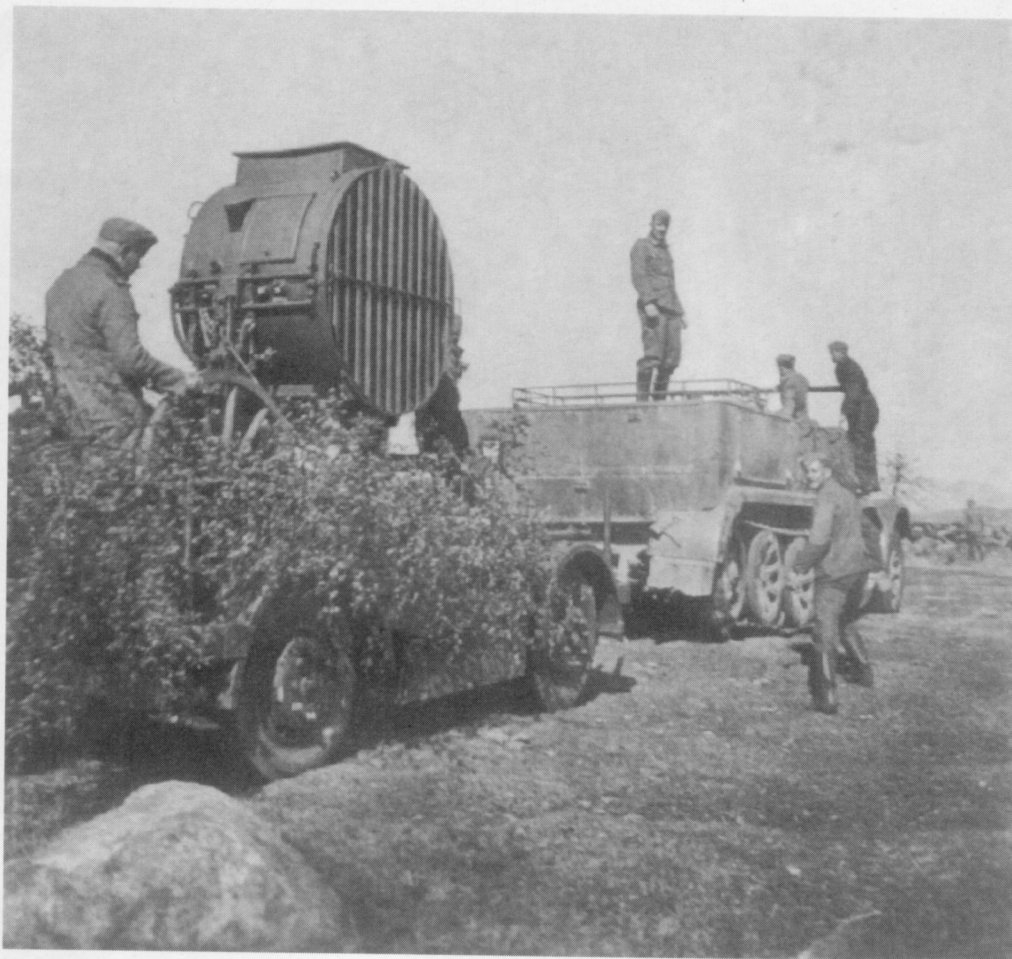
Links: Ein 110 cm Scheinwerfer aus dem 1. Weltkrieg wird von einem 12-Tonner in Stellung gebracht.
