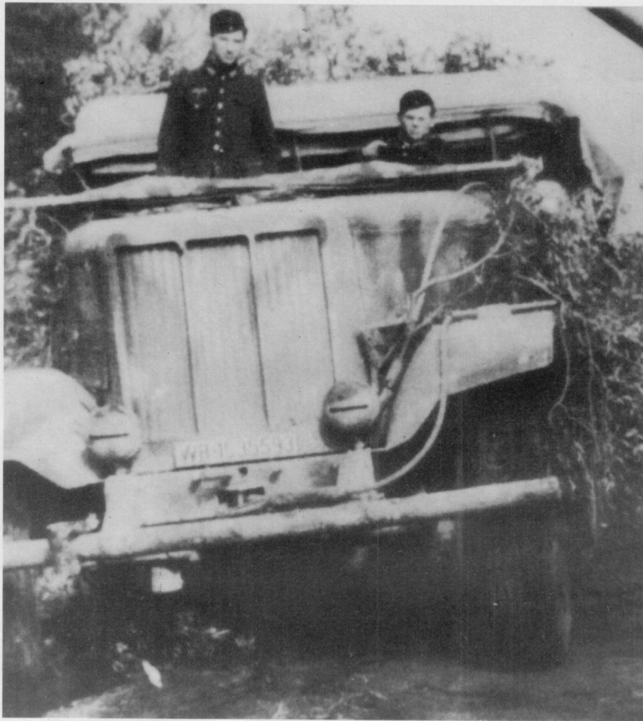
Die späte Ausführung des schweren Zugkraftwagen 18 t (Sd. Kfz. 9) erkennt man vor allem an der vereinfachten Vorderfront mit Rohr-Stoßstange und verkürzten Kotflügeln.
