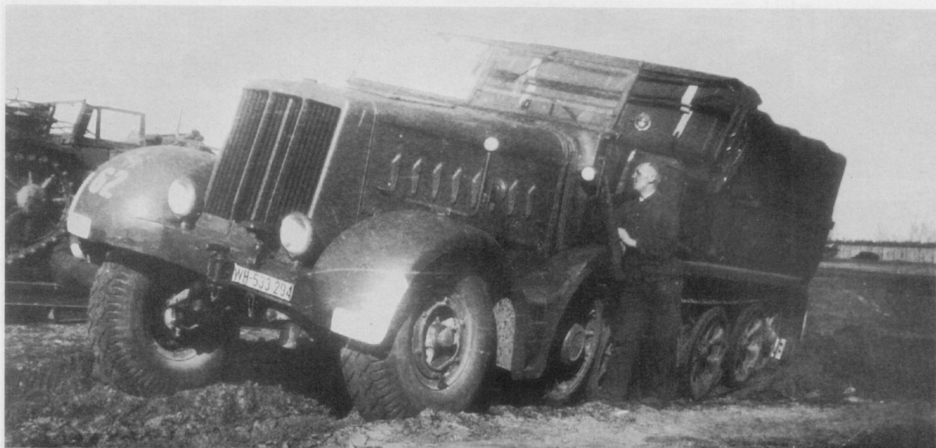
Mit einer Höhe von 2,85 m, einer Breite von 2,6 m und einer Länge von 8,25 m war der 18-Tonner ein wahrlich aufsehenerregendes und weltweit einmaliges Halbkettenfahrzeug. (Archiv Welte)
