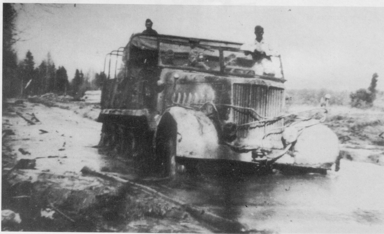
Unten: Im Schlamm des Wolchowgebietes: Der schwere Zugkraftwagen 18 t (Sd. Kfz. 9) einer Pioniereinheit.
