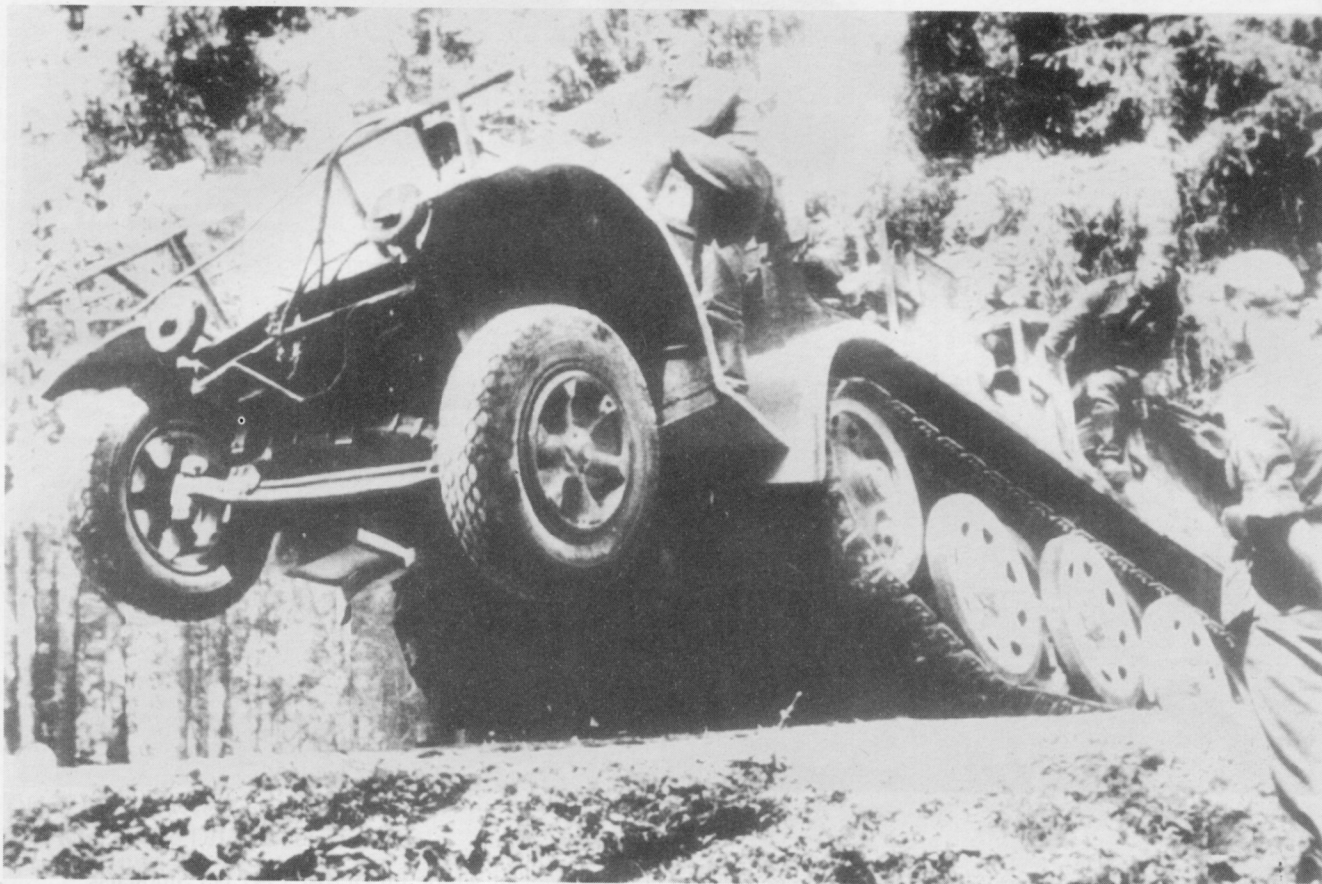
Bei diesem Fahrschulwagen des Typs DBs 7 ist gut die Konstruktion der Vorderachse erkennbar, die erst beim Typ DB 10 grundlegend geändert wurde.
