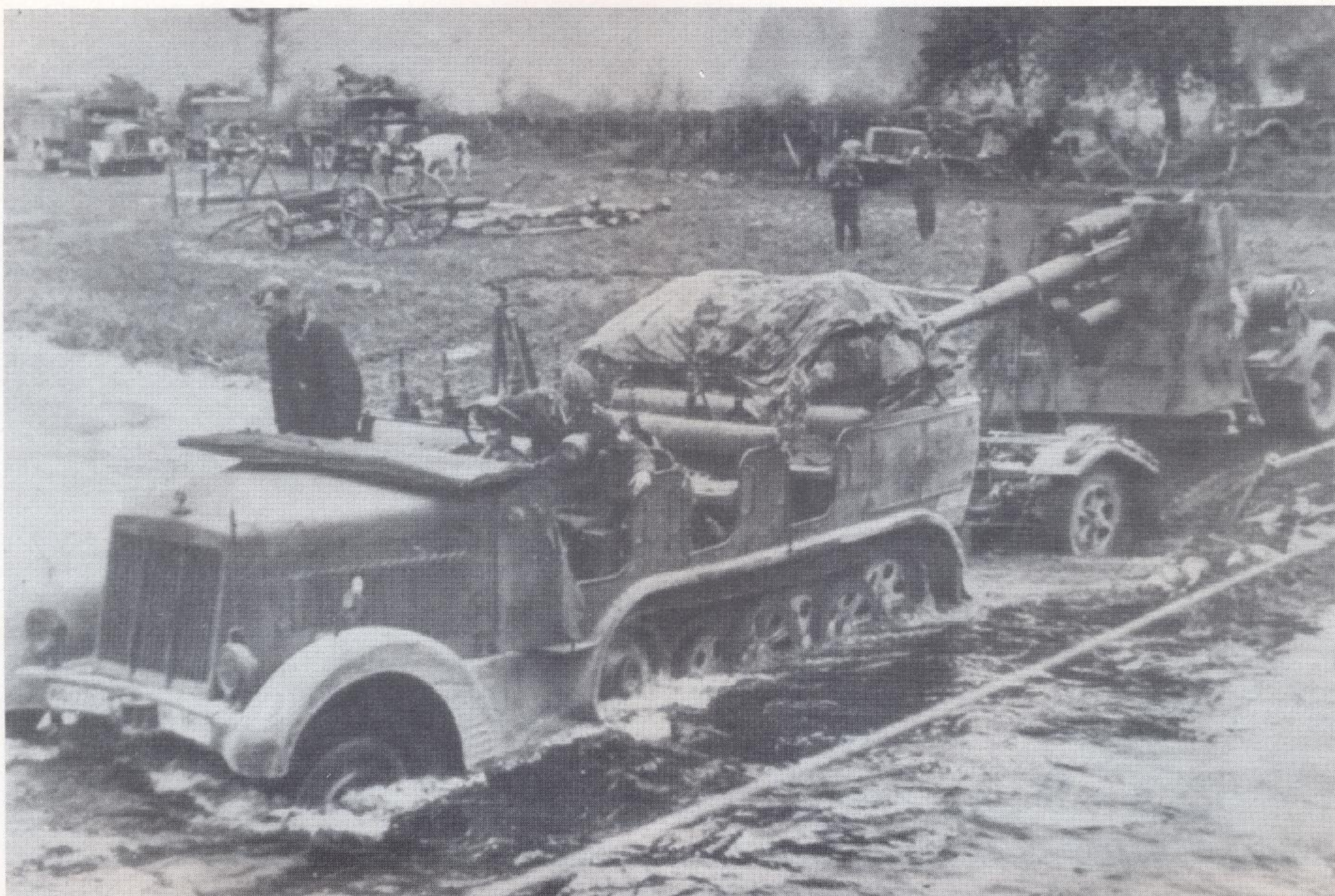
Oben: Auch eine gesprengte Brücke konnte diese 8,8cm Flak, gezogen von einer älteren 8 t-Zugmaschine mit kurzem Laufwerk, nicht am Überqueren eines Flusses hindern. Er wurde an geeigneter Stelle an einer Furt durchwatet.
