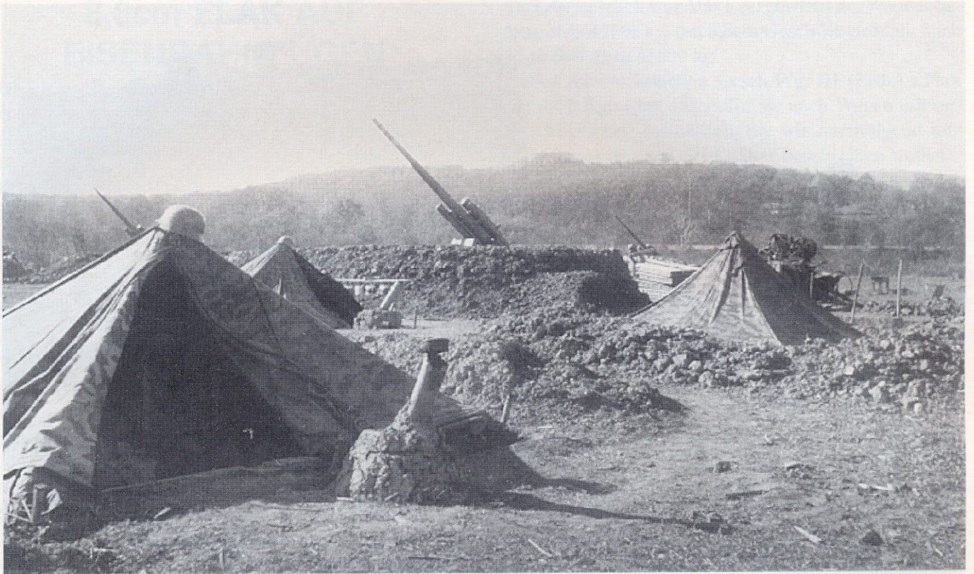
Oben: Um die Geschütze wurden Schutzwälle angelegt. Mit Zeltbahnen abgedeckte Erdgruben dienten den Bedienungsmannschaften als Unterkunft, die mit Bunkeröfen ausgestattet waren, wie das Ofenrohr vorn im Bild vermuten läßt.
