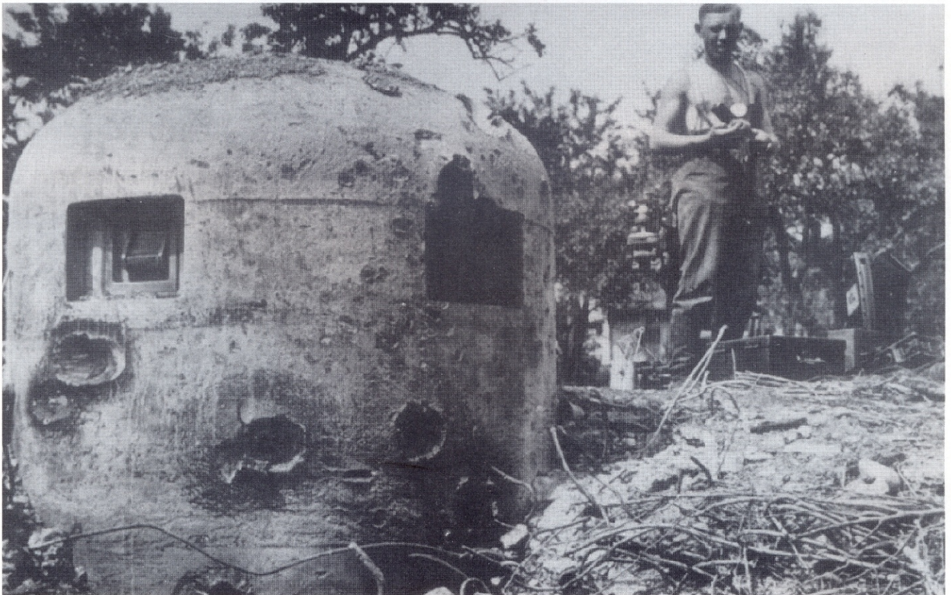
Unten: Ein Bunker der Maginot-Linie nach dem Beschuß durch 8,8cm Flak mit Panzergranaten im Juni 1940.
