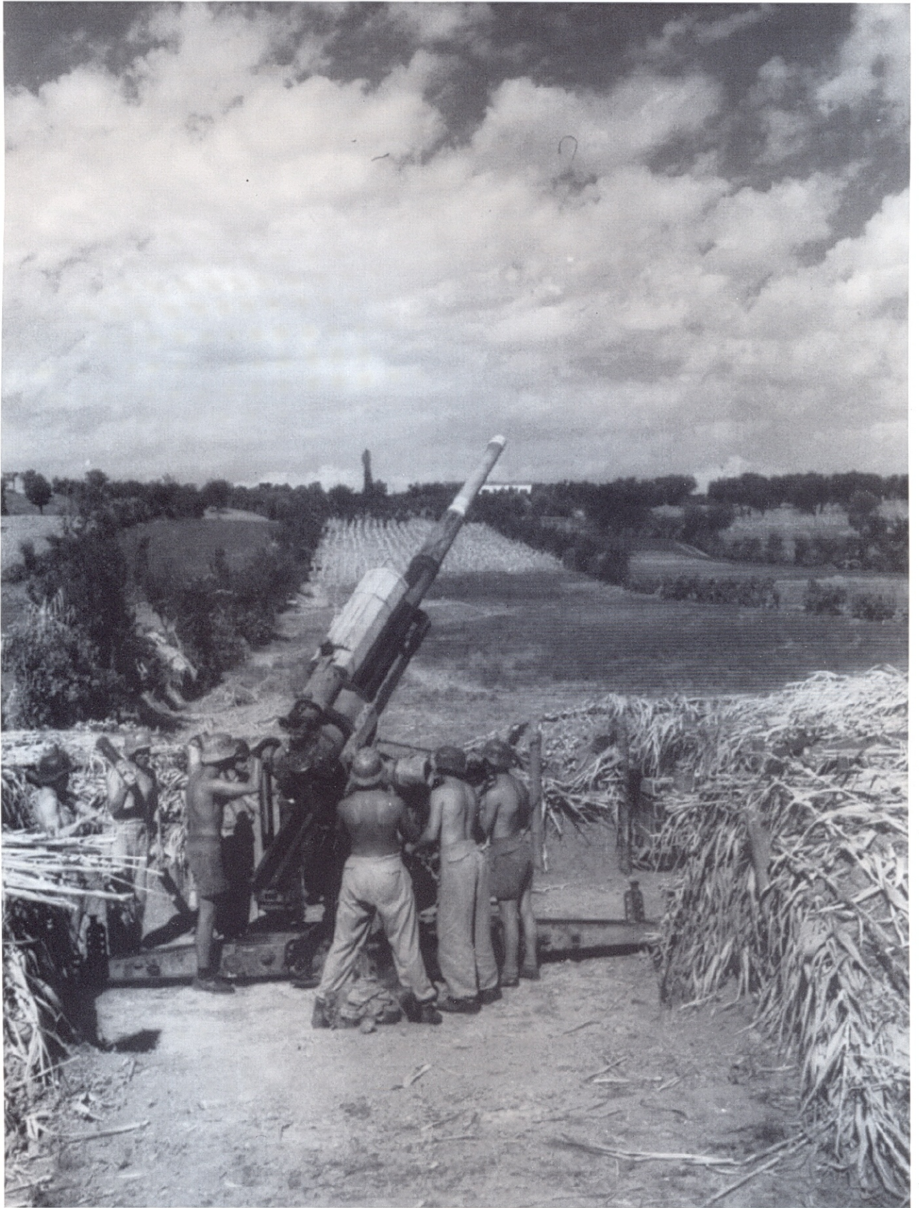
In einem mit Maispflanzen getarnten Geschützstand steht diese 8,8cm Flak im Einsatz. Bemerkenswert ist die Umschalung des Luftvorholers über dem Rohr mit Holzleisten. Wahrscheinlich sollte dadurch eine allzugroße Erwärmung durch die Sonneneinstrahlung verhindert werden.
