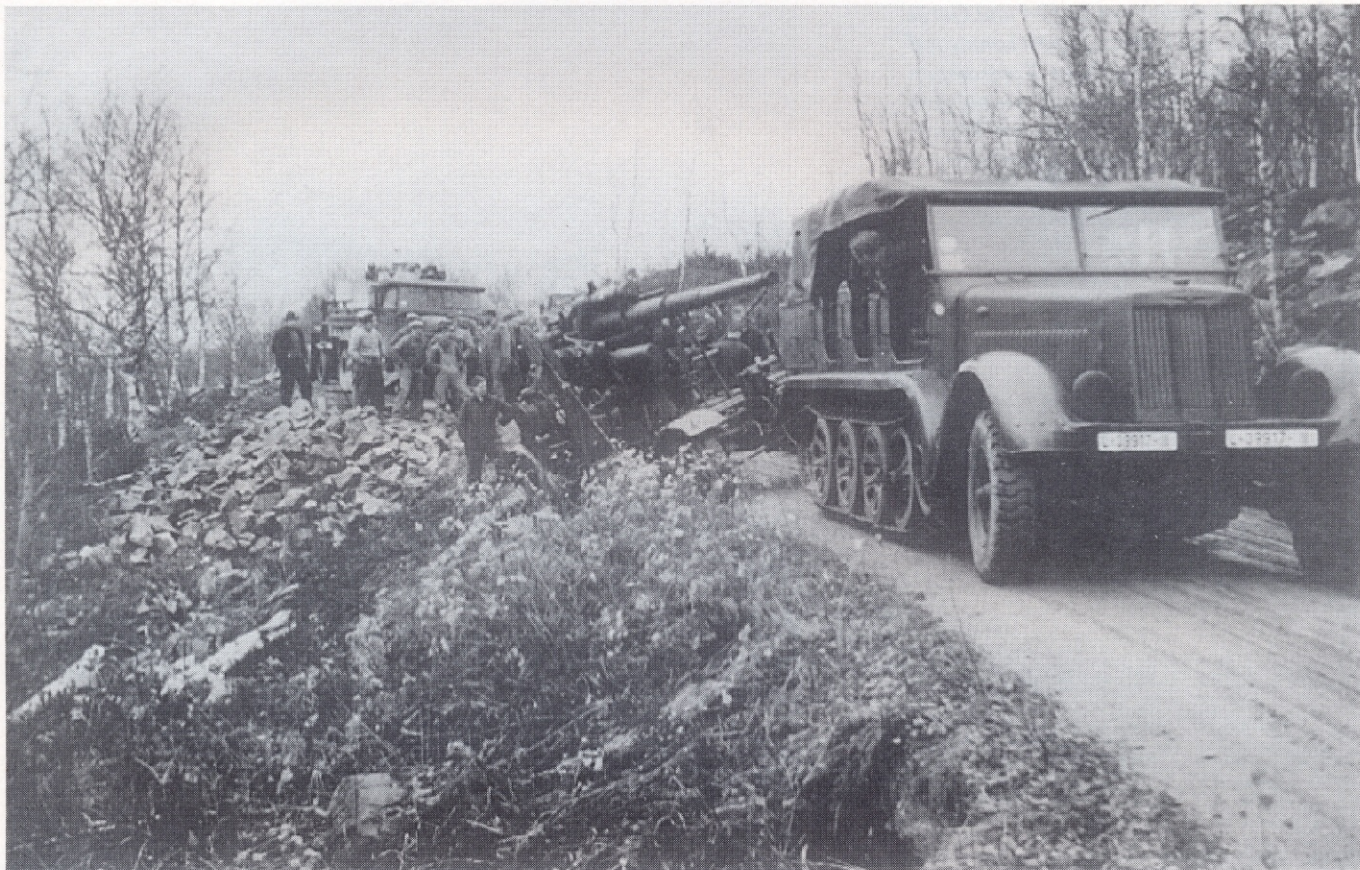
Oben: Auf weicher Bankette einer Straße bei Bardufuß in Norwegen sackte diese 8,8cm Flak ab und konnte nur mühsam wieder auf festen Grund gebracht werden.
