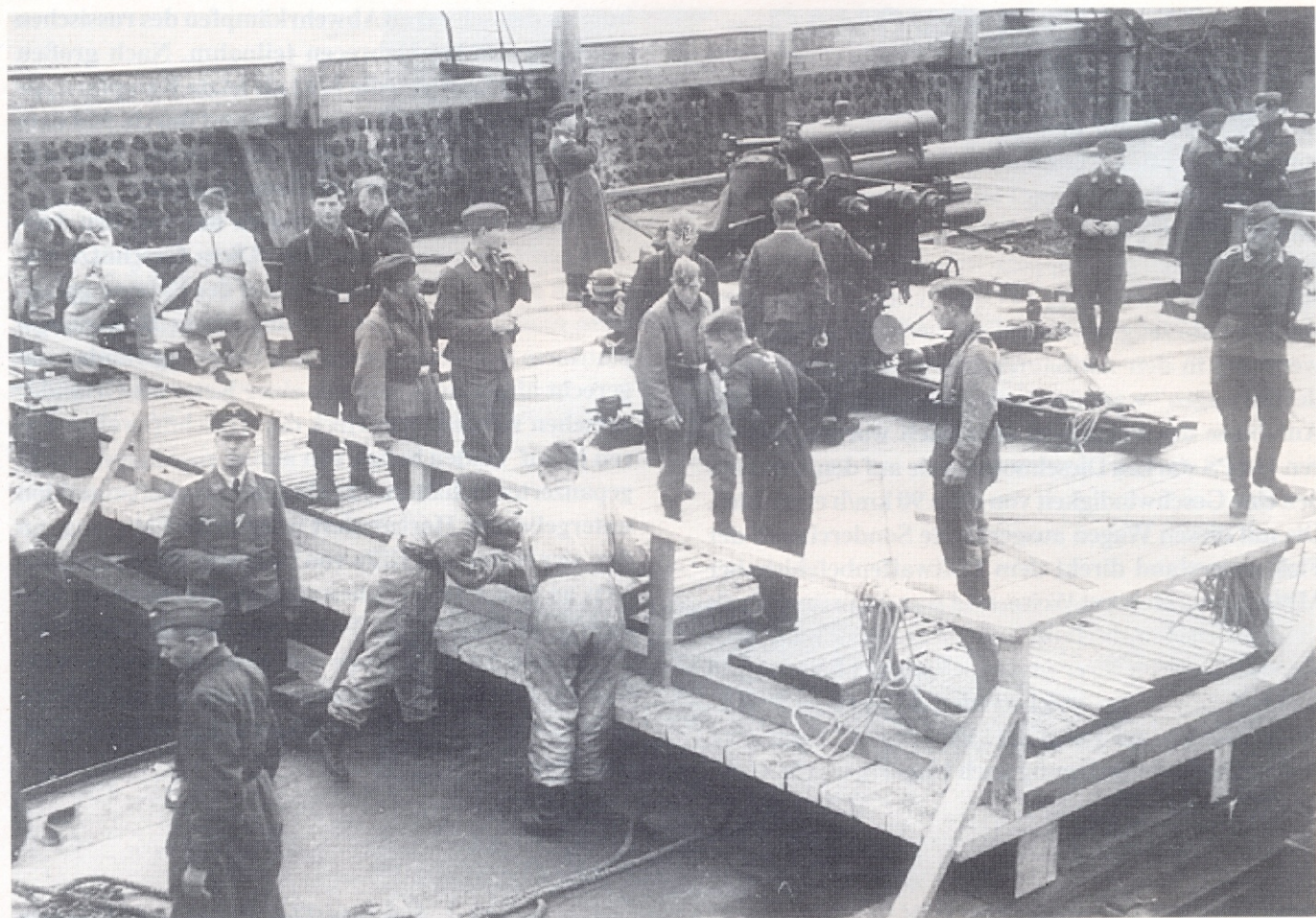
Oben: Im Hafen von Harlingen wird hier eine Flak-Fähre zusammengezimmert. Das Geschütz ist bereits auf der Plattform fest vertaut.
