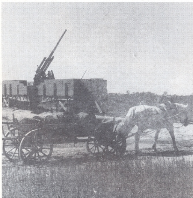
Unten: Das Bild zeigt eine andere Variante eines Eisenbahnflakwagens. Die Bedienungsmannschaft erreichte ihre Geschütze über eine Treppe am Kopfende des Wagens. Vorn passiert ein russischer Bauer mit seinem Pferdegespann friedlich die Stellung.
