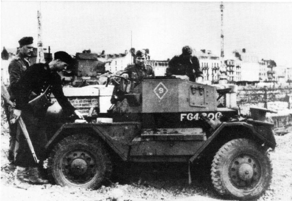
Links: Nach dem versuchten Landungsunternehmen bei Dieppe am 19. August 1942 wurde dieser Dingo Mark II erbeutet. Die Mk. II hatten ein Klappdach, welches nach rückwärts auf den hier einseitig abgerissenen Bügel abgelegt wurde.
