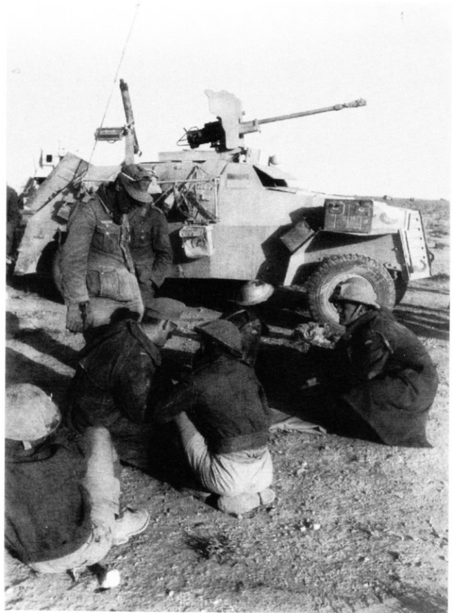
Von derselben Einheit wurde dieser Marmon-Herrington Mark II erbeutet, der anstelle des Turmes eine frz. 2,5-cm-Pak aufgesetzt hat. Als weitere Bewaffnung steht ein Vickers-MG zur Verfügung. Um die Bewaffnung der Mark II und Mark III zu verstärken, wurden verschiedene Beutewaffen, z.B. ital. 2-cm- und 4,7-cm-Geschütze oder deutsche 3,7-cm-Pak, anstelle des Turmes aufgesetzt. (BA)
