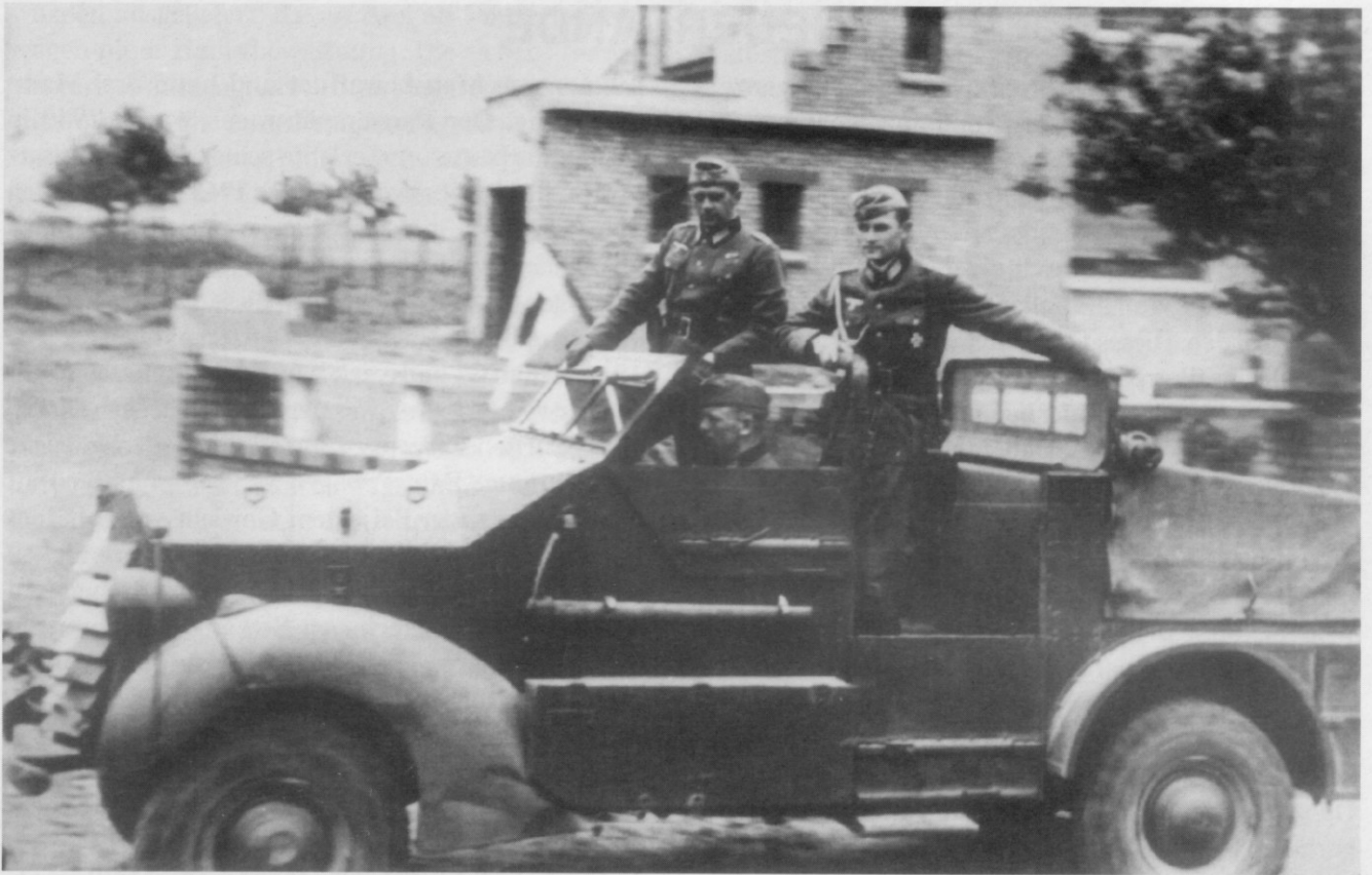
Oben: Auch beim I./I.R. 11 der 14. Infanterie-Division wurde die gepanzerte Ford/Marmon-Herrington-Zugmaschine als Kommandeurwagen genutzt. Der seitliche Panzerschutz für Fahrer und Beifahrer und die "Türen" ließen sich abklappen. (RF)
