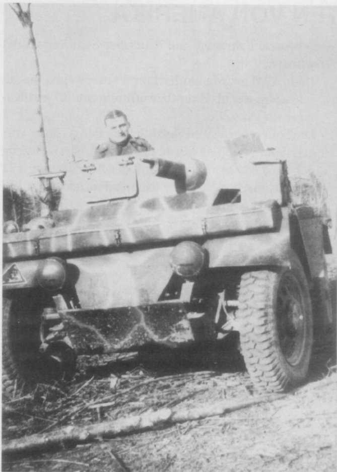
Die italienische Armee hatte sich 1943 entschlossen, für einen leichten Panzerspähwagentyp den englischen Daimler Dingo nachzubauen. Als Bewaffnung war ein MG eingebaut. (JW)
