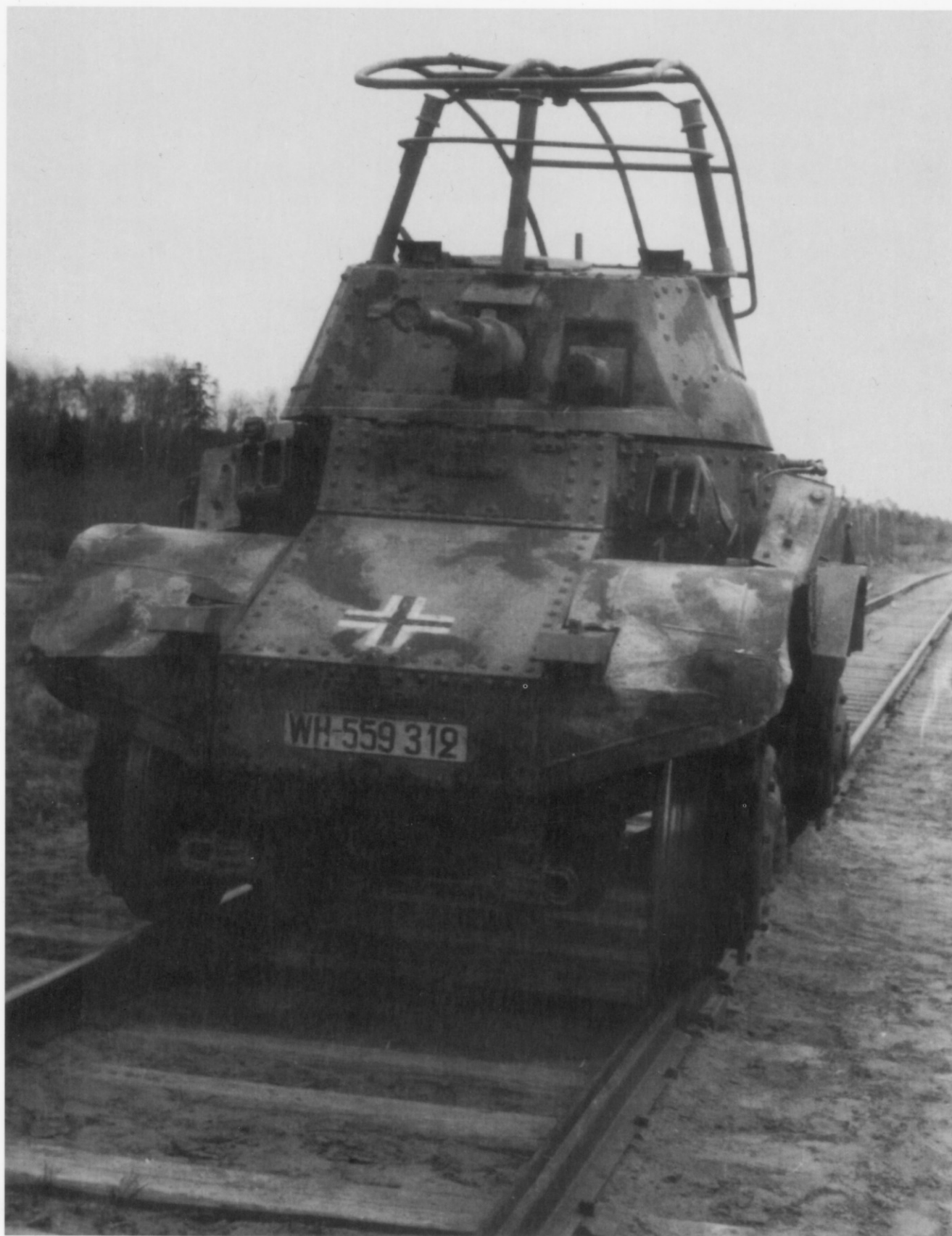
Eine Panhard-Draisine auf einer Schienenstrecke in Rußland zur Aufklärung eingesetzt. Diese Fahrzeuge waren oft paarweise oder auch einzeln den Eisenbahn-Panzerzügen als Aufklärungsmittel zugeteilt. (BA)
