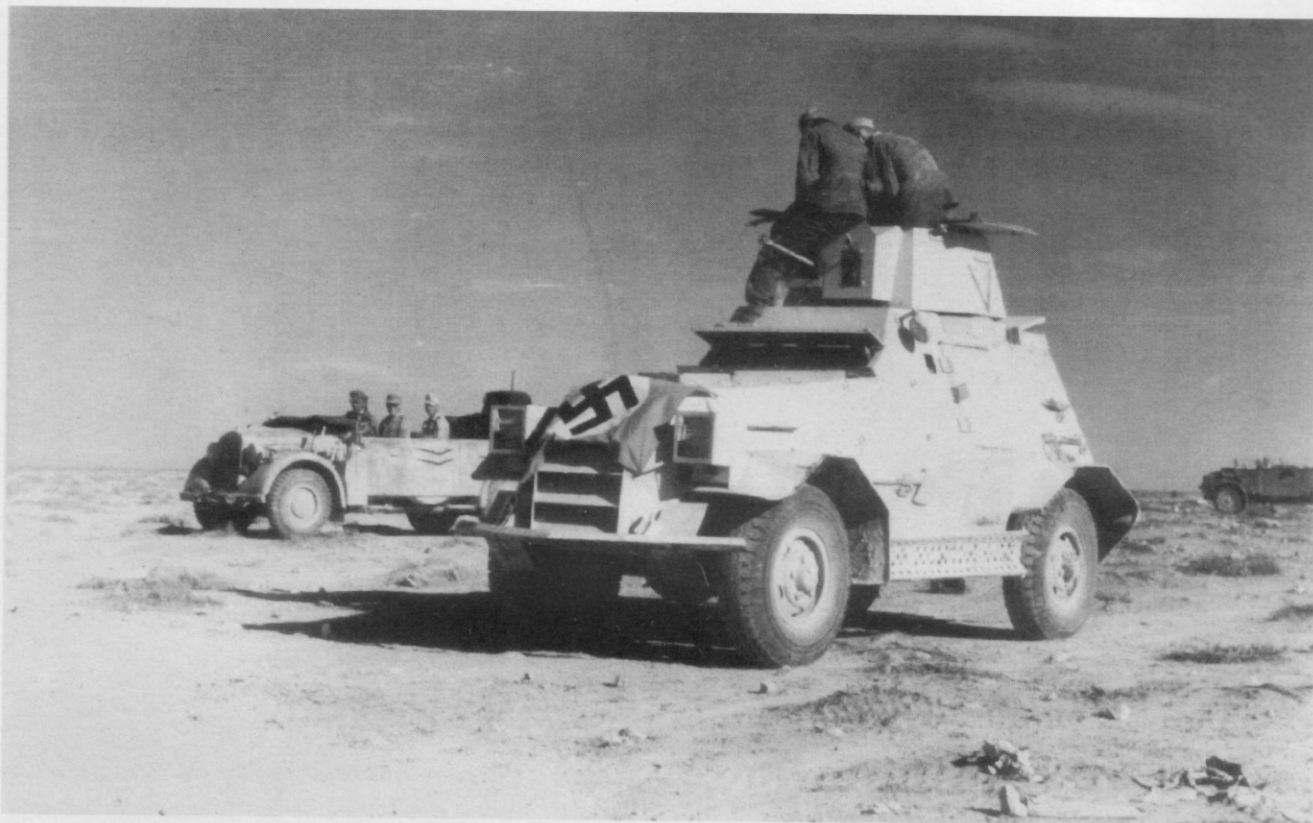
Oben: Marmon-Herrington Mark III mit weißen Balkenkreuzen und einem Fliegersichttuch auf der Motorhaube. Es handelt sich um eine frühe Ausführung des Mark III, die an dem gepanzerten Kühlergrill zu erkennen ist. Typisch für den Mark III sind auch die gepanzerten, viereckigen Frontscheinwerfer, die erst beim Mark IIIA wieder entfielen. (BA)
