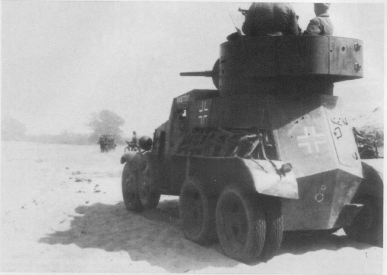
Oben: Ein schwerer russ. Panzerspähwagen BA-3, der mit dem gleichen Turm wie der Panzerkampfwagen T-26, Modell 1933, ausgerüstet war. Die Hauptbewaffnung war eine 4,5-cm-Kwk. (BA)
