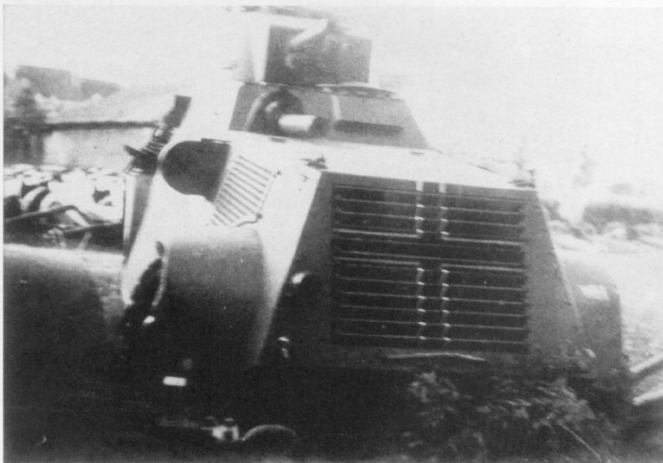
Links: Diese etwas unscharfe Aufnahme zeigt einen Landsverk Typ L 180 mit Balkenkreuz und WH- Kennung. Diese Pantser- wagen M 38 unterschie- den sich vom M 36 durch den breiteren Bug mit den feineren Kühlrippen und den waagerechten Kühl- schlitzen an den Seiten des Motorraumes. Die M 38 besaßen einen stär- keren Motor als die M 36, die Bewaffnung war gleich. (RE)
