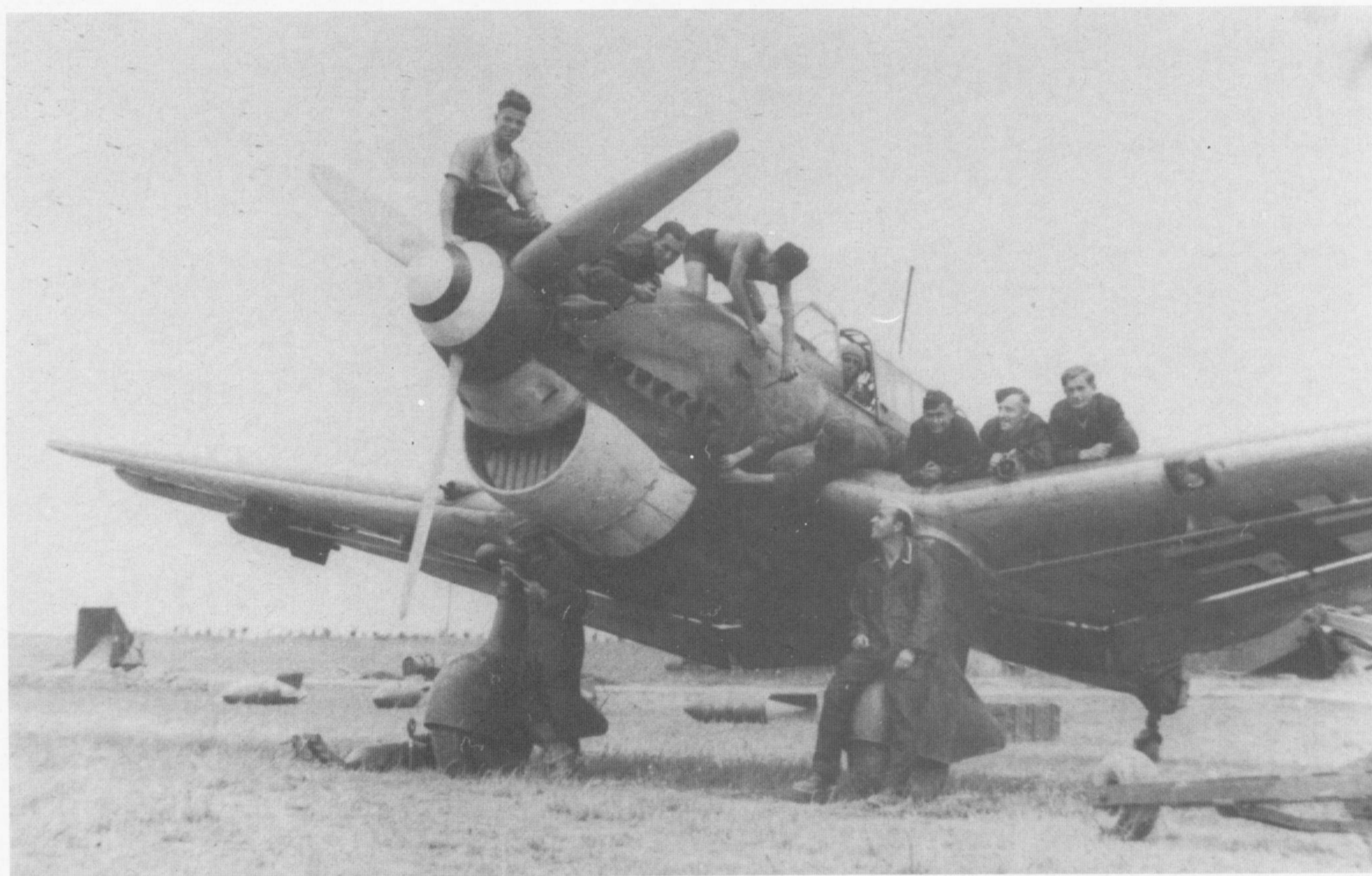
Unten: Ebenfalls einen modifizierten Kühler hat diese Ju 87 B-1 des StG 1 erhalten.
