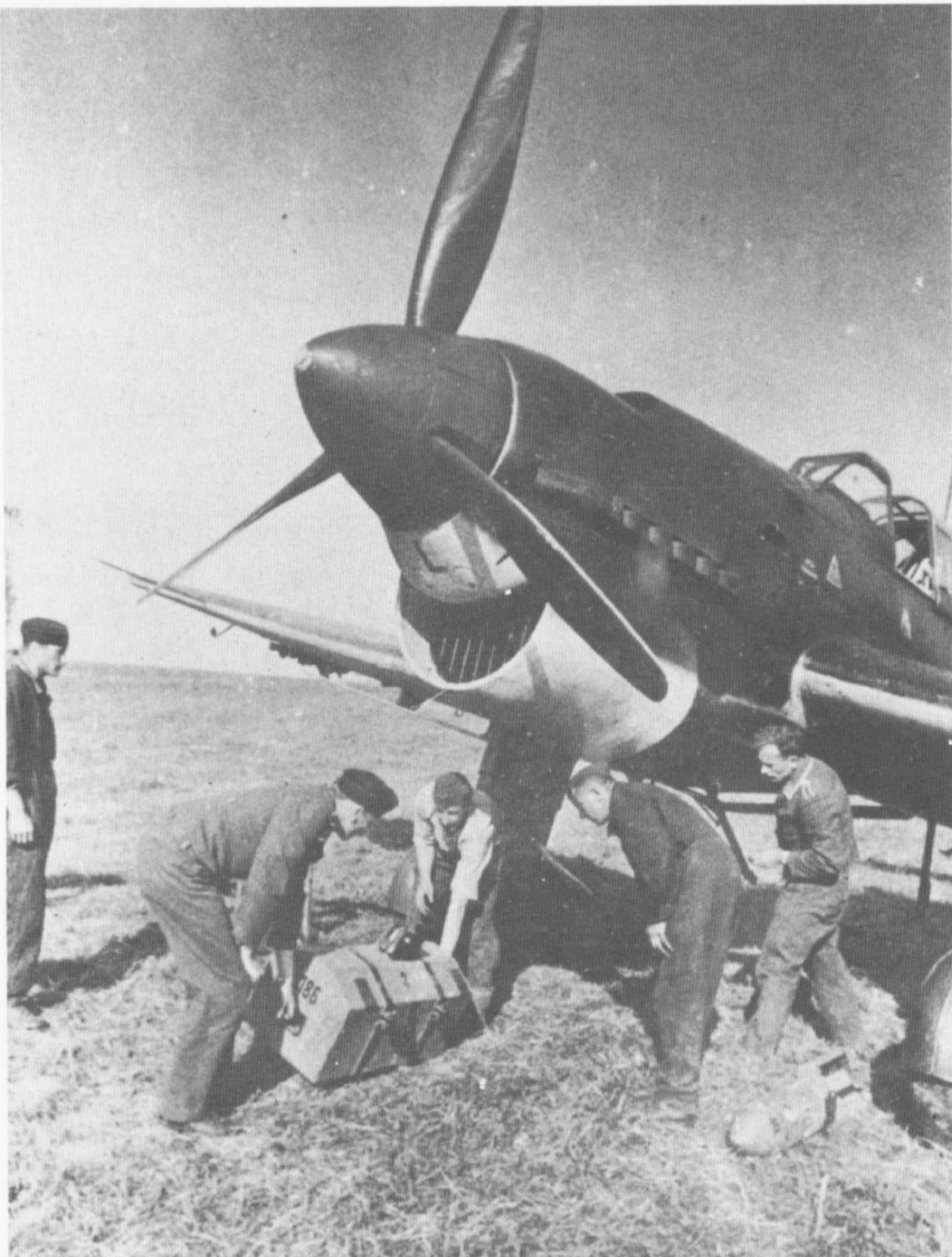
Anbringung einer Nachschubkiste unter dem Rumpf ETC bei der 1. Staffel der Trägergruppe 186. Der Behälter diente bei Verlegungen zur Aufnahme der persönlichen Ausrüstung der Besatzung.
