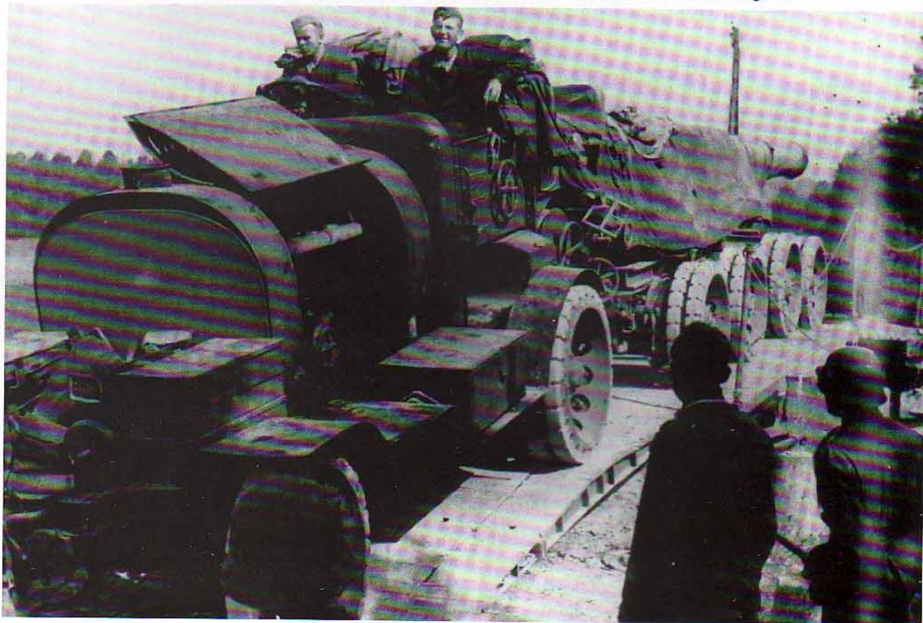
Ein Generatorwagen zieht ein Elektro-Fahrgestell mit der Rohrlast von einem Eisenbahnwaggon.
