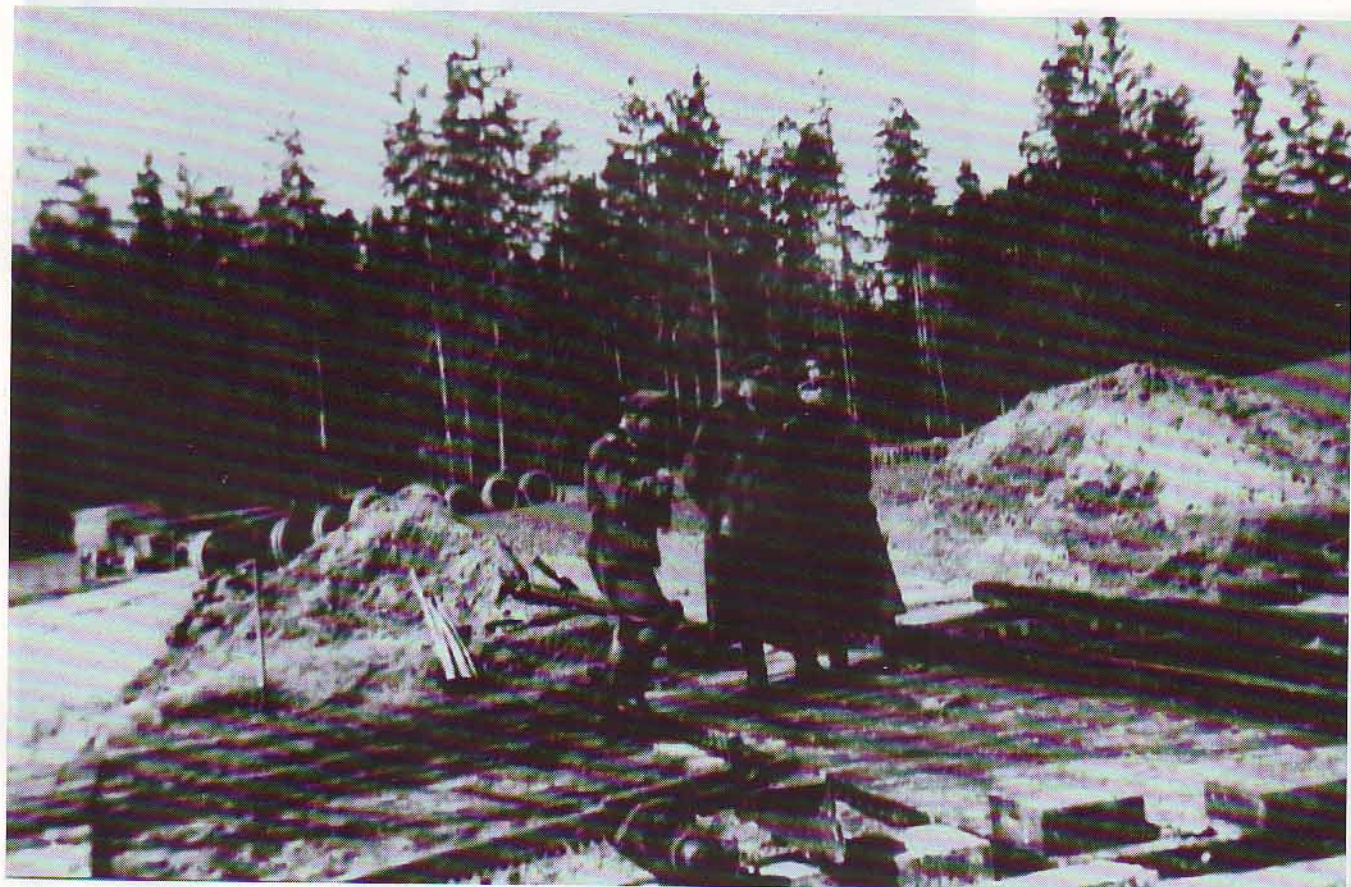
4. Vier Ratschen wurden in Stellung gebracht, die Fahrrollen entfernt und die Bettung mit Hilfe der Ratschen langsam in die Grube gesenkt.
