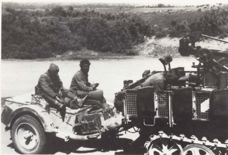
Links: Ein Sd.Kfz.10/4 des Fla.Btl.609 nach dem Durchbruch der Me- taxas-Linie. Der Sd. Ah.51 diente auf dem Marsch zum Transport des einklinkbaren M.u. G. —(Munition und Gerät—)Kastens, auf dem sich hier verwundeten griechische Soldaten ein Stück mitnehmen lassen.
