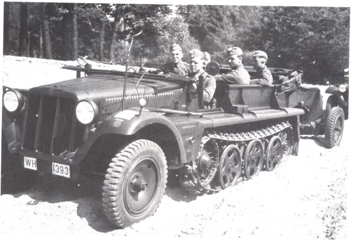
Leichter Zugkraftwagen 1 t (Sd.Kfz.10) mit 3,7 cm Pak im Übungsgelände; ein Fahrzeug der Adlerwerke. Gut ist neben dem Fahrer die Führungsschiene für die versenkbare Einstiegsklappe zu sehen. Am Heck eine Rolle Sperrdraht, der nur gegen Radfahrzeuge und sehr leichte Panzer wirksam war. (Achilles)
