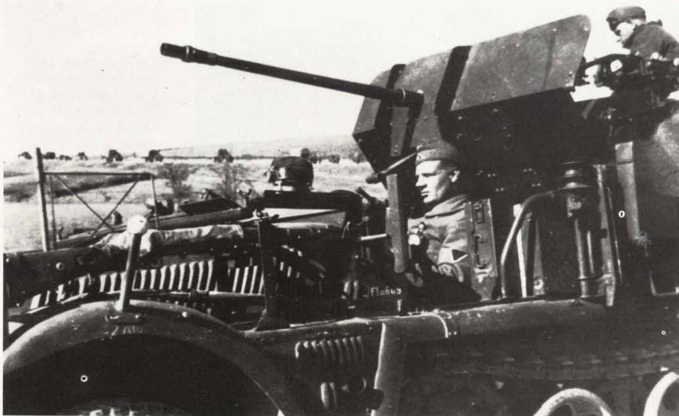
Oben: Nahaufnahme eines Sd.Kfz.10/4 der 1. Komp. des Fla.Btl. 609 in Griechenland. Gut erkennbar die Karabiner mit Staubschutzüberzug in der Karabinerhalterung und die Doppelrolle neben dem Fahrer zum Auflasten des Geschützes.
