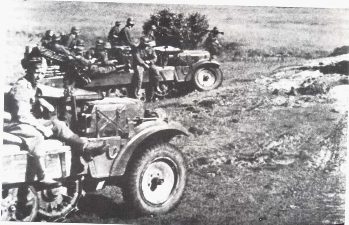
Oben: Bereitstellung zum Dünäübergang 1941. Diese leichten Zugkraftwagen 1 t (Sd.Kfz.10) führen Pioneermaterial in seitlichen Halterungen mit.
