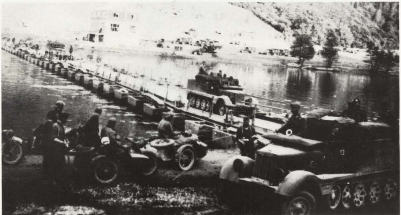
Unten: Maasübergang 1940 der 5.Pz.Div. Sd.Kfz. 11 ohne Anhängelast, mit ungeklärter Zuladung.
