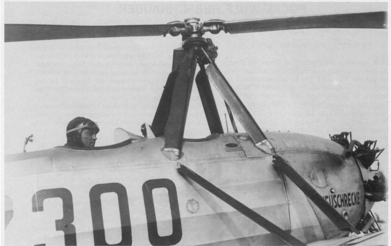
Oben: Nahaufnahme der dreiblättrigen Rotoranlage der D-2300.
