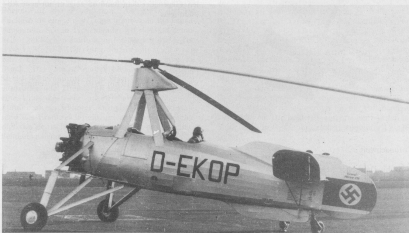
Die erste deutsche C 30 (D-EKOP) mit Sh-14-Motor.
