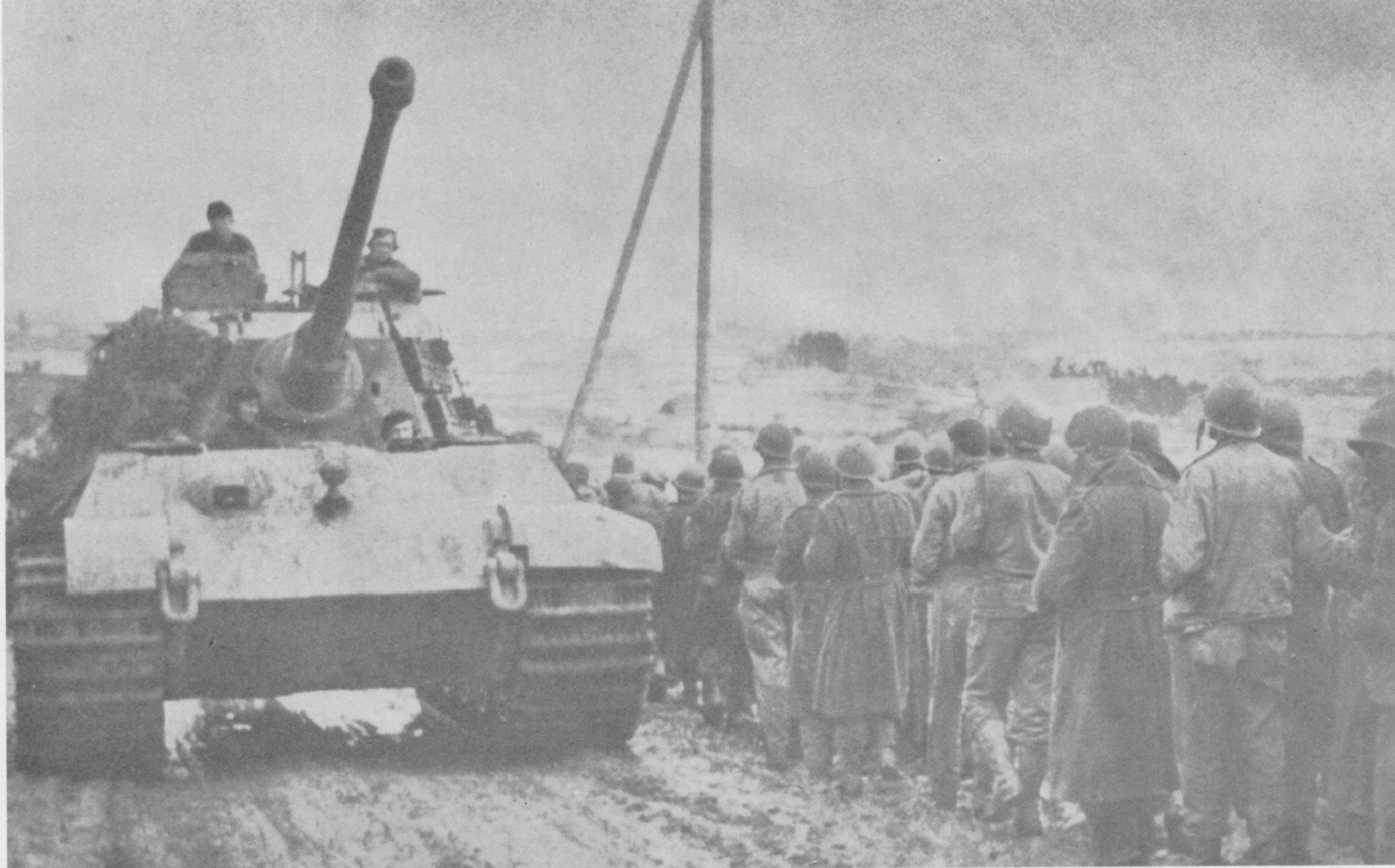
Unten: Auch der "Königstiger" nutzte Reservekettenglieder als zusätzlichen Schutz. Unter der Kanone schaut der Bug-MG-Schütze (gleichzeitig Funker) aus seiner Einstiegluke. Hierzu konnte er seinen Sitz höherstellen: übrigens ein Zeichen, daß sich dieser Tiger II zur Zeit nicht im Gefecht befindet.
