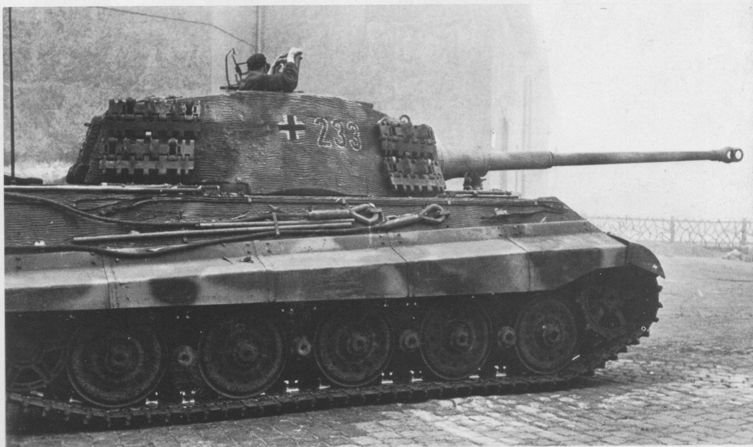
Unten: Auch der "Königstiger" nutzte Reservekettenglieder als zusätzlichen Schutz. Unter der Kanone schaut der Bug-MG-Schütze (gleichzeitig Funker) aus seiner Einstiegluke. Hierzu konnte er seinen Sitz höherstellen: übrigens ein Zeichen, daß sich dieser Tiger II zur Zeit nicht im Gefecht befindet.
