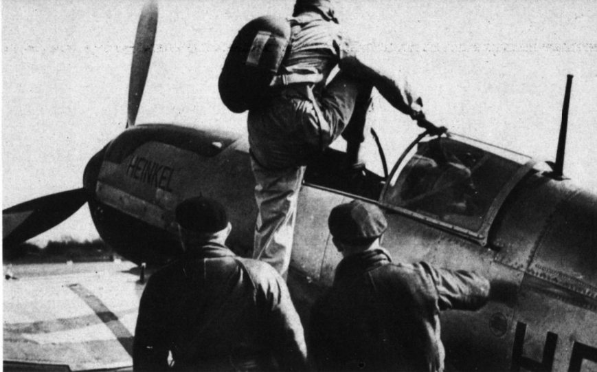
Zum nachgestellten Flug machte man sich nicht die Mühe, Nieten, Blechstöße usw. zu verspachteln und glattzuschleifen.
