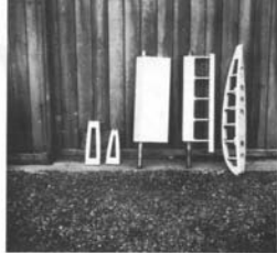
Die Tragfläche der "Natter" in verschiedenen Fertigungsstadien. Die Holzkonstruktion der BP-20 hatte den Vorteil, kriegswichtige Materialien zu schonen und den Bau der Maschine zu vereinfachen. Mit relativ schlichten Werkzeugen ließ sich die Tragflächenhälfte einer Ba 349 produzieren.
