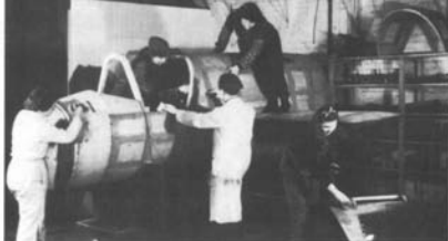
Oben: Rumpfmontage einer BP-20. Der Einsatz von Frauen war durch den Kriegsverlauf immer notwendiger geworden.
