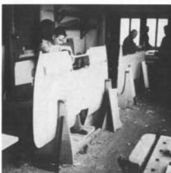
Die Tragfläche der "Natter" in verschiedenen Fertigungsstadien. Die Holzkonstruktion der BP-20 hatte den Vorteil, kriegswichtige Materialien zu schonen und den Bau der Maschine zu vereinfachen. Mit relativ schlichten Werkzeugen ließ sich die Tragflächenhälfte einer Ba 349 produzieren.
