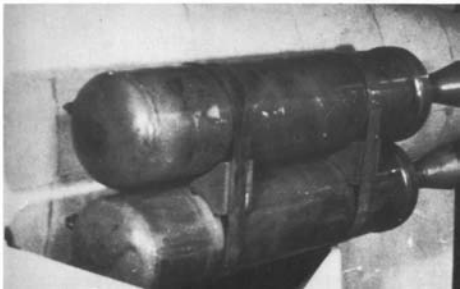
Anbringung der vier 500-kp-Starthilfsraketen an einer A- trappe der BP-20.
