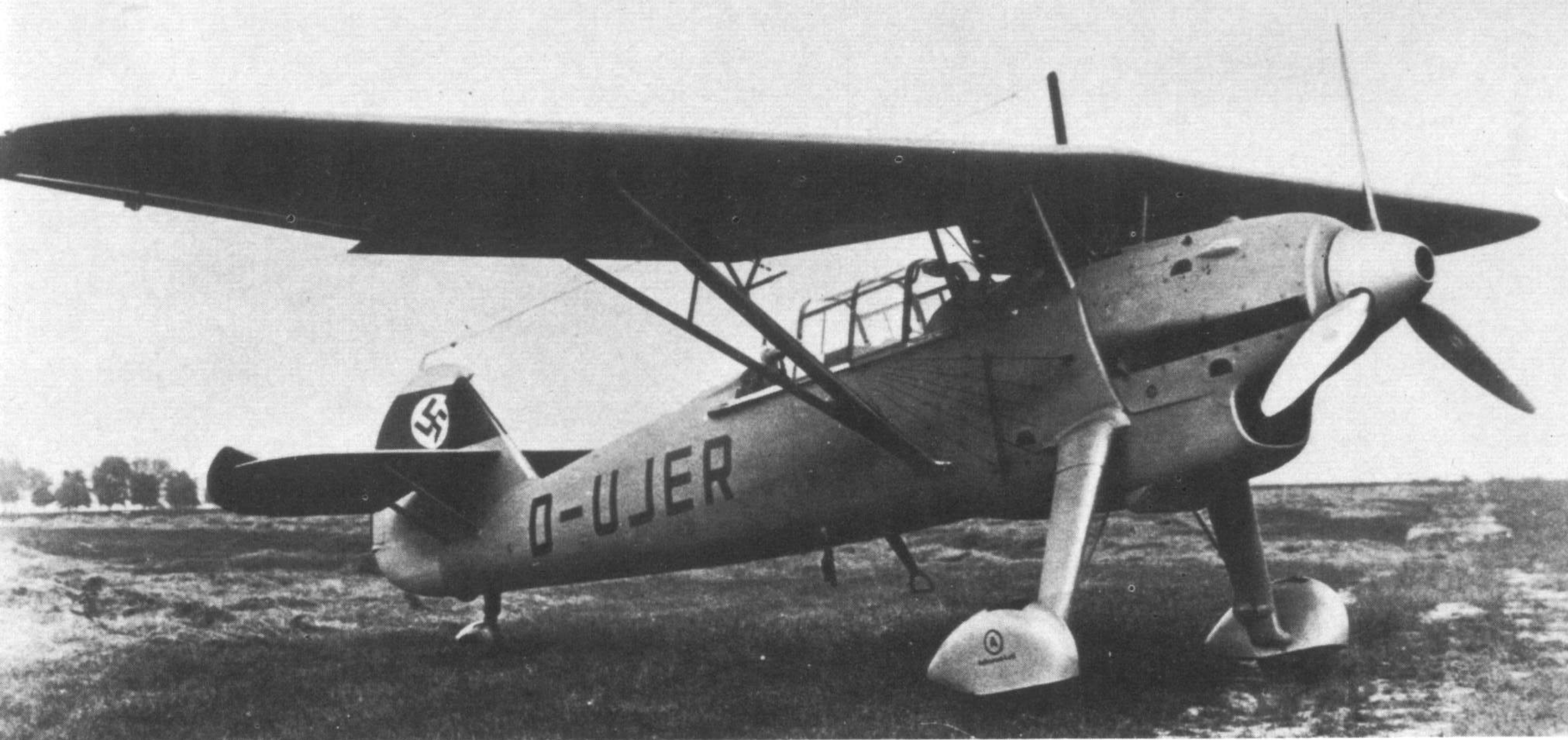
Oben: Die Hs 126 wurde 1938 zum neuen Nahaufklärer der Luftwaffe und löste die Heinkel-typen ab, welche nur noch für Schulungszwecke Verwendung fanden. Das Foto zeigt die zweite V-Maschine mit Reihenmotor.
