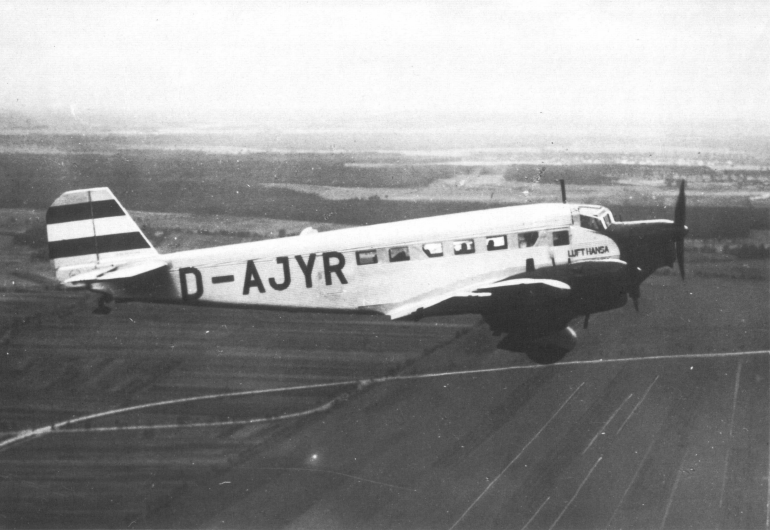
Ju 52-3m ho, Werknr. 4045, war eine der beiden mit Jumo 205 Schwerölmotoren ausgerüsteten Ju 52 der Lufthansa.
