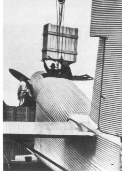
Die Ladeluke im Rumpfrücken machte auch das Verladen sperriger Güter möglich.
