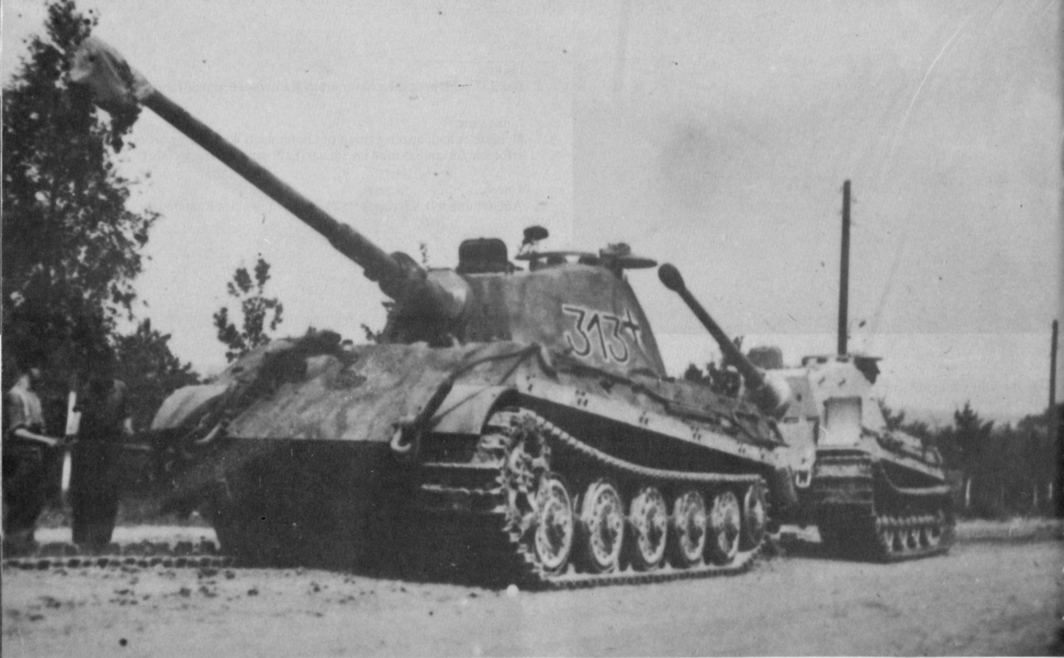
Die sPzAbt 501 bei der Entladung in Kielce (Polen). Der Wagen 313 wird von einem zweiten Tiger gerade auf die vor ihm ausgelegte rechte Gefechtskette geschoben. Linksseitig ist noch die schmale Verladekette aufgezogen. Anschließend sind die Kettenschürzen anzuschrauben.
