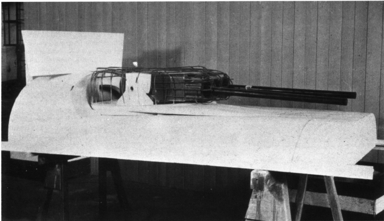
Attrappe eines Zwillingsstandes mit MG 151/20-Bestückung für die Ju 290 B.
