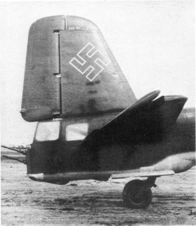
Die Erprobung dieses bemannten Waffenstandes erfolgte Ende 1943 bei der E-Stelle in Tarnowitz. Das Foto zeigt die Ju 188 V2 mit HL 131 Z.
