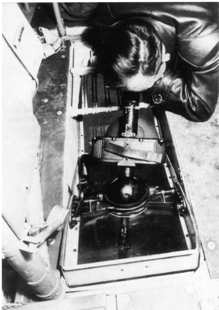
Der C-Stand der frühen Do 17-Ausführungen wies nur einen begrenzten Schwenkbereich auf.
