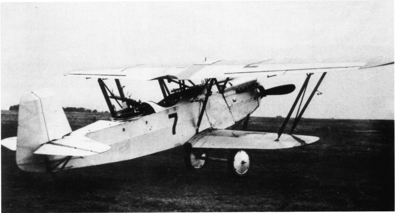
Diese Albatros L 76 wurde in Rußland versuchsweise mit einem beweglichen MG im Beobachterstand ausgerüstet.
