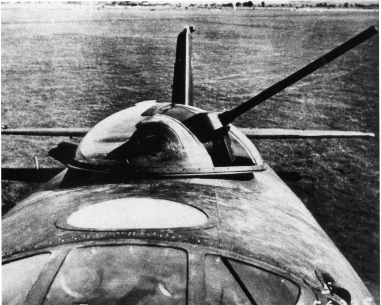
20 mm - Waffenstand auf dem Rumpfrücken einer Fw 200 C.
