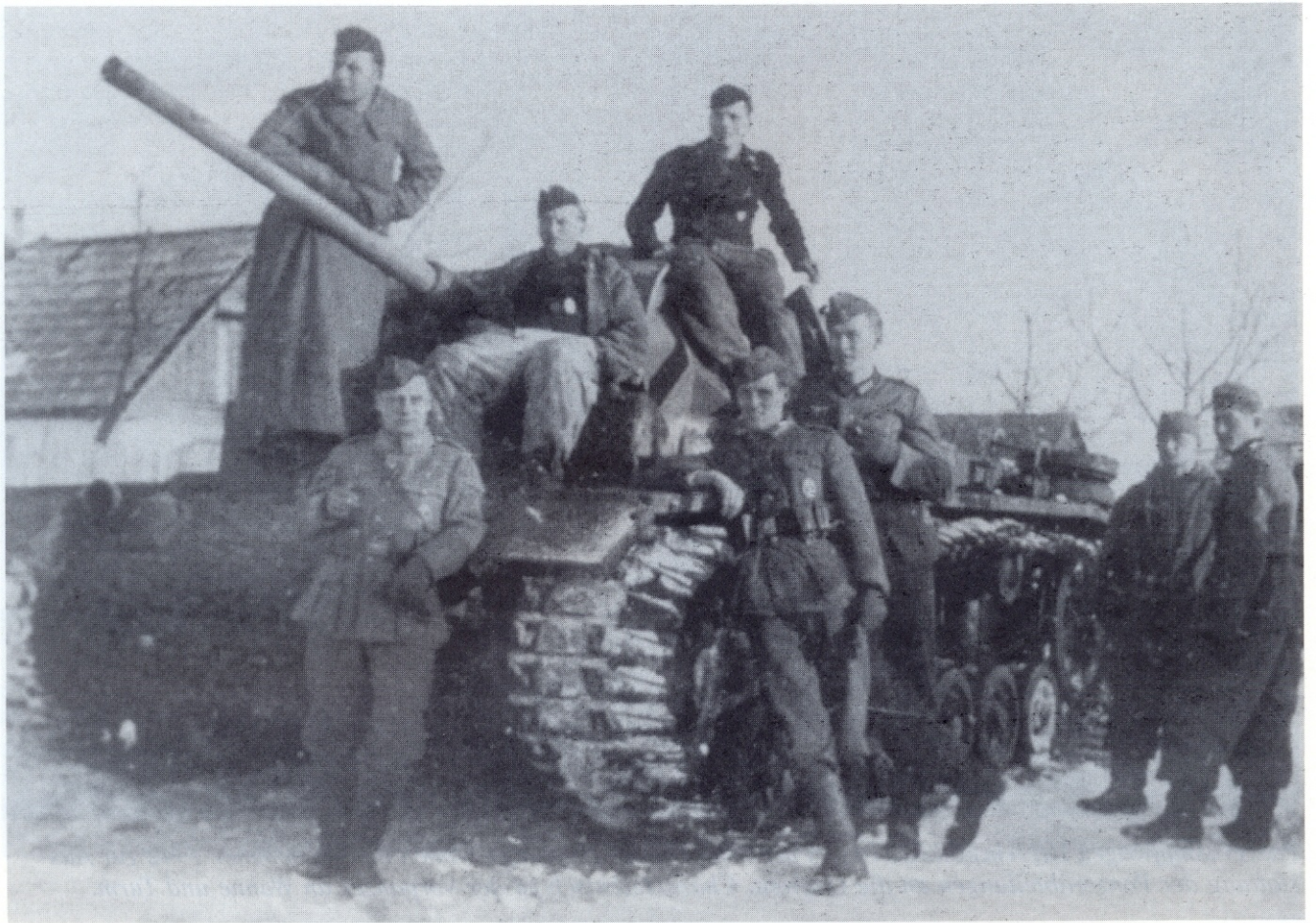
Ein Bild aus den Kämpfen im Frühjahr 1943. Der Panzerkampfwagen III(5cm)(Sd.Kfz.141/1), Ausführung M ist mit einer Zusatzpanzerung an Wanne und Turm versehen. Die Schneegreifer sollten dazu beitragen die Schneegängigkeit des Kampfwagen zu verbessern.
