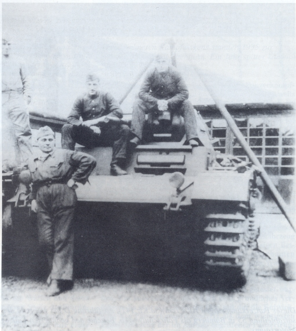
Ein Panzerkampfwagen III(3,7cm)(Sd.Kfz.141), Ausführung D während des Polenfeldzuges. Im Winter 1939/40 wurden alle Panzerkampfwagen III aus den Panzerverbänden des Feldheeres herausgezogen und gegen Fahrzeuge der Serien E und F ersetzt.
