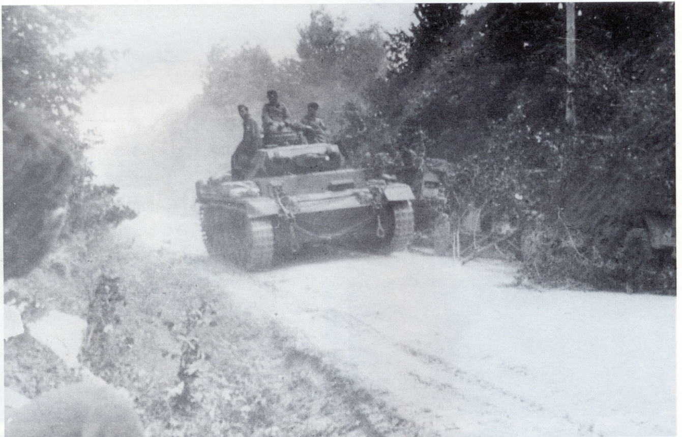
Diese Aufnahme aus dem August 1941 zeigt ein Panzerkampfwagen III(5cm)(Sd.Kfz.141), Ausführung G mit der ursprünglichen 30 mm starken Grundpanzerung.
