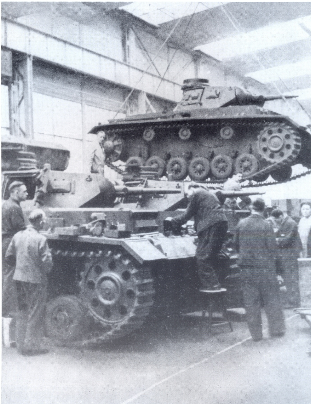
Die Fertigung des Panzerkampfwagen III (3,7 cm) (Sd.Kfz.141), hier in der endgültigen Ausführung mit 6-Rollen-Laufwerk und Drehstabfederung, hinkte lange Zeit den Bedürfnissen der Panzertruppe hinterher.
