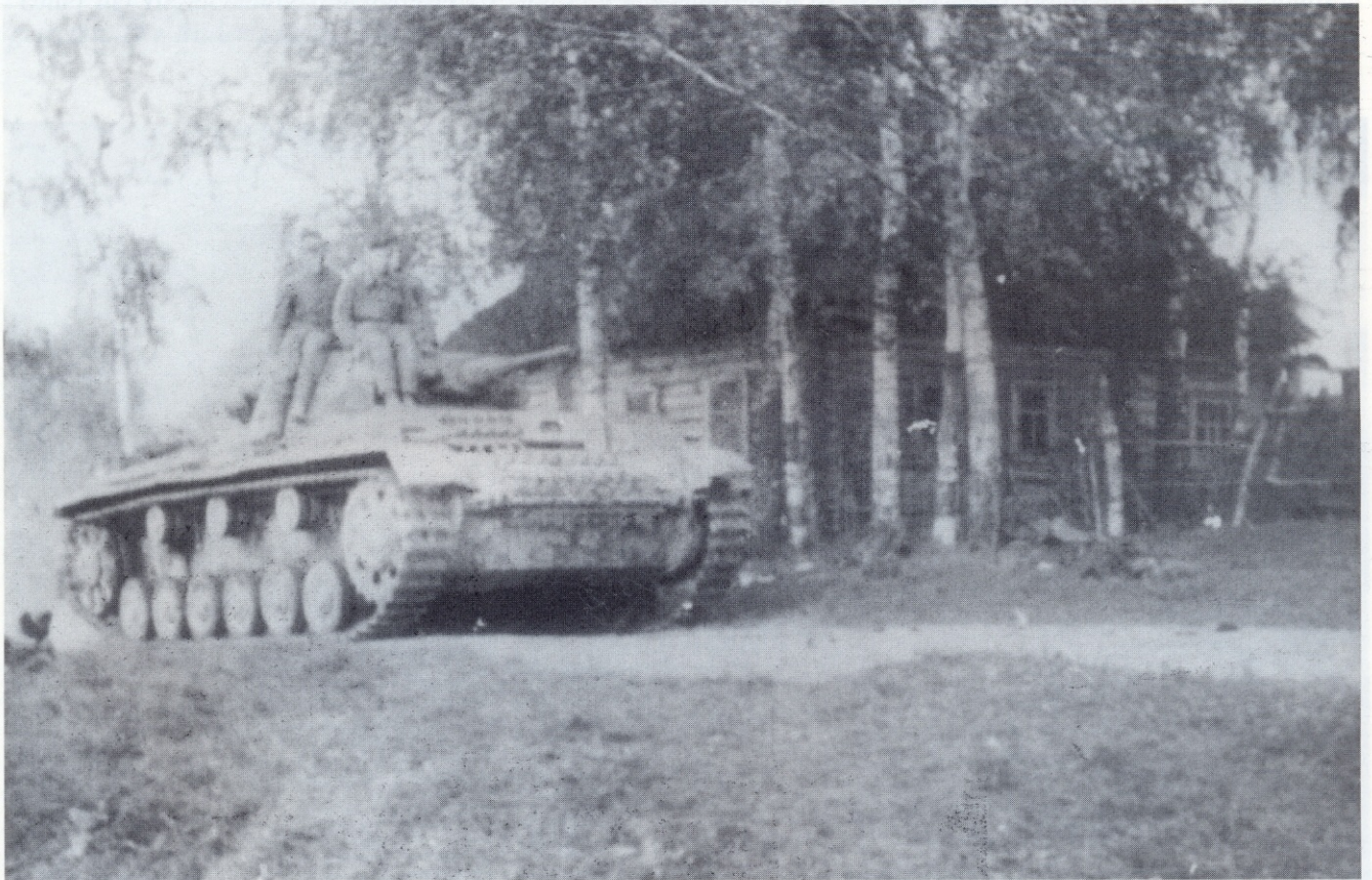
Ein Bild, das im Sommer 1942 an der Ostfront entstanden ist. Der Panzerkampfwagen III(5cm)(Sd.Kfz.141), Ausführung F ist durch Nachrüstungsmaßnahmen auf den Standard neuerer Baureihen dieses Panzertyps gebracht worden.
