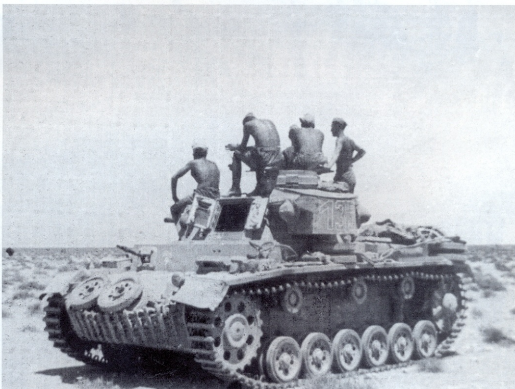
Ein Panzerkampfwagen III(5cm)(Sd.Kfz.141), Ausführung G des Deutschen Afrikakorps. Die Leistungen der 5-cm-Kampfwagenkanone L/42 reichten auf diesem Kriegsschauplatz nicht aus, um das Feuergefecht auf größere Entfernung führen zu können.
