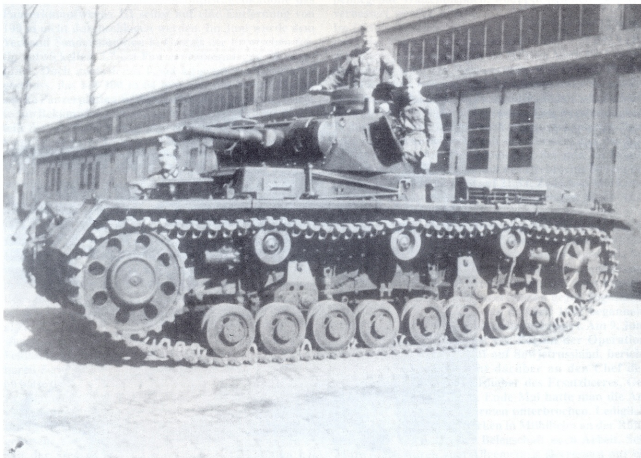
Dieser Panzerkampfwagen III(3,7cm)(Sd.Kfz.141), Ausführung D lief während des Krieges bei der Panzerersatzabteilung 35 in Bamberg als Fahrschulwagen. Beachte den geänderten Luftzugang an der linken Seite des Motorraums.
