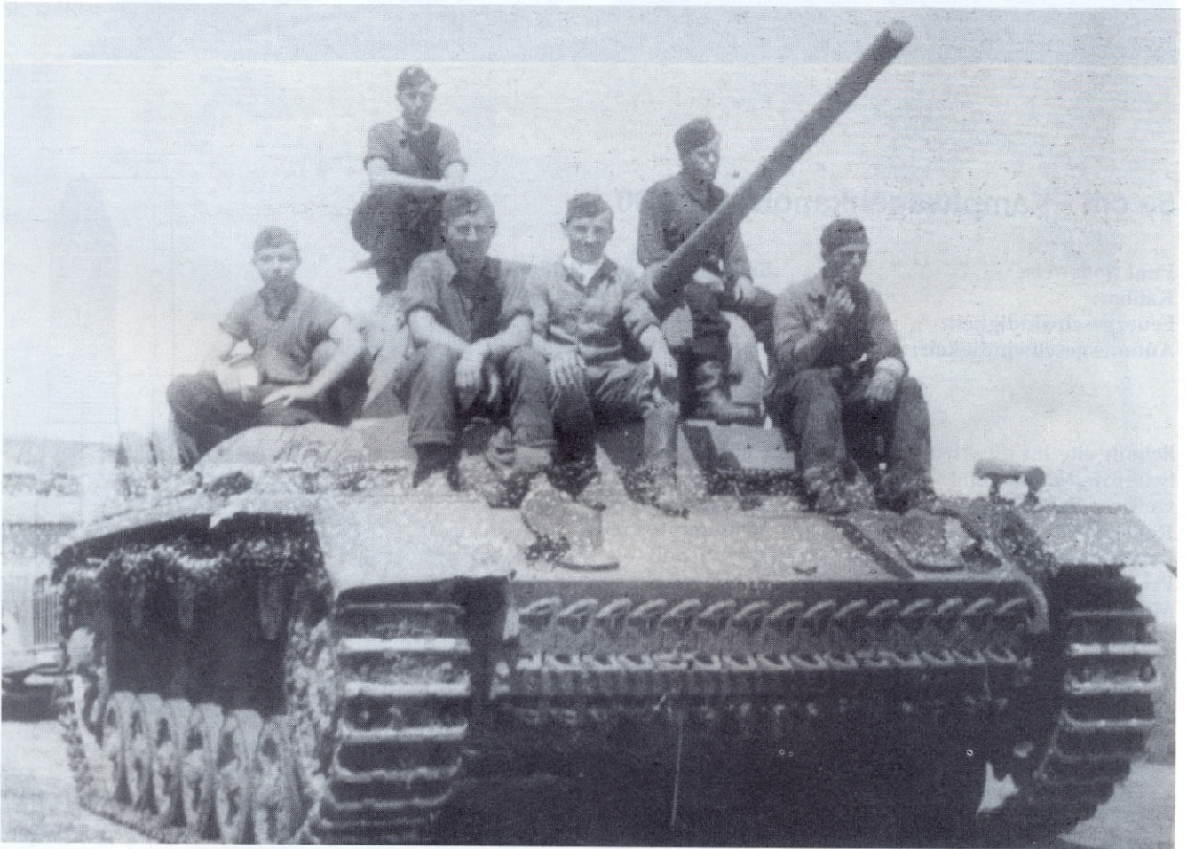
Panzerkampfwagen III(5cm)(Sd.Kfz.141/1), mit einer langen 5-cm-Kampfswagenkanone, aber ohne Zusatzpanzerung, waren typisch für die Ausstattung der Panzerabteilungen in den Kämpfen des Sommers, im Südbereich der Ostfront.
