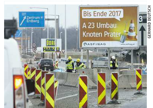
Die Tangenten-Baustelle Knoten Prater steht seit Montag in der Kritik. Die zuständige Asfinag wird an der Beschilderung nichts ändern
